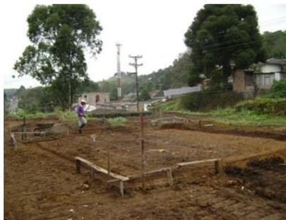
**8.3.1.3 FORMALETA:** La formaleta se hace con tablas, en los vértices en la zona donde van las zapatas Z2 para sus primeros 15 centímetros el terreno nos sirve como formaleta interna, pero en el resto de la excavación para la cimentación hay que colocar formaleta interna y externa.
