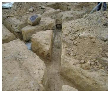
**8.2.2.3 COLOCACION DE LA TUBERIA:** Antes de colocar la tubería, la zona de excavación debe estar libre de rocas ya que estas pueden dañar la tubería y deben quedar perfectamente apoyados sobre el terreno.
