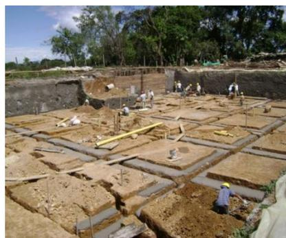
**8.2.1.1.4 ACERO DE REFUERZO:** Esta actividad comprende el proceso figuración, construcción y colocación del acero requerido según el diseño estructural para las zapatas.
