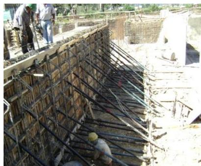
**8.2.1.3.1.4 FUNDICION:** para la fundición de los muros se utilizo una mezcla con proporción 1:3:3 mas un baldado de triturado y otro de arena, para los muros exteriores se le adiciono además un impermeabilizante de Sika.
