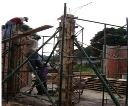
**8.3.3.4 FUNDICION:** Para La fundición de las columnas se prepara en forma mecánica una mezcla con una proporción 1:2:3, la cual se vierte dentro de las formaletas con la ayuda de baldes. La mezcla se vierte primero desde una altura de 1.50 metros y luego a una altura de 3.00 metros para evitar la segregación de la mezcla. Las columnas se desencofran pasadas como mínimo 12 horas de la fundición.
