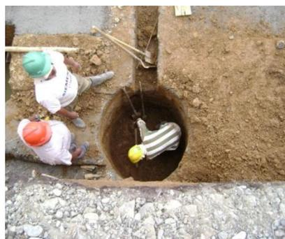
**8.2.1.2.4 FUNDICION:** Lo primero que se funde son las paredes de proteccion del caisson como ya se dijo anteriormente este se hizo por etapas. Se utiliza una mezcla con proporcion 1:3:3 con la adiccion de un acelerante Sikaset-L de la casa Sika, por cada bulto de 50 Kg se le adicionaron 1200 cc de Sikaset-L, esto con el fin de desformaletear en un tiempo de 8 horas, ya que la funcion del acelerante es obtener altas resistencias en corto tiempo.
