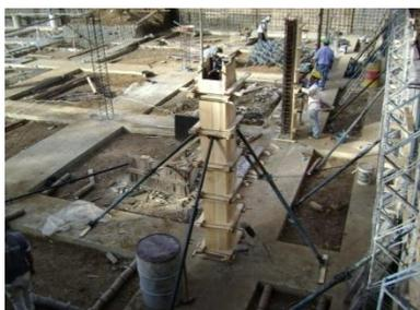
**8.2.1.3.2.4 FUNDICION:** Para la fundición de las columnas se utilizó una mezcla con proporción 1:3:3 más un baldado de arena y otro de triturado.
