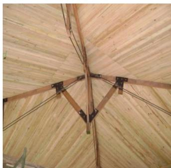
**8.3.6.3 COLOCACION DE LA CUBIERTA:** La cubierta se coloca antes de colocar el machimbre para poder colocarle las amarras de alambre y poder corregir algun error en su colocacion.
