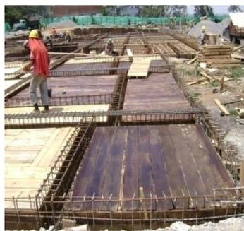
**8.2.4.2.3 ACERO DE REFUERZO:** Para el refuerzo de la losa se utilizó una doble parrilla de 10\*10 con varillas # 3.
