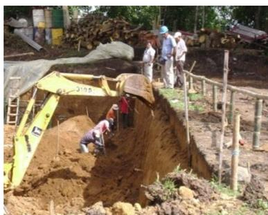
**8.1.6 PERFILADA DE TALUDES:** Esta actividad consiste, en dejar los taludes completamente verticales y asegurar que el ancho de la excavación es la especificada en los planos.
