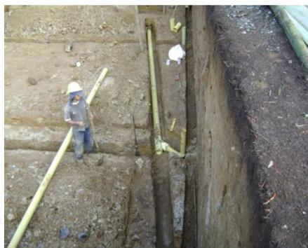
**8.2.2.4 RELLENO DE LAS ZANJAS:** Antes de hacer el relleno se comprueba que la red de tuberías colocadas este funcionando bien, una vez comprobando su buen funcionamiento se procede a rellenar la zanja.
