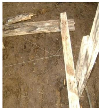
**8.3.1.2 EXCAVACION:** Lo primero que se hace es templar hilos en las puntillas que nos indican las líneas de paramentos ubicadas en los puentes, los cuales nos indican el ancho de la excavación, con la ayuda de un barreton se va marcando en el terreno las líneas proyectadas de los hilos lo que nos da el ancho del corte.
