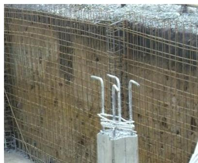
**8.2.1.3.1.3 FORMALETA:** Para formaletear todos los muros se usaron tableros, algunos se hicieron en obra y otros fueron alquilados, antes de colocarlos se les untaba aceite quemado por la cara que va a tener contacto con el concreto, para que este no se pegue a la formaleta.
