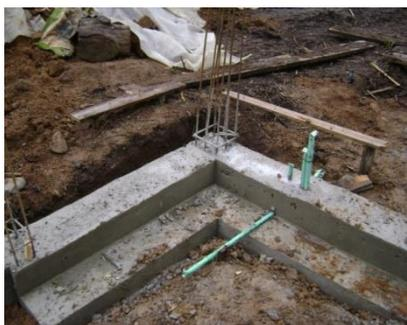
**8.3.1.8 ERRORES CONSTRUCTIVOS:** El vibrado no se hizo de una manera adecuada ya que se vibro utilizando pedazos de tabla con punta, lo que no nos garantiza que se haya ejecutado un buen vibrado.
