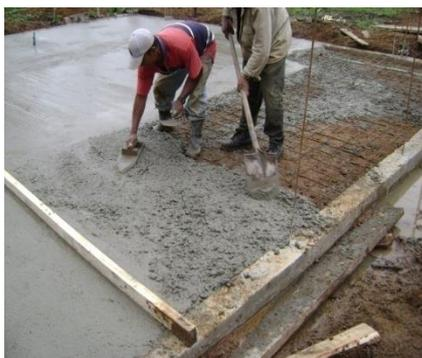
**8.3.2.1 ERRORES CONSTRUCTIVOS:** El recubrimiento no es el ideal ya que es menor a 2 centímetros y el recubrimiento mínimo recomendado debe ser de 4 centímetros ya que el concreto esta en contacto con el terreno.
