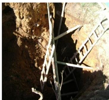
**8.2.2.6.4 RELLENO DE LA ZANJA:** Para el relleno de la zanja se colocó primero una capa de material suelto libre de rocas de 60 centímetros, luego se colocan capas de 20 centímetros y se va compactando con la presión de la cuchara de la retroexcavadora. Cuando el relleno iba por la mitad por medio de una fotografía se observó que la tubería no había sufrido deformación.
