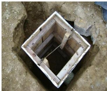
**8.2.2.5.4 ACERO DE REFUERZO:** El acero de refuerzo para las cajas de inspeccion son parrillas de 15\*15 con varillas # 3 y en su parte inferior se tiene cuidado de dejar espacio para que pase la tuberia, este refuerzo se coloca exteriormente a la formaleta y se amarran entre si con alambre negro # 18 para que queden estables y se colocan panelas de concreto simple de 2.5 centimetros para separar las aceros de la formaleta y del terreno garantizando asi el recubrimiento.
