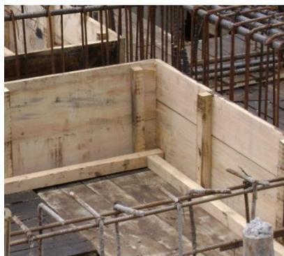
**8.2.4.2 LOSA MACIZA:** En el diseño se proyectó construir una losa maciza de 25 centímetros de espesor reforzada con doble parrilla.
