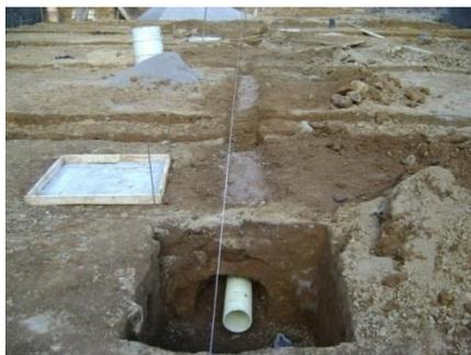
**8.2.2.2 EXCAVACION PARA LA TUBERIA:** La excavación se hace de forma manual con la ayuda de picas, barras, palas, martillos eléctricos ya que en el terreno hay presencia de rocas de tamaño considerable.
