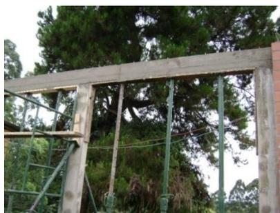
**8.3.5.2 VIGA CANAL:** Lo primero que se hace es colocar un entarimado encima de los muros y de los dinteles usando tableros, estos tableros se atracan usando cerchas y gatos, una vez esten nivelados los tableros se colocan los aceros de acuerdo al dimensionamiento de los planos y con sus debidos traslapos de acuerdo al diametro de las varillas; la formaleta se hace en tabla y se asegura con chapetas y traviesas cada 40 centímetros, y se arriostran colocando diagonales con pedazos de tabla.
