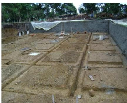
**8.2.1.1.3 SOLADO DE LIMPIEZA:** El solado de limpieza es un elemento de adecuación y sellado del terreno para brindar un espacio limpio y correcto para la construcción de las elementos estructurales que se van ha construir sobre el.
