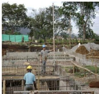
**8.2.4.1.2 ACERO DE REFUERZO:** Para armar las vigas se utilizo acero PDR- 60 sismoresistente de la Aceria Paz del Rio, se utilizaron principalmente varillas de 12 metros ya que por el despiece según el diseño con estas varillas habia menos
