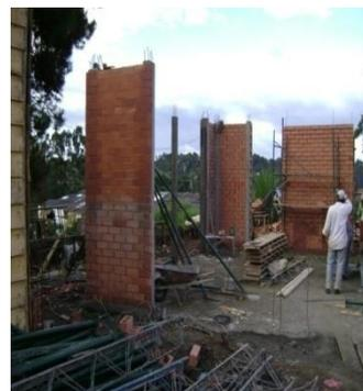
**8.3.4.4 CONTINUACION DE LOS MUROS DE CERRAMIENTO:** De acuerdo al diseño arquitectónico una vez los muros llegan a la altura de diseño se construye sobre ellos una viga canal y seguida a esta se continúa con el cerramiento también en mampostería reforzada, hasta una altura igual a la de la cumbrera de la cubierta; terminando los muros con una alfaja para que el agua lluvia escurra más fácilmente y no caiga directamente en la parte superior del muro.
