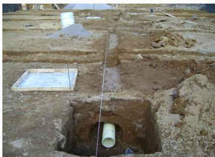
**8.2.2.5 CAJAS DE INSPECCION:** Se utilizaron cajas de inspeccion en concreto reforzado, se hicieron unas cajas principales de 80\*80 y unas cajas auxiliares de 50\*50, las cajas auxiliares se hicieron con el fin de disminuir la cantidad de tubería que llegaban a las cajas principales, la máxima cantidad de tubos por caja fueron de 6. La transición entre la tubería de llegada y la de salida de la red principal se dejó de 3 centímetros.
