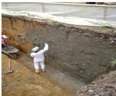
Un error cometido en obra, fue el de pasar un doble troque cargado con arena para abastecer uno de los patios destinados a almacenar material, sin tener en cuenta que al doble troque le tocaba pasar muy próximo el talud, ocasionando fisuras en este, lo que obligó a apuntalar el talud, lo que con lleva a gastos innecesarios y atenta contra la seguridad del personal. Para asegurar el talud se colocaron sobre este tablas y se apuntalan con guaduas trancándolas con cuartones.
