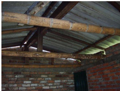
Fotografía 7. Estado actual de las escuelas. Estructura de cubierta
