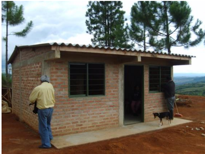
Fotografía 19. Viviendas terminadas (Vereda Riohondo)
