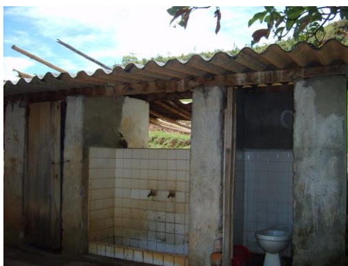
Fotografía 11. Estado actual de las escuelas. Batería Sanitaria
