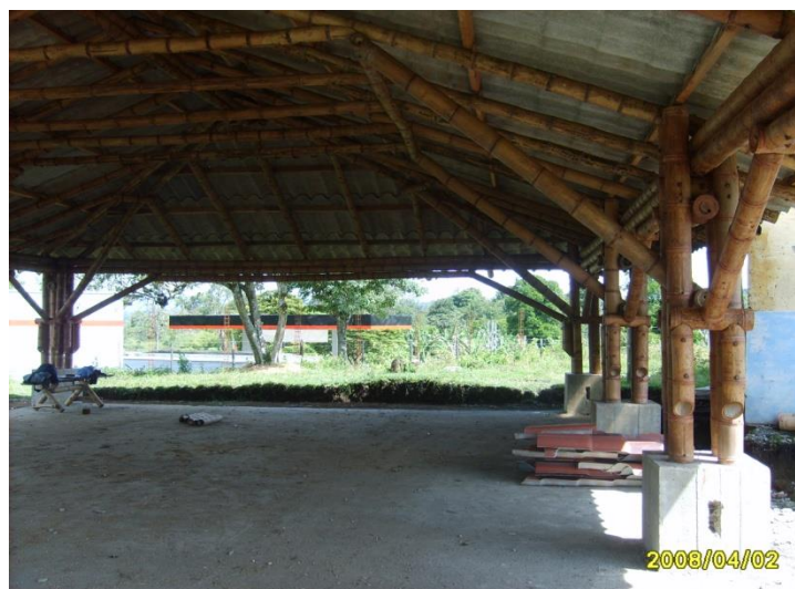
Fotografía 25. Estructura en guadua terminada.
