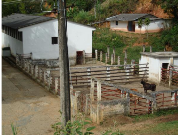
Fotografía 26. Infraestructura existente Matadero Municipal
