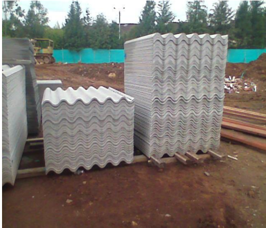
Imagen 41 Teja de Asbesto Cemento.
