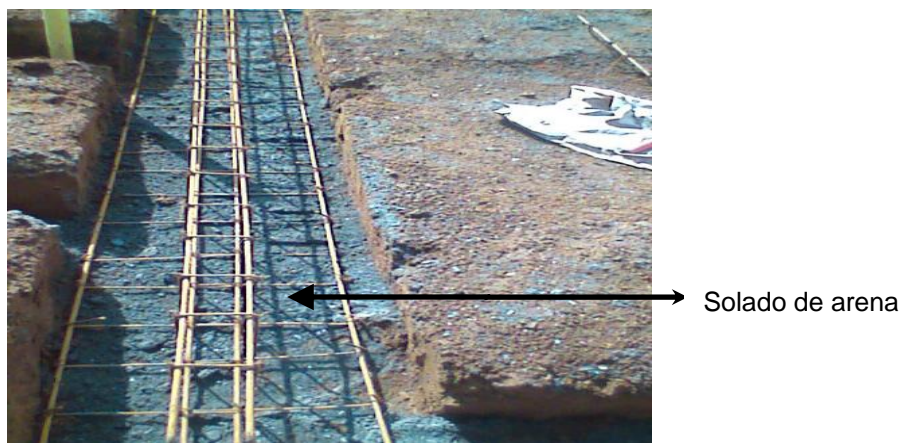
Imagen 16. Castillos de refuerzo sobre solado de arena
