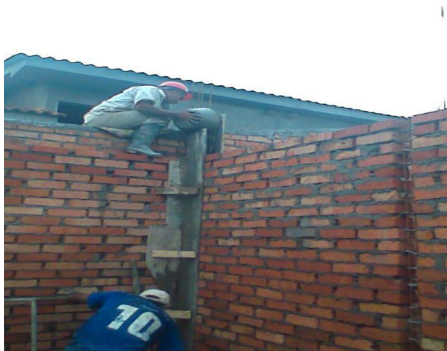
Imagen 23. Fundición de la Columna
