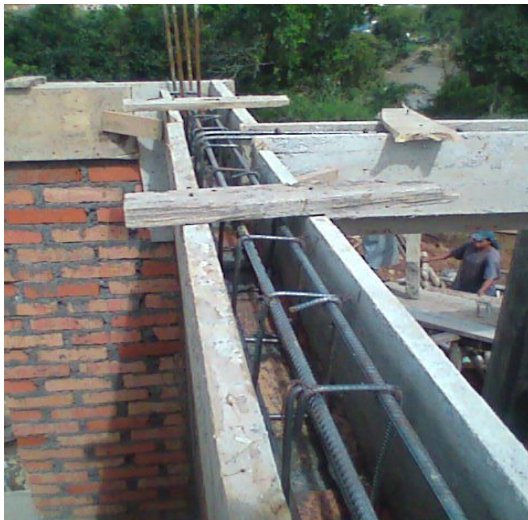
Imagen 24. Formaleta - Viga de Amarre
