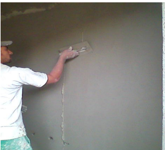
Imagen 58. Estucado de Muros.
