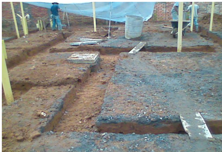
Imagen 11. Excavación para la viga de cimentación
