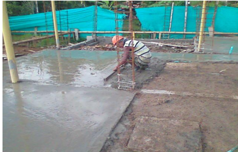
Imagen 15. Fundición - piso primario
