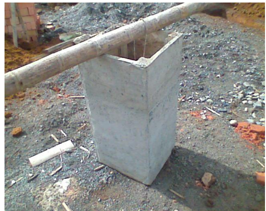
Imagen 7. Formaleta de tabla para cajas de inspección.
