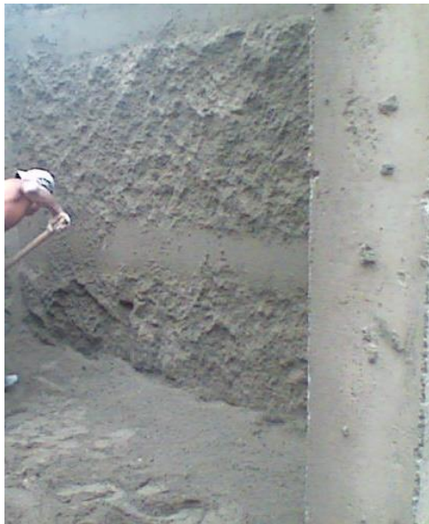
Imagen 51. Lanzamiento del Mortero Entre las Fajas.
