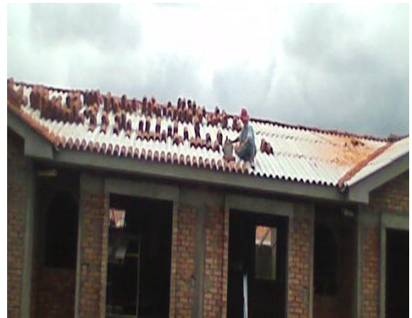
Imagen 44. Colocación - Teja de Barro
