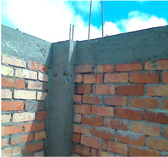
Imagen 26. Vigas de Amarre
