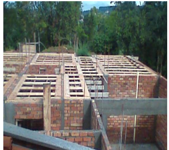
Imagen 28. Encofrado de la losa
