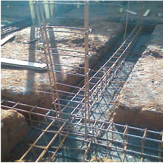
Imagen 37 Refuerzo-Columnas
