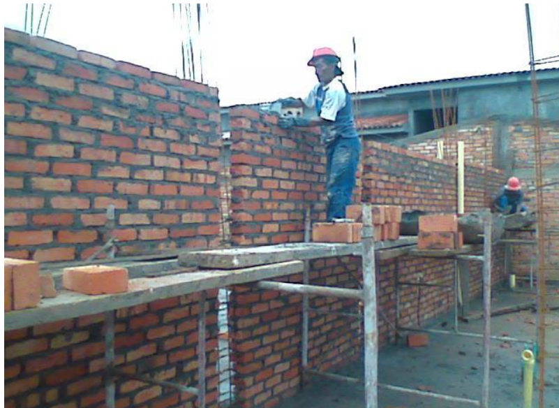
Imagen 18. Construcción de Mampostería Confinada.
