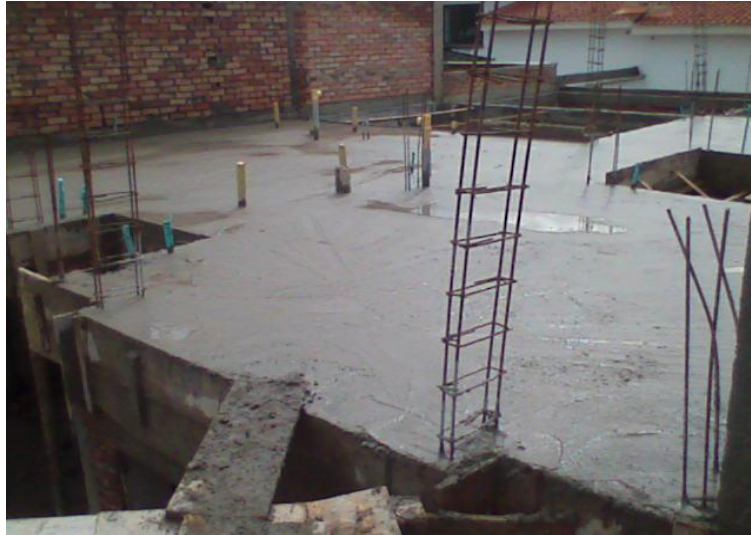
Imagen 34. Losa terminada
