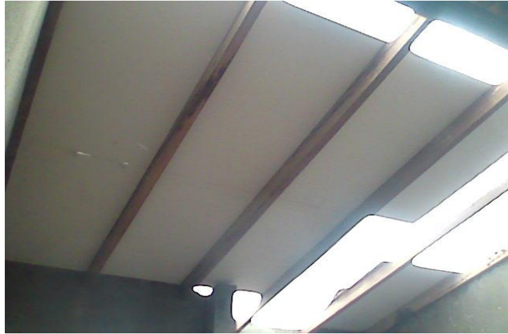
Imagen 45. Instalación del Panel Yeso.
