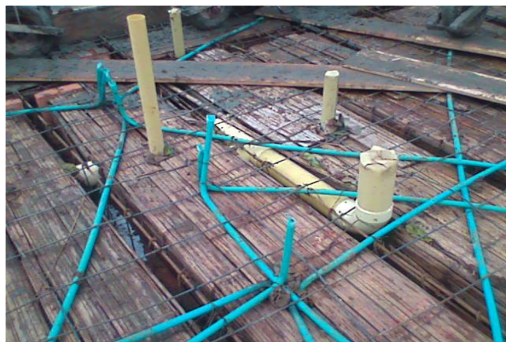
Imagen 31. Tubería hidrosanitaria y eléctrica dentro de la losa
