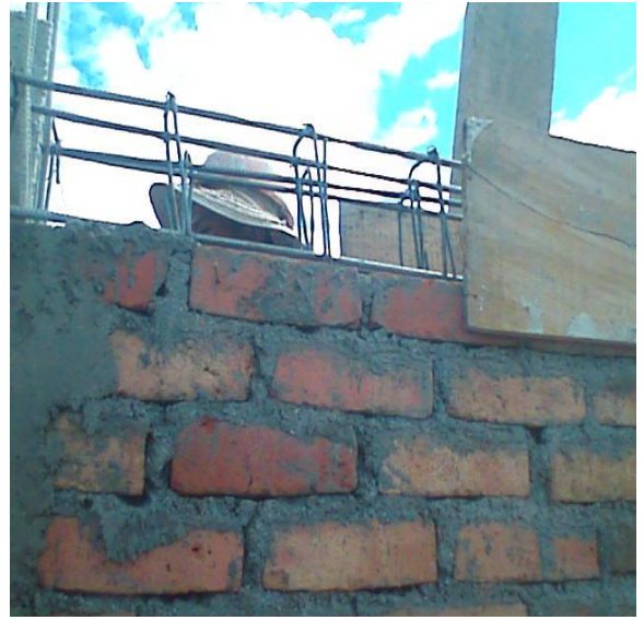
Imagen 38. Refuerzo – Vigas de amarre
