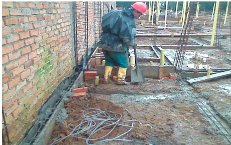
Imagen 13. Fundición - Viga de Cimentación
