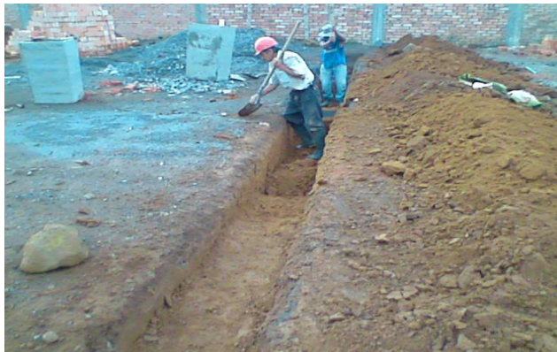
Imagen 5. Excavación de zanjas para tubería de desagües
