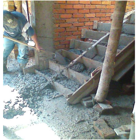
Imagen 36. Fundición Escaleras
