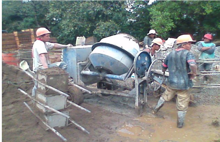
Imagen 12. Preparación del concreto en mezcladora
