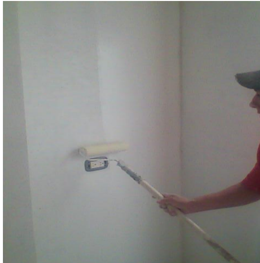
Imagen 59 Pintura Sobre Muros.
