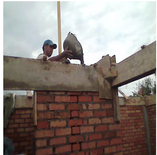
Imagen 25. Vaciado - Vigas de Amarre
