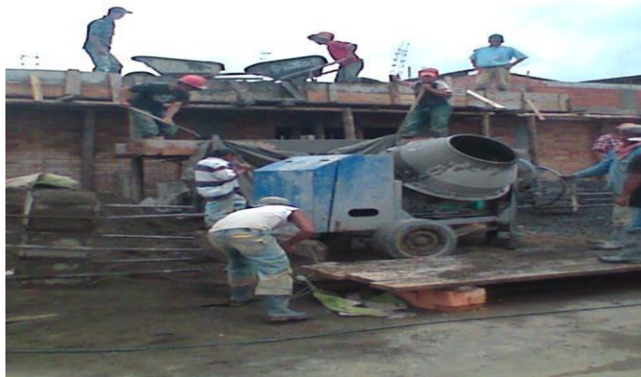
Imagen 32. Preparación y transporte del concreto
