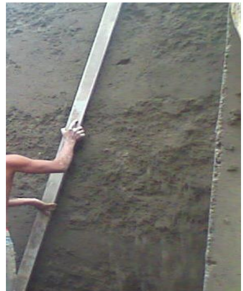
Imagen 52. Tallado del Mortero
