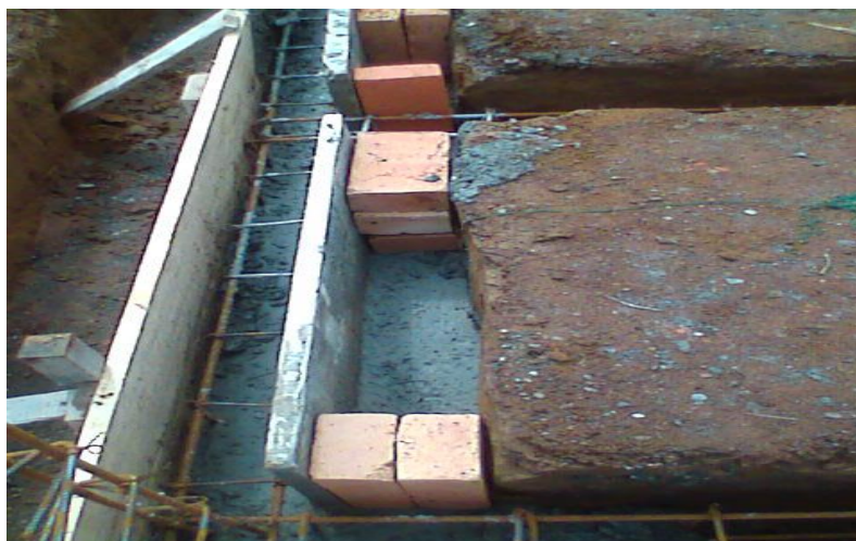
Imagen 14. Detalle de formaleta – viga de cimentación sección en L
