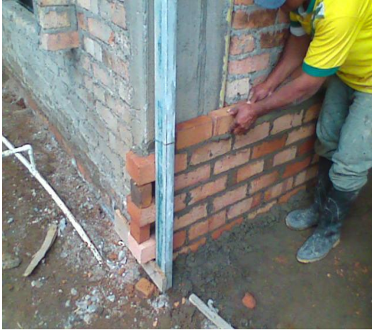
Imagen 19. Muro de fachada.
