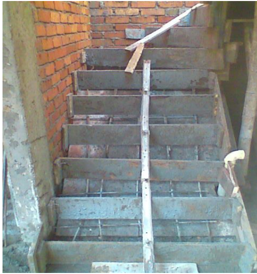
Imagen 35. Encofrado – Escaleras
