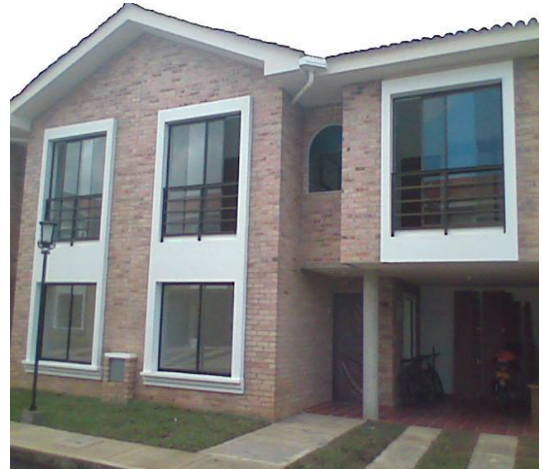
Imagen 20. Fachada de la vivienda.
