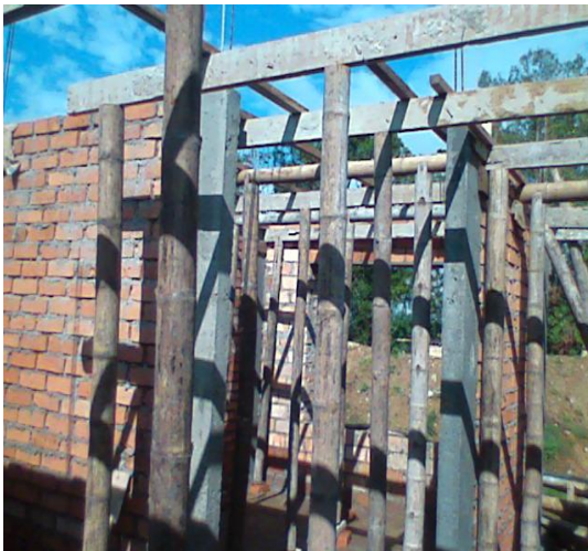
Imagen 27. Puntales del encofrado.
