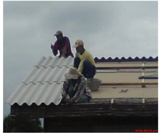
Imagen 42. Colocación de la teja de A.C
