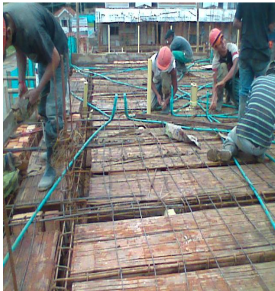
Imagen 39. Refuerzo – Losa de Entrepiso
