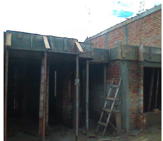
Imagen 30. Tapas o testeros de la losa
