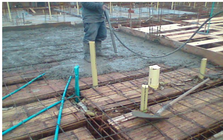
Imagen 33. Vibrado del concreto
