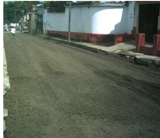
Carlos A. Joaquín M. Figura 10. Extensión y conformación de material de base
