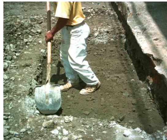
Carlos A. Joaquín M. Figura 8. Corrección de un fallo o colchón
