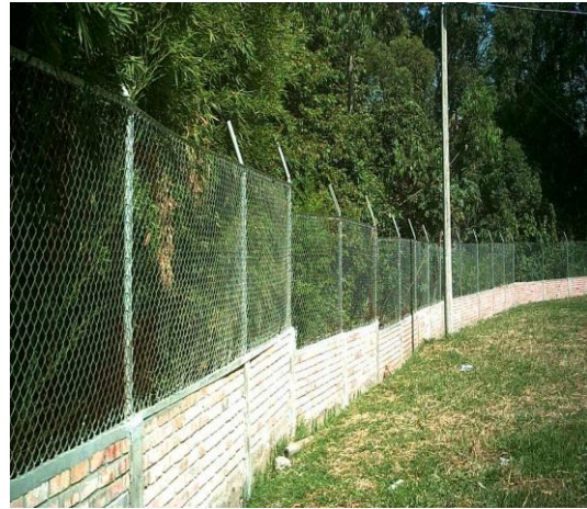
Carlos A. Joaquín M. Figura 6. Malla de cerramiento actual
