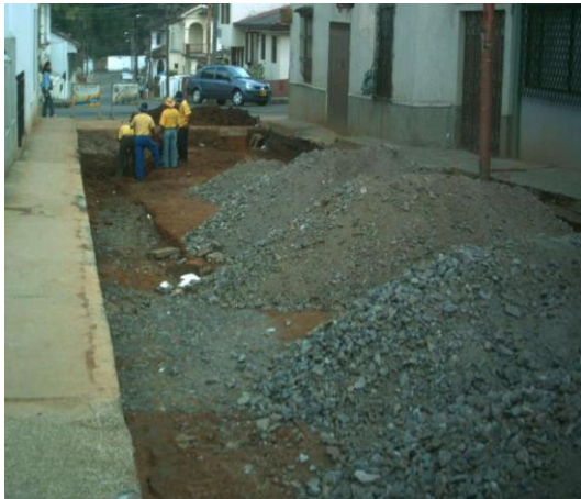
Carlos A. Joaquín M. Figura 5. Suministro de material de subbase
