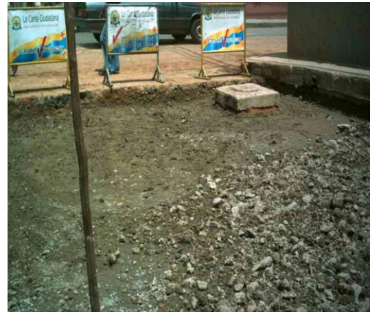
Carlos A. Joaquín M. Figura 6. Extensión y riego de material de subbase
