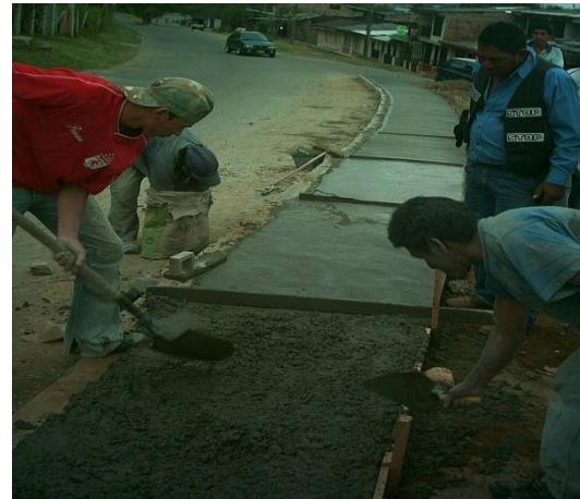
Carlos A. Joaquín M. Figura 2. Detalle del proceso constructivo del andén
