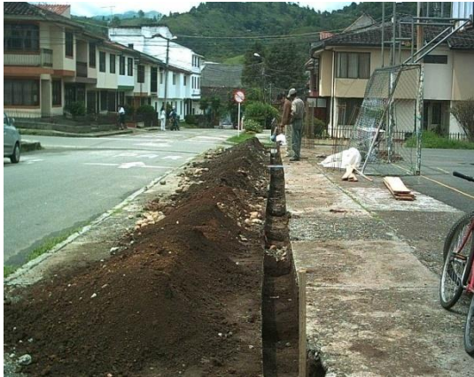
Carlos A. Joaquín M. Figura 1. Excavación para cimentación de muro
