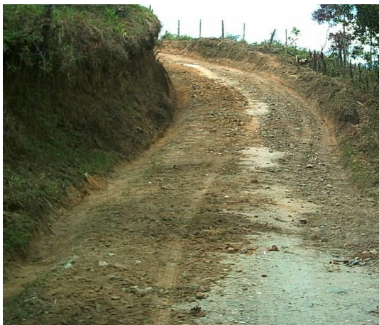
Carlos A. Joaquín M. Figura 3. Limpieza de cunetas
