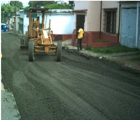
Carlos A. Joaquín M. Figura 9. Extensión y conformación de material de base
