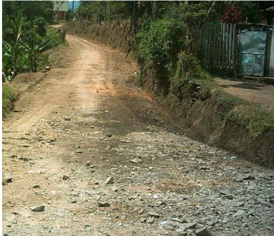
Carlos A. Joaquín M. Figura 1. Limpieza y conformación de cunetas
