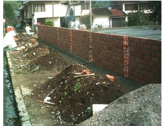
Carlos A. Joaquín M. Figura 2. Construcción de muro de ladrillo
