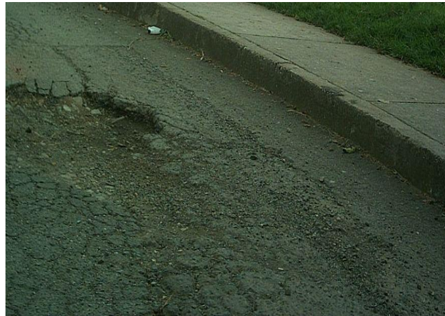
Figura 6. Fisuras de deslizamiento
