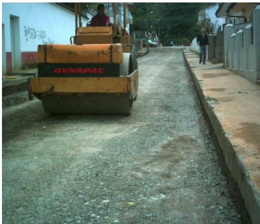
Carlos A. Joaquín M. Figura 7. Compactación de material de subbase
