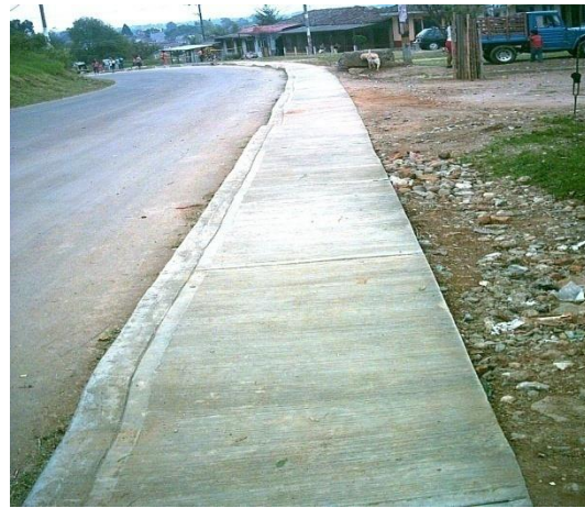
Carlos A. Joaquín M. Figura 4. Andén terminado y puesto en servicio
