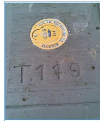
FOTOGRAFIA No. 27 TAPA Y MARQUILLAS
