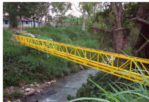
FOTOGRAFIA No. 15 PUENTE SOBRE EL RIO MOLINO – LA POLICIA
