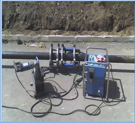
FOTOGRAFIA No. 16 PEGA Y UNION CON EL CARRO ALINEADOR
