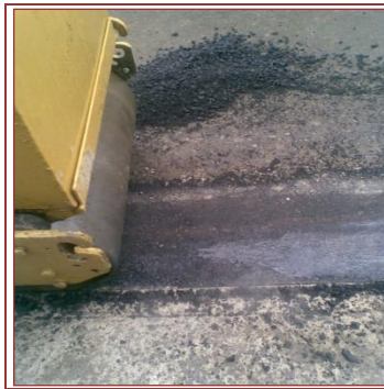
FOTOGRAFIA No. 35 COMPACTACION MECANICA
