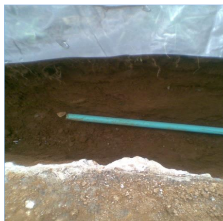
FOTOGRAFIA No. 24 TUBERIA LISTA PARA TRABAJOS DE TAPADO
