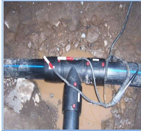
FOTOGRAFIA No. 17 PEGA Y REDUCCION DE 4" A 3" TERMOFUSION
