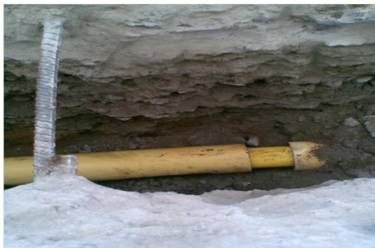
FOTOGRAFIA No. 14 ENCAMISADO DE TUBERIA DE 2 PULGADAS
