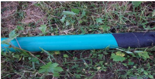
FOTOGRAFIA No. 5 REVESTIMIENTO PARCIAL DE TUBERÍA DE ACERO
