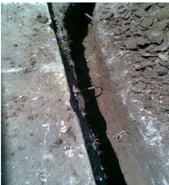
FOTOGRAFIA No. 11 EXCAVACION LIBRE DE ESCOMBROS,BASURA, ETC.
