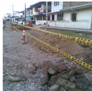
FOTOGRAFIA No. 13 SEÑALIZACION DE LA EXCAVACION
