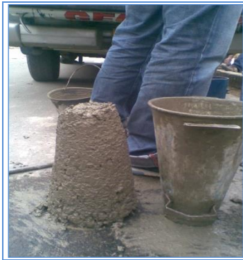
FOTOGRAFIA No. 39 VERIFICACION DEL SLUMP
