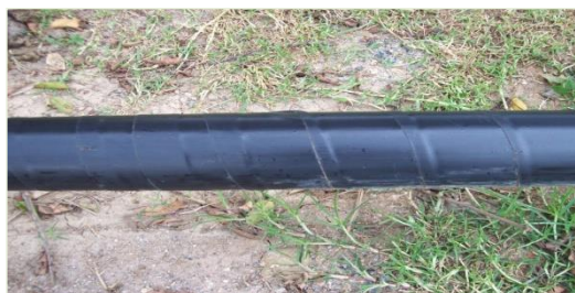
FOTOGRAFIA No. 6 REVESTIMIENTO DE CAUCHO – TUBERIA DE 4”
