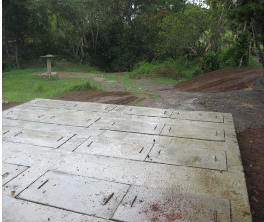
Figura 2. Filtro Anaerobio y zanja filtrante
