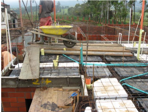
Figura 20. Ubicación de arranque para dovelas e instalaciones hidráulicas, eléctricas y sanitarias.
