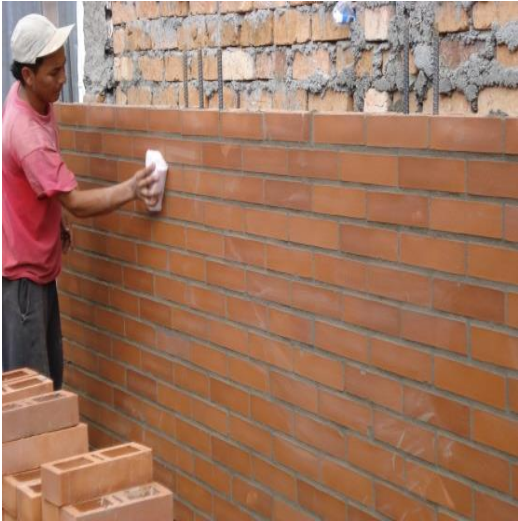
Figura 24. Limpieza de Muros.
