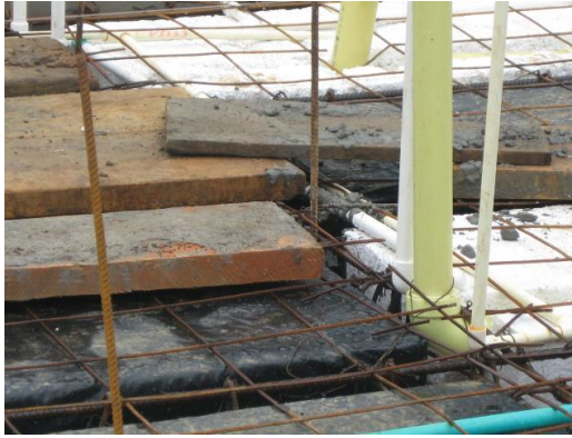
Figura 21. Red hidráulica instalada debajo de la malla de refuerzo
