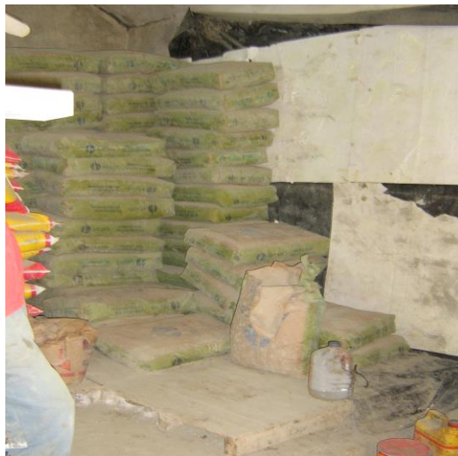
Figura 7. Bultos de cemento arrumados junto a los muros húmedos.
