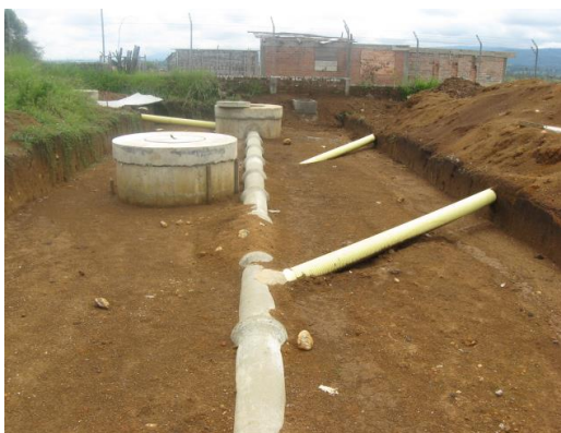
Figura 5. Cámaras dispuestas al final del conjunto de donde salen a una caja externa para AN Y ALL que transporta hacia la PETAR
