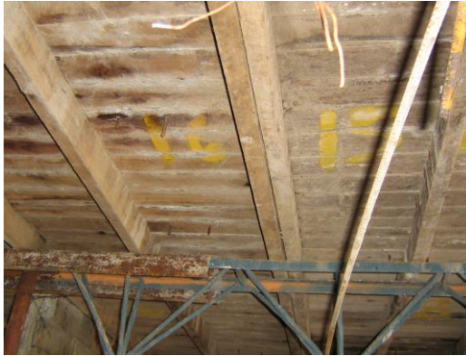
Figura 11. Soportes y formaletas enumeradas para la losa aligerada.
