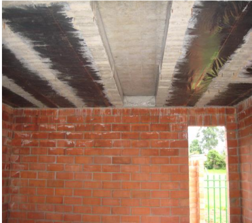
Figura 13. Losa aligerada desencofrada
