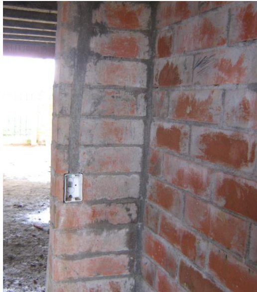
Figura 23. Instalación eléctrica para un interruptor sencillo.
