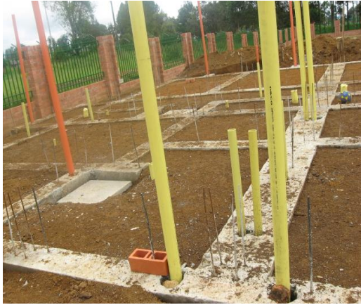
Figura 6. Cimentación, instalación de la red de aguas negras y aguas lluvias de las viviendas.
