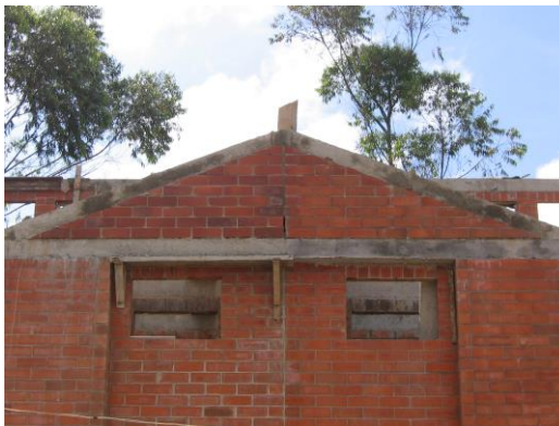
Figura 22. Culatas en fachada.
