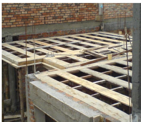
Foto 35. Tendido que sostiene el material aligerante
