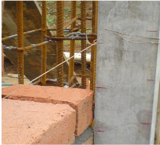
Foto 24. Codal marcado con la distribución de las hiladas
