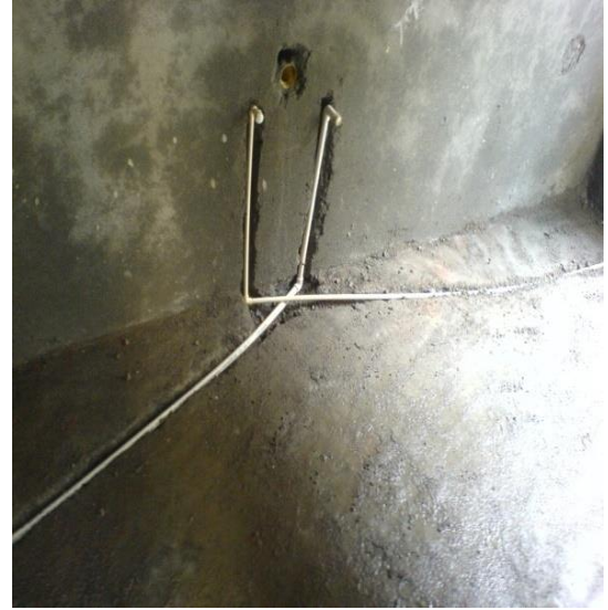
Foto 55. Regateo después de repellar.
