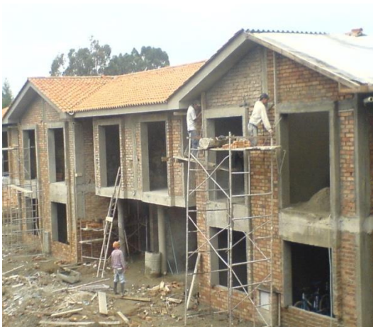
Foto 75. Obreros colocando ladrillos de la fachada
