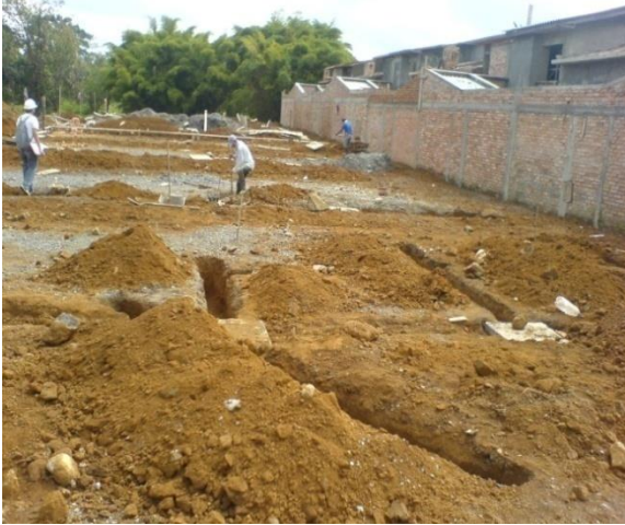
Foto 8. Zanjas para los desagües
