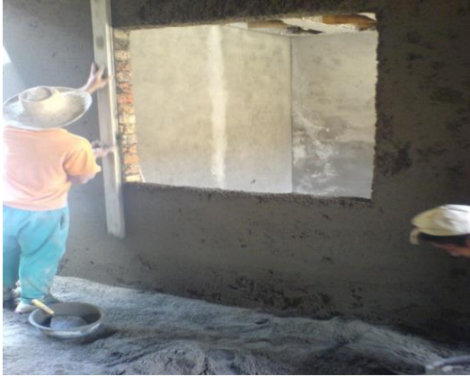
Foto 50. Obrero nivelando la superficie con el codal metálico.
