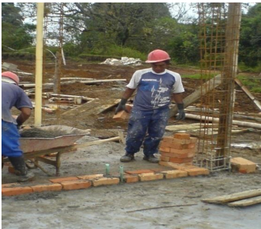
Foto 88. Obrero colocando ladrillo
