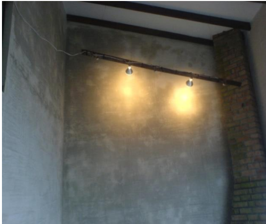
Foto 59. Lámparas usadas acelerar el secado del estuco
