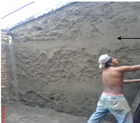
Foto 49. Repello del muro
