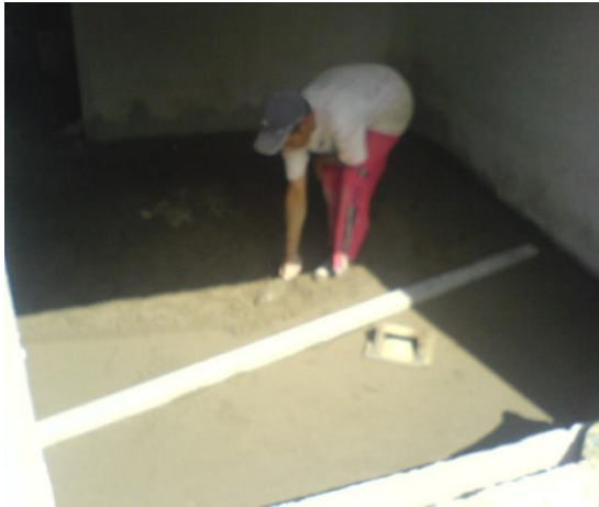
Foto 60. Mortero colocado como basa para colocar la cerámica
