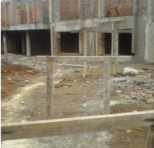
Foto 108. Bases de la estructura de acceso al segundo nivel
