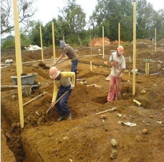
Foto 85. Obreros realizando excavación para desagües
