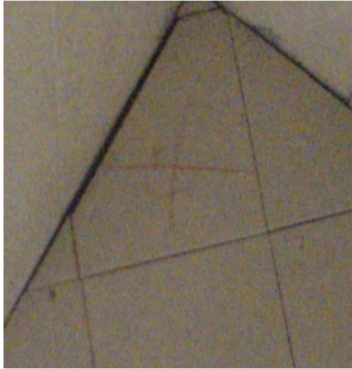
Foto 123. Enchape del baño mal cortado
