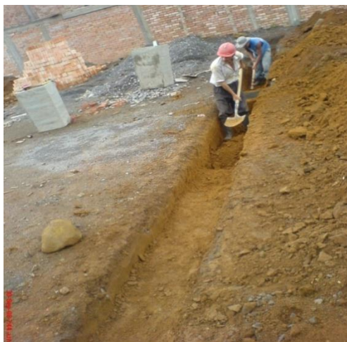
Foto 70. Obrero realizando labores de excavación
