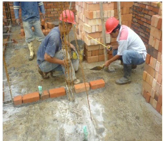
Foto 23. Colocación de la primera hilada de ladrillos
