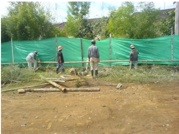
Foto 84. Obreros realizando la localización y replanteo
