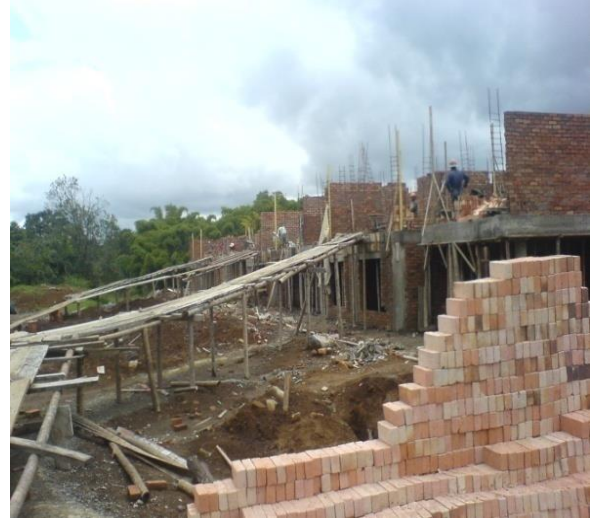
Foto 109. Estructura de acceso al segundo nivel
