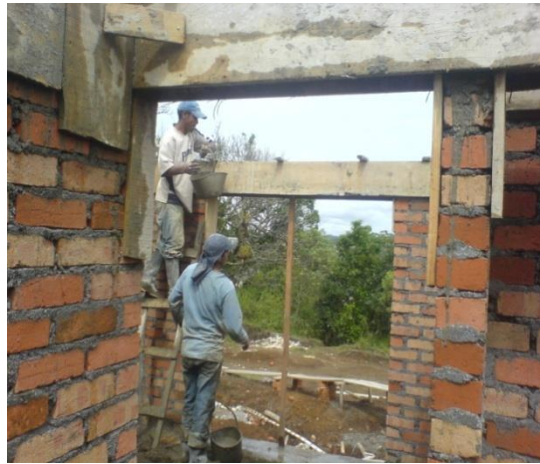
Foto 34. Vaciado del concreto para la viga
