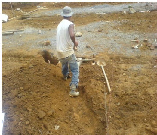
Foto 7. Obrero realizando zanja para el desagüe
