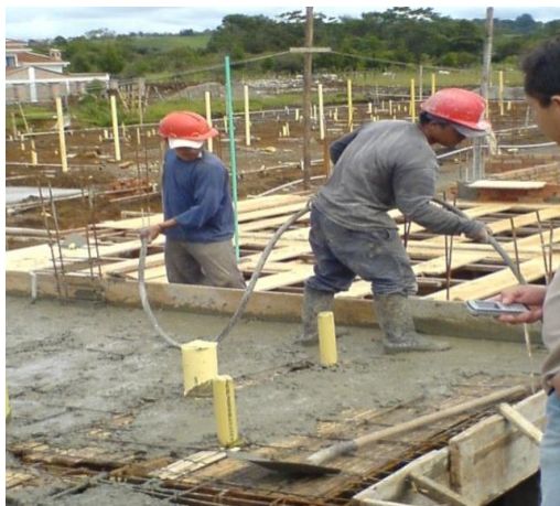
Foto 37. Vibrado de la mezcla de concreto para la losa
