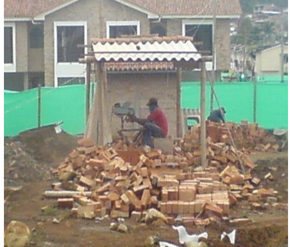
Foto 115. Obrero usando solamente como protección una tela para proteger las vías respiratorias
