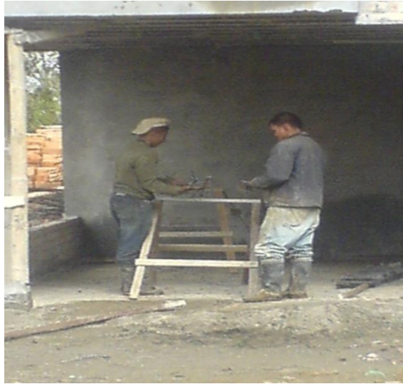
Foto 15. Corte del acero
