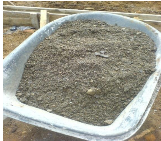
Foto 120. Material usado para el solado de limpieza
