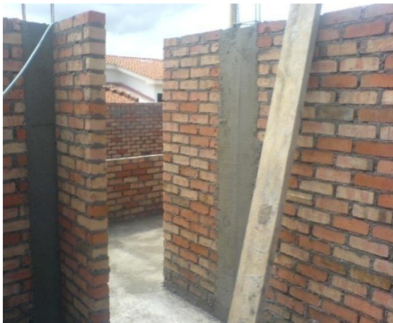
Foto 42. Muros y columnas del segundo piso
