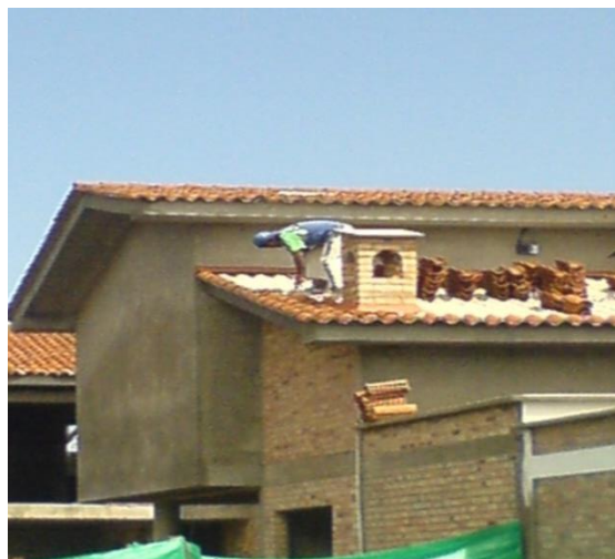
Foto 48. Instalación de la teja de barro
