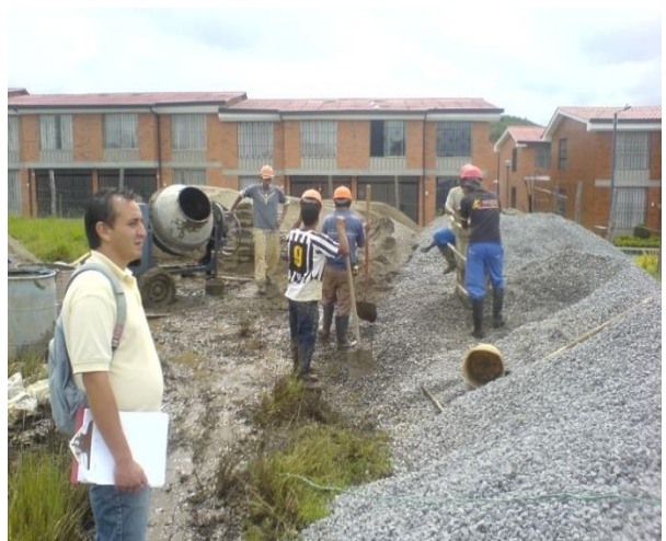
Foto 111. Obreros con equipo de protección
