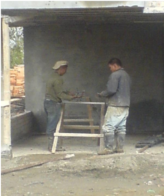
Foto 112. Obreros sin casco ni guantes realizando el corte y figurado del acero
