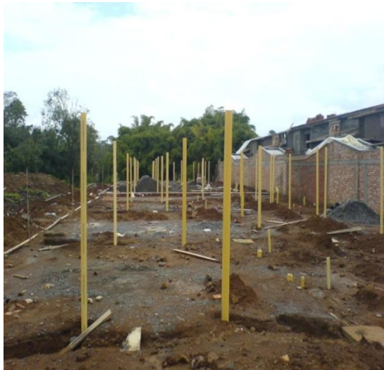
Foto 11. Desagües colocados totalmente
