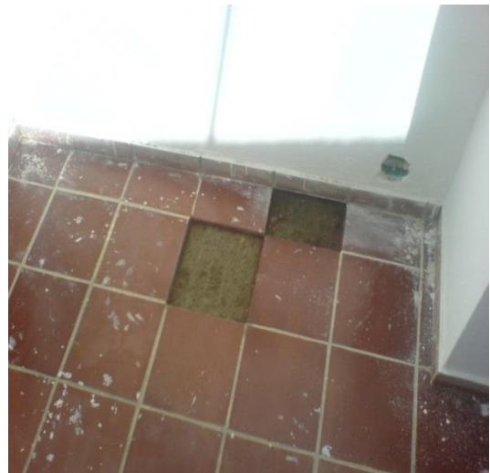
Foto 118. Cambio de tablones
