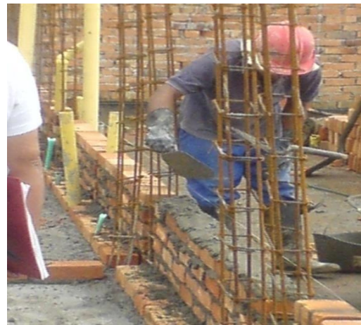
Foto 91. Obreros colocando impermeabilizante para colocar la primera hilada de ladrillos
