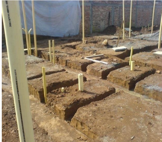
Foto 12. Zanjas para la cimentación
