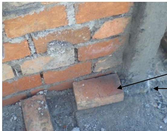
Foto 27. Muro en papelillo con ladrillo limpio de fachada
