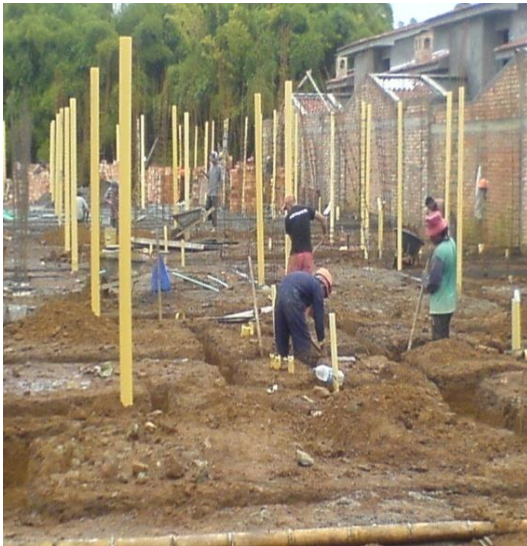
Foto 87. Obreros realizando excavación para la cimentación
