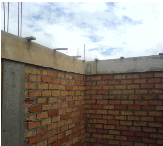
Foto 32. Viga de amarre formaleteada
