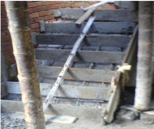
Foto 39. Armado y encofrado de la escalera
