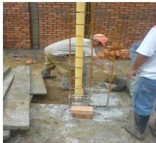
Foto 91. Obreros colocando impermeabilizante para colocar la primera hilada de ladrillos
