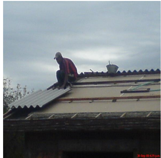
Foto 47. Instalación de las tejas de AC
