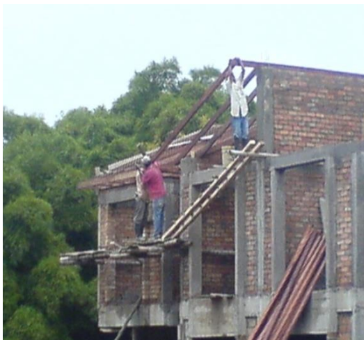
Foto 97. Obreros colocando teleras
