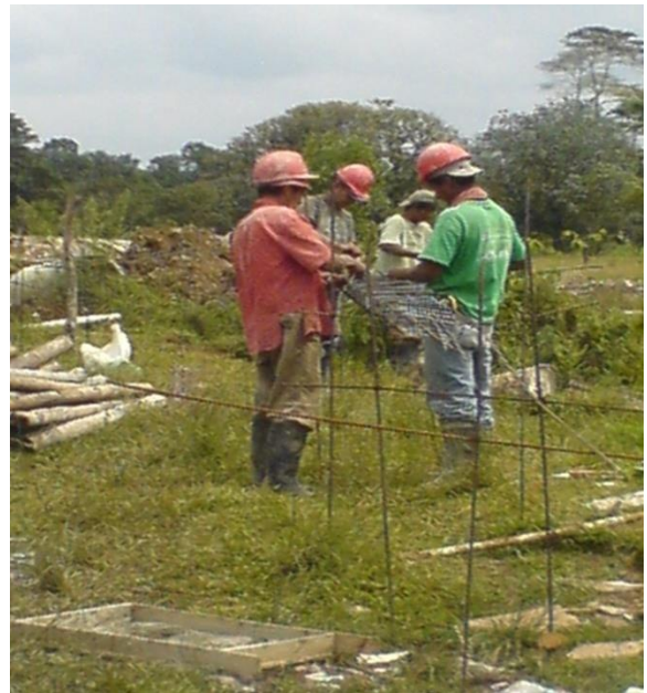
Foto 113. Obreros realizando corte y figurado del acero de refuerzo; falta el uso de guantes
