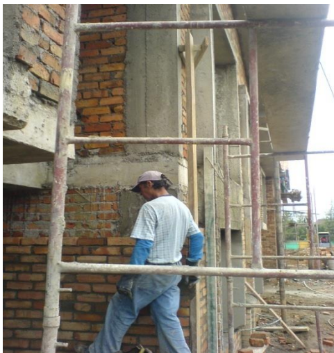
Foto 101. Obrero colocando ladrillo de fachada
