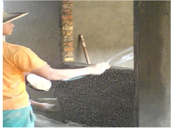
Foto 51. Obrero que pasa sobre la superficie una llana de madera.
