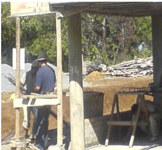
Foto 13. Obreros armando la estructura para la cimentación
