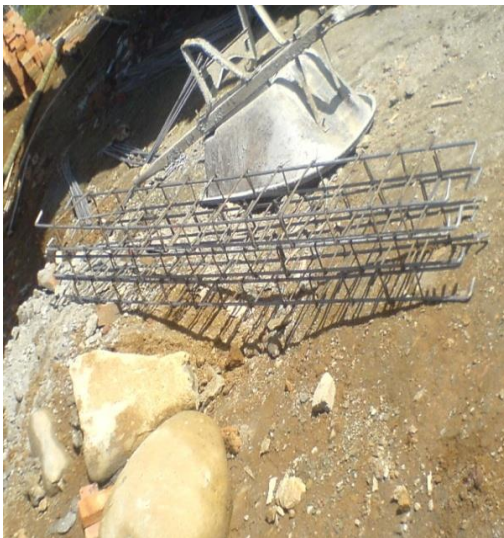
Foto 28. Castillo armado para las columnas
