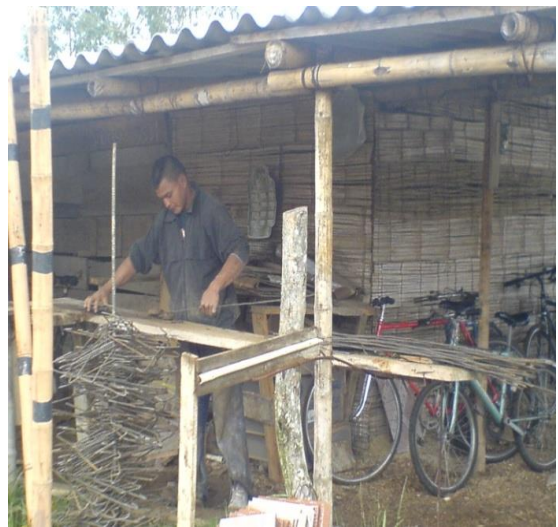
Foto 14. Obrero cortando y armando los estribos
