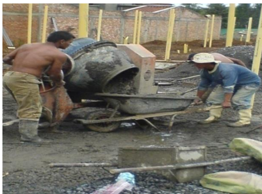
Foto 18. Obreros preparando la mezcla
