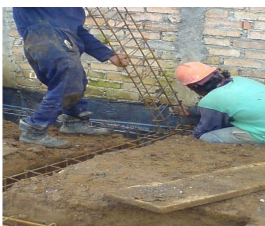
Foto 17. Colocación del refuerzo de la columna
