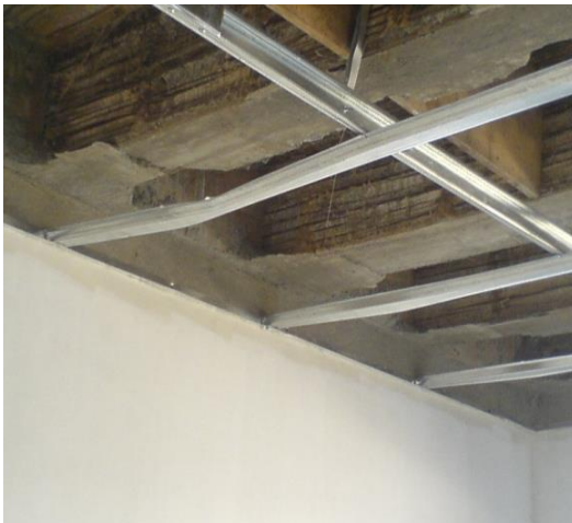
Foto 119. Estructura para el panel yeso descolgada
