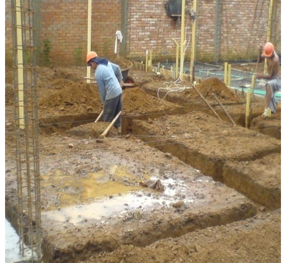
Foto 86. Obreros realizando excavación para la cimentación
