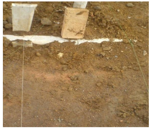
Foto 5. Zanjas referenciadas con hilos
