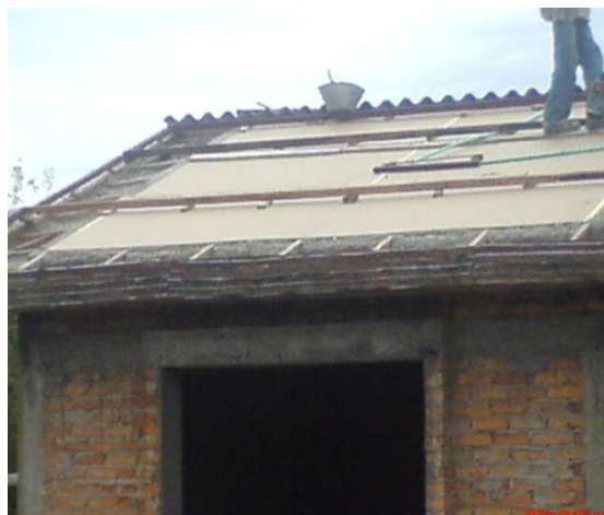
Foto 46. Correas de la cubierta
