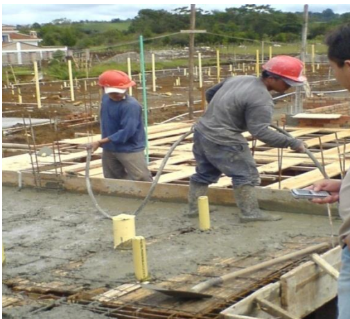
Foto 94. Obrero vibrando los nervios de la losa
