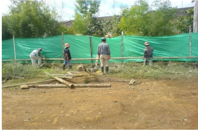
Foto 1. Obreros realizando la localización y replanteo.
