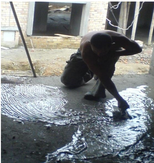
Foto 105. Colocación del fijamix
