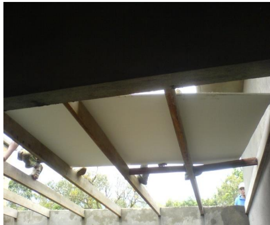
Foto 45. Instalación del panel yeso
