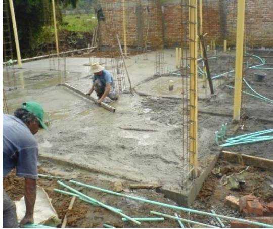
Foto 20. Colocación del piso primario
