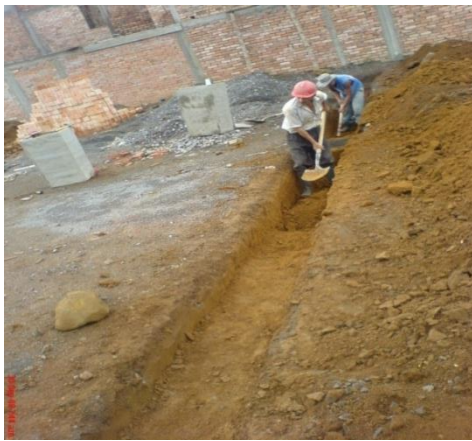
Foto 4. Obreros realizando la excavación
