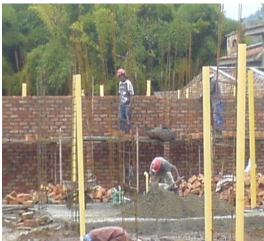
Foto 90. Obreros levantando los muros
