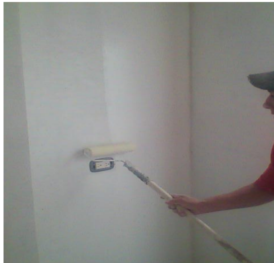
Foto 66. Obrero pintando los muros
