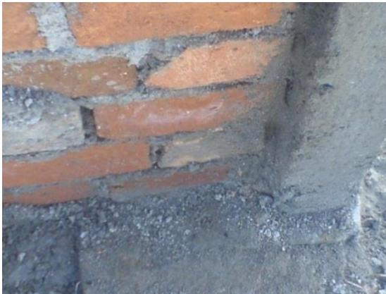
Foto 27. Muro en papelillo con ladrillo limpio de fachada
