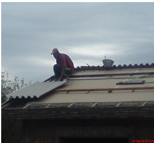
Foto 97. Obreros colocando teleras
