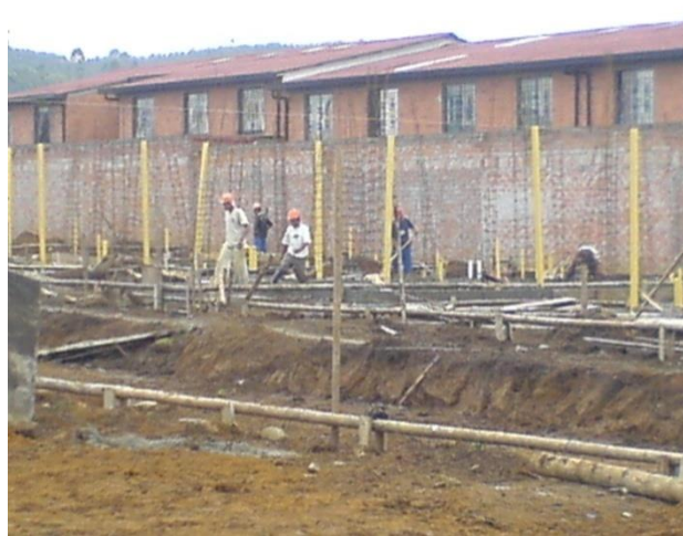
Foto 82. Obreros con casco y botas realizando la excavación para la cimentación
