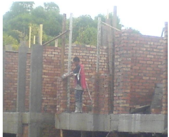
Foto 43. Obrero levantando muro del segundo piso
