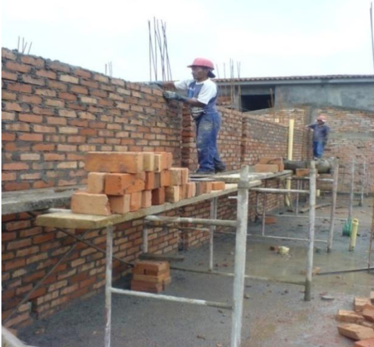
Foto 25. Levantamiento del muro
