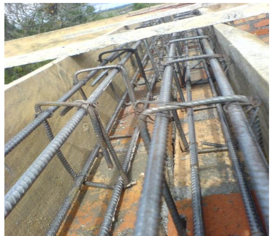
Foto 33. Refuerzo de la viga de amarre colocado
