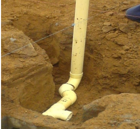
Foto 10. Colocación de los desagües
