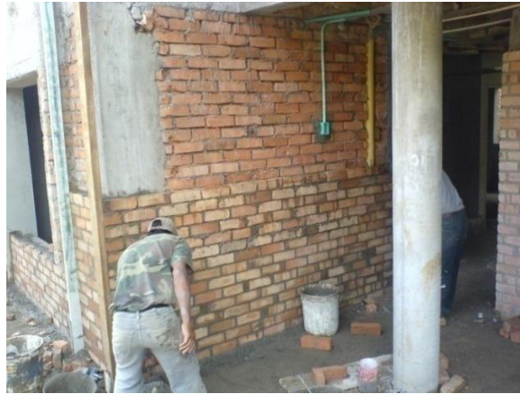
Foto 68. Obreros en labores de colocación de ladrillos
