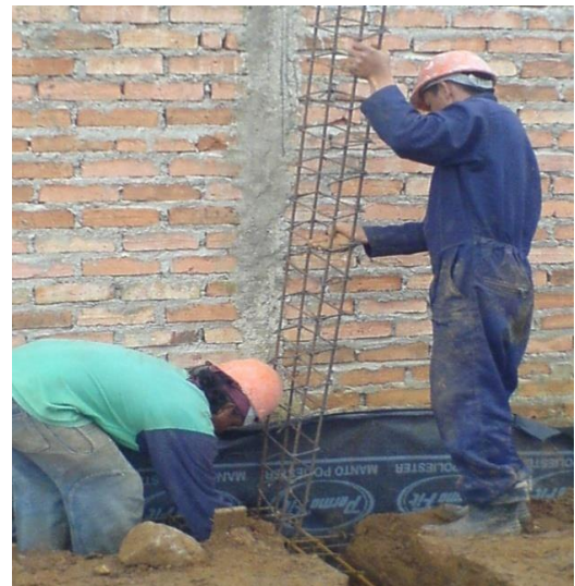
Foto 29. Colocación del castillo para la columna
