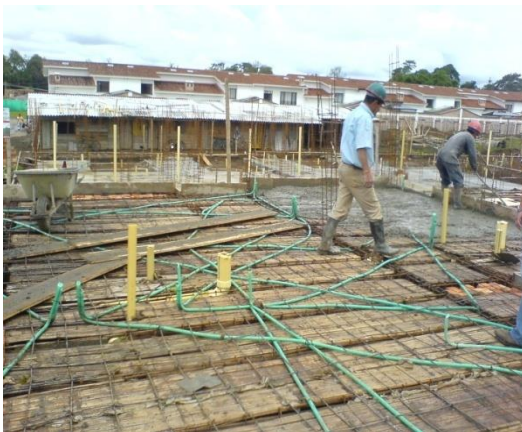
Foto 92. Maestro inspeccionando vaciada del concreto
