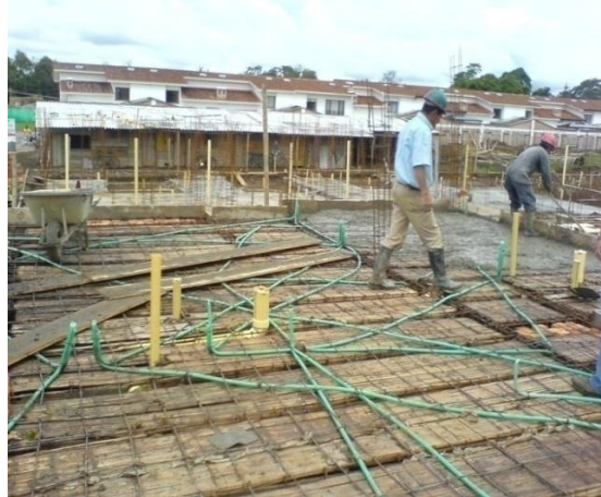
Foto 36. Losa de entrepiso lista para fundir
