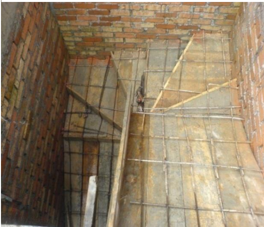
Foto 41. Panorámica de la estructura de la escalera
