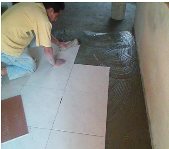
Foto 61. Instalación de la cerámica
