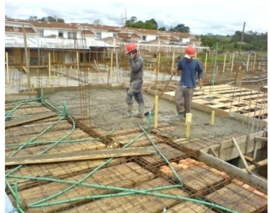
Foto 93. Obreros vibrando el concreto de la losa de entrepiso
