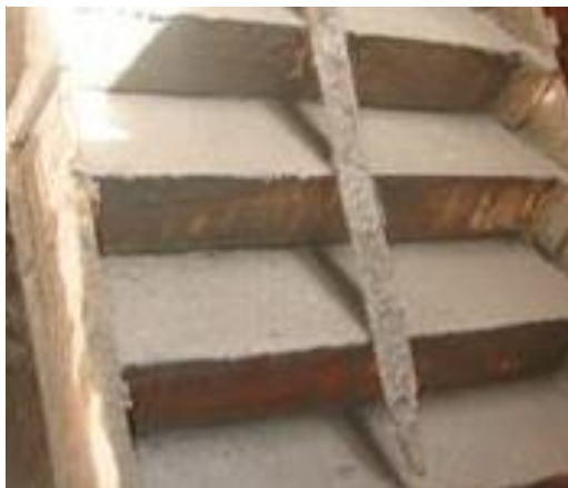
Foto 40. Concreto vaciado en la escalera
