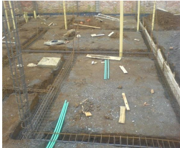
Foto 16. Solado de limpieza y refuerzo de la cimentación
