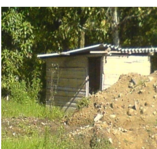
Foto 71. Instalación sanitaria provisional.
