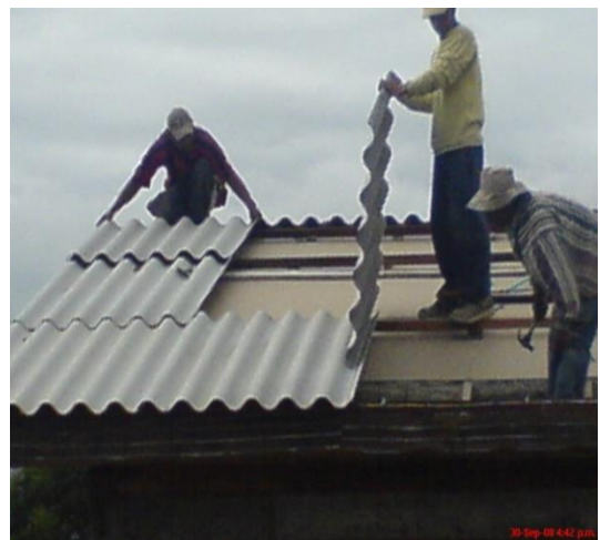
Foto 98. Obrero colocando telera
