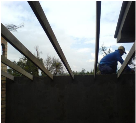
Foto 98. Obrero colocando telera
