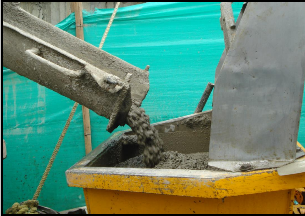
FOTO 46. DETALLE DESCARGA DE CONCRETO EN LA TOLVA
