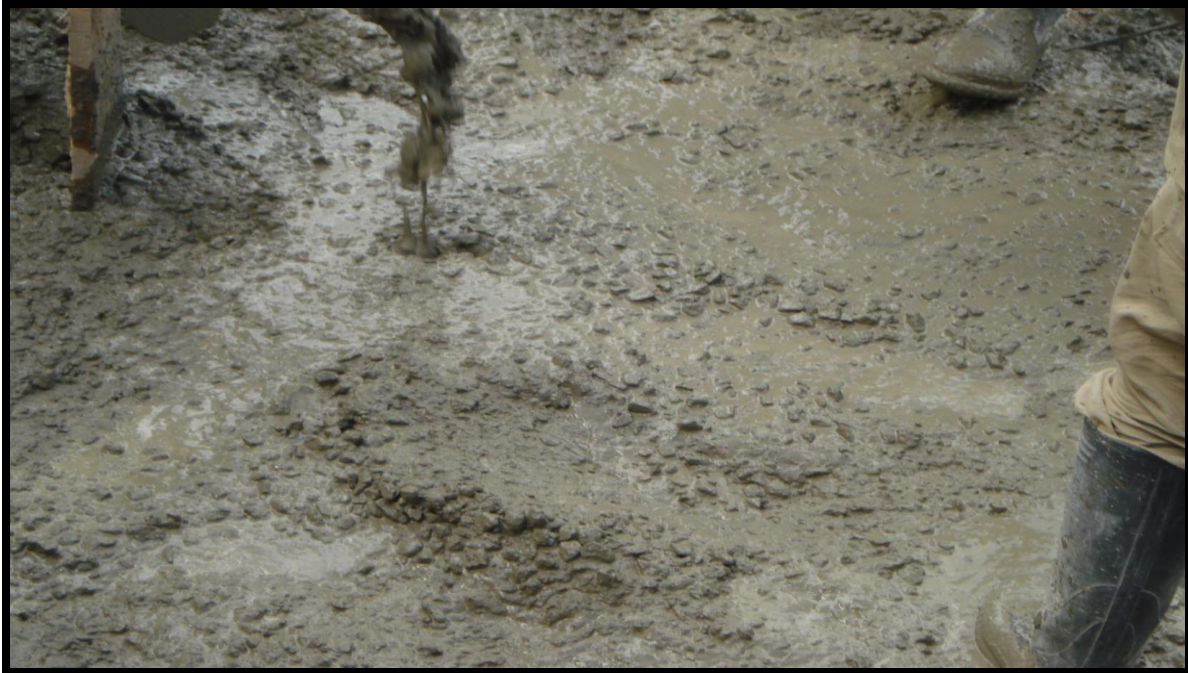
FOTO 1. IMAGEN DE CONCRETO COLOCADO SOBRE UNA LOSA
