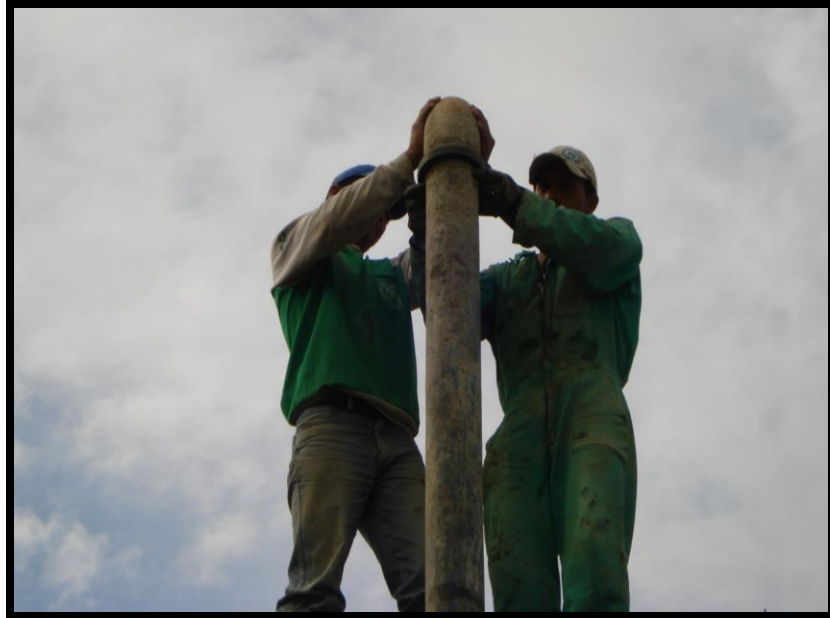
FOTO 37. OPERARIOS ARMANDO LA TUBERIA
