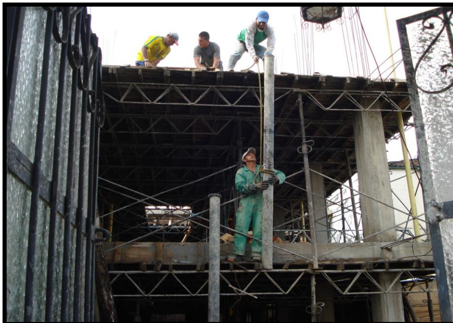
FOTO 36. SUBIENDO TUBERIA CON SOGAS
