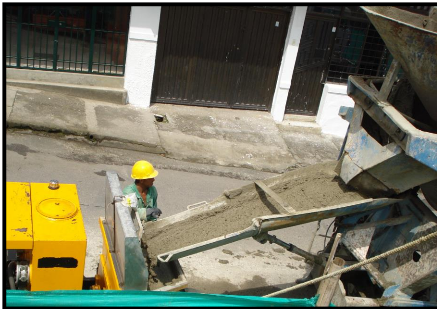
FOTO 45. DESCARGA DE CONCRETO EN LA TOLVA
