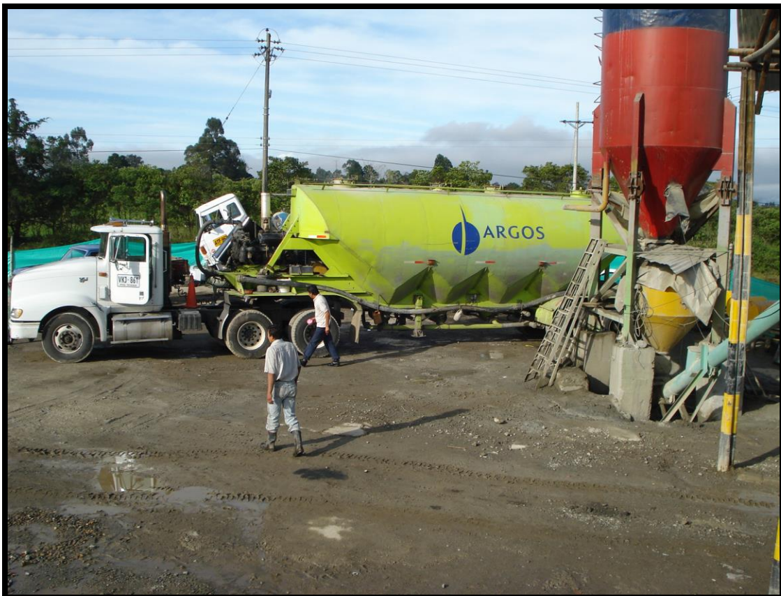
FOTO 9. PREPARACION PARA DESCARGA DE CEMENTO
