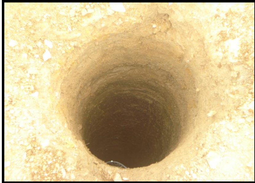
FOTO 48. EXCAVACION PARA PILOTE
