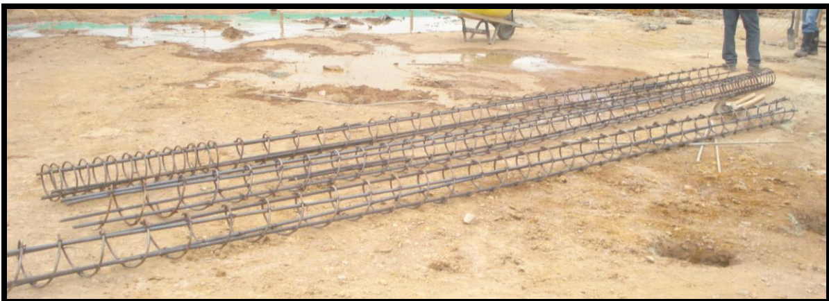
FOTO 49. DETALLE DEL REFUERZO
