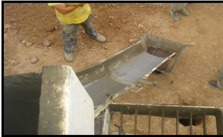
FOTO 53. EQUIPO DISPUESTO PARA COLOCACION DE CONCRETO
