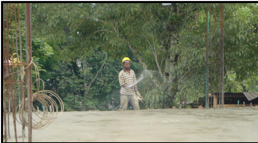
FOTO 57. CURADO DE CONCRETO (2)
