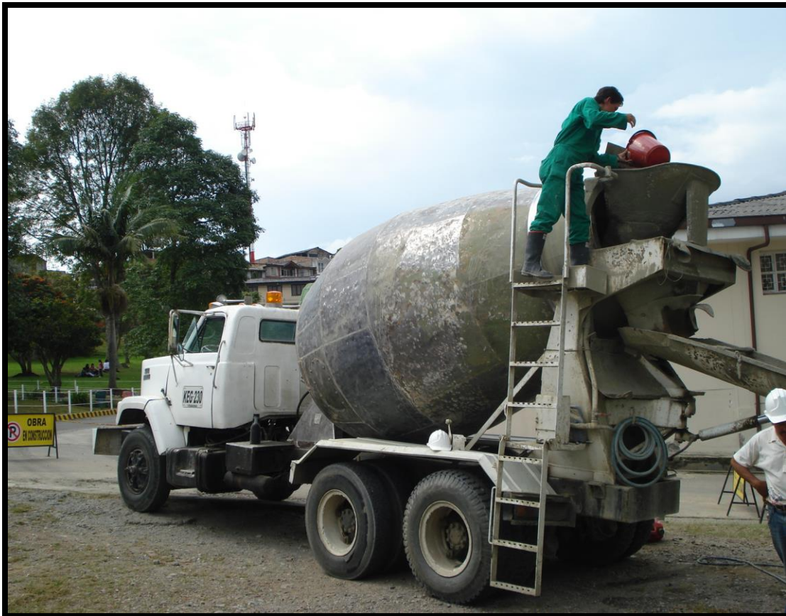
FOTO 40. APLICACIÓN DE ADITIVO A LA MEZCLA ANTES DE LA DESCARGA
