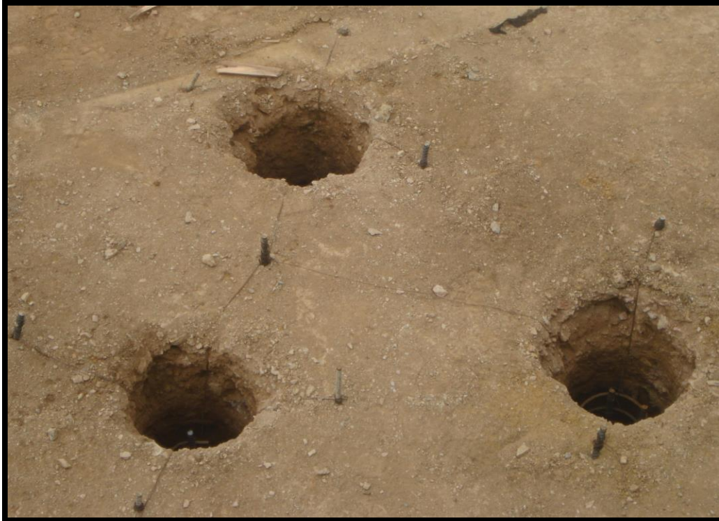
FOTO 51. GRUPO DE PILOTES LISTOS PARA VACIADO DE CONCRETO
