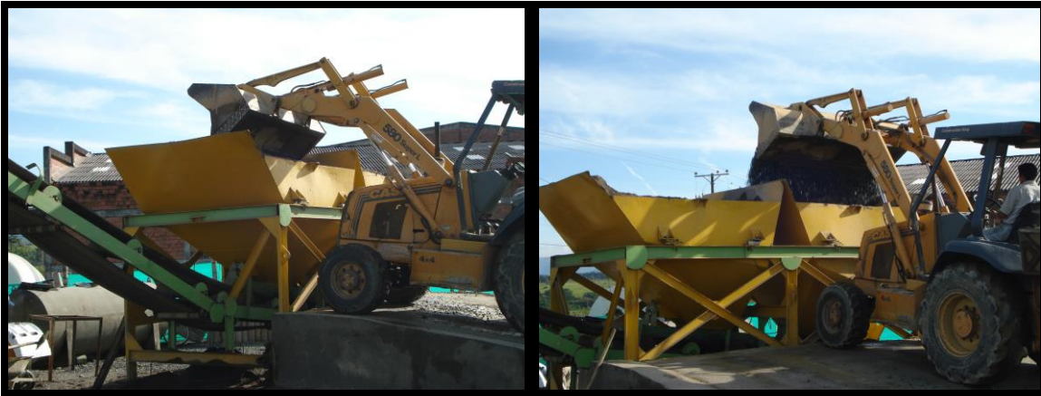
FOTO 16. RETROEXCAVADORA CARGANDO AGREGADOS
