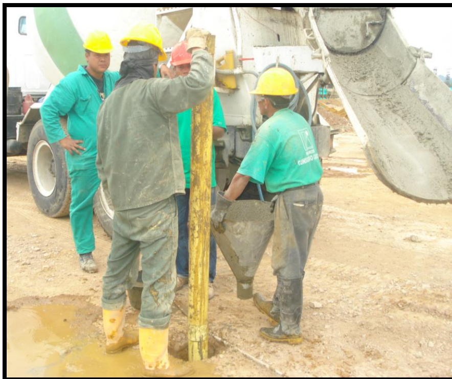
FOTO 52. TUBERIA ACOPLADA DENTRO DEL PILOTE
