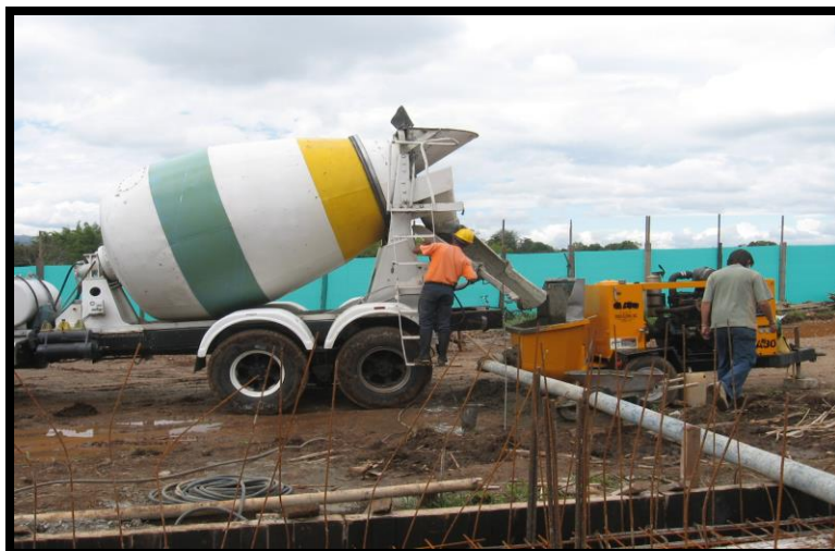
FOTO 32. DESCARGA DE CONCRETO CON BOMBA Y TUBERIA
