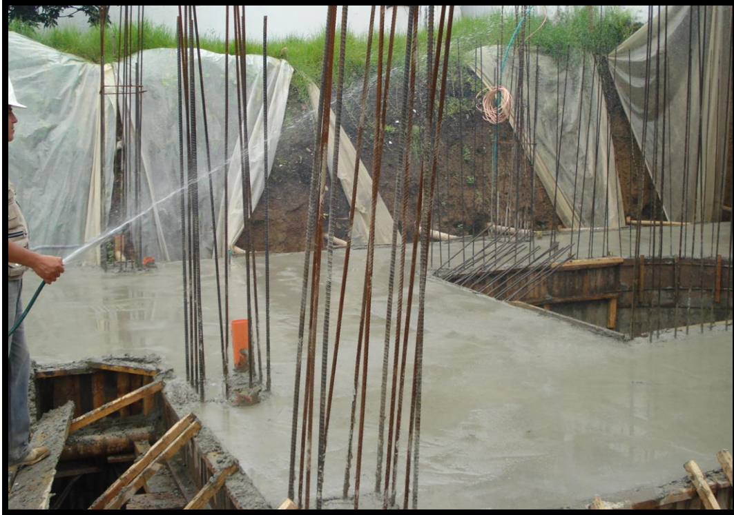
FOTO 56. CURADO DE CONCRETO (1)
