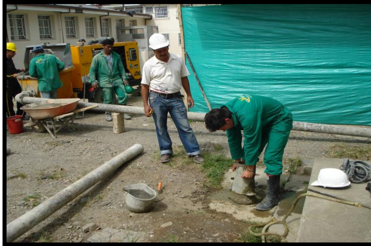
FOTO 30. LEVANTAMIENTO DEL CONO PARA PERMITIR EL ASENTAMIENTO
