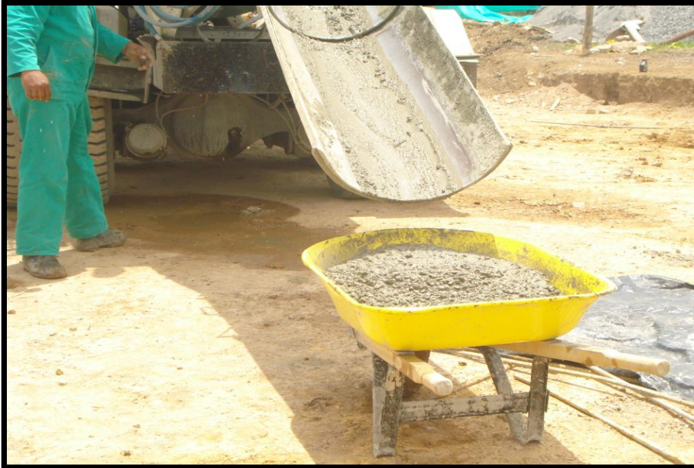
FOTO 25. TOMA DE MUESTRA EN CARRETILLA
