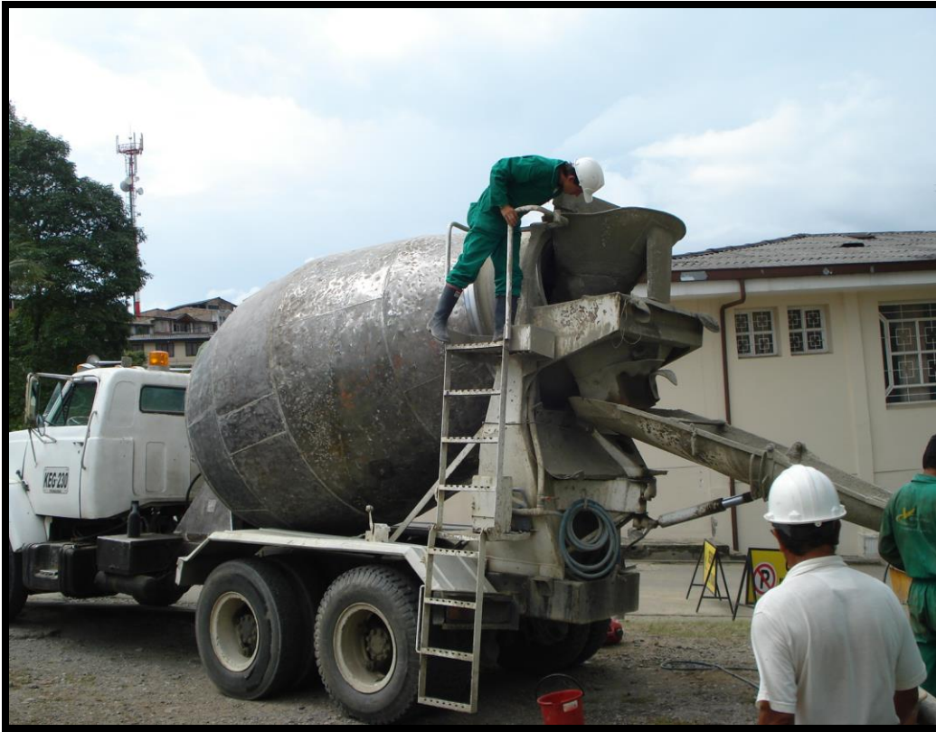
FOTO 41. REVISION DE CONSISTENCIA DE LA MEZCLA CON EL ADITIVO
