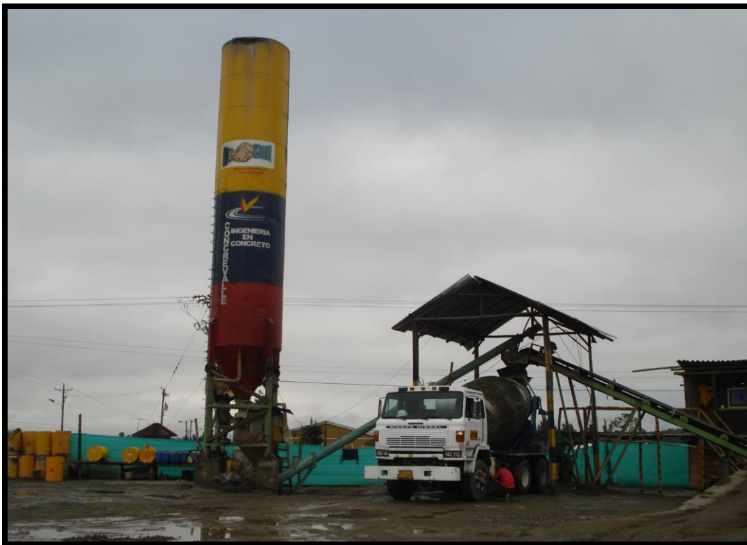
FOTO 21. SILO DE ALMACENAMIENTO DE CEMENTO Y VEHICULO CARGANDO
