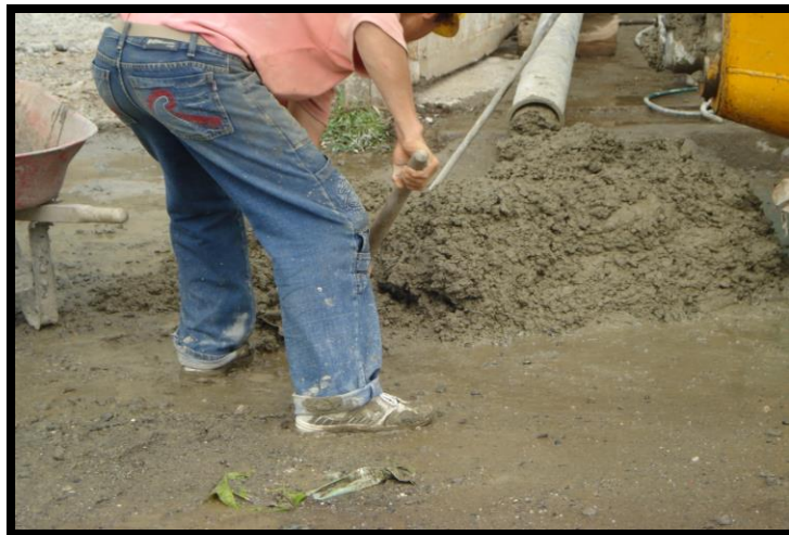
FOTO 33. RECOLECCION DE CONCRETO VACIADO EN EL PISO
