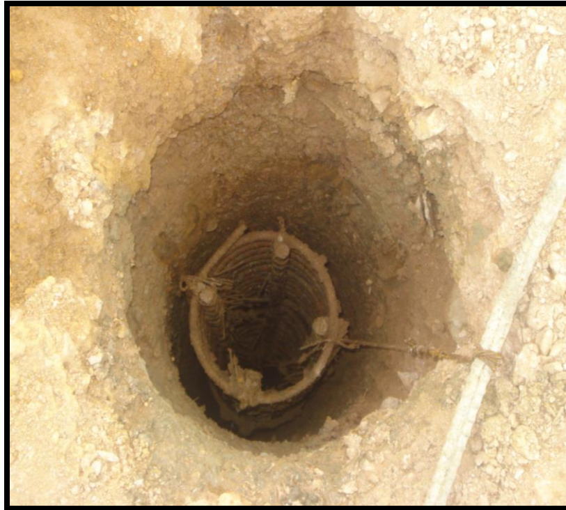
FOTO 50. PILOTE CON EL REFUERZO DENTRO
