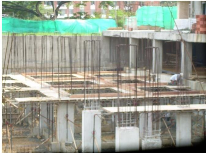
Figura 30. Encofrado vigas sótano superior zona F.
