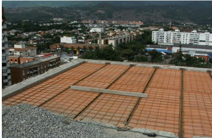
Figura 70. Bloquelón y malla electro soldada terraza pent-house.
