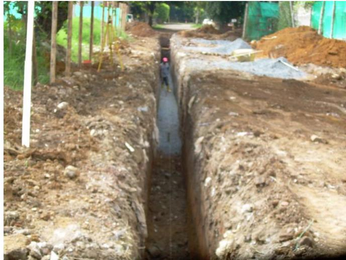
Figura 46. Colocación de lecho de filtro.
