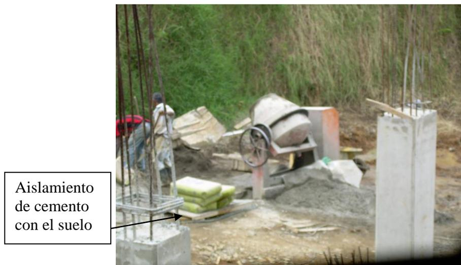
Figura 19. Sitio de mezcla de concreto.
