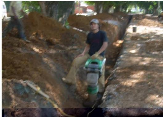
Figura 48. Compactación de zanjas de alcantarillado.
