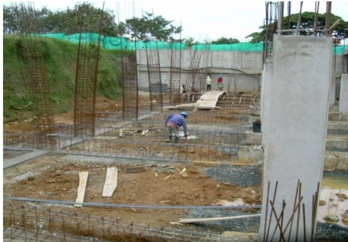
Figura 24. Armado de vigas centradoras zona F.
