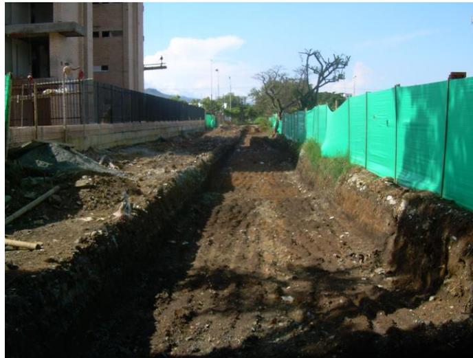
Figura 74. Excavación de calzada
