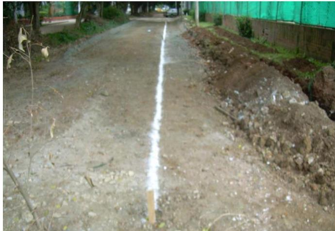
Figura 42. Trazado de eje para excavación de alcantarillado.
