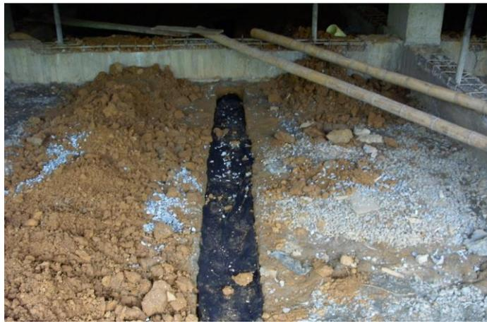
Figura 61. Drenaje con geotextil sótano inferior zona F.
