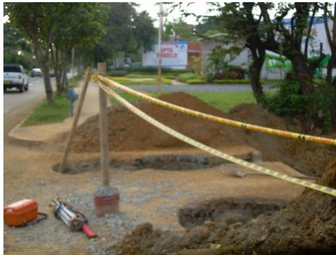
Figura 53. Señalización construcción de alcantarillado
