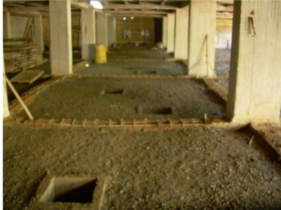
Figura 62. Sistema de drenaje sótano inferior zona F.
