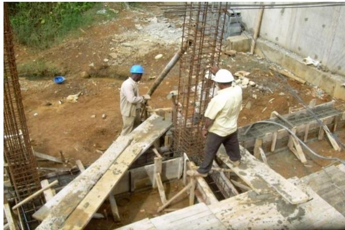
Figura 26. Fundición de vigas de cimentación Zona F.
