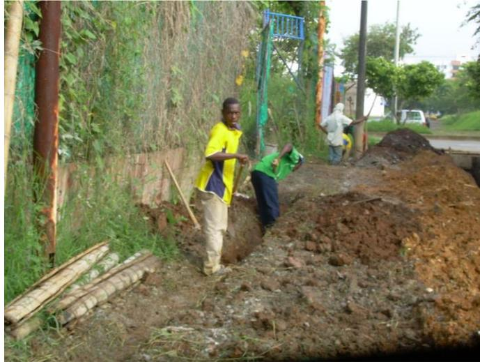
Figura 38. Excavación para tubería de acueducto exterior.
