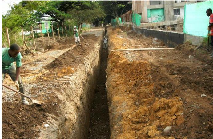
Figura 43. Excavación alcantarillado pluvial cll 13ª1.
