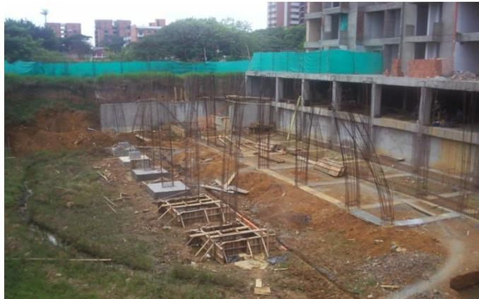
Figura 20. Encofrado y fundición de zapatas en la estructura de parqueadero.
