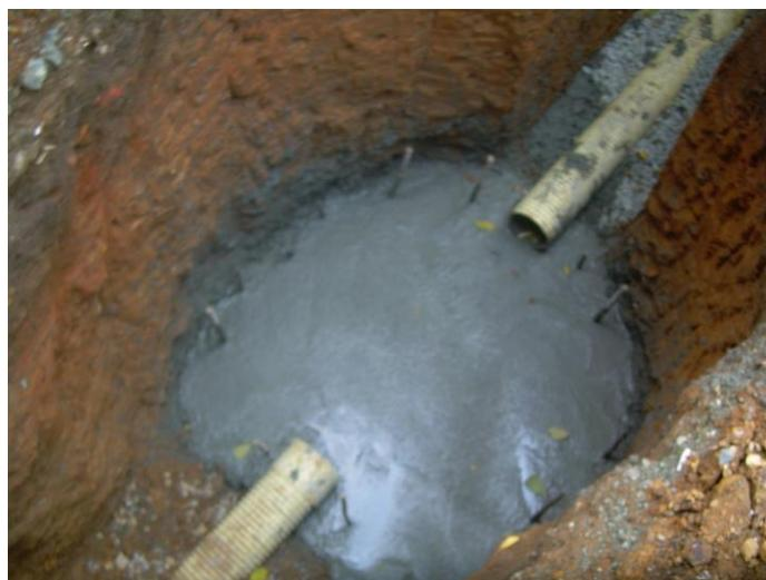
Figura 50. Losa inferior cámara de inspección tipo B alcantarillado pluvial cll 13ª1.
