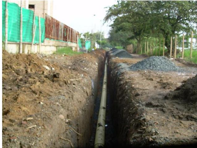
Figura 47. Instalación tubería alcantarillado pluvial cli 13<sup>a</sup>1.
