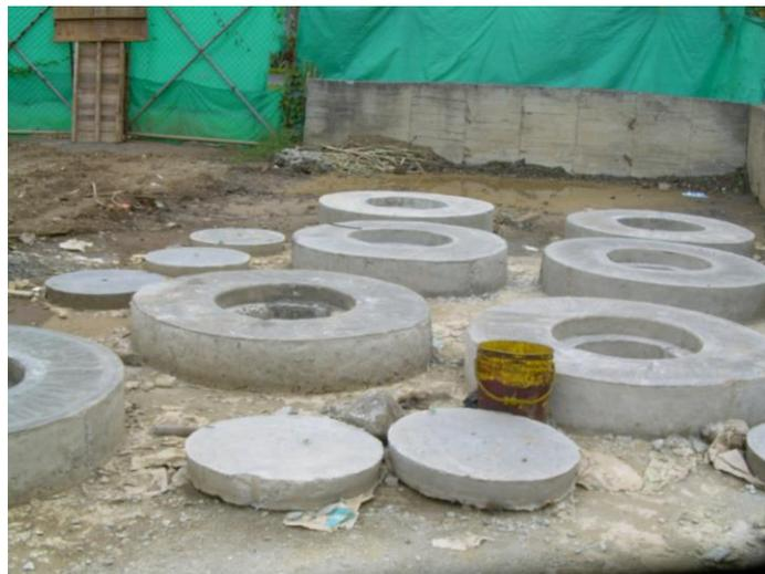
Figura 52. Fundición de losas superiores para cámaras de inspección.
