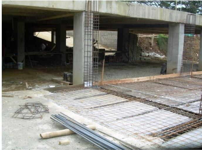
Figura 32. Fundición de losa sótano superior zona F.
