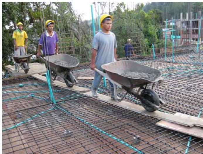
Figura 31. Transporte del concreto hecho en obra
