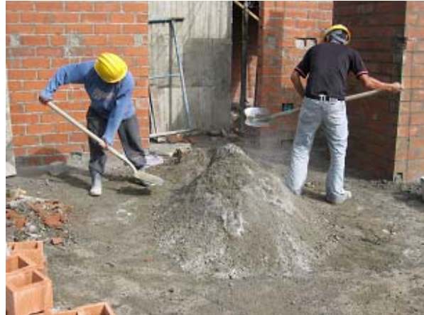
Figura 12 Mezclado para mortero de pega
