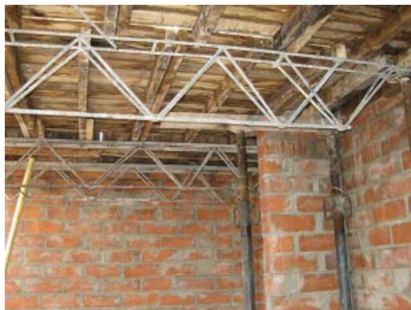
Figura 50. Cerchas y Tacos utilizados en obra
