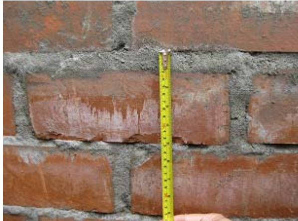
Figura 55. Juntas horizontales en la mampostería estructural
