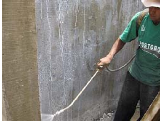
Figura 38. Curado con antisol.
