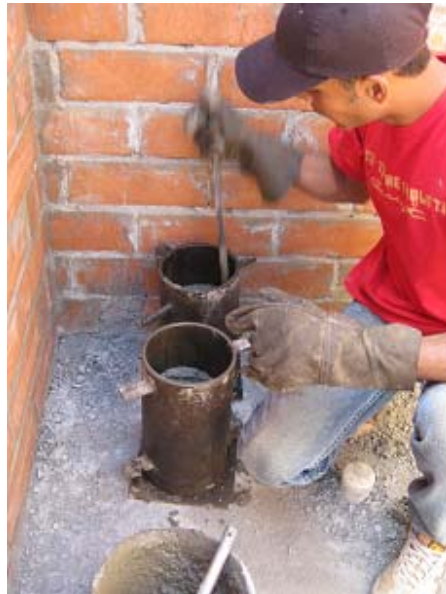
Figura 22. Toma de cilindros para mortero de relleno
