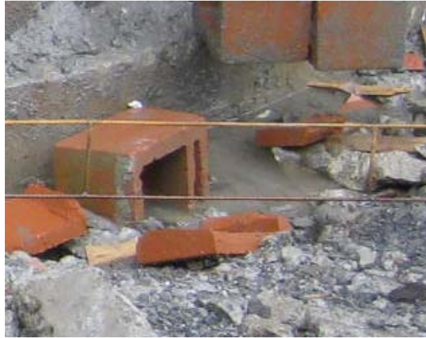
Figura 48. Ladrillos fracturados
