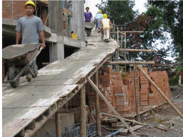
Figura 30. Transporte de concreto hecho en obra
