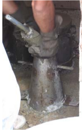
Figura 40. Asentamiento del concreto premezclado
