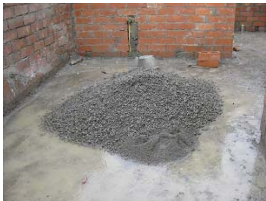
Figura 21. Sitio de mezcla del mortero de relleno
