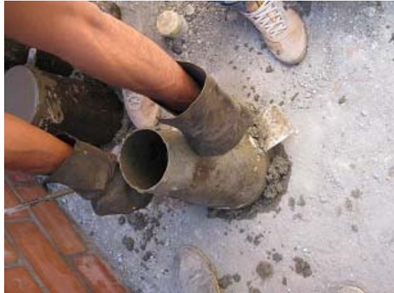
Figura 24. Toma del asentamiento al mortero de relleno
