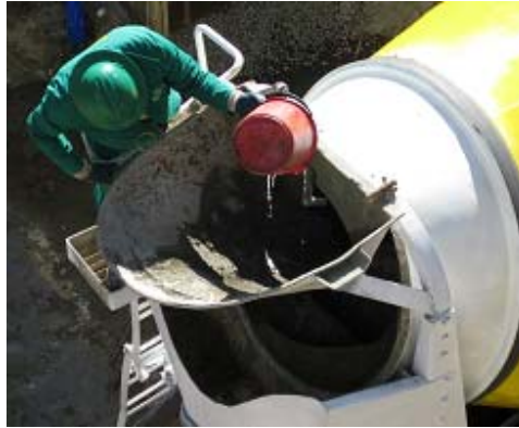
Figura 9. Aplicación del súper-plastificante a la mezcla
