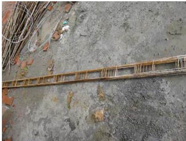
Figura 54. Escalerilla utilizada en la mampostería estructural
