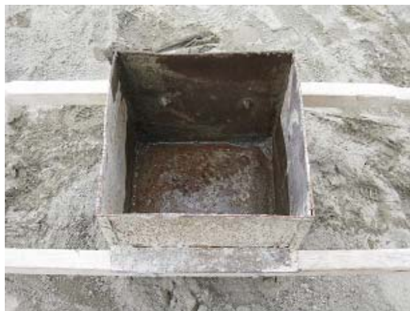
Figura 2. Cajón utilizado en la dosificación en volumen
