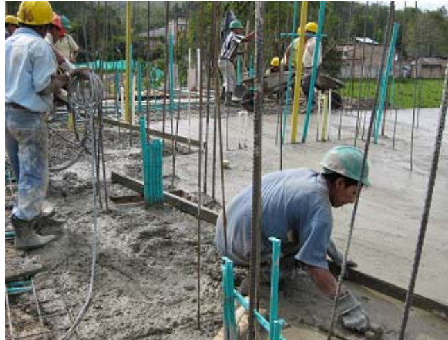
Figura 35. Acabado del concreto
