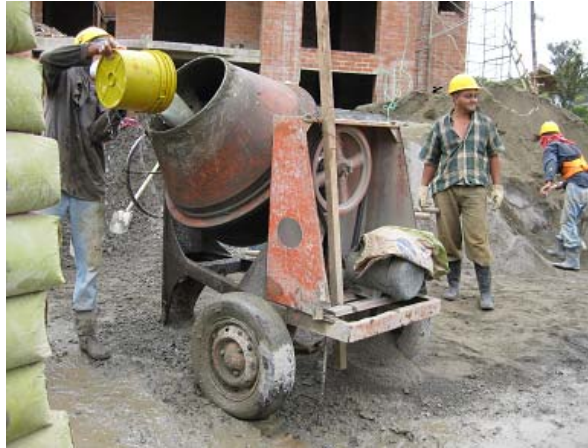
Figura 29. Mezclado de los materiales del concreto hecho en obra
