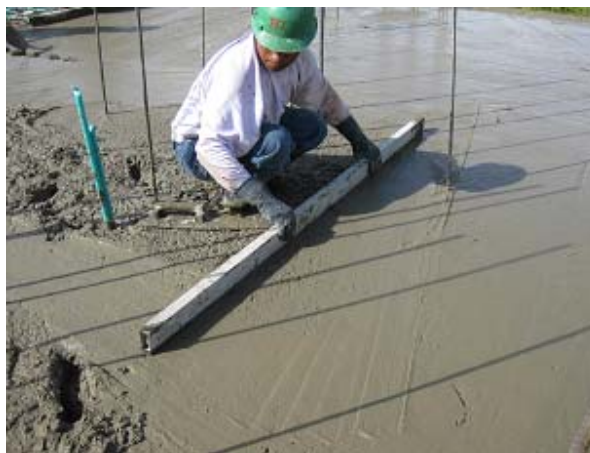
44. Acabado del concreto premezclado
