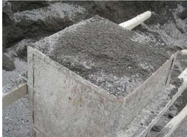
Figura 28. Enrase de los cajones que se utilizan en la dosificación del concreto
