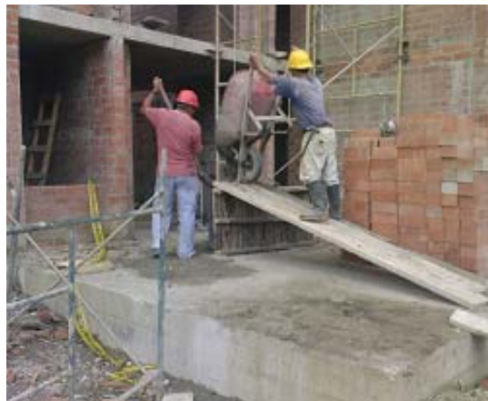
Figura 32. Vaciado del concreto en el cucharón
