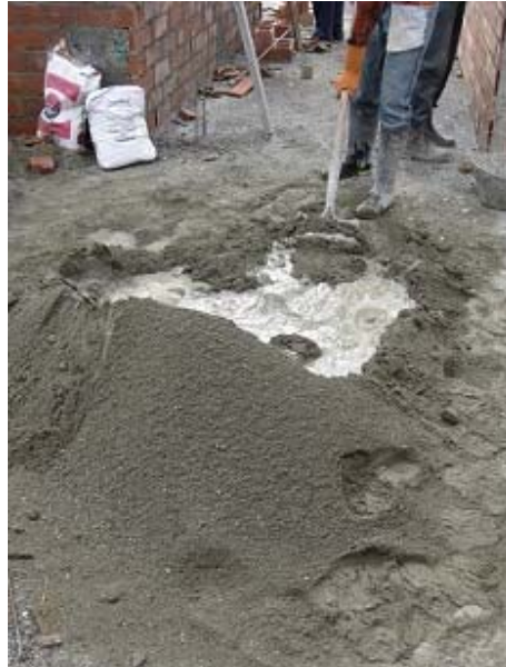
Figura 19. Adición de agua para el mortero de relleno
