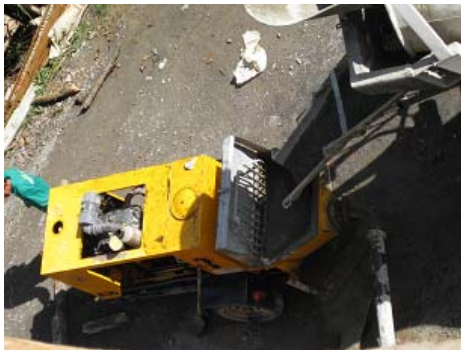
Figura 41. Bomba utilizada para la fundición con concreto premezclado
