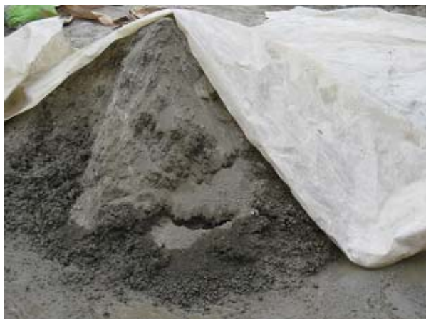
Figura 18. Protección de mortero de pega contra la lluvia
