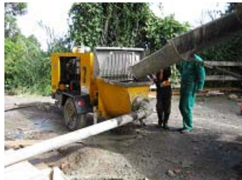
Figura 42. Colocación del concreto en la bomba
