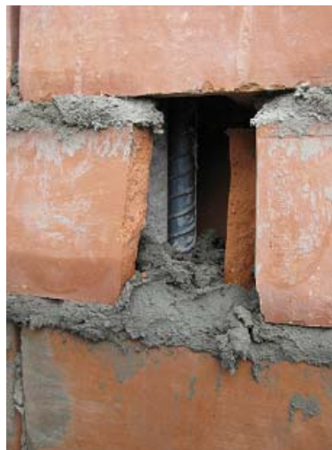
Figura 56. Ventanas de Inspección
