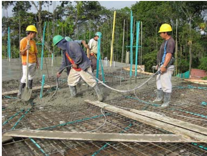
Figura 34. Vibrado del concreto
