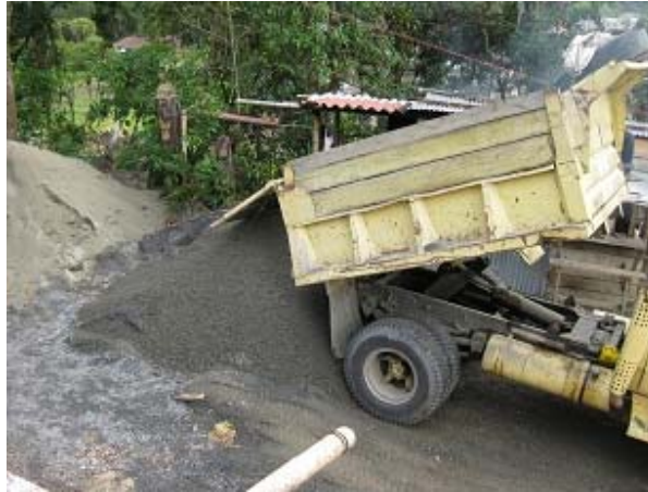
Figura 25. Llegada del agregado a la obra
