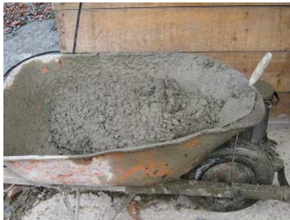
Figura 64. Concreto para la toma de cilindros
