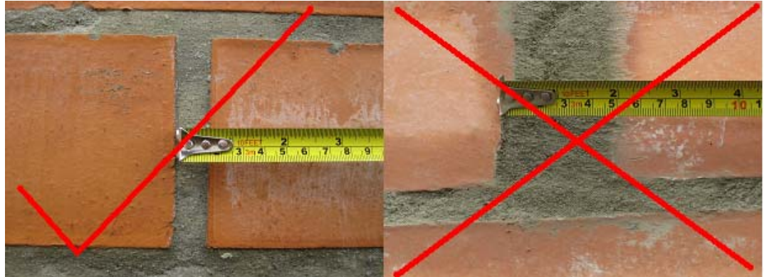
Figura 53. Juntas verticales
