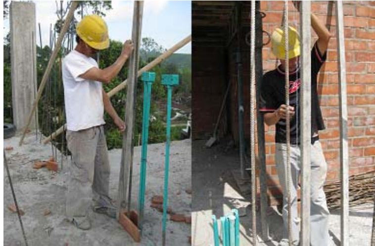
Figura 57. Verticalidad en los muros estructurales
