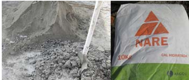
Figura 17. Adición de cal hidratada al mortero de pega
