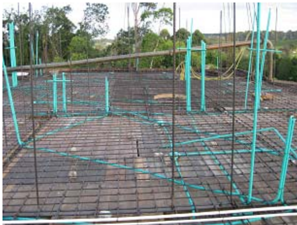
Figura 51. Acero de refuerzo de losa de entrepiso
