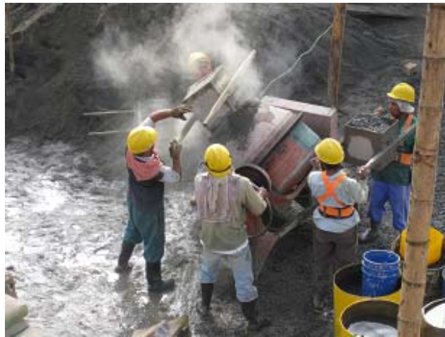
Figura 27. Dosificación en volumen de la mezcla
