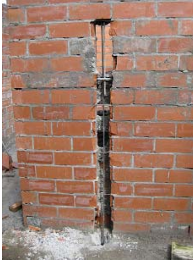
Figura 59. Regateada de los muros
