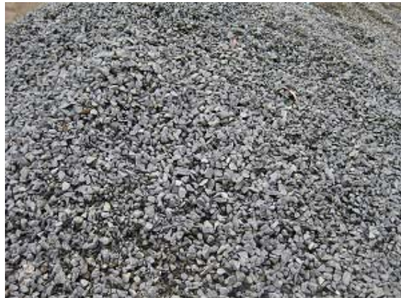
Figura 7. Agregado grueso utilizado en la obra
