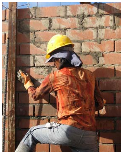
Figura 58. Rebitada de los muros
