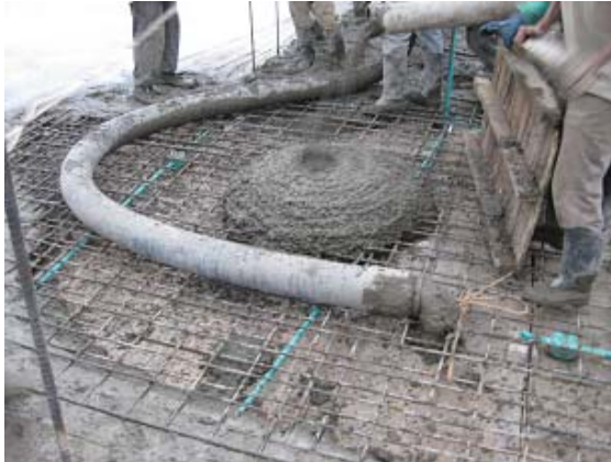
Figura 43. Colocación del concreto en el sitio de fundición
