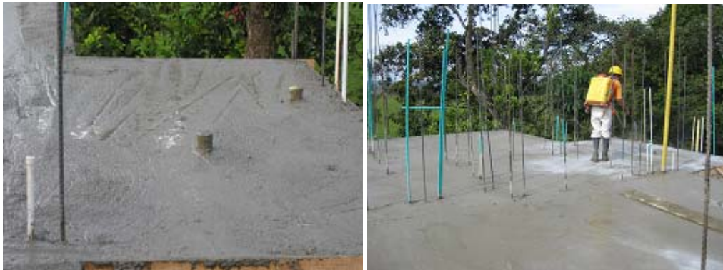
Figura 37. Curado con antisol
