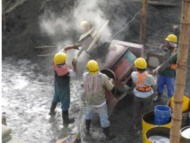
Figura 61. Producción del concreto
