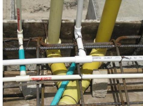
Figura 73. Corrección traslapando una barra
