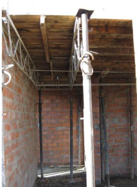
**Figura 44. Elementos del encofrado**
