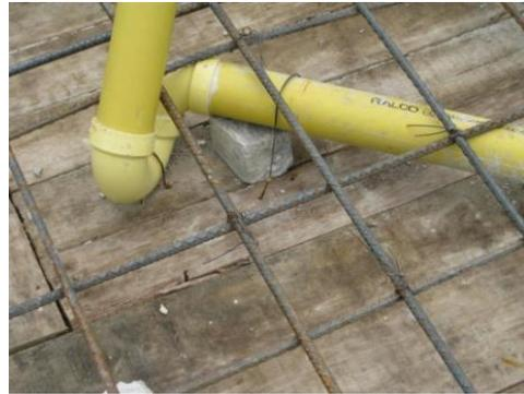
Figura 77. Corrección con "panelas" de concreto
