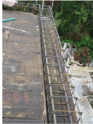
**Figura 53. Refuerzo de viga terminado**
