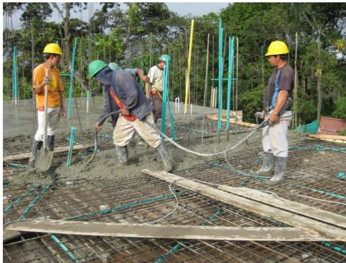
**Figura 65. Compactación por vibración interna**
