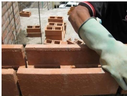
**Figura 33. Colocación del bloque viga**
