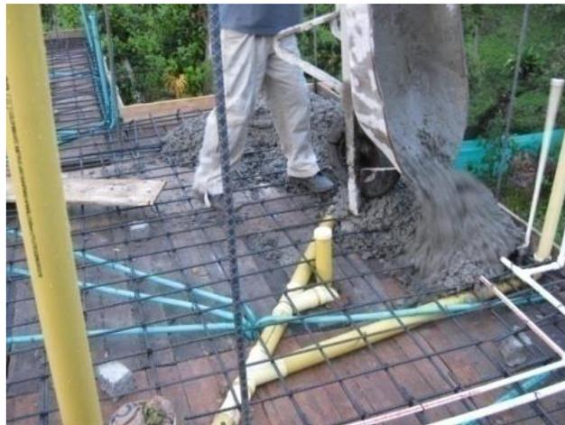
Figura 64. Vaciado del concreto en el sitio requerido
