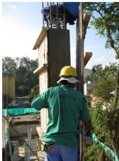
**Figura 84. Desencofrado de la columna**
