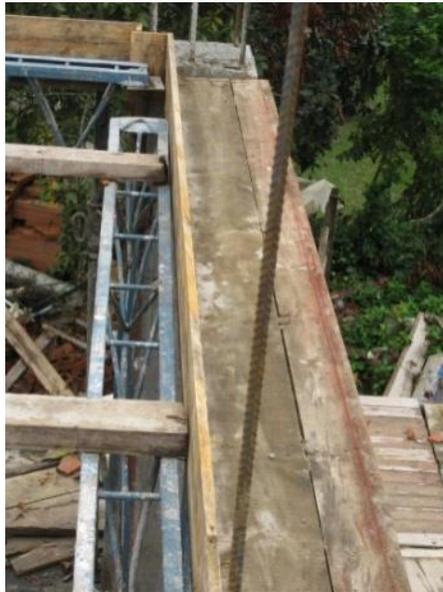
**Figura 46. Puente para el encofrado de las vigas del borde de la losa**
