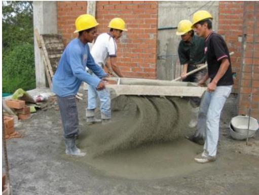
Figura 17. Tamizado de la mezcla
