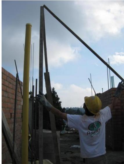
**Figura 29. Colocación de los vientos**
