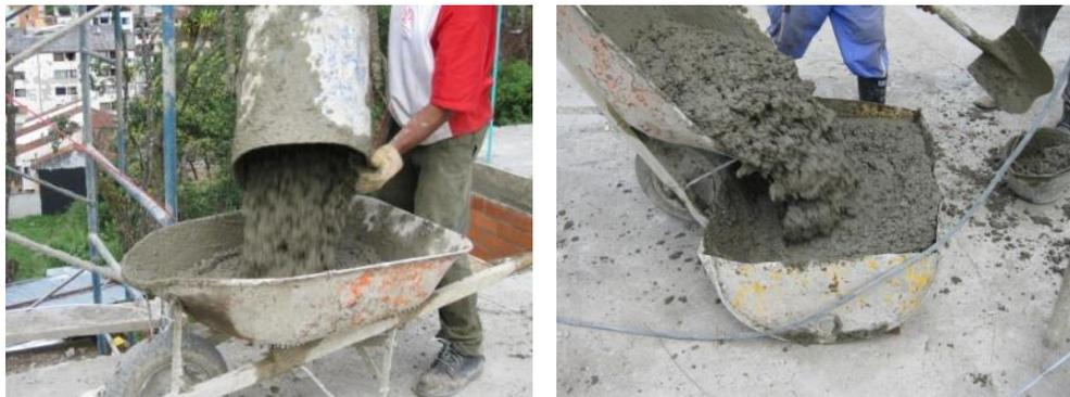
Figura 86. Transporte del concreto
