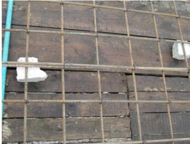
**Figura 56. "PANELAS" o trozos de concreto**
