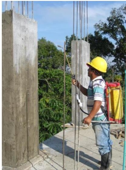
Figura 85. Curado de la columna con antisol blanco
