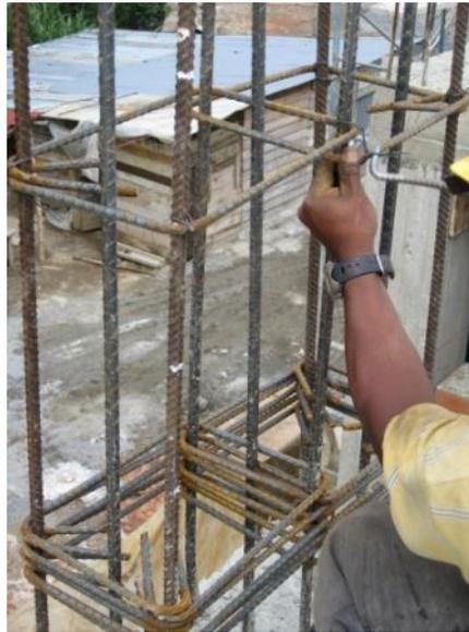
Figura 79. Colocación de los estribos
