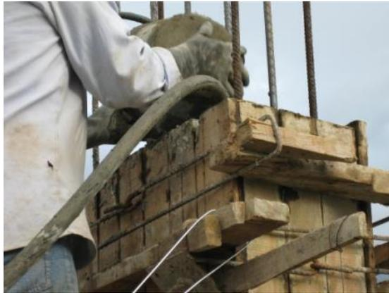
**Figura 82. Vaciado del concreto**
