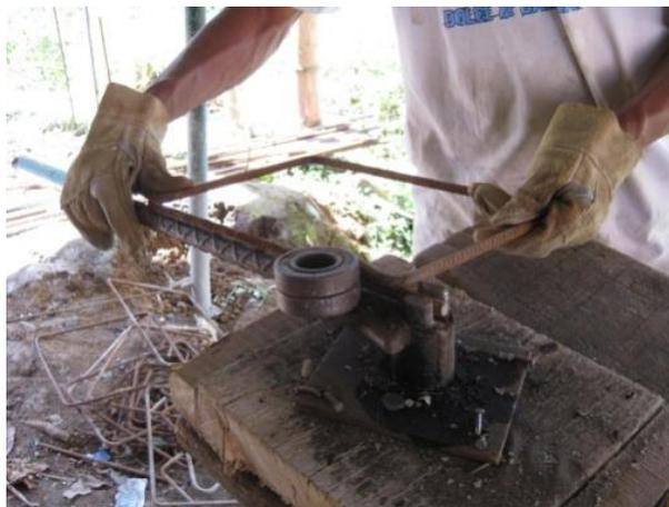
Figura 78. Figurado de los estribos
