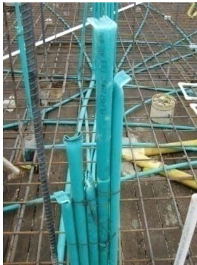
**Figura 48. Tuberías dobladas para su protección**
