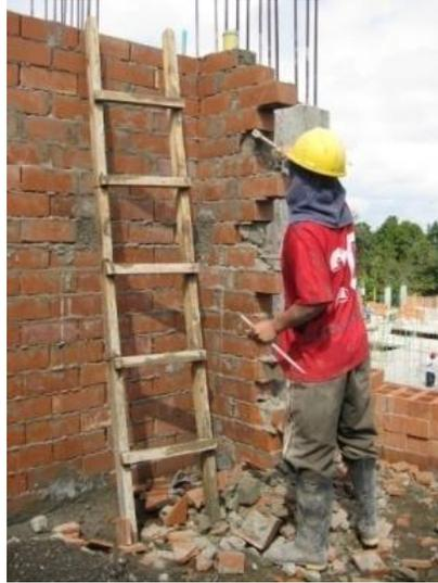
**Figura 40. Demolición del muro**
