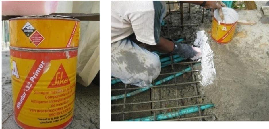
Figura 71. Aplicación del epóxico para la adherencia de los concretos
