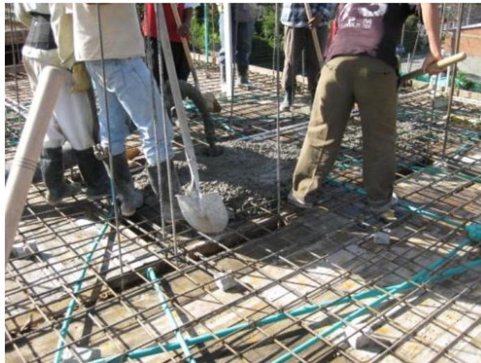
**Figura 69. Vaciado del concreto**
