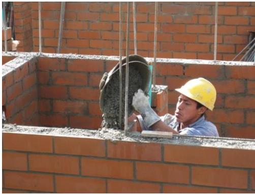
Figura 21. Fundición de celdas y dovelas
