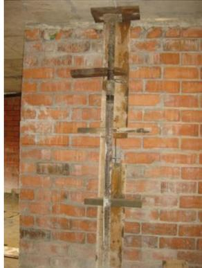
Figura 42. Encofrado
