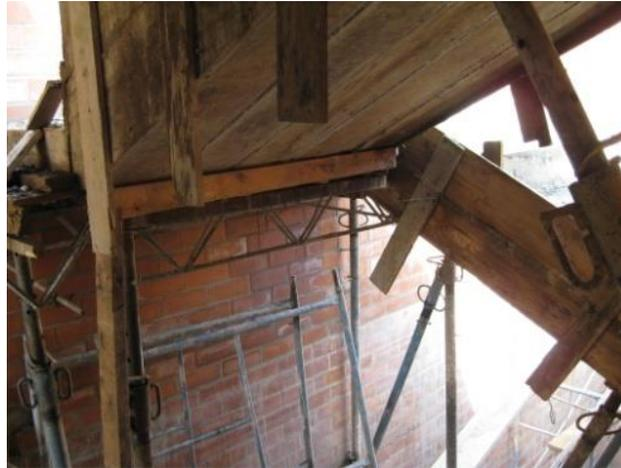
**Figura 87. Encofrado de las gradas**
