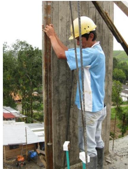
**Figura 30. Chequeo del plomo del codal**
