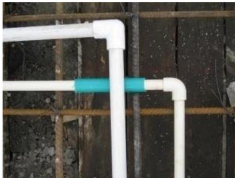
**Figura 50. Aislamiento de la tubería de agua caliente**
