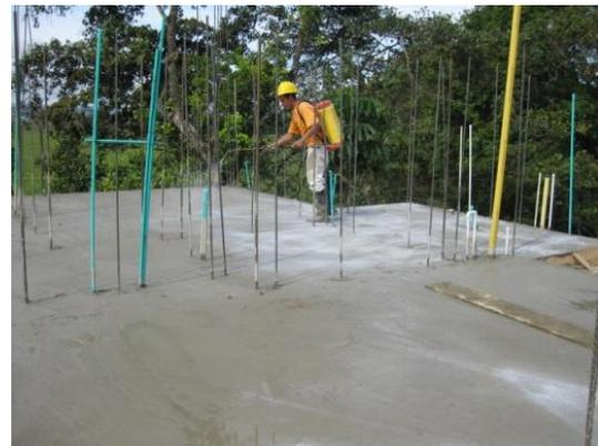
**Figura 70. Curado del concreto con antisol blanco**
