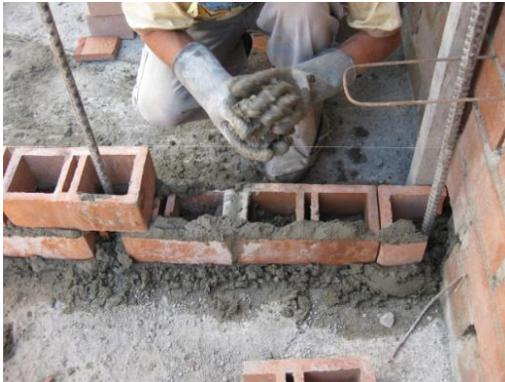
Figura 27. Posición de los conectores
