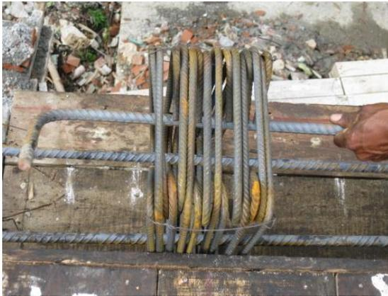
**Figura 52. Colocación de los estribos por grupos**
