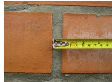
**Figura 38. Junta de pega correcta**
