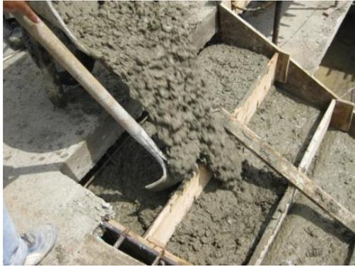
**Figura 90. Vaciado del concreto**
