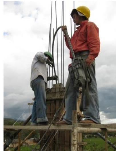
**Figura 83. Compactación por vibración interna**
