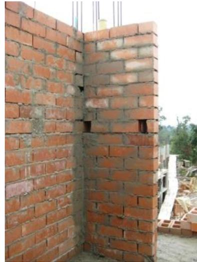
**Figura 39. Corrección del muro a escuadra**
