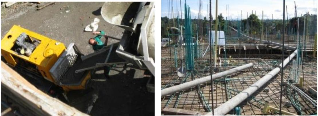
**Figura 68. Sistema de bombeo constituido por la bomba, tolva y las tuberías**
