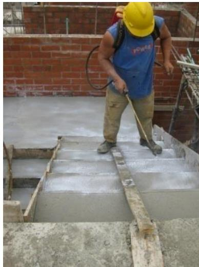
**Figura 92. Curado de las gradas con antisol blanco**
