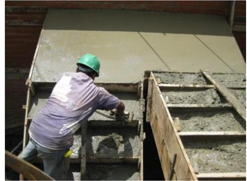
**Figura 91. Acabado del concreto con llana**
