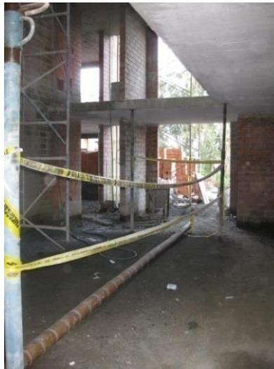
**Figura 101. Colocación de las cintas de advertencia de peligro**
