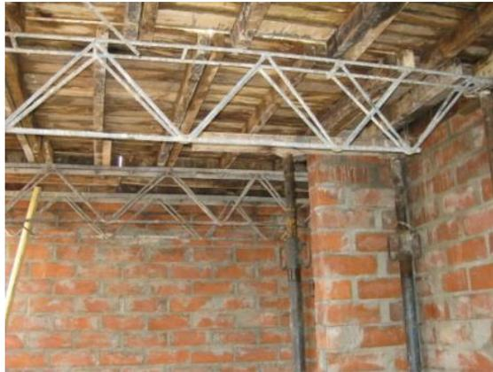
**Figura 45. Colocación del encofrado**
