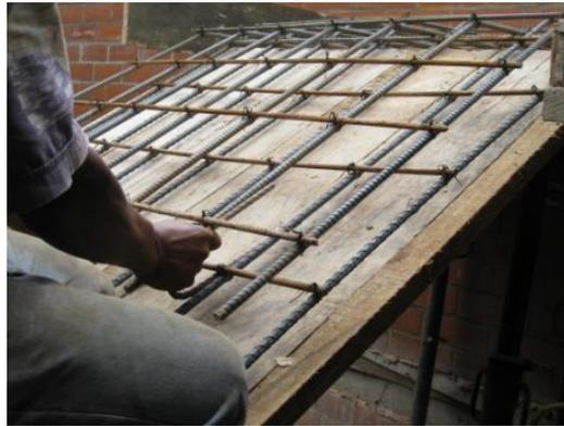
**Figura 89. Colocación del acero de refuerzo**
