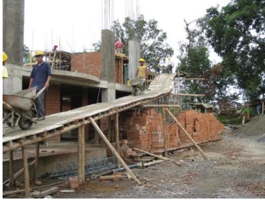
Figura 62. Transporte en la rampa
