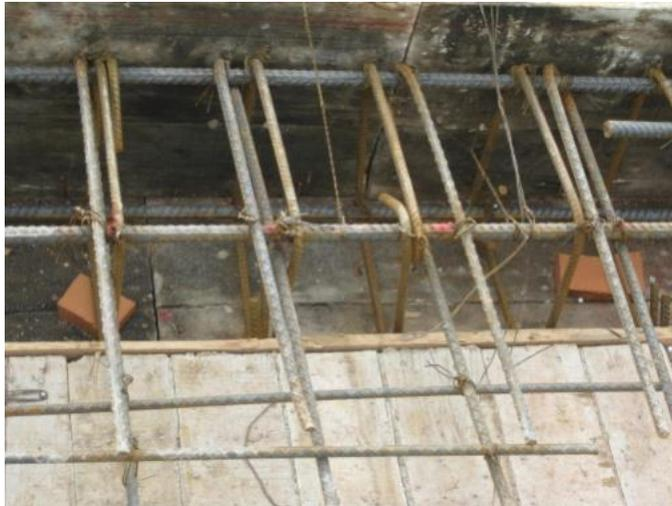
**Figura 75. Recubrimiento de las vigas con pedazos de ladrillo**
