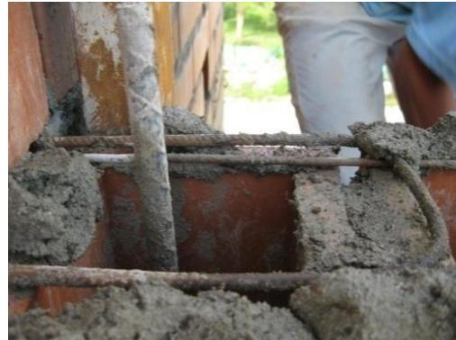
Figura 28. Conectores embebidos por el mortero
