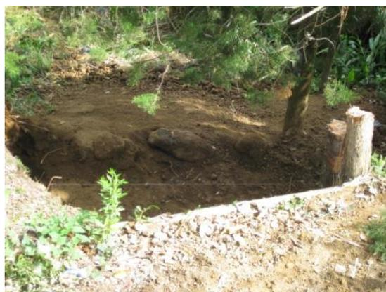
**Figura 5. Excavación para el muro de contención**
