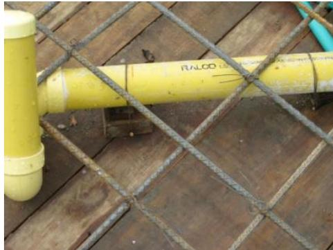
Figura 76. Soporte de tubería con madera
