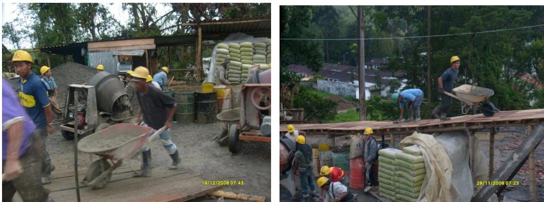
Fig.7.13 Transporte de concreto con boogies hasta el tercer nivel
