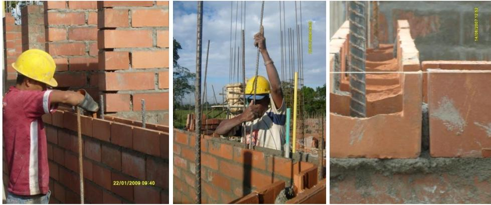
Fig.5.15. Refuerzo vertical y longitudes de traslapo.
