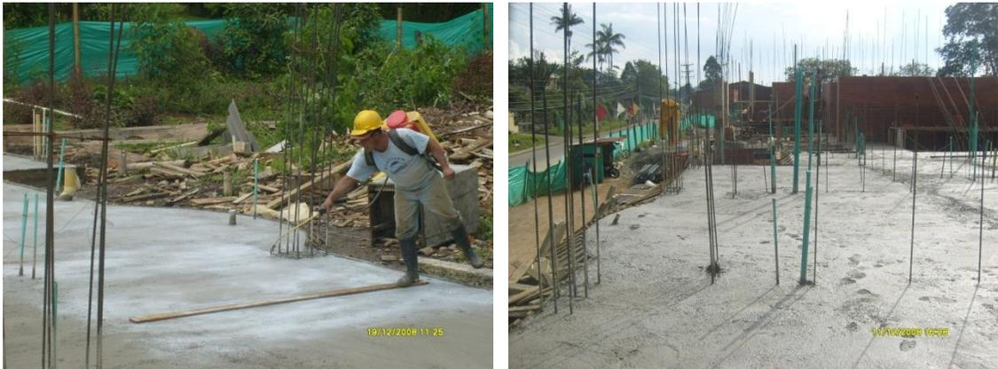
Fig.7.23. Aspecto general de la losa terminada.
