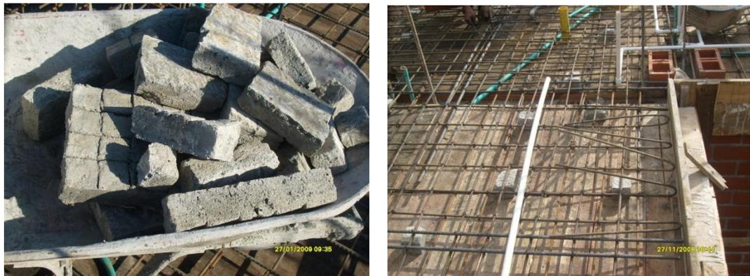
Fig. 7.8. Bases separadoras o panelas para el recubrimiento.
