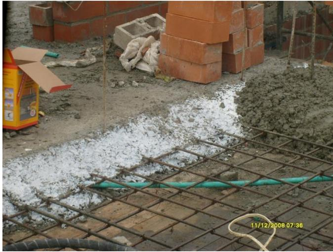
Fig.7.22. Aplicación del adhesivo.
