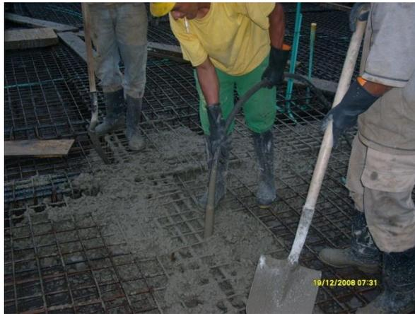
Fig.7.18. Vibrado del concreto
