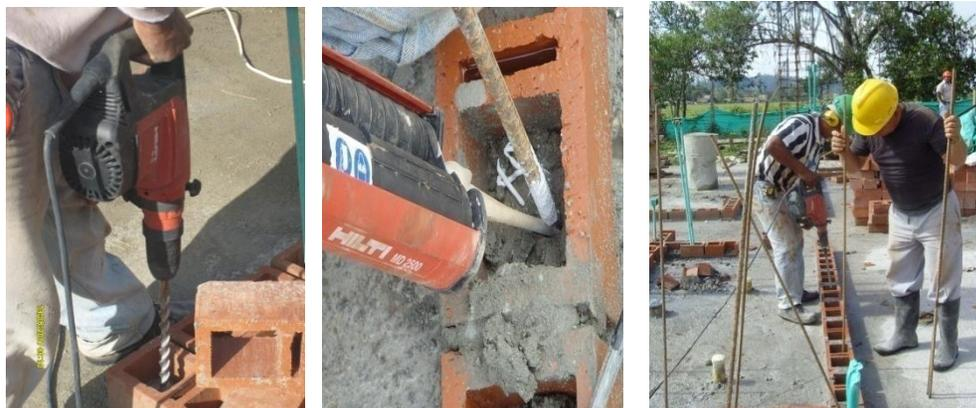
Fig.5.6. Anclaje de varillas según planos estructurales
