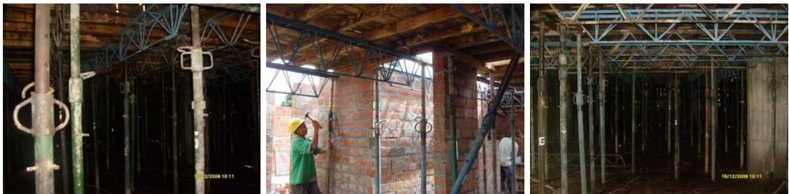
Fig.7.4. Gatos, cerchas y tableros para el encofrado.
