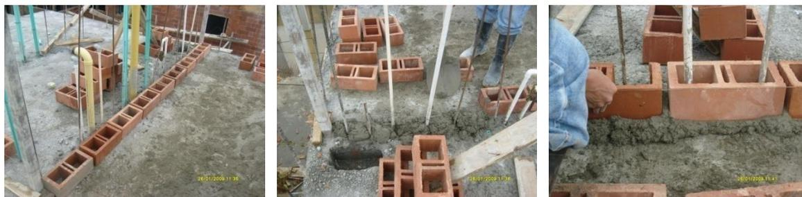
Fig.5.11. Colocación de la primera hilada.
