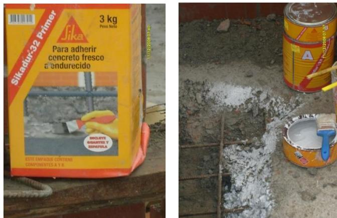
Fig.7.21. Aplicación de adhesivo epóxico de Sika.
