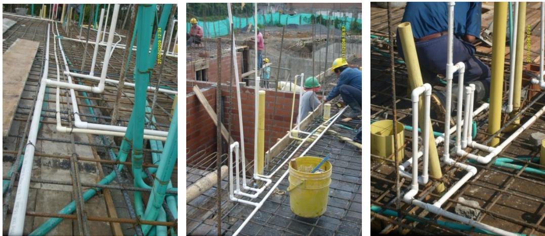
Fig.7.14. Ubicación de puntos hidráulicos.
