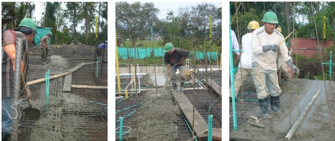
Fig.7.14. Elaboración de plantillas y vibrado del concreto.
