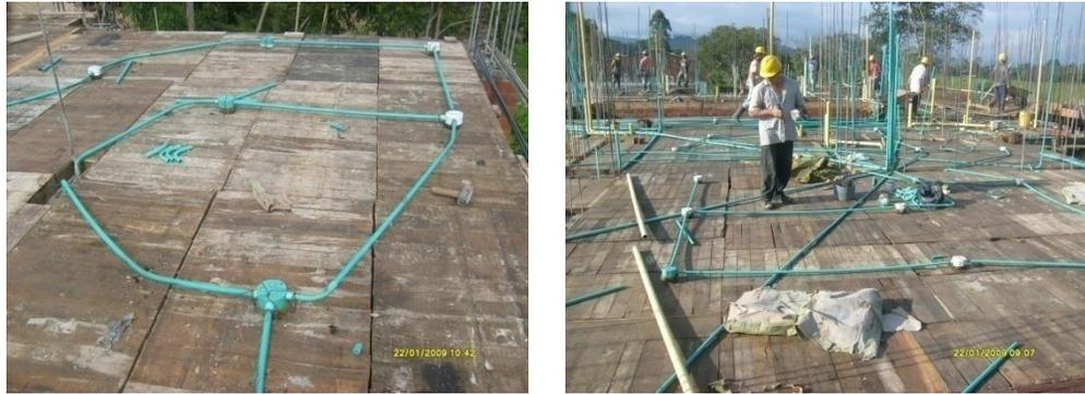
Fig. 7.9. instalación de ductos electricos.
