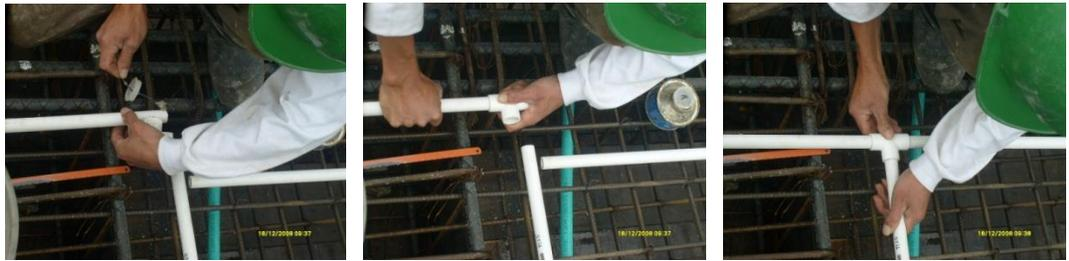
Fig. 6.4. Limpieza e instalación de tubería hidráulica.
