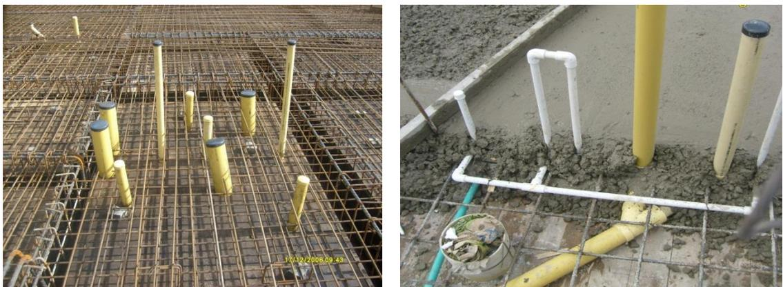
**Fig.6.2. Protección de bocas hidráulicas utilizando tapones**
