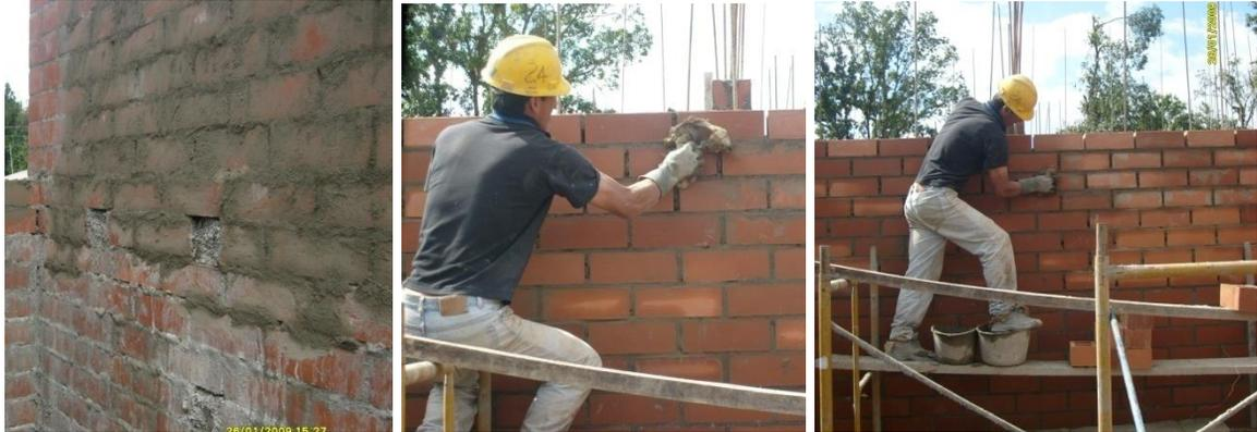
Fig.5.14. Rebitado de muros
