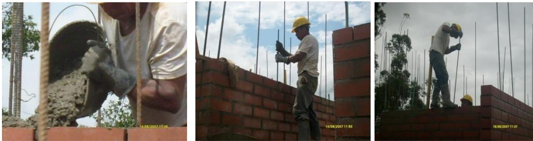
Fig.5.16. Inyección y varillado del mortero de inyección (grouting).
