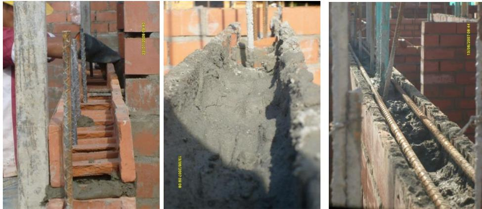
Fig.5.18 Construcción vigas de amarre.
