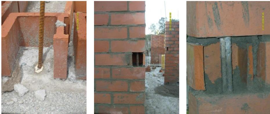
Fig.5.17.Ubicacion de ventanas de inspección.
