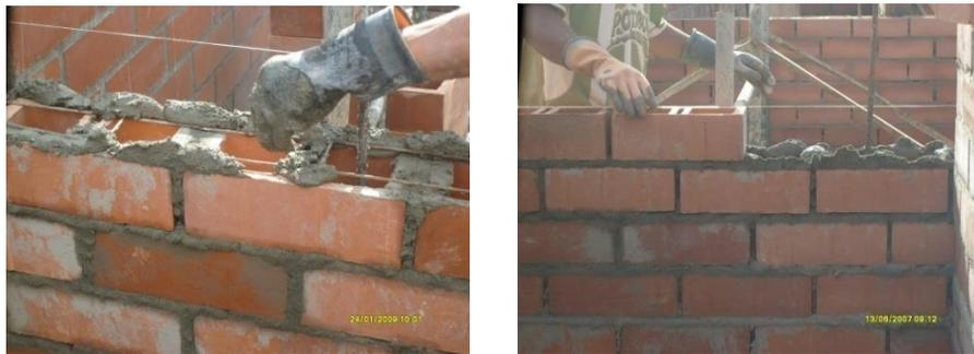
Fig.5.13. Mortero de pega en juntas horizontales.
