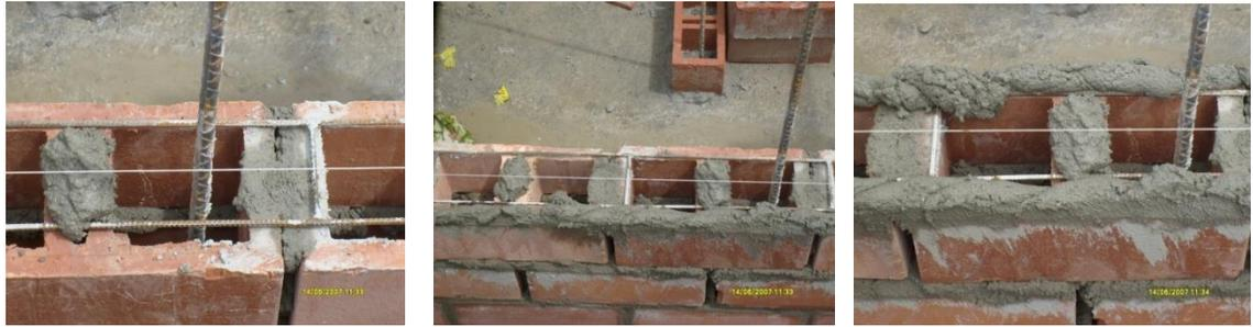
Fig. 5.6. Refuerzo horizontal embebido en el mortero de la junta.
