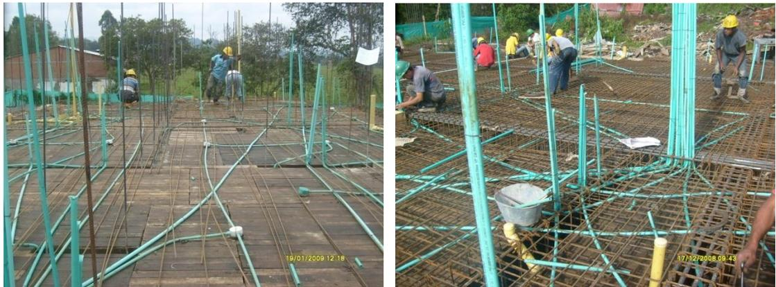
Fig.7.10. Colocación de tuberías para la instalación de tomas e interruptores.
