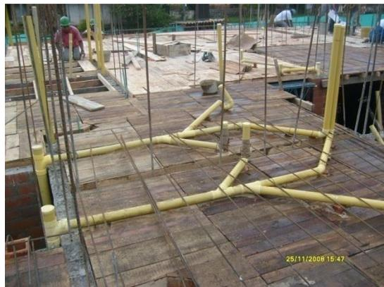
Fig.6.1. Esquema general de instalacion de redes hidrosanitarias.
