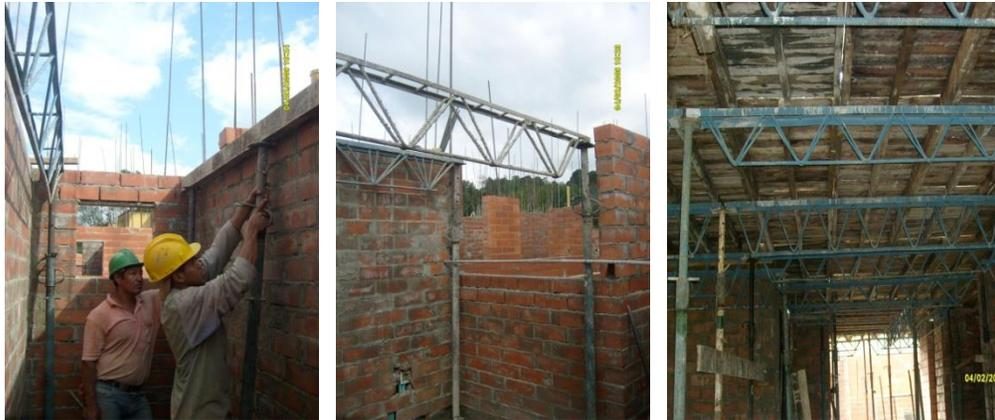
Fig.8.5. Encofrado de la losa de entrepiso.
