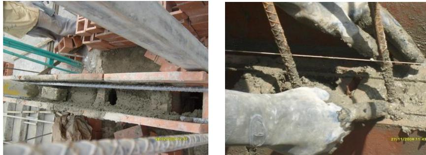
Fig.5.14. Viga de amarre embebida en mortero de inyección (grouting)
