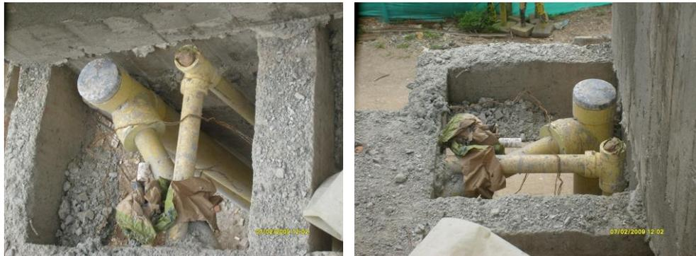
Fig.5.15.a. Buitrones para tuberías sanitarias.
