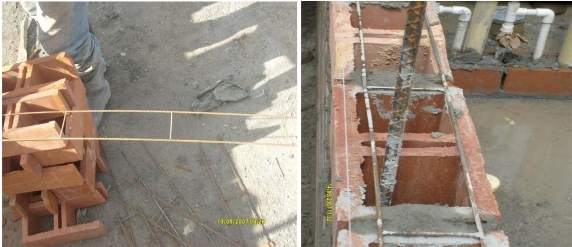
Fig. 5.5 Grafil de 4mm. (Escalerilla) para refuerzo horizontal.
