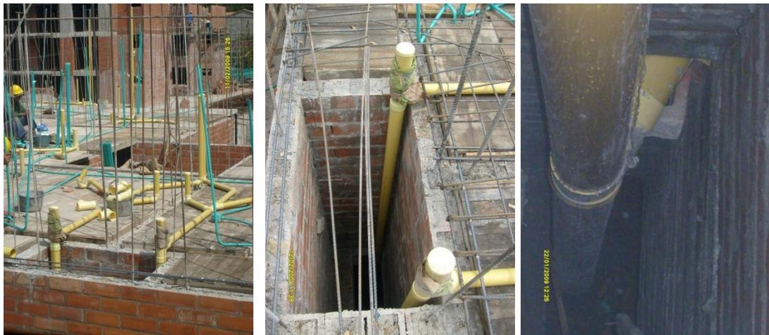
Fig.6.3. Tubería sanitaria bajando por los buitrones.
