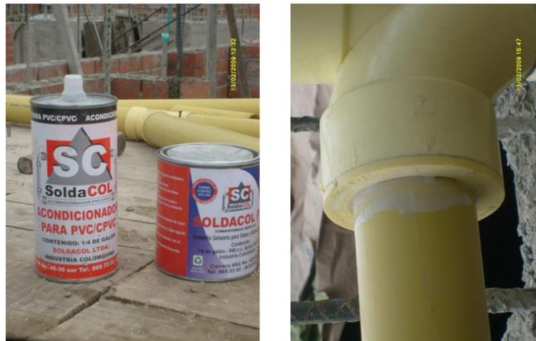
Fig.6.5. Implementos para la soldadura en PVC.
