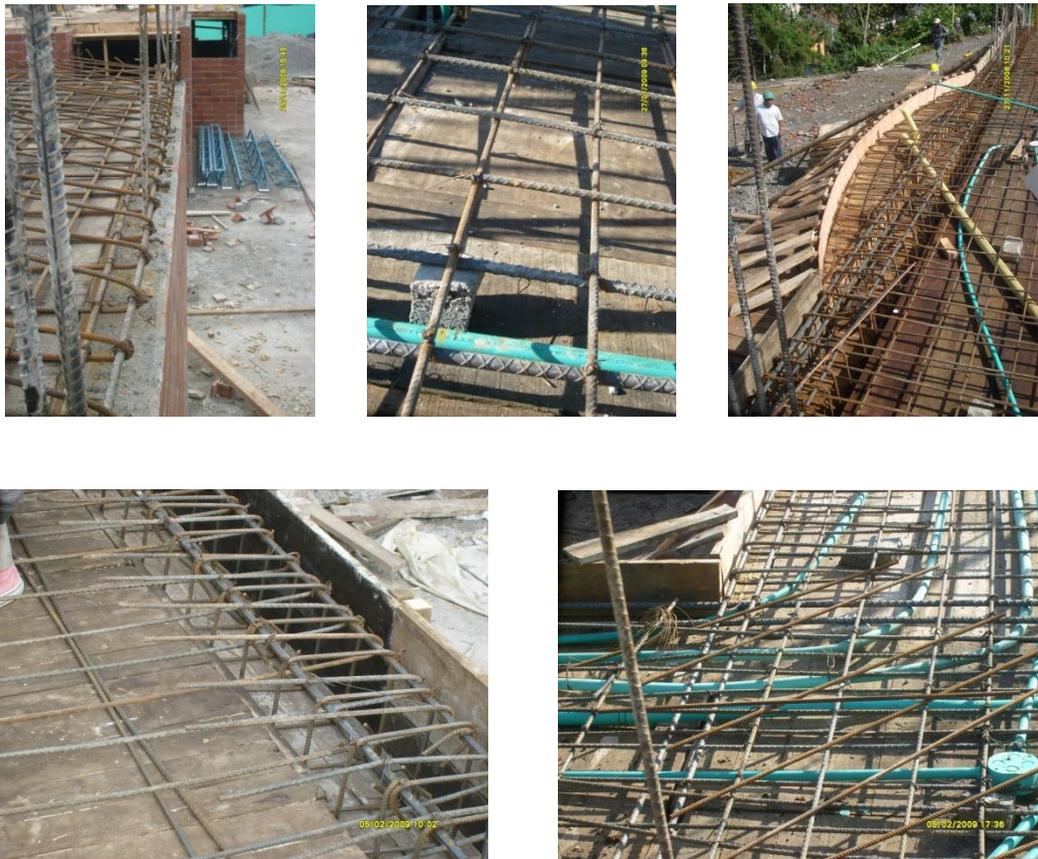
Fig. 7.7. Detalles colocación de la parrilla de refuerzo.
