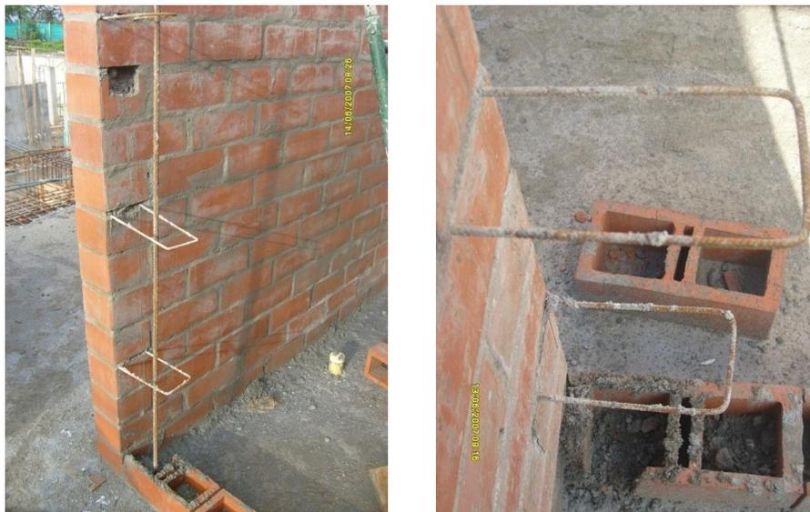
Fig. 5.6. Conectores espaciados a 4 hiladas para muros sin traba.
