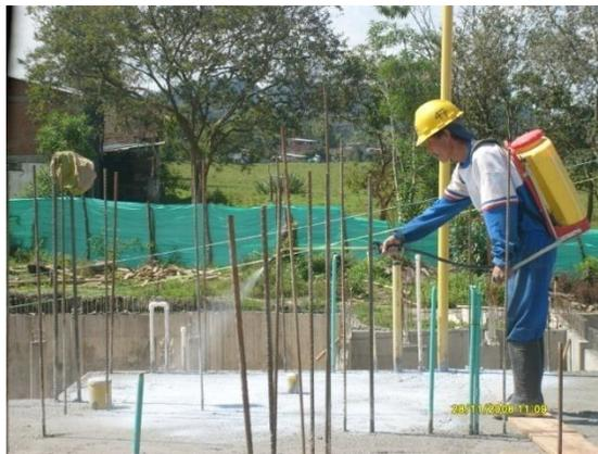
Fig.7.19. curado del concreto.
