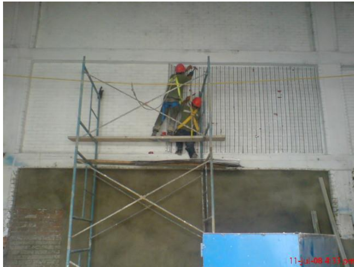
Fotografía 6. Trabajo en alturas – Arreglo de muros
