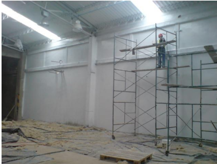
Fotografía 5. Trabajo en alturas – Pintado de techos en el área de Nueva Bodega de Producción
