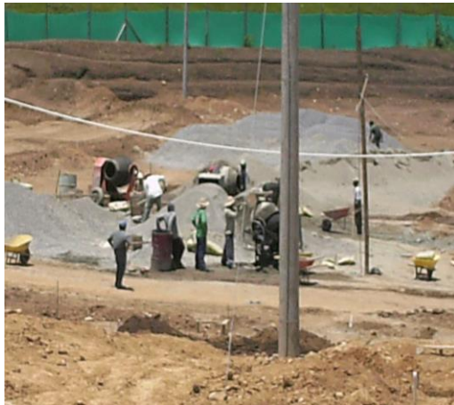
PREPARACIÓN DE LA MEZCLA
