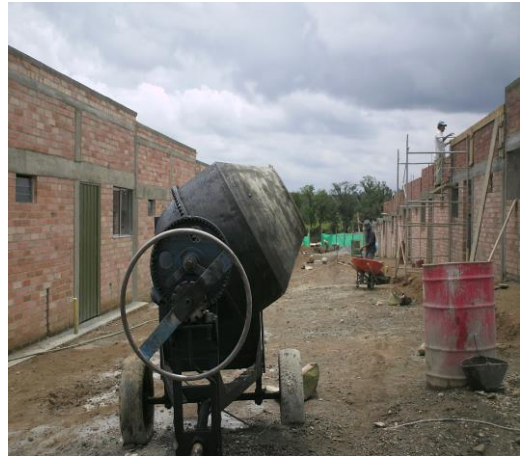
EQUIPO USADO PARA MEZCLAR EL CONCRETO
