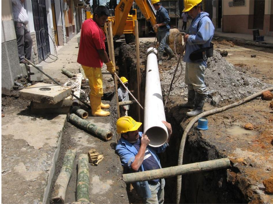
**Figura 26.** Instalación de tubería de 10" para acueducto. Carrera sexta.
