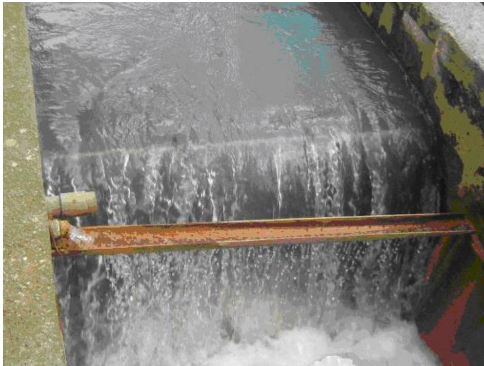
**Figura 11.** Vertedero rectangular sin contracciones para generar resalto hidráulico.
