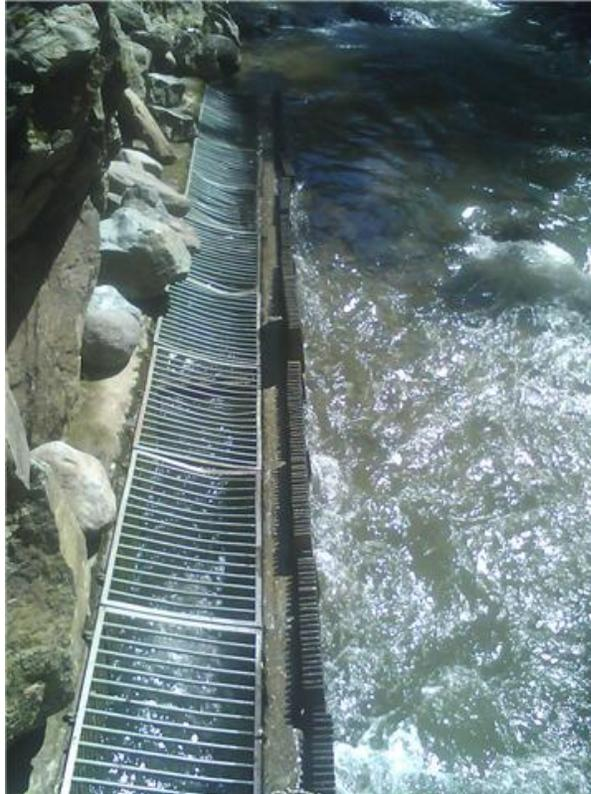
**Figura 2.** Bocatoma Lateral para Río Las Piedras.
