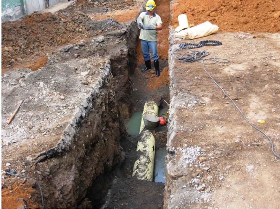
**Figura 28.** Reposición de redes de alcantarillado. Carrera sexta.
