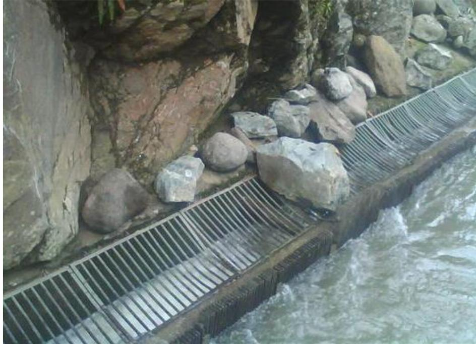
**Figura 20.** Bocatoma Lateral Río Las Piedras. Rejilla obstruida por material de arrastre.
