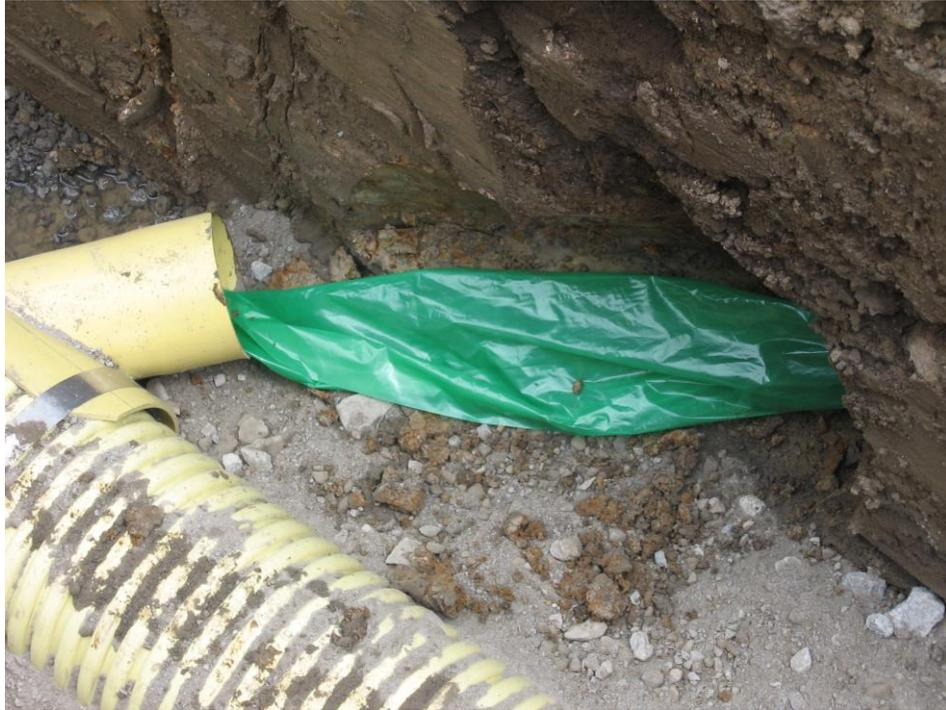
**Figura 29.** Sistema de plásticos para dar continuidad en el servicio de alcantarillado. Carrera sexta.
