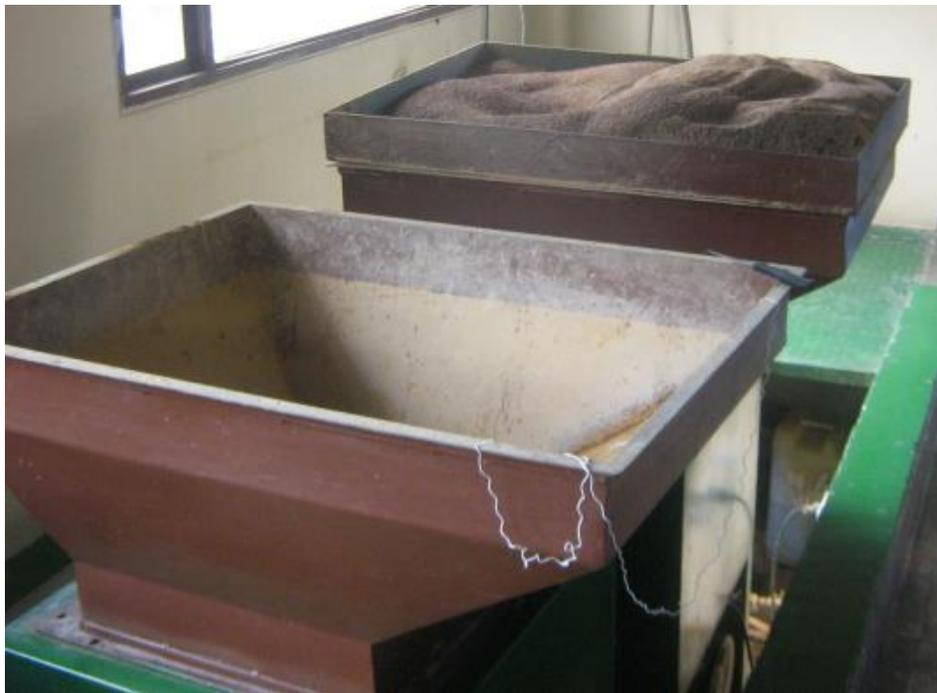
**Figura 12.** Unidades de dosificación de coagulante en polvo. Planta de Tulcán.
