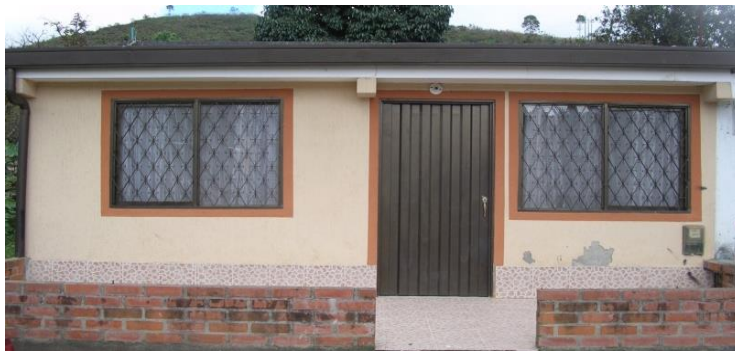
Figura 5.2. Fotografía primer tipo de fachada
