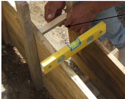
Figura 19. Elemento de tabla midiendo una viga de cimentación
