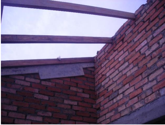
Figura 58. Teleras ubicadas paralelamente
