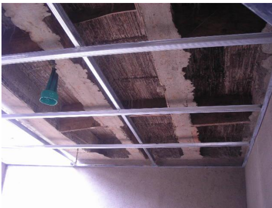
Figura 61. Estructura para colocar el panel yeso
