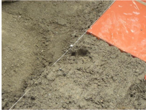
Figura 55. Colocación del hilo con pendiente confluyendo a un mismo punto
