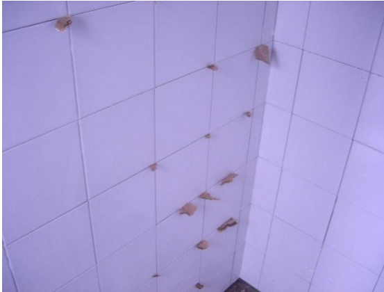
Figura 53. Elementos de cartón para garantizar juntas horizontales
