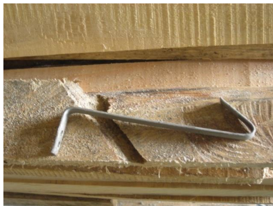
Figura 60. Gancho sujetador de las hojas de asbesto cemento
