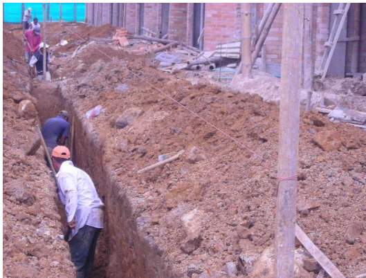
Figura 25. Excavación para alcantarillado tomando desnivel con hilo
