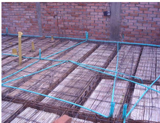
Figura 46. Disposición de instalaciones eléctricas y sanitarias
