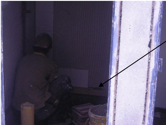
Figura 52. Regla horizontal para apuntalar las piezas del enchape
