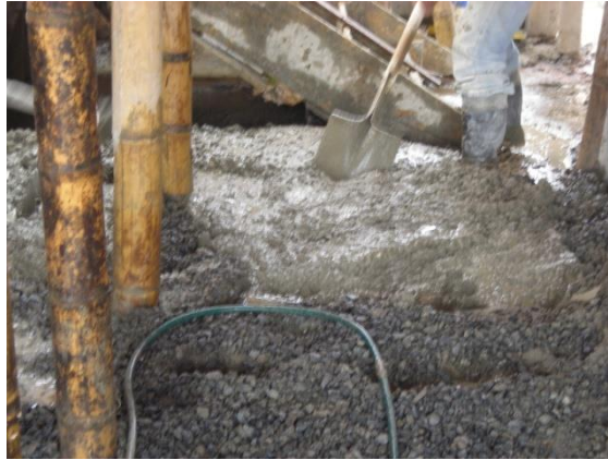
Figura 78. Mezclado manual
