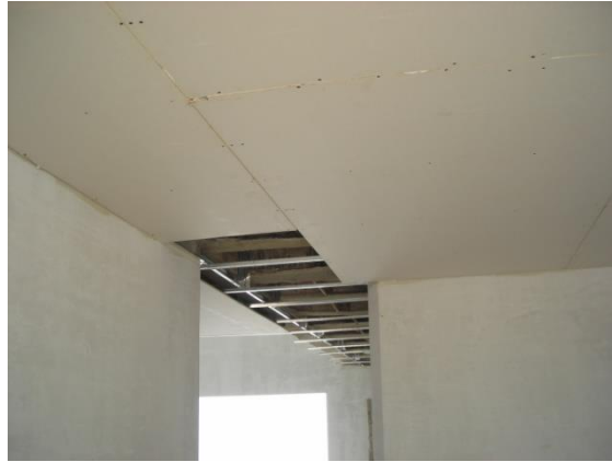
Figura 62. Colocación del panel yeso
