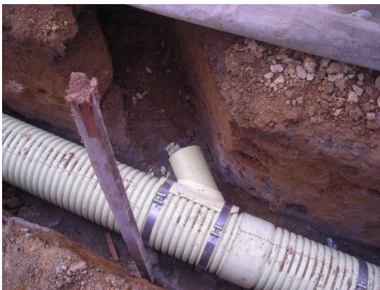
Figura 66. Accesorios para unir la tubería de la acometida domiciliaria con el conducto principal
