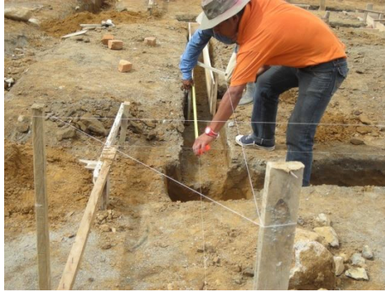
Figura 33. Colocación de formaletas
