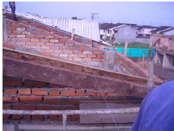
Figura 57. Colocación del hilo para garantizar la posición de las teleras
