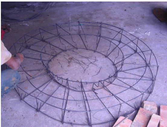
Figura 69. Figuración de acero para la construcción de tapas de cámaras de inspección
