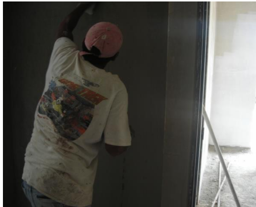
Figura 51. Disposición del estuco sobre el muro
