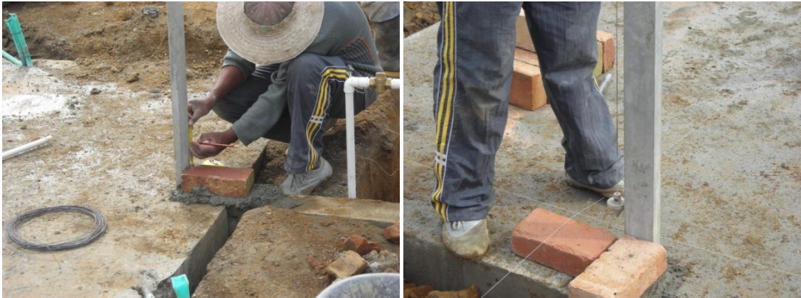
Figura 37. Colocación de la mira para levantar un muro de mampostería
