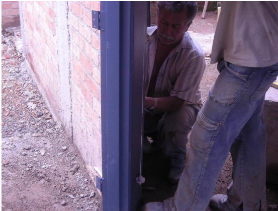
Figura 41. Toma de plomo en el marco de una puerta
