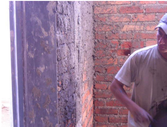
Figura 49. Champeo con mezcla de agua y cemento
