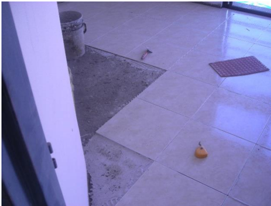
Figura 54. Colocación de un piso a un mismo nivel
