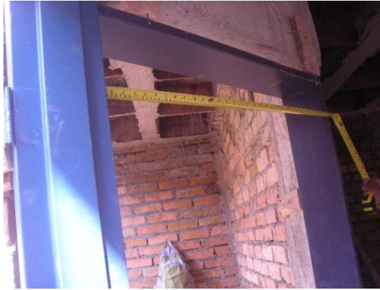
Figura 17. Flexómetro utilizado para medir el ancho del marco de una puerta
