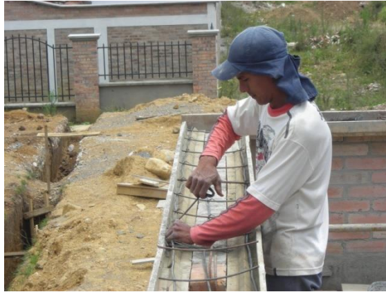
Figura 44. Colocación del acero para las alfajías
