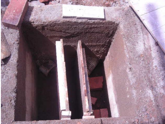
Figura 35. Construcción de una caja de inspección
