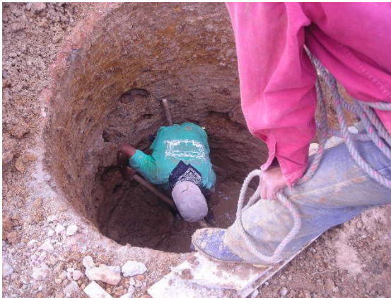
Figura 67. Excavación para la construcción de cámaras de inspección
