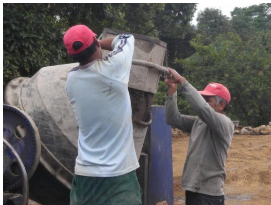
Figura 77. Mezclado mecánico con trompo
