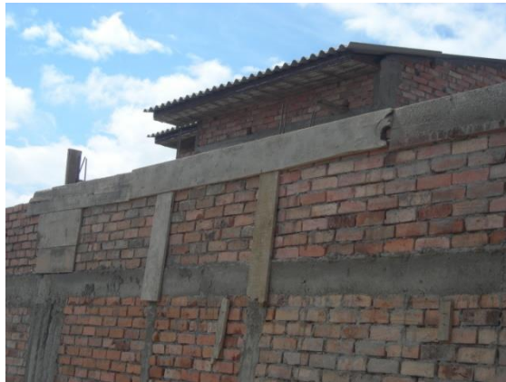
Figura 45. Colocación de formaletas para las vigas
