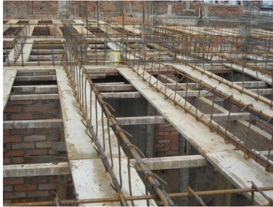
Figura 47. Colocación del acero de refuerzo
