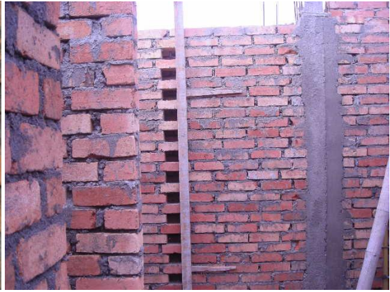
Figura 40. Trabas con ladrillo
