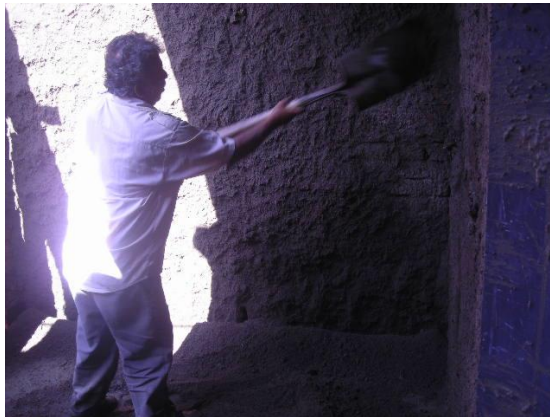
Figura 50. Disposición de la mezcla de mortero sobre el muro
