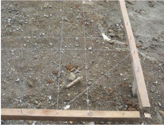
Figura 30. Puente para replanteo con hilos tendidos
