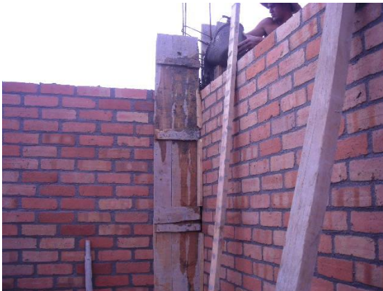
Figura 43. Fundición de una columna
