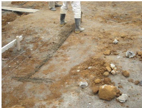
Figura 31. Excavación para la construcción de zapatas
