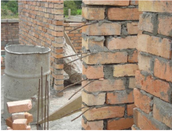
Figura 39. Varillas de acero para empalmes
