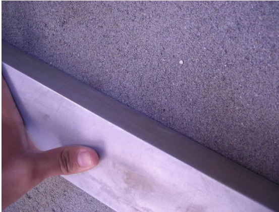
Figura 72. Verificación de uniformidad en el repello
