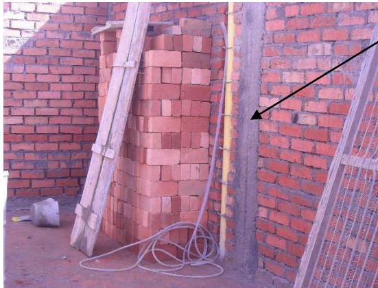
Figura 9. Nivel de manguera
