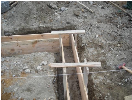
Figura 32. Colocación de formaletas
