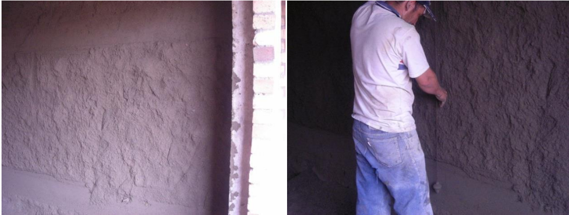
Figura 48. Verificación de la verticalidad con plomada
