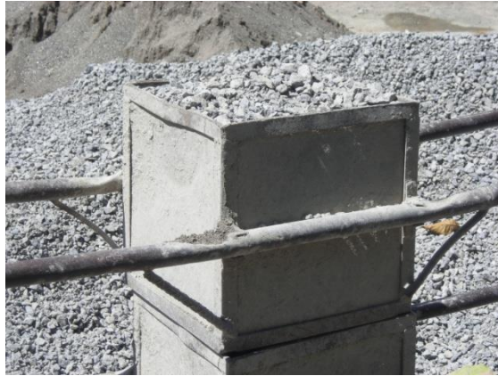
Figura 82. Enrase de los cajones que se utilizan para dosificar el concreto
