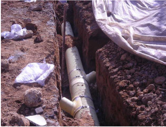
Figura 65. Colocación de la tubería del alcantarillado
