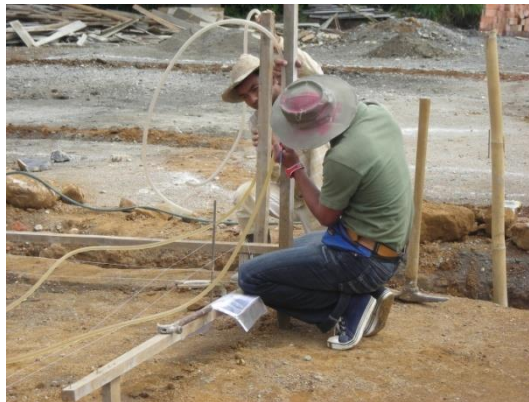
Figura 24. Nivelación con nivel de manguera
