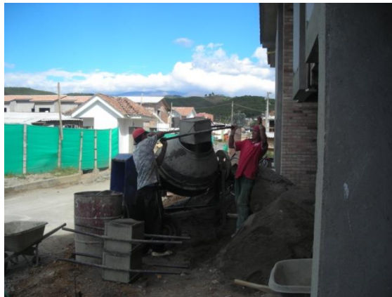
Figura 81. Dosificación en volumen de la mezcla de concreto
