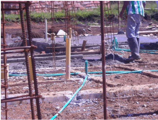
Figura 34. Fundición de piso primario
