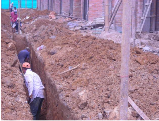
Figura 64. Excavación para la colocación de la tubería del alcantarillado
