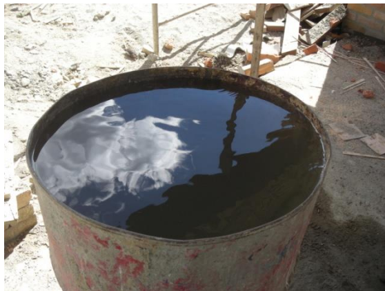
Figura 74. Agua utilizada en obra
