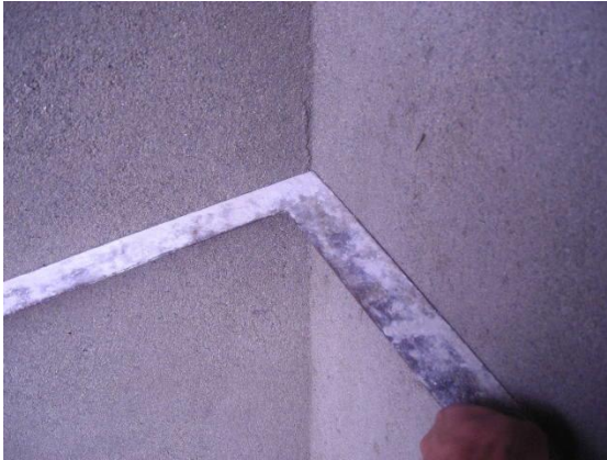
Figura 71. Verificación de escuadras en el repello
