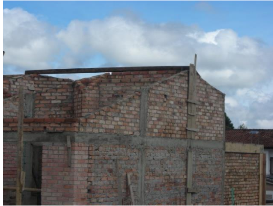
Figura 56. Ubicación de las teleras sobre las culatas
