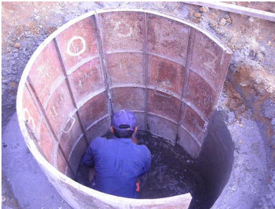
Figura 68. Formaleta metálica para las cámaras de inspección
