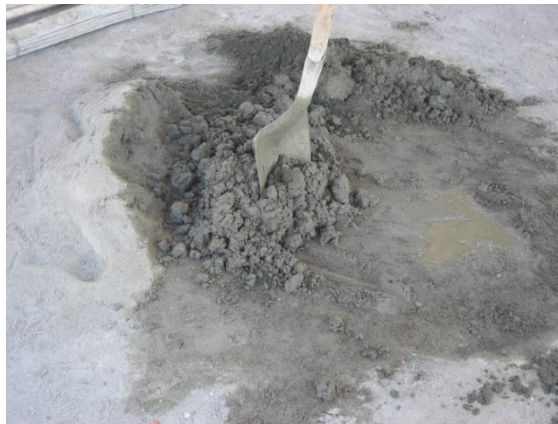
Figura 83. Mezcla de mortero utilizado en obra
