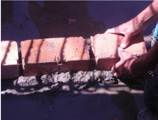
Figura 38. Colocación del ladrillo
