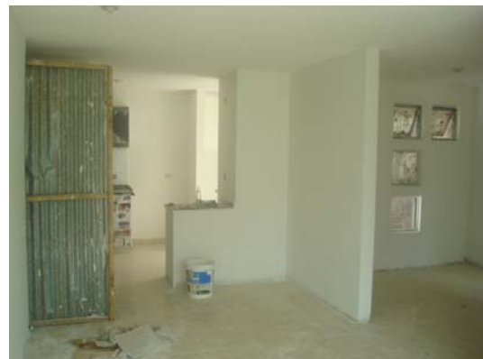
Primera mano de pintura
