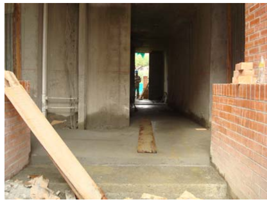
Afinado hall acceso Torre D
