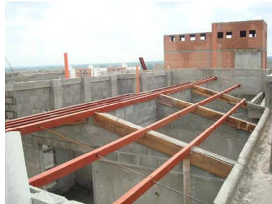
Instalación de perfiles de cubierta
