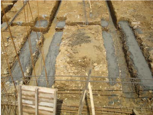
Concreto de limpieza
