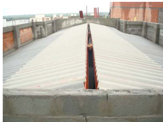
Instalación de teja
