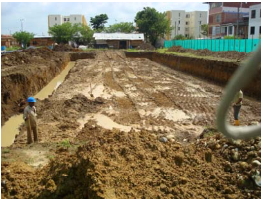
Excavación a máquina Torres A-B-C
