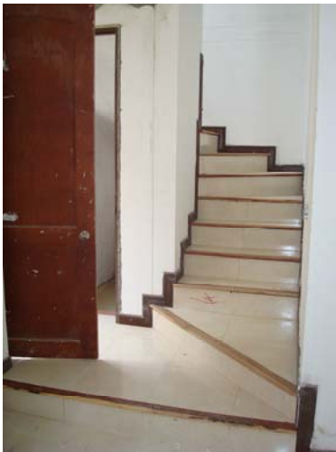
Escalera 1º a 2º nivel
