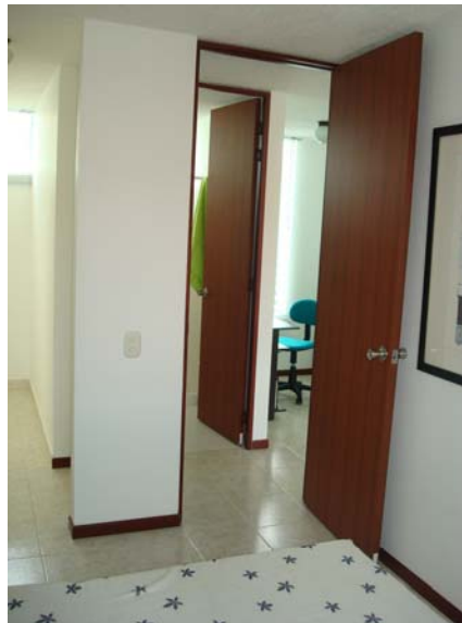
Habitación principal: se nota el punto hasta donde llega el guarda escobas en madera y el guarda escobas en cerámica.
