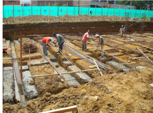
Amarre hierro vigas y zapatas
