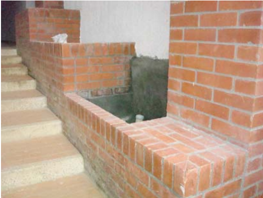
Repello interno y de protección de materas
