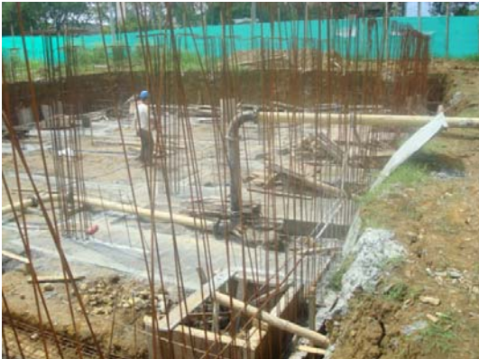
Fundida vigas y zapatas
