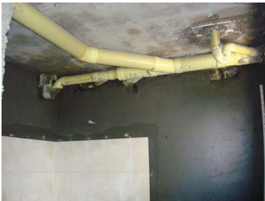
Repello y enchape de muros
