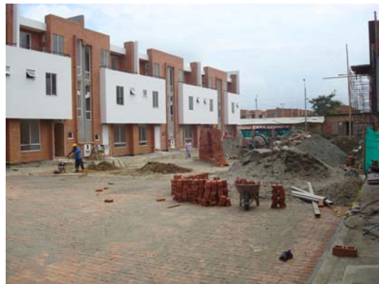
Compactación pavimento adoquinado
