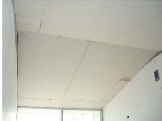
Cielo raso Torre E, dry wall en este caso.
