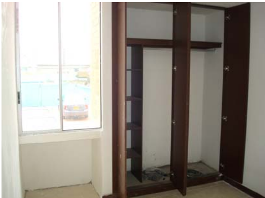
Instalación de closets
