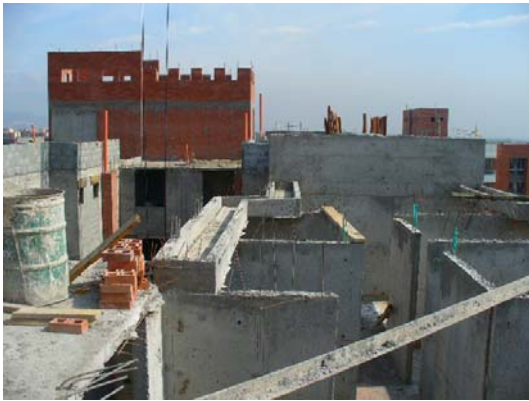
Cubierta Torre D y cuarto de maquinas.
