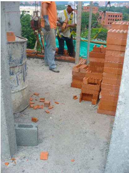
Subida de material (Ladrillo)
