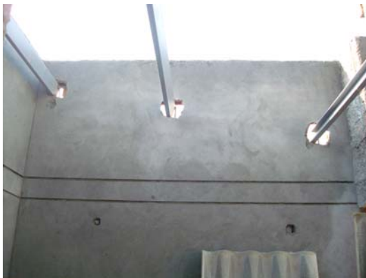
Colocación perlines de cubierta
