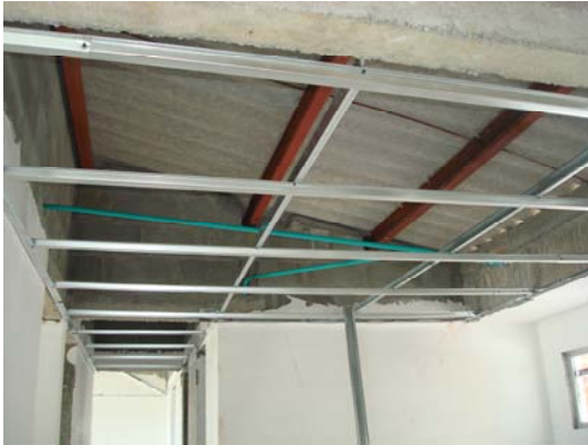
Cielo raso Torre E, se notan las instalaciones para la colocación del panel yeso o machimbre. Decisión del comprador.
