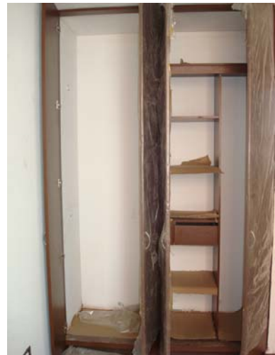
Instalación de closets
