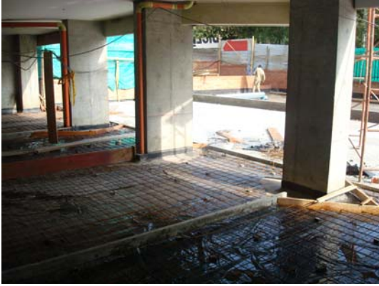
Parqueadero Losas de concreto rígido
