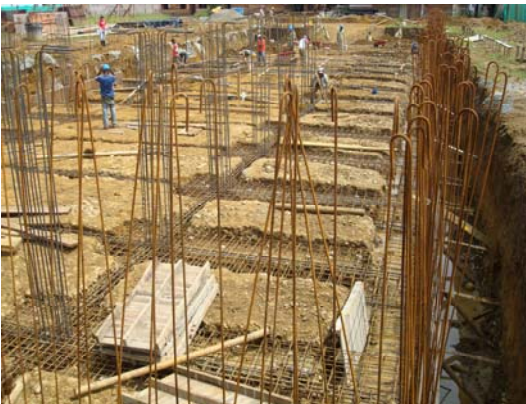
Amarre hierro columnas y muros de contención
