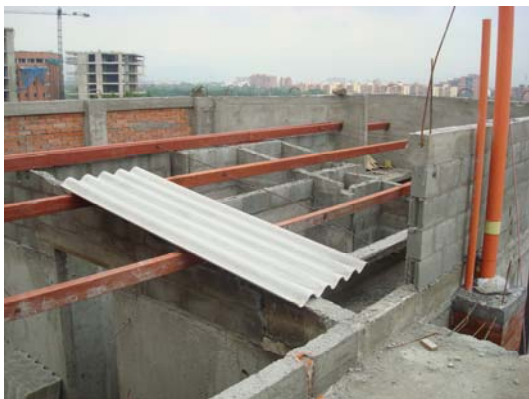
Instalación teja Torre D
