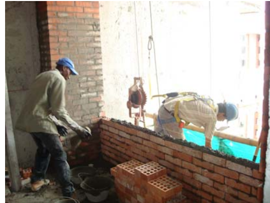
Mampostería de fachada
