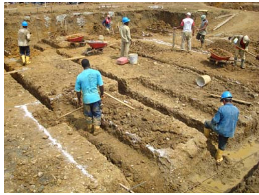
Excavación manual de vigas y zapatas
