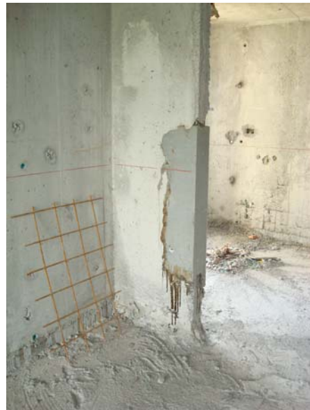
Resane al muro en outinord
