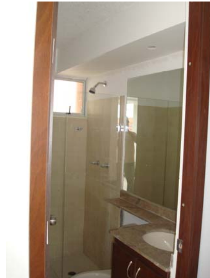
Instalación de mesón, divisiones y espejo
