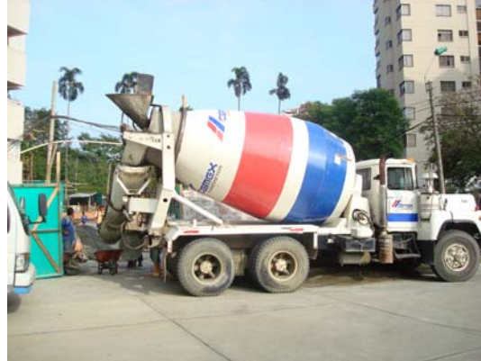
Fundición Losas de concreto
