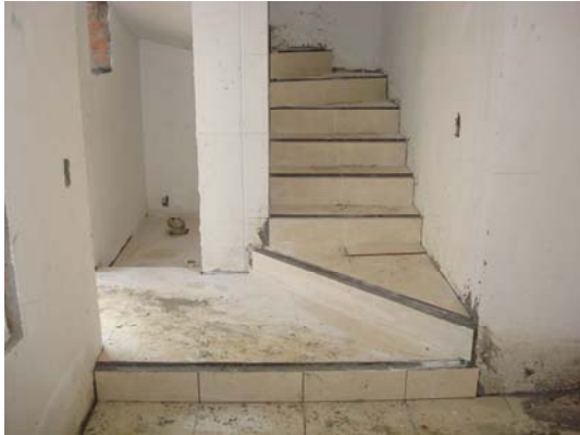
Escaleras 1er nivel
