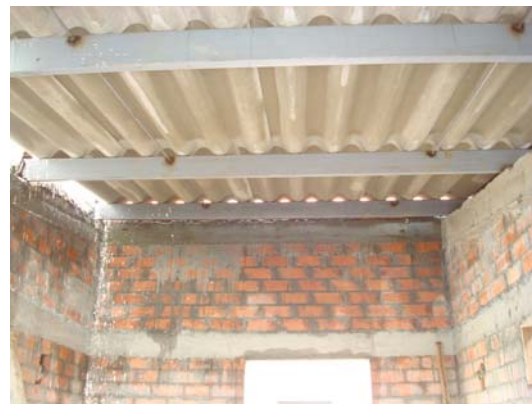
Montaje de tejas
