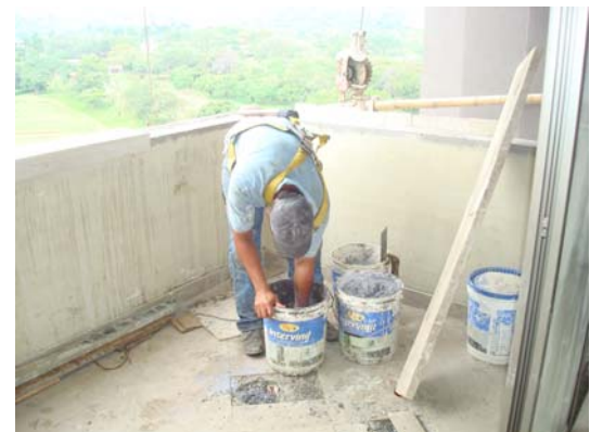
desinstalación Marmolina de fachadas
