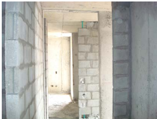
Mampostería bloque de cemento
