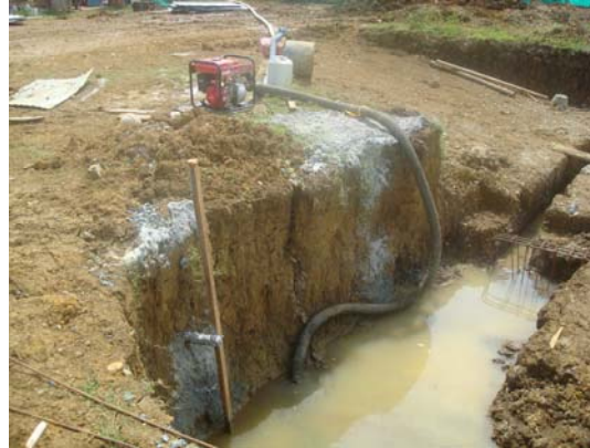
Bombeo de agua para fundición
