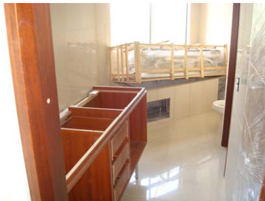
Instalación carpintería baños
