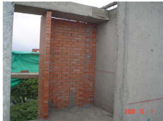
Mampostería de Fachada
