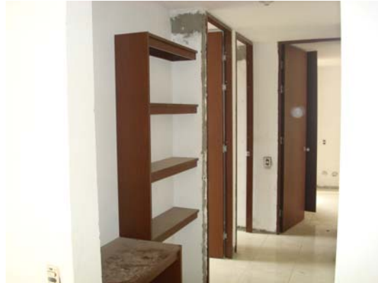
Instalación puertas en madera
