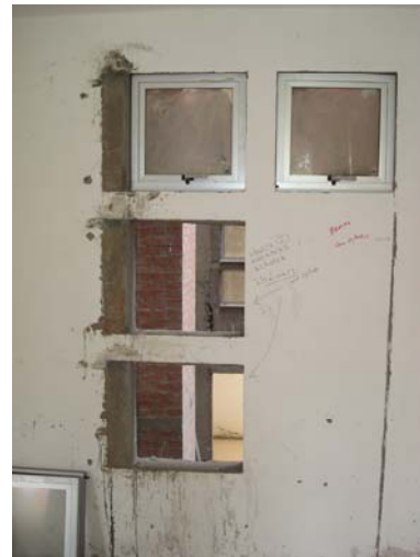
Arreglo de vanos para ventanas
