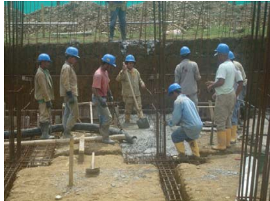
Fundida vigas y zapatas
