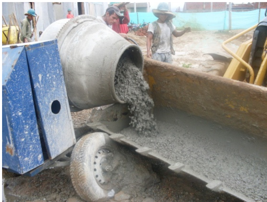
Foto 15. Preparación de mezcla en obra con trompo.
