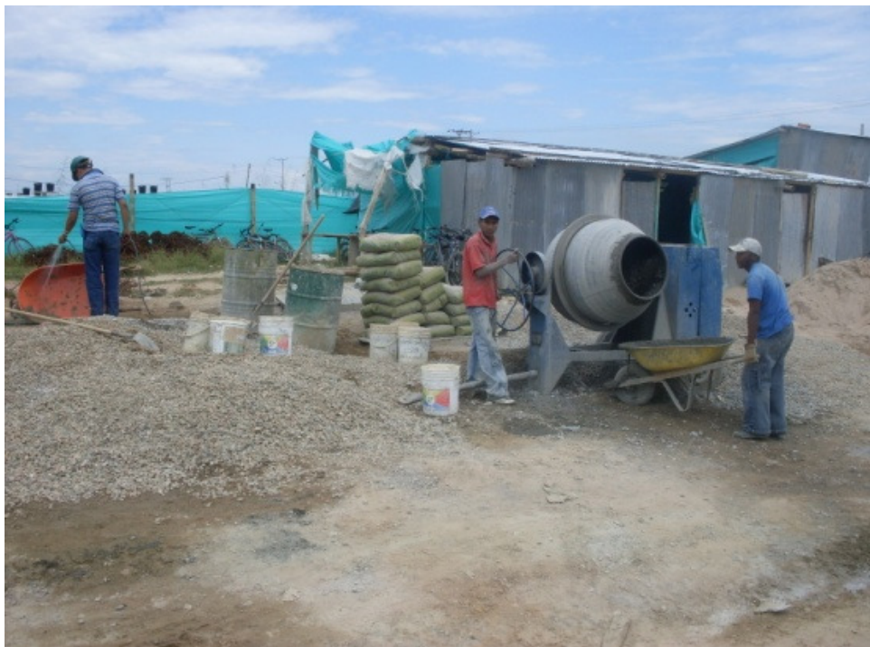
Foto 6. Sitio para la disposición del trompo y material para la mezcla del concreto.
