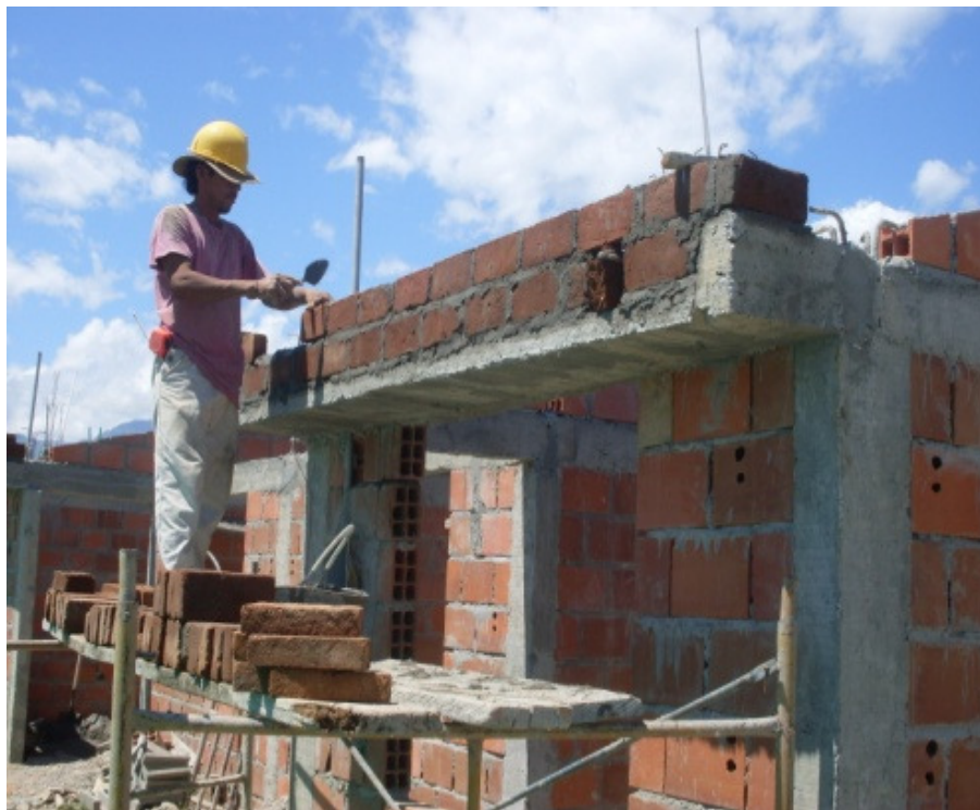
Foto 49. Construcción de un muro de sobreelevación.
