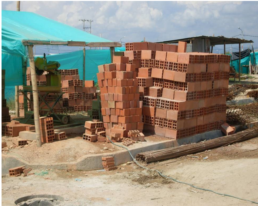
Foto 3. Ladrillos apilados junto a la cortadora
