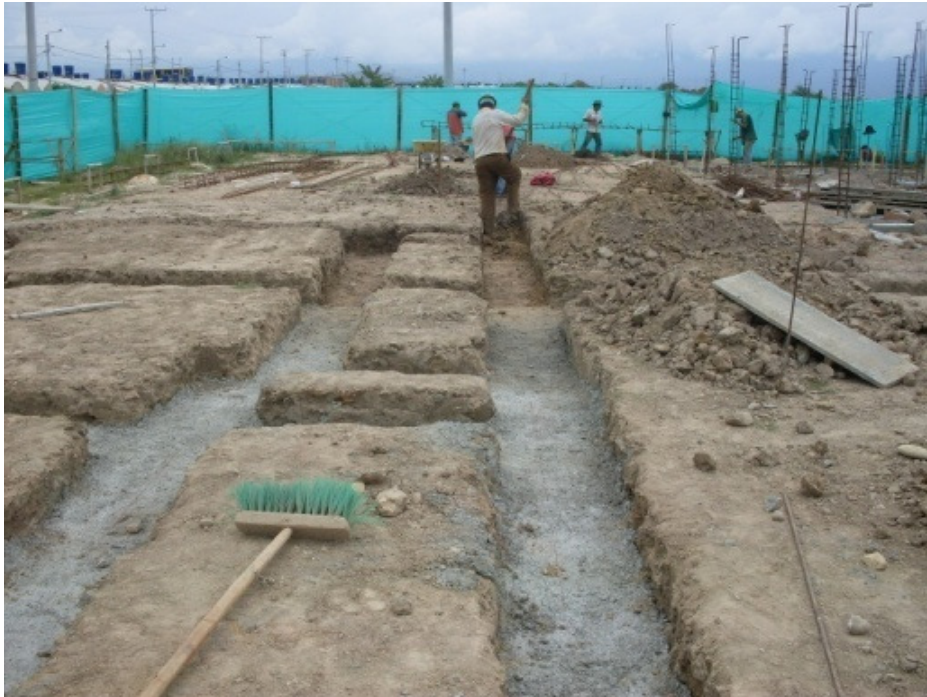
Foto 19. Concreto de limpieza fraguado.
