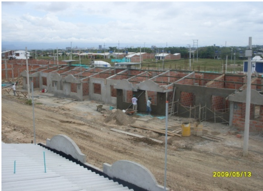
Foto 61. Vista general, vigas cinta fundidas en Manzana 3.
