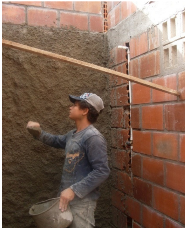
Foto 63. Pañete impermeabilizado de duchas
