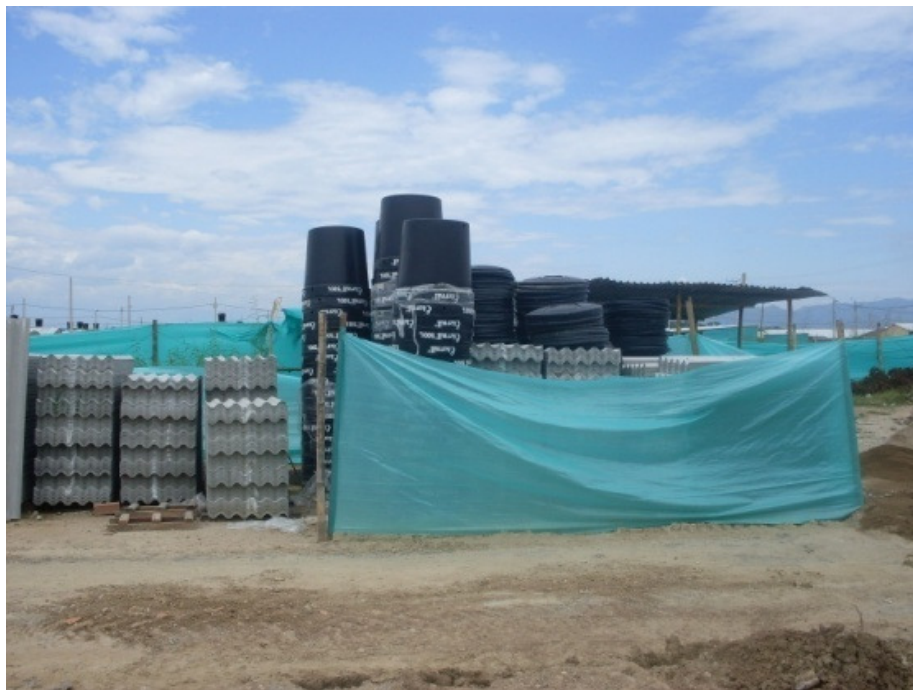
Foto 5. Cerramiento para almacenamiento de tejas y tanques.
