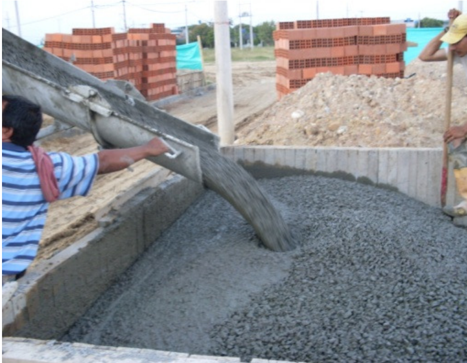
Foto 11. Concreto tipo bombeo depositado en los cajones para vaciado
