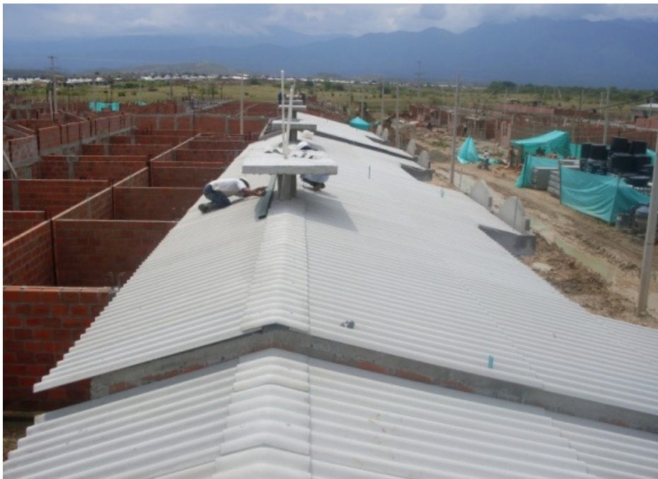
Foto 74. Vista general de cubiertas en Manzana 6.
