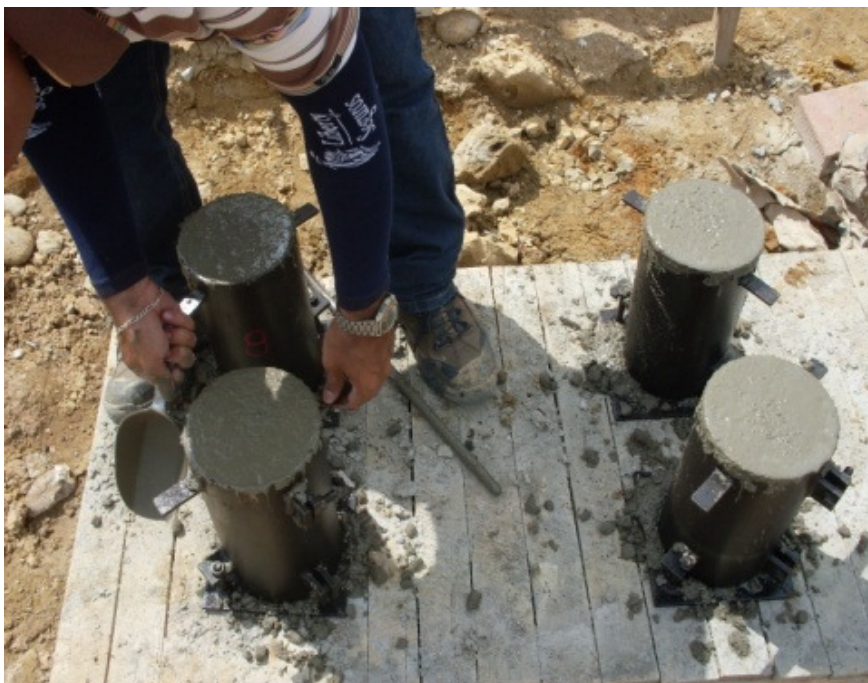
Foto 14. Cilindros de concreto.
