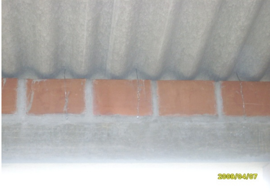
Foto 73. Fijación de la cubierta a la fachada por medio de amarres
