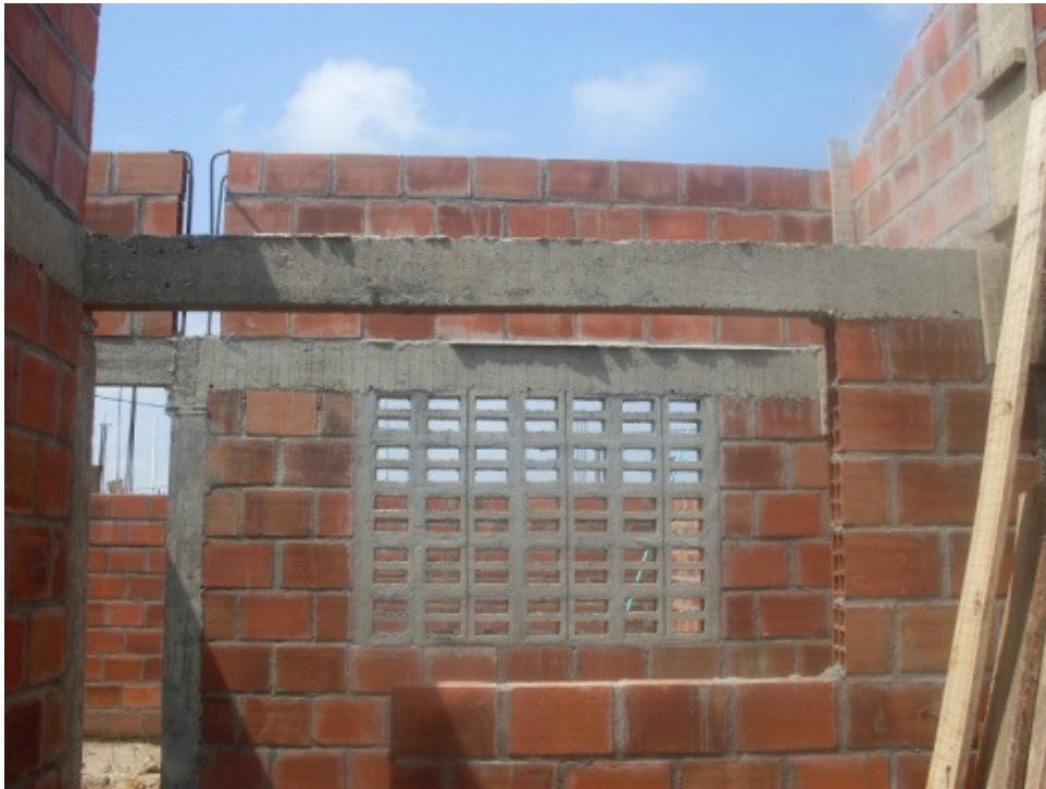
Foto 52. Muros en calado, para ventana de cocina
