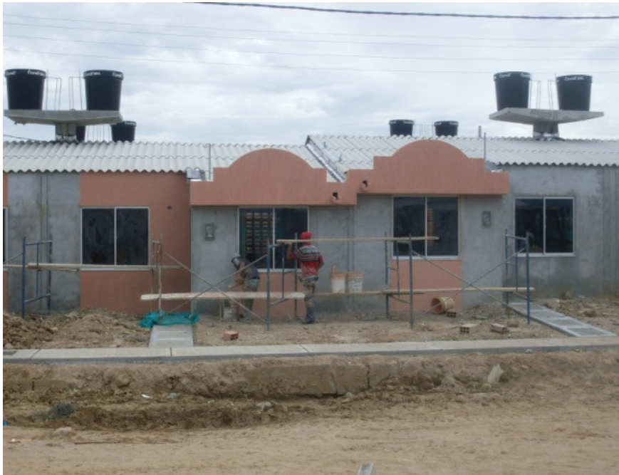
Foto 104. Aplicación de graniplast en fachadas
