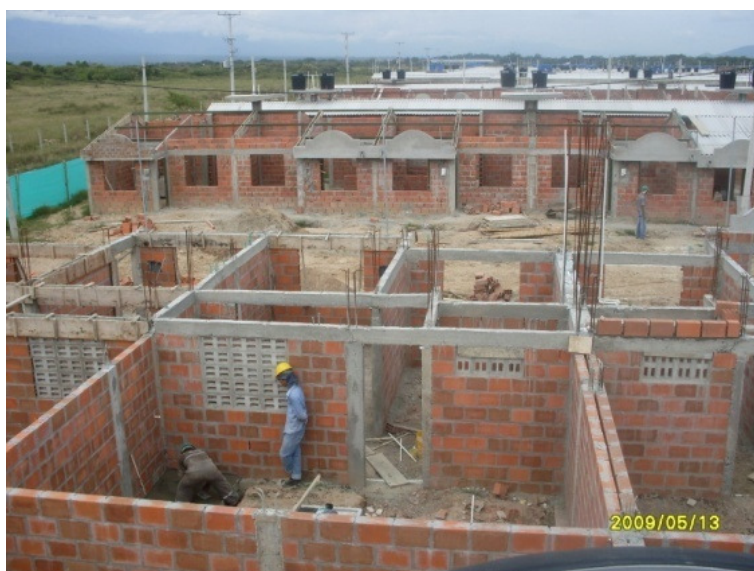
Foto 43. Vista superior, vigas de amarre
