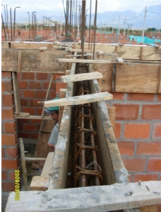
Foto 41. Acero de refuerzo de las vigas de amarre
