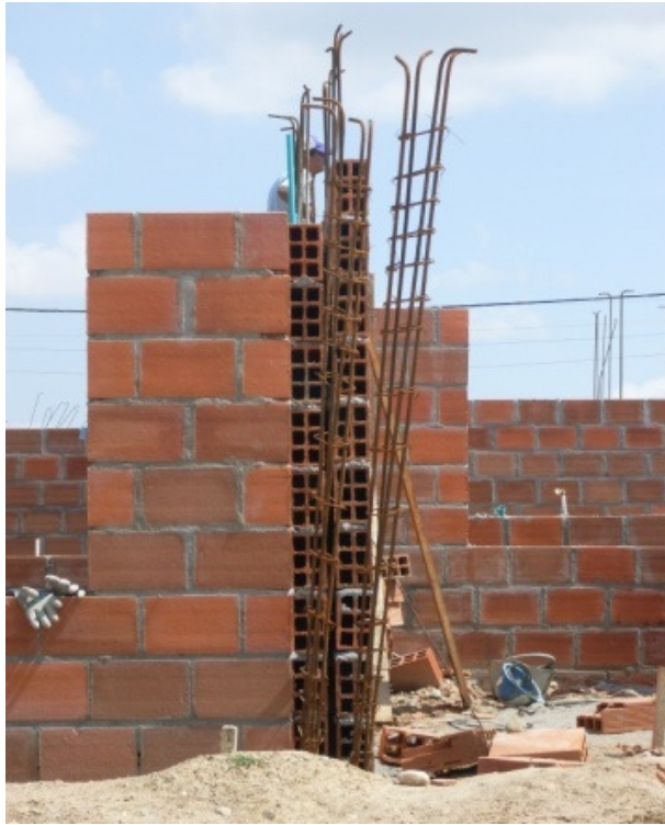
Foto 28. Muros dobles dilatados.
