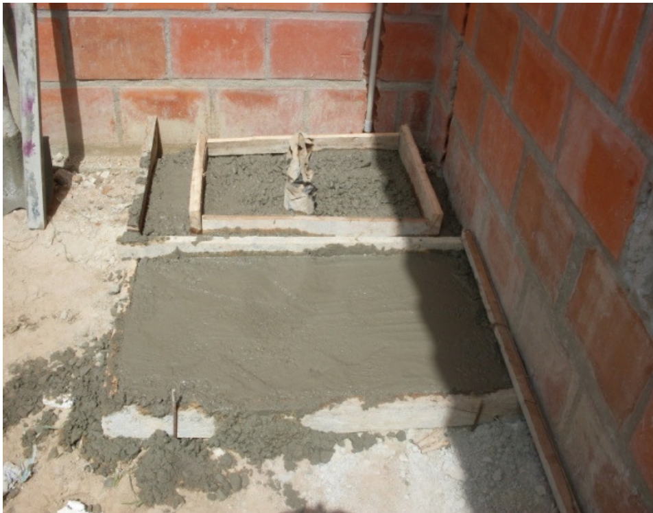
Foto 89. Fundición de placa para lavadero
