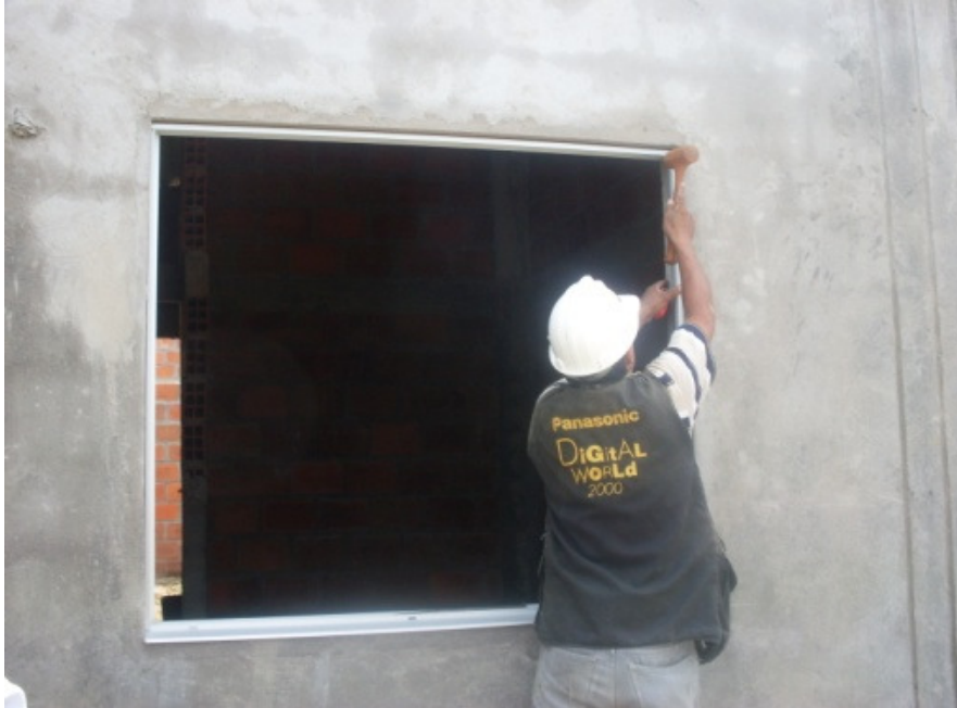
Foto 91. Instalación de ventanas
