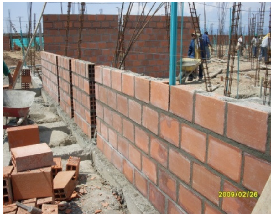
Foto 26. Eje longitudinal de las casas. Espesores de mortero uniformes.
