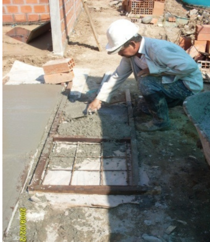
Foto 34. Fundición de tapas reforzadas para las cajas de inspección.
