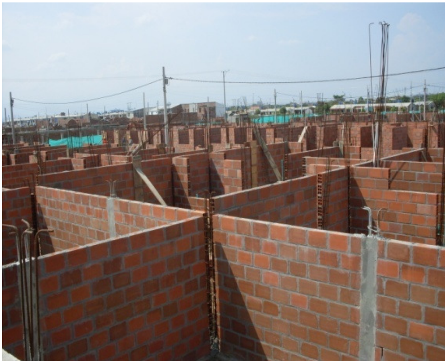
Foto 31. Vista superior de las viviendas a nivel de mampostería y columnas de confinamiento
