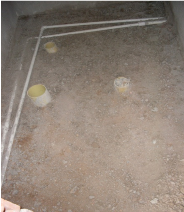
Foto 86. Red presión interna, área de baño
