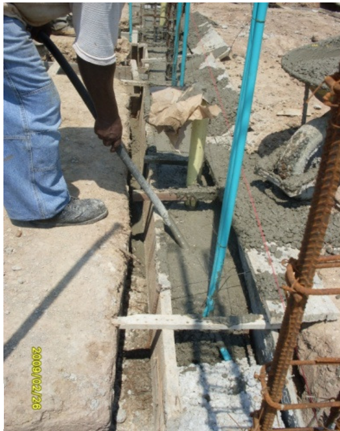
Foto 21. Fundición de vigas de cimentación. Vibrado
