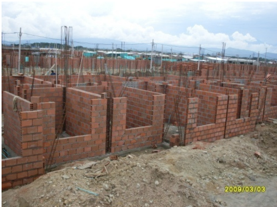
Foto 29. Vista general de la Manzana 5 con construcción a nivel de mampostería.
