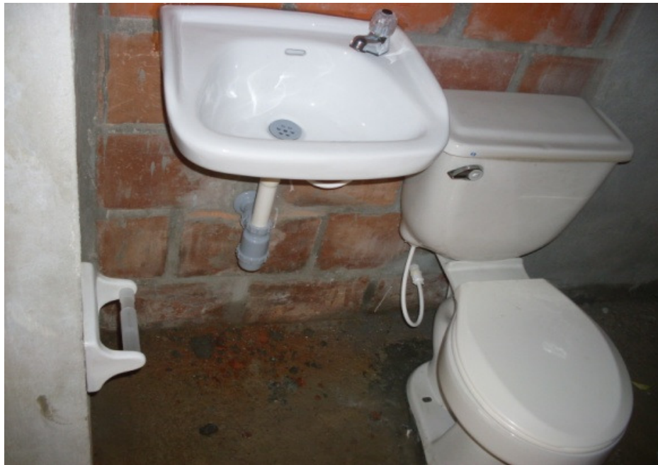
Foto 118. Lavamanos y sanitario instalados
