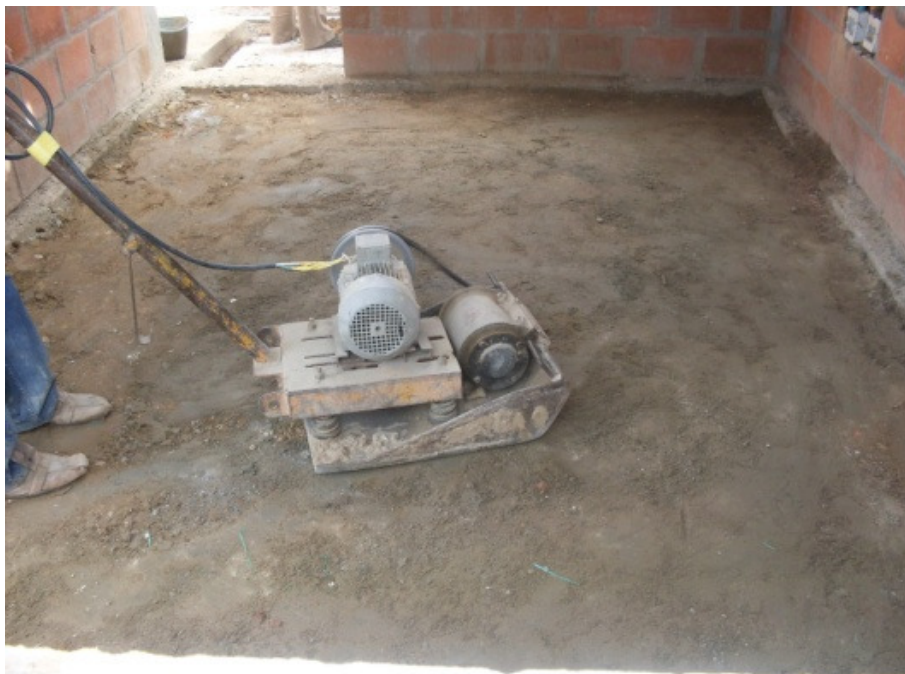
Foto 96. Afiración del terreno con rana vibradora
