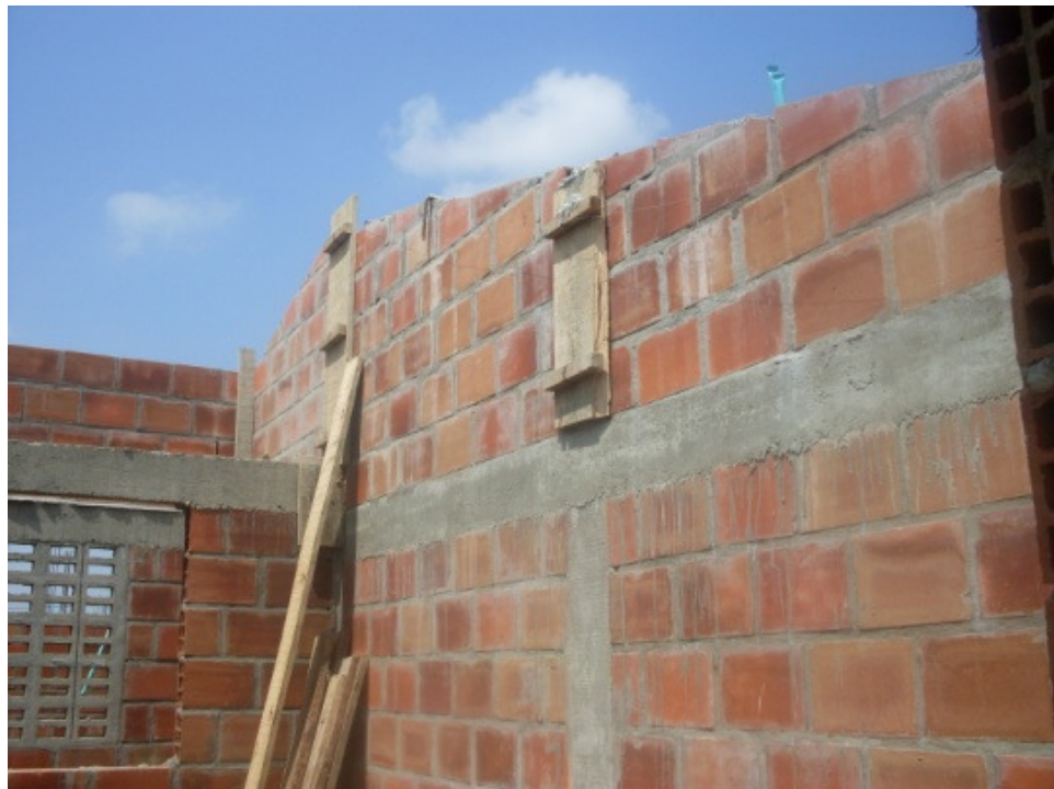
Foto 58. Formaletas de las columnetas
