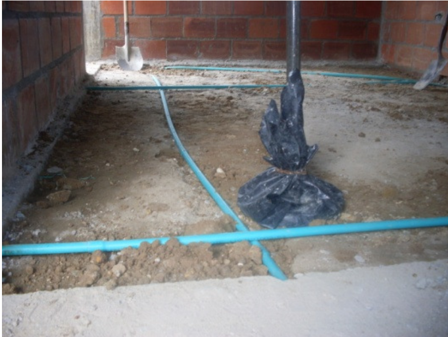
Foto 95. Paso de Tubería Conduit y apisonado del terreno
