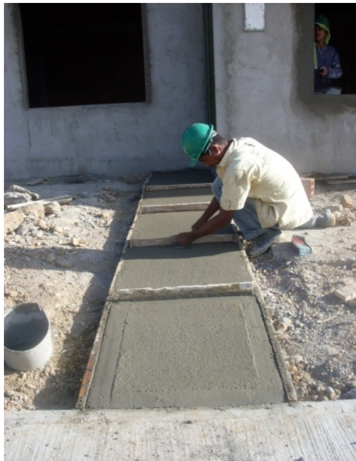
Foto 102. Fundición de huellas
