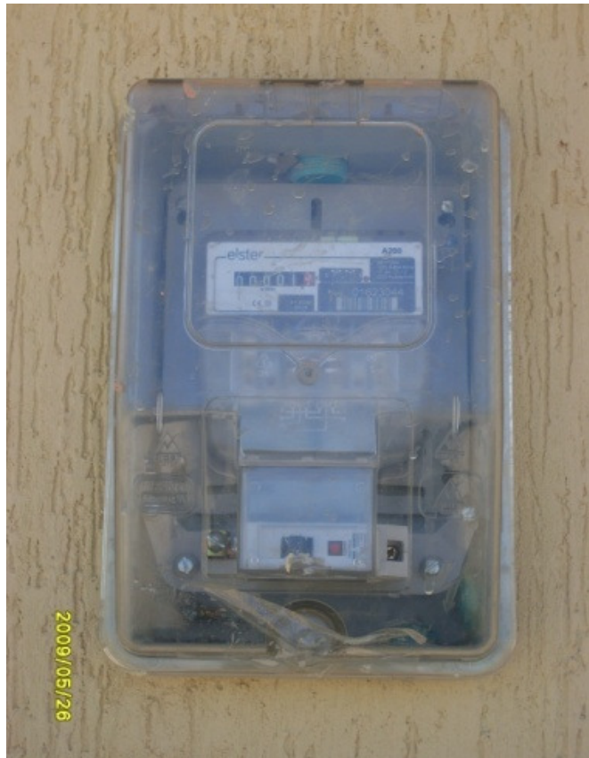
Foto 117. Contador eléctrico
