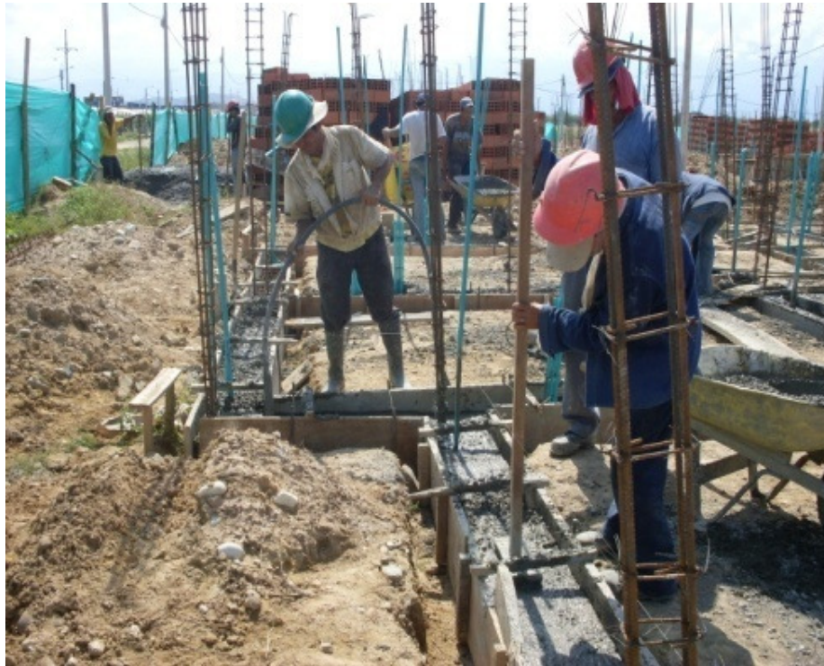
Foto 22. Fundición de vigas de cimentación; vibrado y paso de niveles
