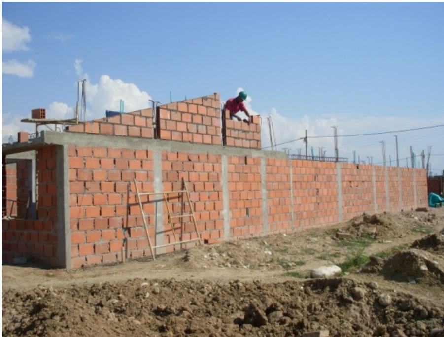
Foto 56. Construcción de cuchillas sobre las culatas
