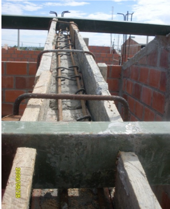
Foto 62. Refuerzo de la viga cinta
