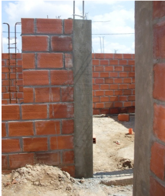
Foto 38. Columnas desencofradas
