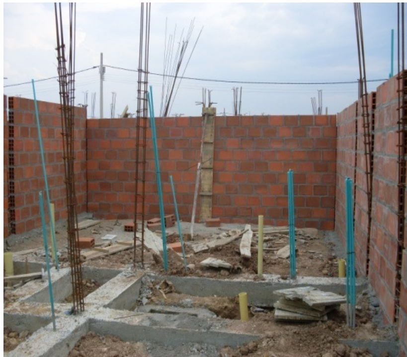
Foto 30. Muro con desplome de 1,5cm corregido con la ayuda del gato hidráulico.
