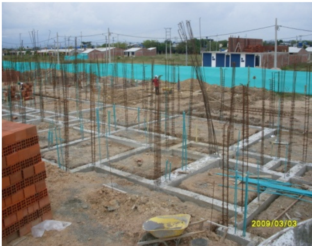
Foto 24. Retiro de formaletas y vigas de cimentación endurecidas.
