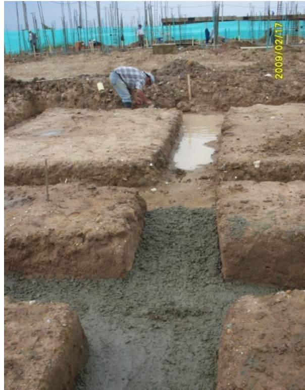
Foto 17. Vaciado del concreto de limpieza
