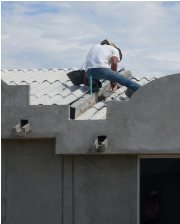
Foto 78. Impermeabilización en cambios de nivel
