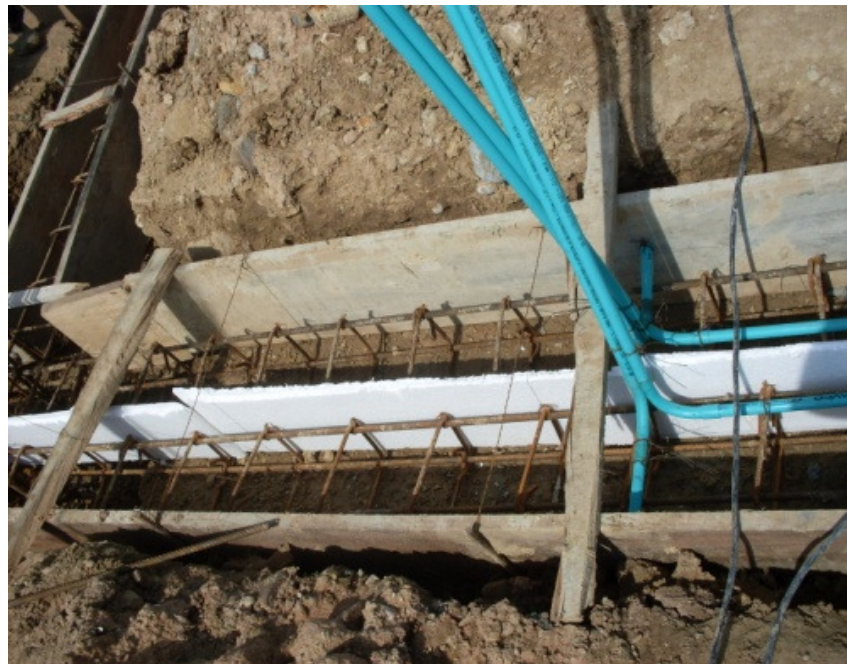
Foto 20. Utilización de Icopor para la dilatación de vigas en muros dobles
