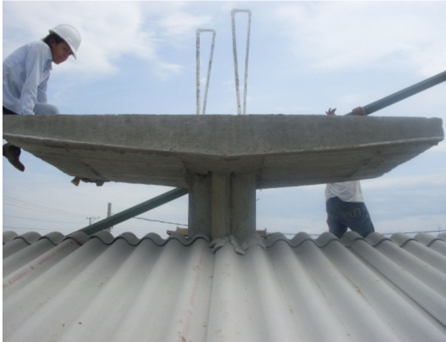
Foto 83. Detalle de columna, Placa Tanque fundida.
