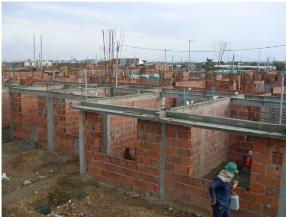
Foto 47. Vigas canales fundidas monolíticamente con las vigas de amarre
