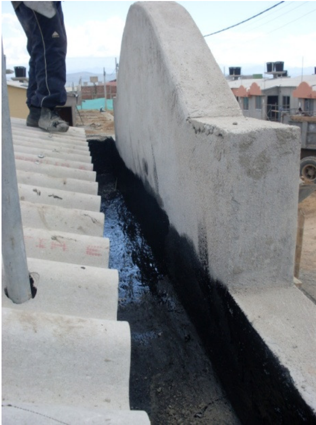
Foto 48. Viga canal terminada con capa de Igol Denso
