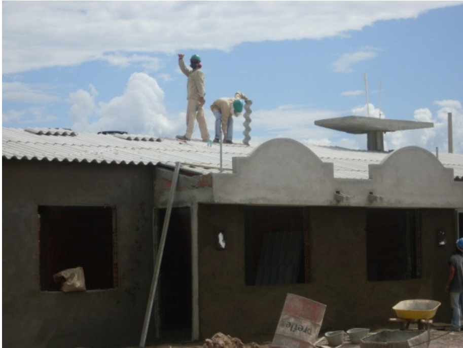
Foto 70. Instalación de cubiertas
