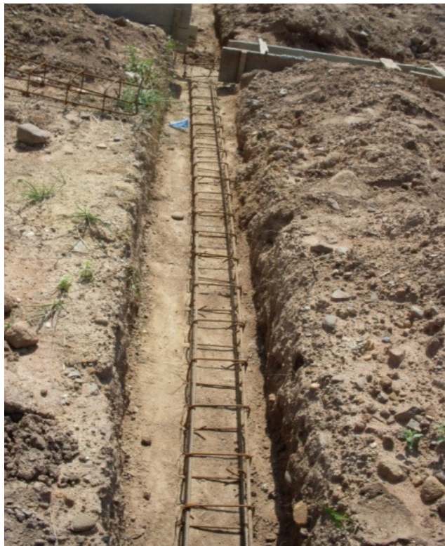
Foto 16. Brechas para la colocación del concreto de
