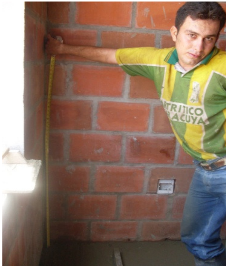
Foto 97. Revisión de niveles para placa de contrapiso
