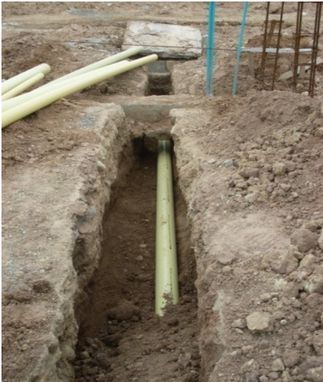
Foto 36. Excavación para lanzar tuberías sanitarias.
