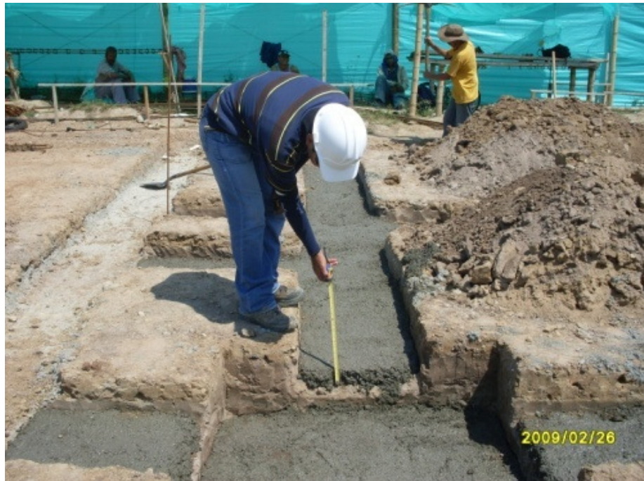
Foto 18. Solado de vigas y zapata. Control del espesor requerido
