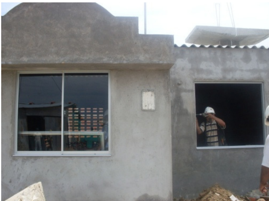
Foto 92. Ventanas instaladas en la fachada
