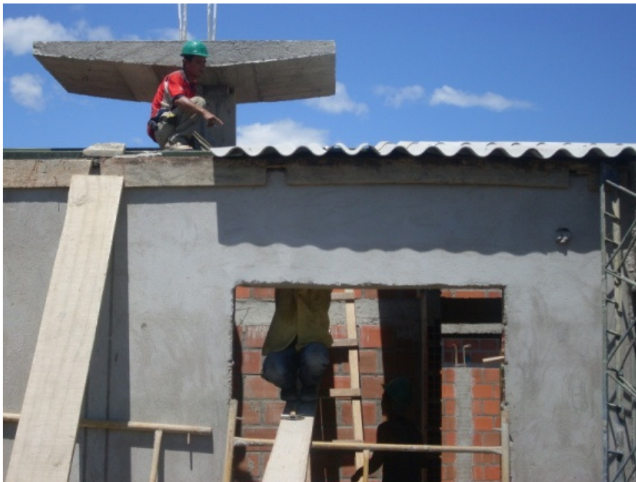
Foto 71. Instalación de cubiertas
