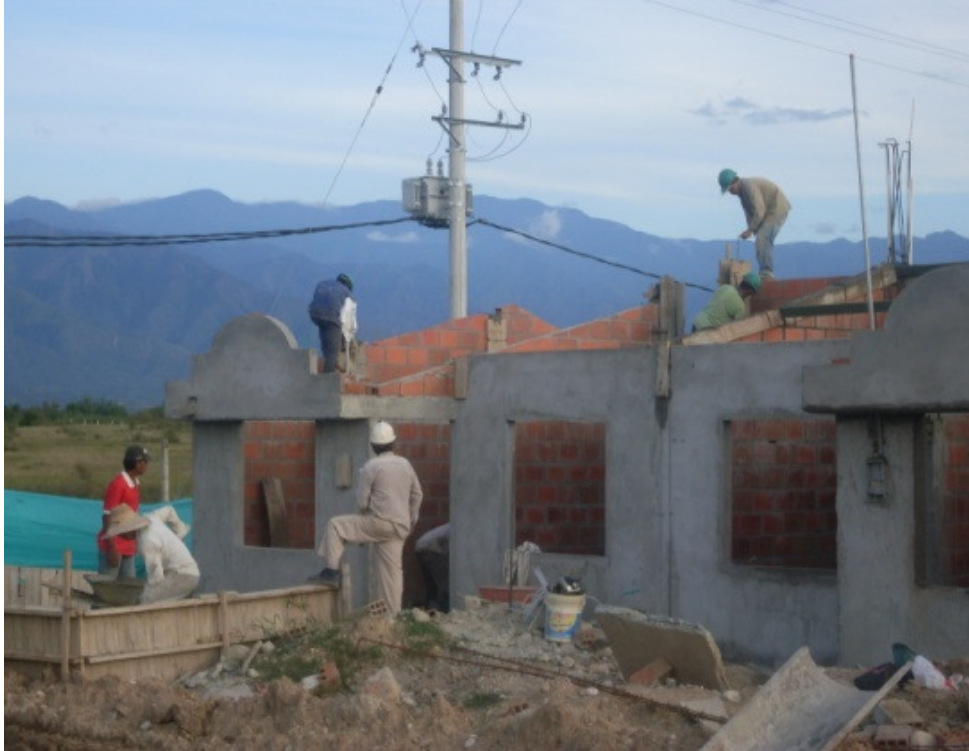
Foto 59. Fundición de columnetas
