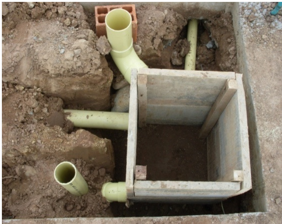
Foto 32. Formaleta para Caja de Inspección de 40 x 40 cm. Ubicada en el baño
