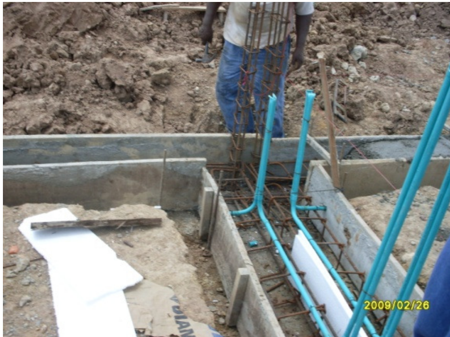
Foto 112. Tubería Conduit embebida en las vigas de cimentación
