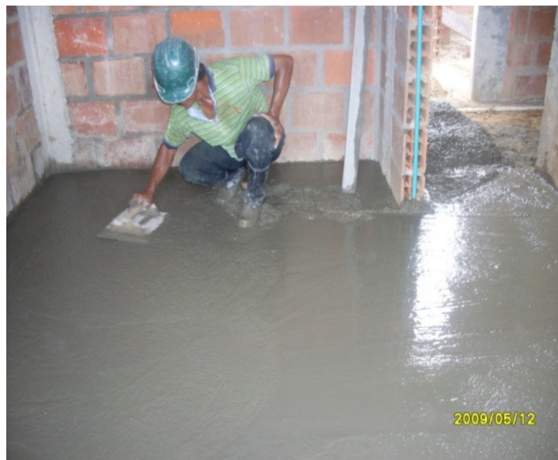
Foto 99. Acabado rústico de las placas con llana
