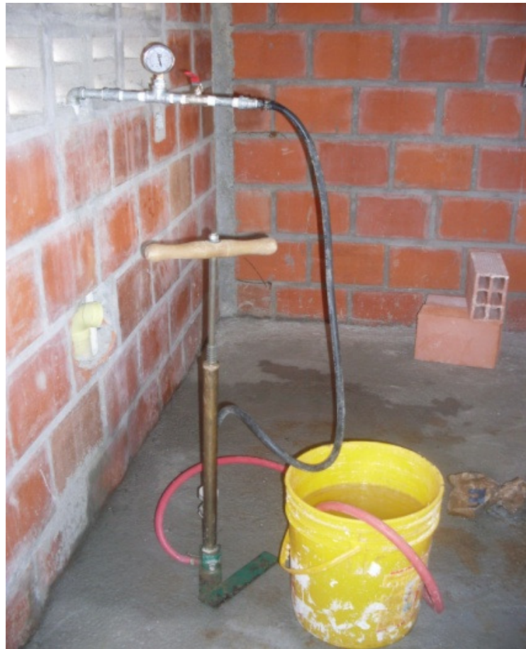
Foto 88. Prueba hidráulica de presión
