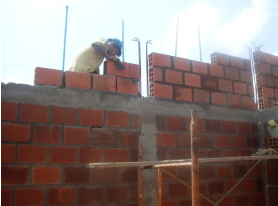
Foto 54. Levante de muros de cuchillas
