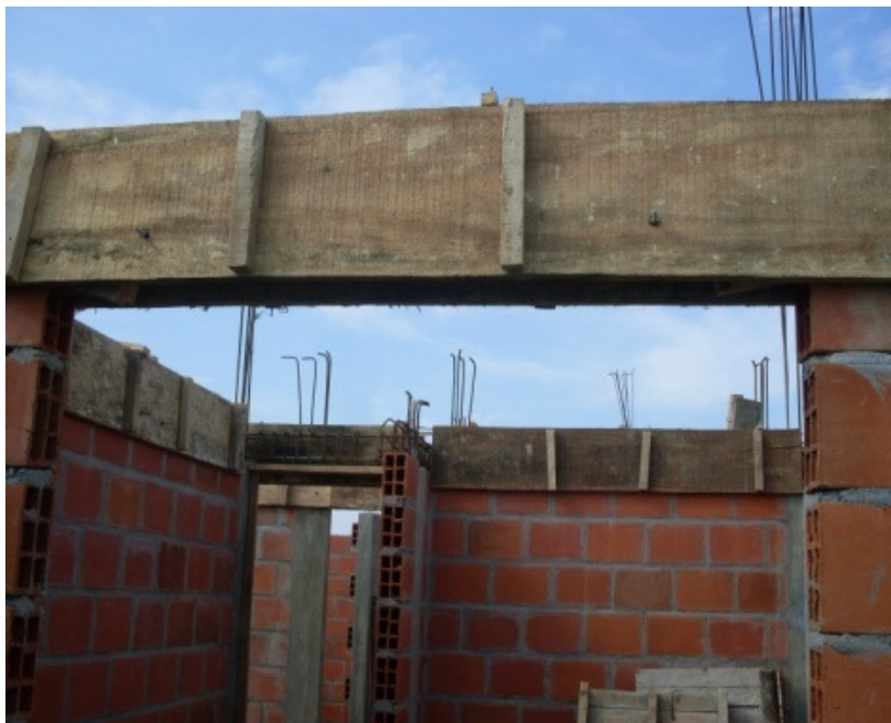
Foto 42. Vigas de amarre formateadas, previo a la fundición
