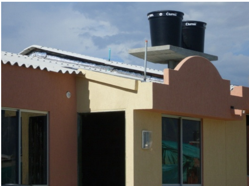
Foto 79. Manto Edil instalado y terminado en los cambios de nivel
