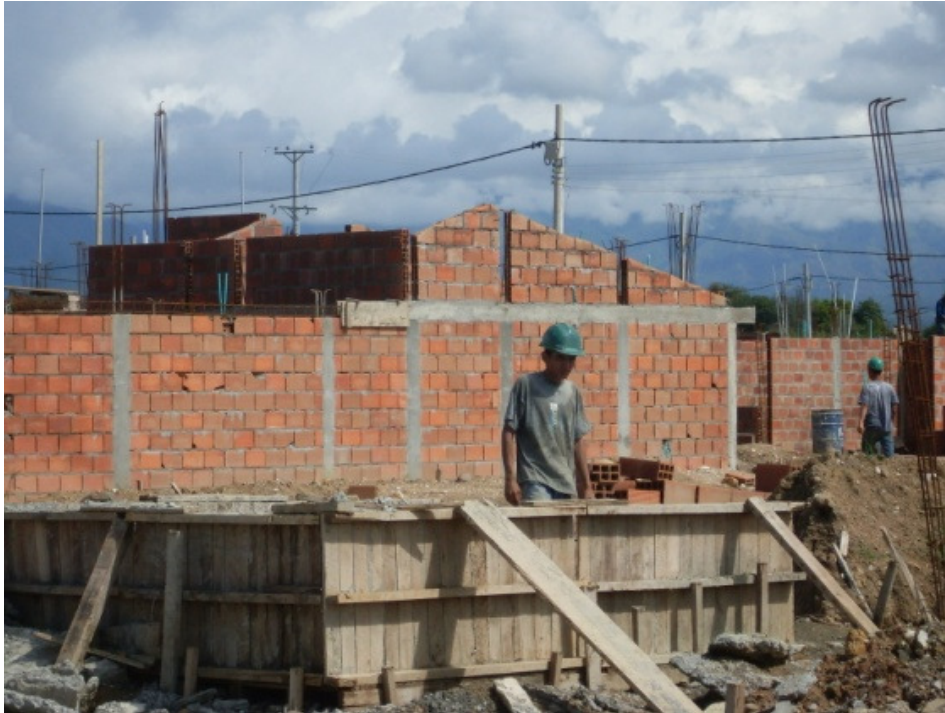
Foto 57. Cuchillas laterales y posteriores de las viviendas
