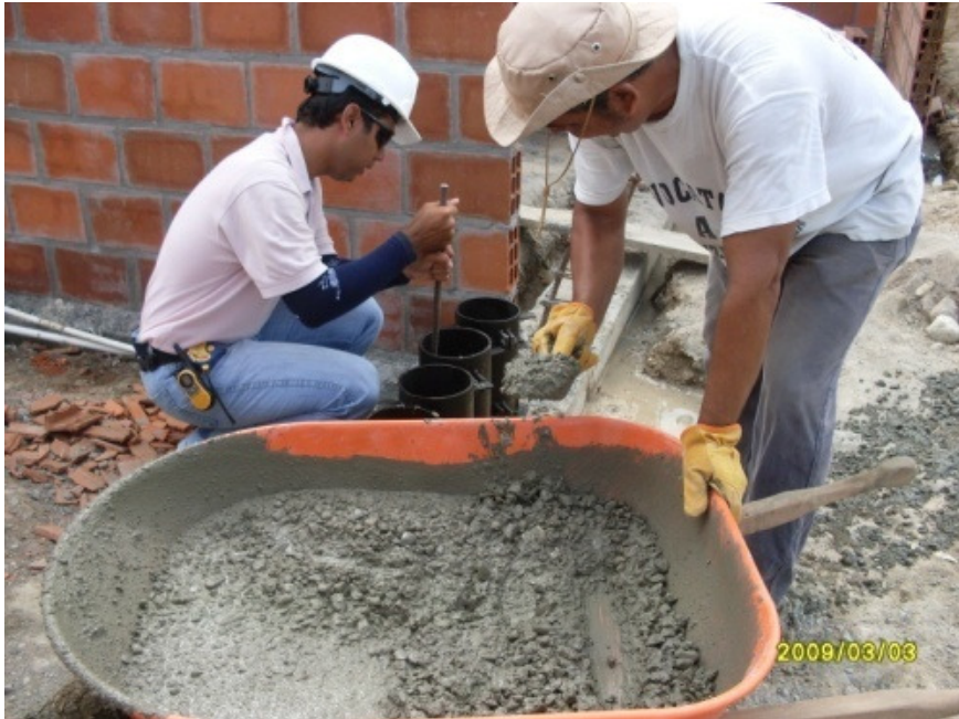
Foto 13. Preparación de cilindros de concreto.
