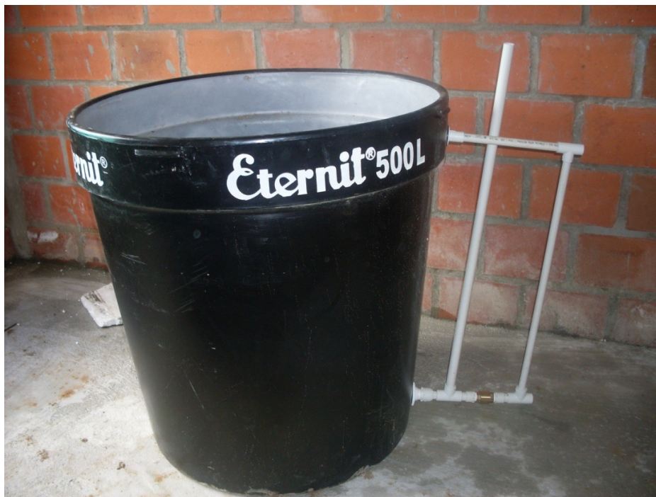
Foto 85. Detalle del By-Pass, Válvula Cheque y tubería de desfogue
