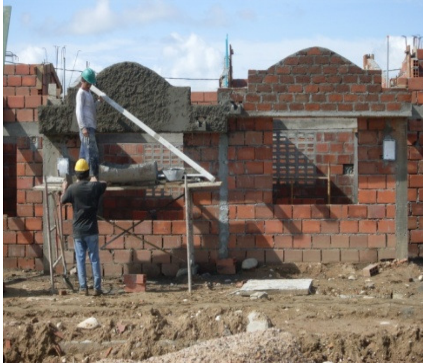
Foto 51. Pañete para los muros de sobreelevación.
