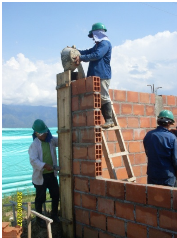
Foto 37. Fundición de columnas
