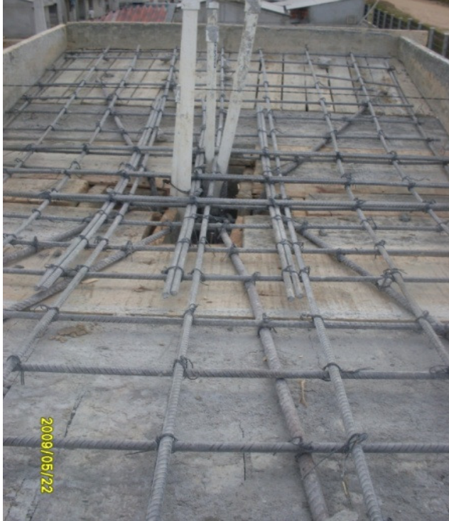
Foto 80. Refuerzo de la Placa Tanque
