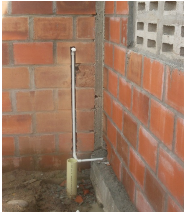
Foto 86. Red presión interna, área de baño
