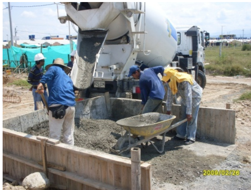
Foto 10. Mixer descargando el concreto en los cajones de madera
