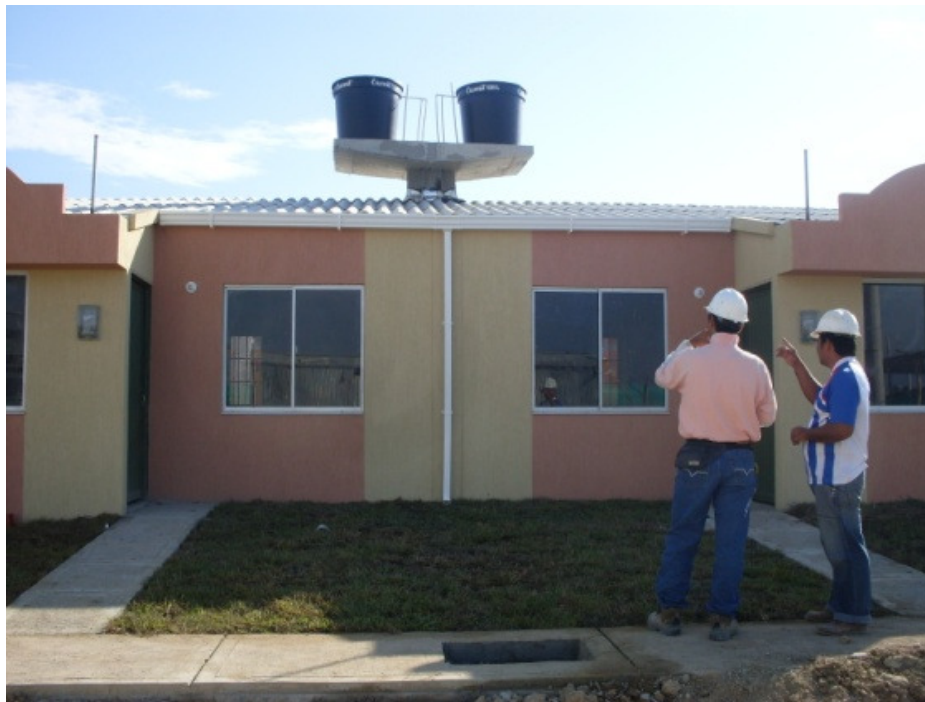
Foto 109. Terminado de las fachadas
