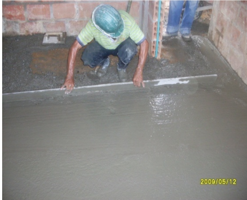
Foto 98. Fundición de placas de contrapiso
