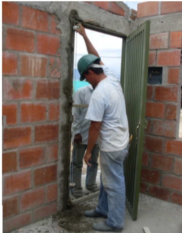
Foto 93. Instalación de puerta principal
