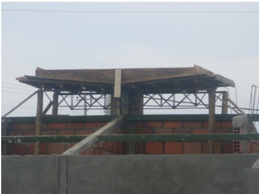
Foto 81. Formaleta para Placa Tanque
