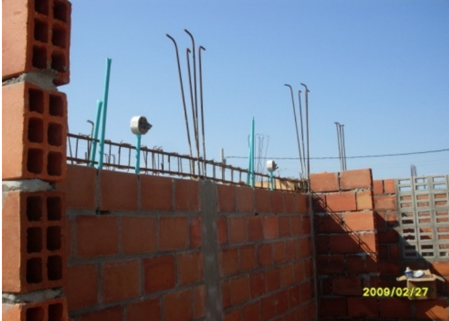
Foto 115. Instalaciones eléctricas a nivel de vigas de amarre
