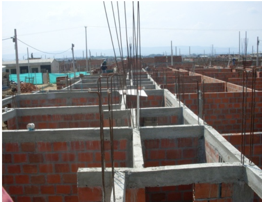
Foto 44. Vista general, vigas de amarre
