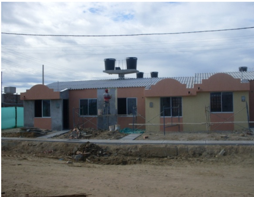
Foto 105. Aplicación de graniplast
