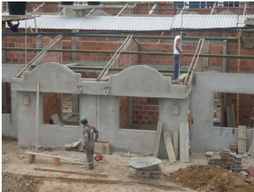
Foto 60. Formaletas para viga cinta
