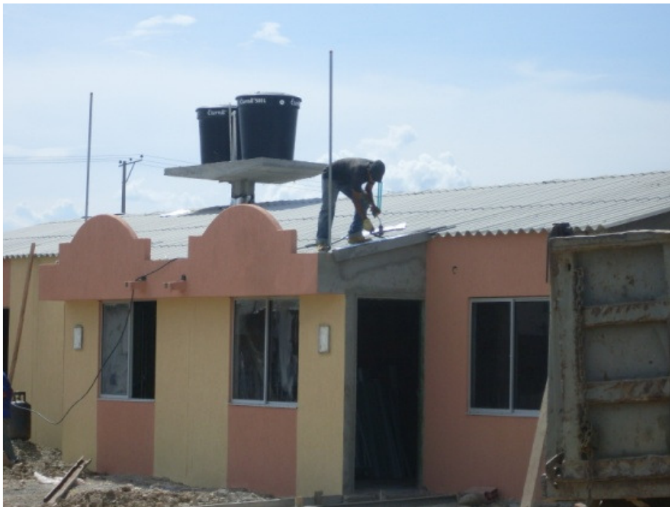
Foto 76. Construcción e impermeabilización de pisatechos
