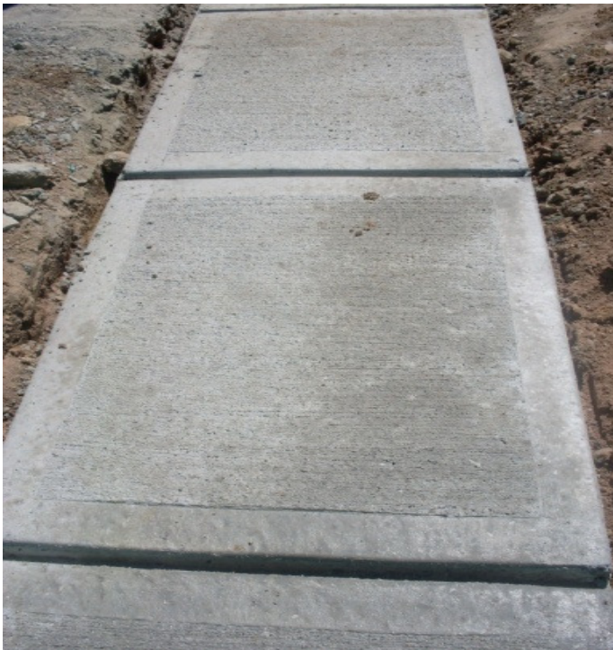
Foto 104. Huellas desencofradas
