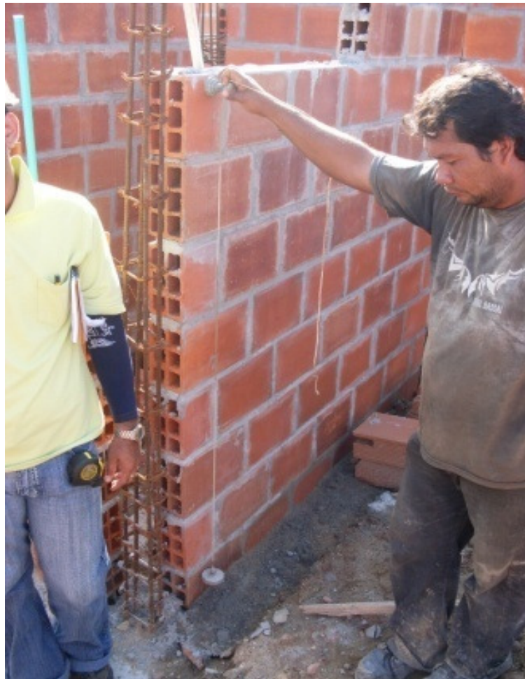
Foto 27. Verificación de plomada en la mampostería.
