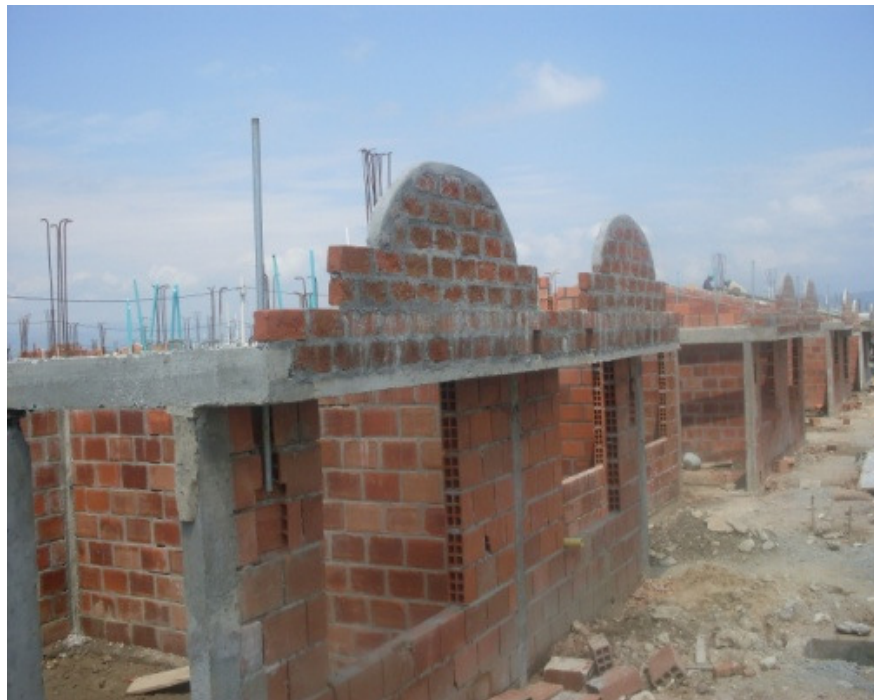
Foto 50. Geometría de los muros de sobreelevación.
