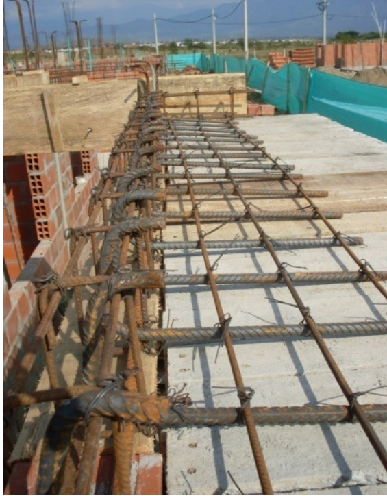
Foto 45. Acero de refuerzo de la viga canal.
