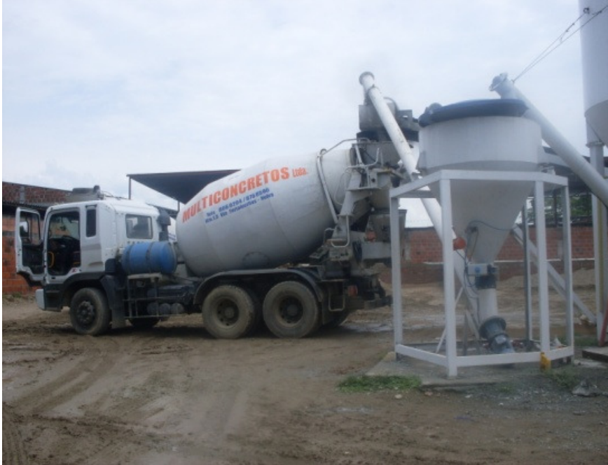
Foto 9. Mixer cargando concreto en la planta.
