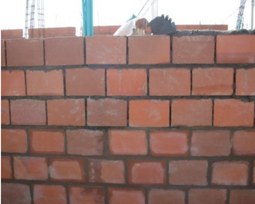
Foto 25. Muros en ladrillo hueco No.5, en perfecta traba
