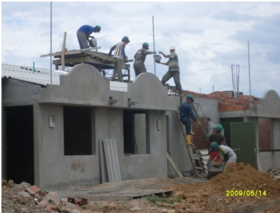
Foto 82. Fundición de Placa Tanque
