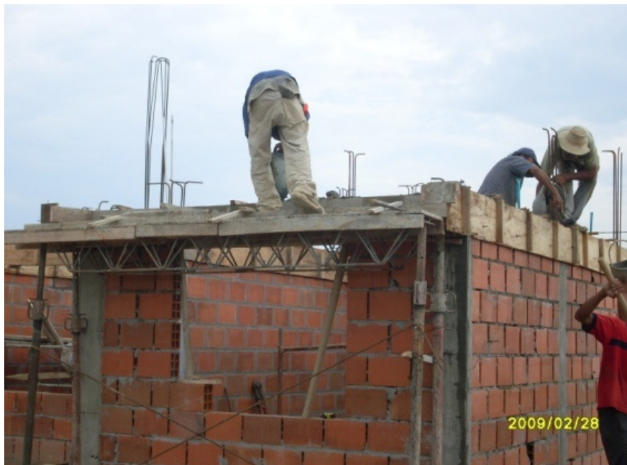
Foto 46. Formaleta para viga canal; fundición de la misma
