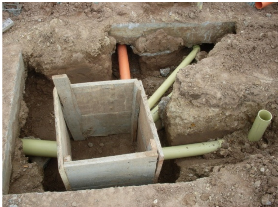
Foto 33. Formaleta para Caja de Inspección de 50 x50 cm. Ubicada en la cocina
