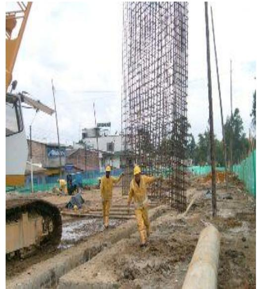
**FOTO No 49 y No 50.** Detalle del traslado de la armadura a su excavación.
