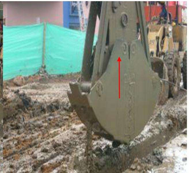
**FOTOS No 15 y No 16.** Salida de la almeja con el material excavado.
