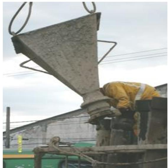
**FOTOS No 57 y No 58.** Se observa como el ayudante conduce el embudo para ensamblarlo en la primera sección de la tubería.
