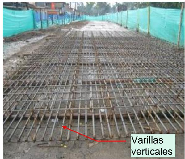
**FOTOS No 82 y No 83.** Detalle de la ubicación de las varillas horizontales y verticales exteriores.
