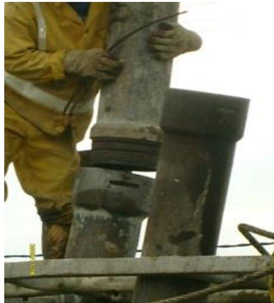
**FOTOS No 61 y No 62.** Se observa como el ayudante sujeta la tubería y la adecua en la sección correspondiente.
