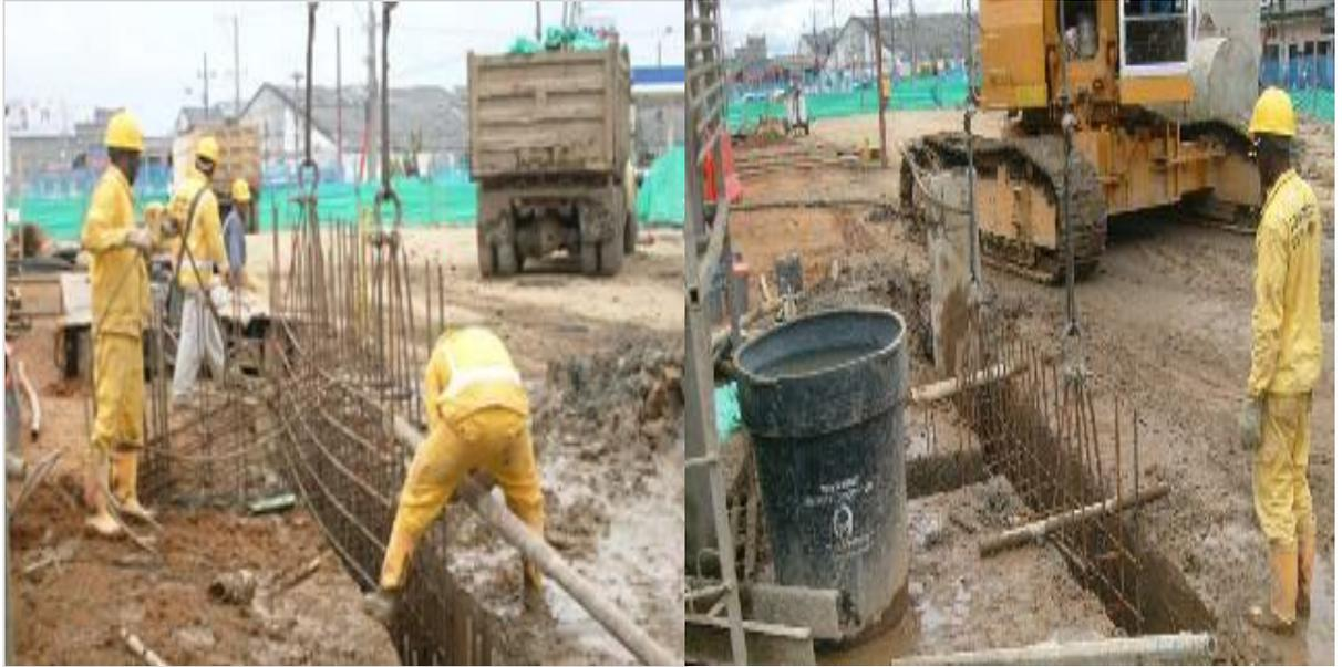
**FOTO No 55 y No 56.** Finalmente se retiran los elementos de izaje y se deja la armadura lista para el vaciado del concreto junto con los dispositivos de fijación.
