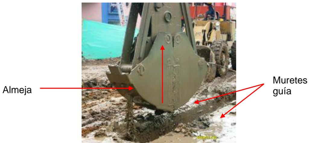
**Figura 6. Detalle de la excavación de un módulo.**
