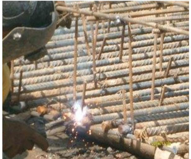
**FOTOS No 90 y No 91.** Detalle de la soldadura de algunos ganchos. Esta soldadura permite rigidizar la parrilla, lo cual es necesario al momento de realizar las maniobras de izaje e instalación de la armadura dentro de la excavación
