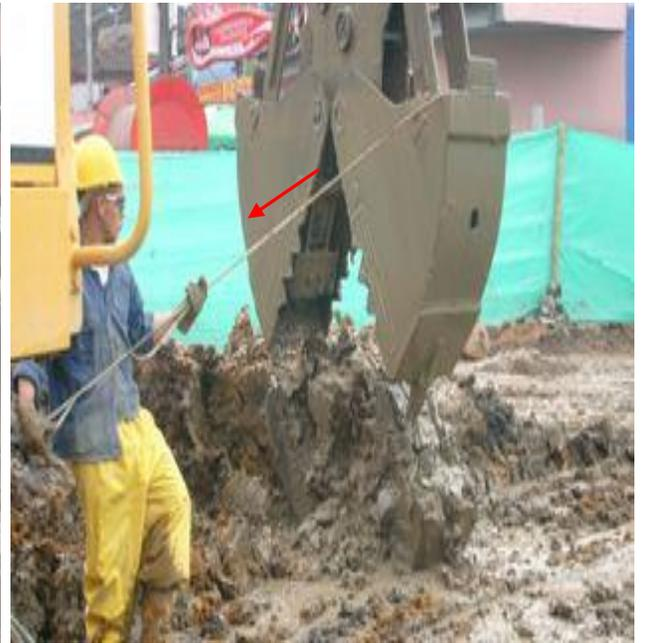
**FOTOS No 17 y No 18.** Detalle de la manipulación de la Almeja con la asistencia de un obrero, para ayudar al descargue del material excavado.
