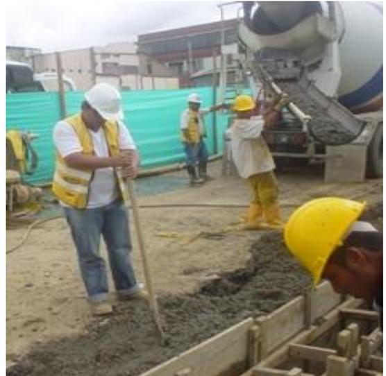
**FOTO No 5 y No 6.** En las fotos se evidencia el descargue del concreto del Míxer y el acomodo de este para darle el acabado final al muro guía.
