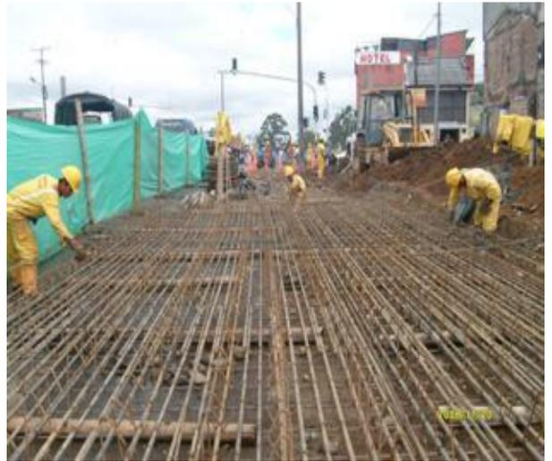
**FOTOS No 86 y No 87.** Después de instalados los ganchos se procedió a colocar las varillas verticales y horizontales interiores.
