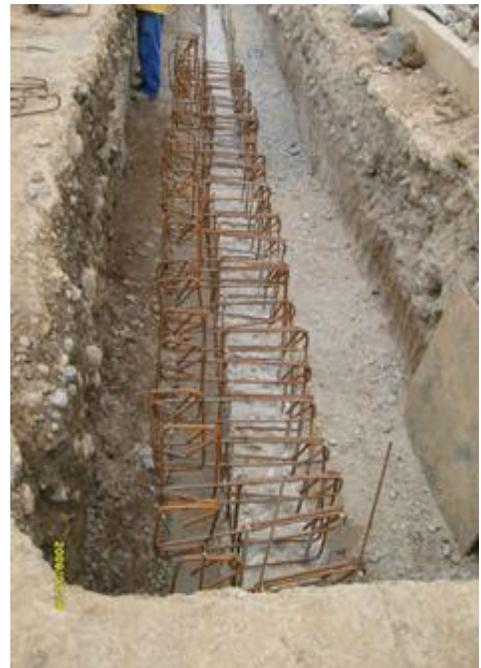
**FOTOS No 75 y 76.** Se detalla a los ayudantes de obra construyendo las vigas de amarre; y la instalación de dichas vigas a lo largo de las pantallas ya descabezadas.
