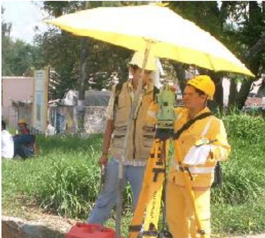
**FOTO No 1.** Comisión de topografía localizando los bordes internos y externos de los muros guías.
