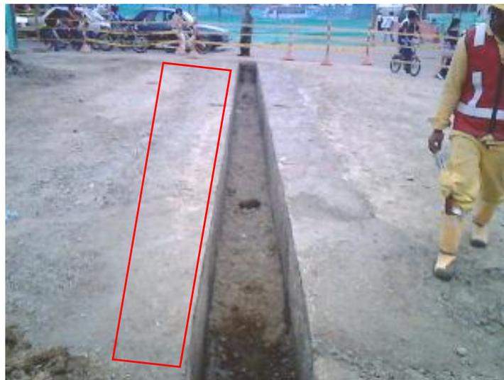
**FOTO No 9.** Detalle de un muro guía ya terminado y listo para iniciar el proceso de excavación de la pantalla.
