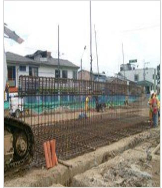
**FOTOS No 47 y No 48.** Detalle de una parrilla de refuerzo con barrete en el sitio de armado.
