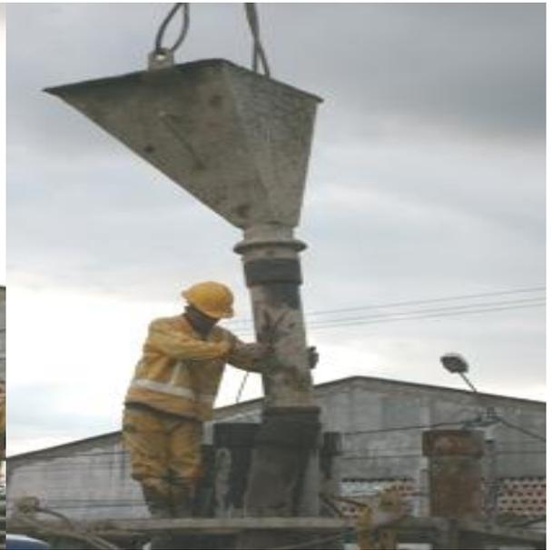
**FOTO No 59 y No 60.** Instalada la primera unidad se procedió a ubicar la segunda sección y a ensamblarla adecuadamente.
