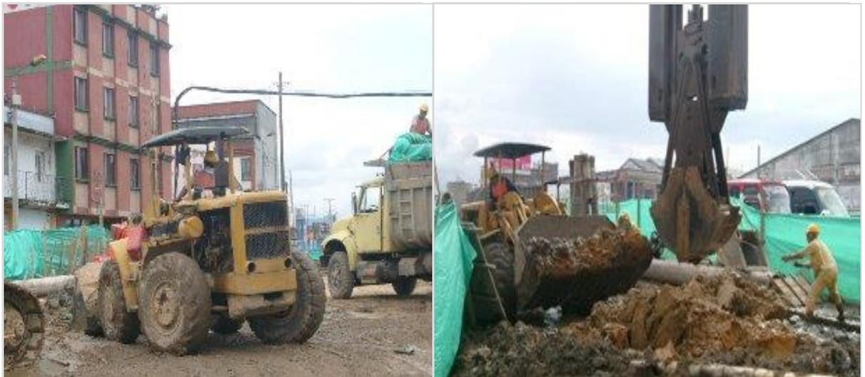
**FOTO No 27 y No 28.** Detalle del cargador recogiendo el material procedente de la excavación del módulo pantalla.
