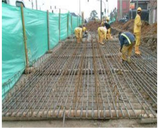
**FOTOS No 84 y No 85.** Detalle de la instalación de los ganchos en la armadura.
