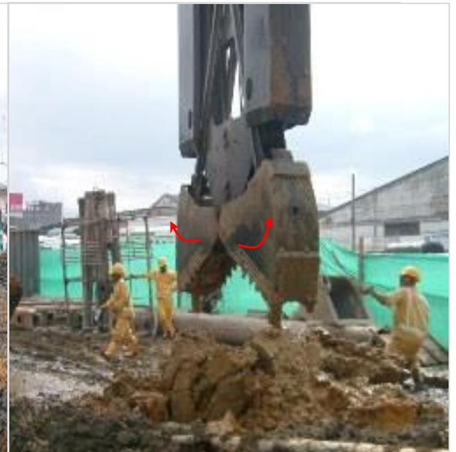
**FOTOS No 19 y No 20.** Detalle del descargue del material ya excavado.
