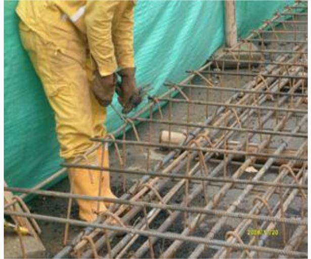
**FOTOS No 88 y No 89.** Detalle del amarre con alambre de los ganchos a las varillas.
