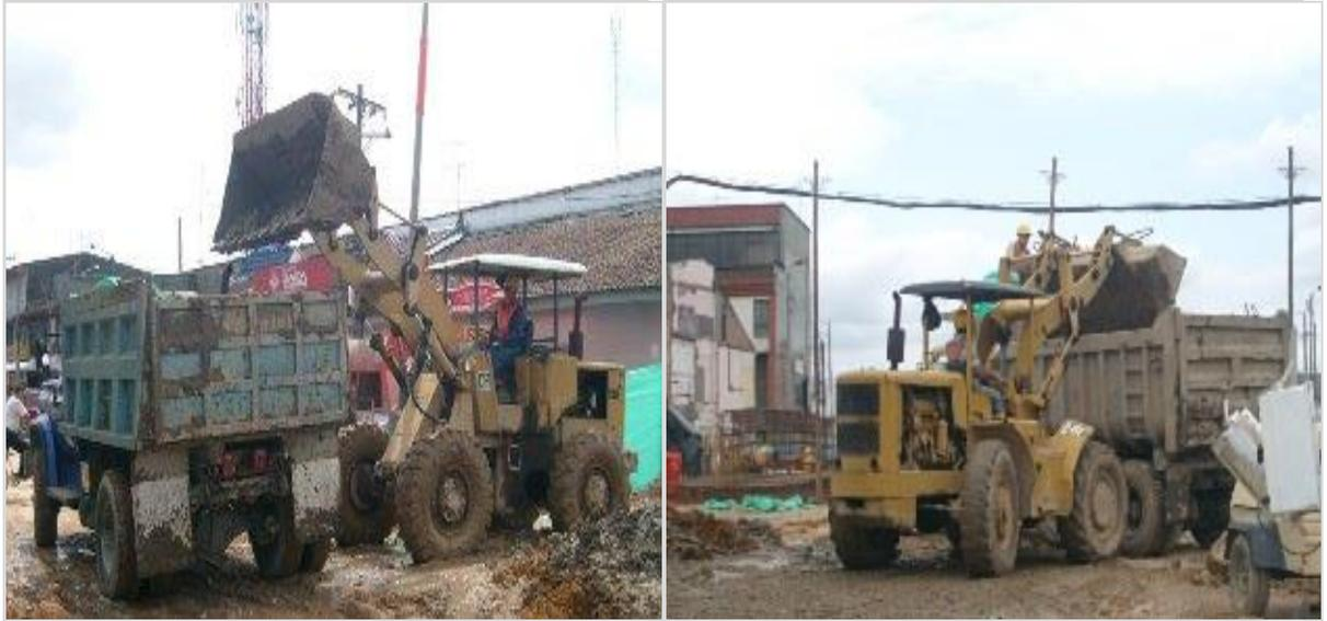
**FOTOS No 29 y No 30.** Detalle del cargador descargando el material recogido proveniente de la excavación a la volqueta la cual se encargará de llevarlo al relleno sanitario “el ojito”.
