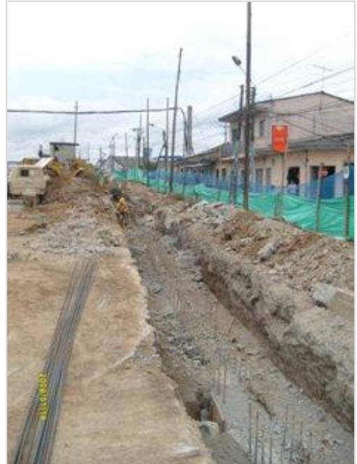
**FOTOS No 73 y No 74.** Se puede detallar el descabece de las pantallas, el cual se realizó con equipos manuales hasta dejar la zona totalmente despejada.
