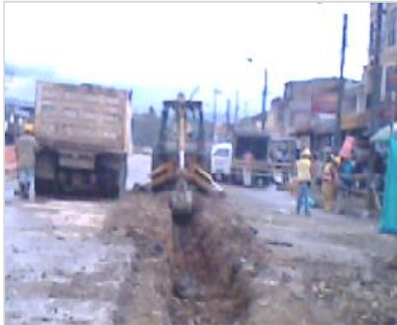
**FOTO No. 2.** Se detalla la excavación del terreno utilizando una retroexcavadora para la construcción de los muros guía.
