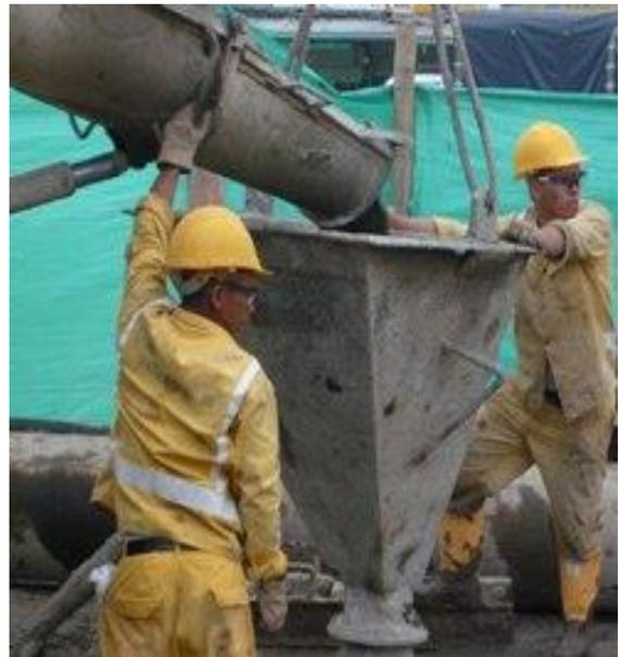
**FOTO No 69 y No 70.** Se detalla el descargue del concreto y a los ayudantes utilizando debidamente los implementos de seguridad industrial.
