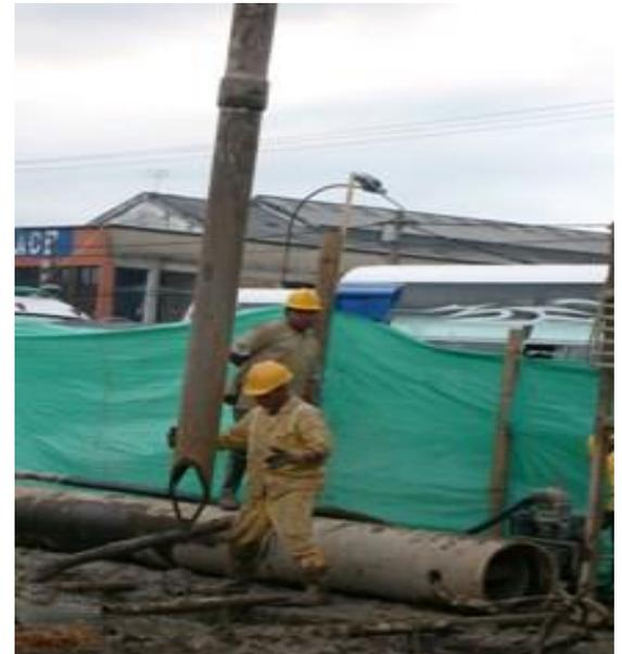
**FOTO No 65 y No 66.** El operario de la Grúa va levantando poco a poco la sección armada y junto con el ayudante la guían al modulo que se va a fundir.
