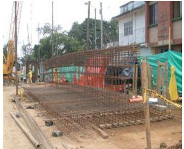
**FOTOS No 94 y No 95.** Detalle del acabado de las parrillas sin (izq.) y con barretes (der).
