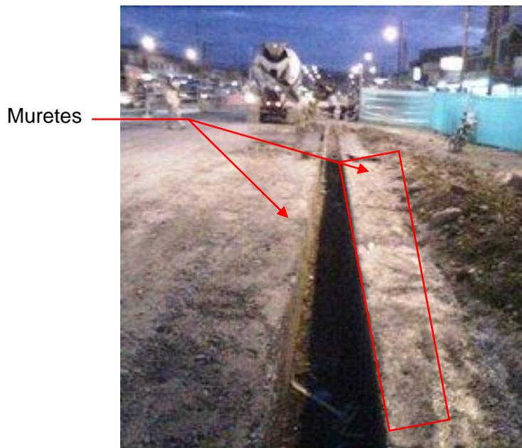
**Figura 4. Detalle del murete guía. Los muretes tienen un acabado final a ras del piso existente.**
