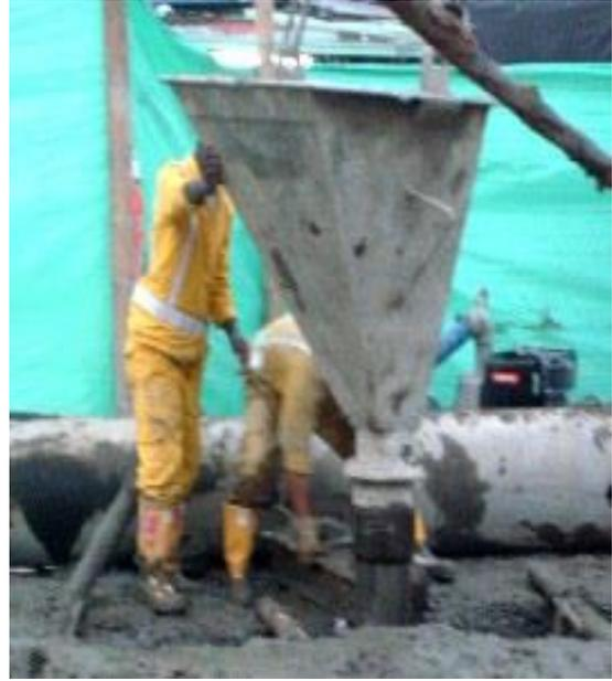
**FOTO No 67 y No 68.** Ubicada la tubería en el módulo correspondiente; se la va bajando lentamente hasta visualizar la parte superior de esta; seguidamente se coloca el elemento que mantendrá la tubería firme e impedirá su descenso.
