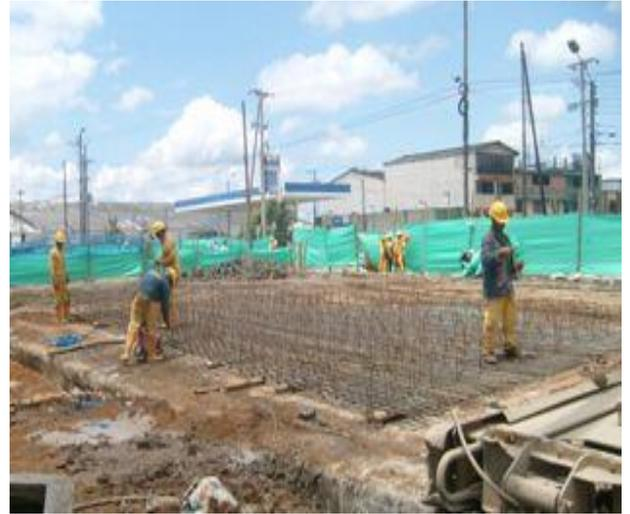
**FOTOS No 92 y No 93.** Para el armado de las parrillas se necesitaron 4 personas con el fin de agilizar su construcción.
