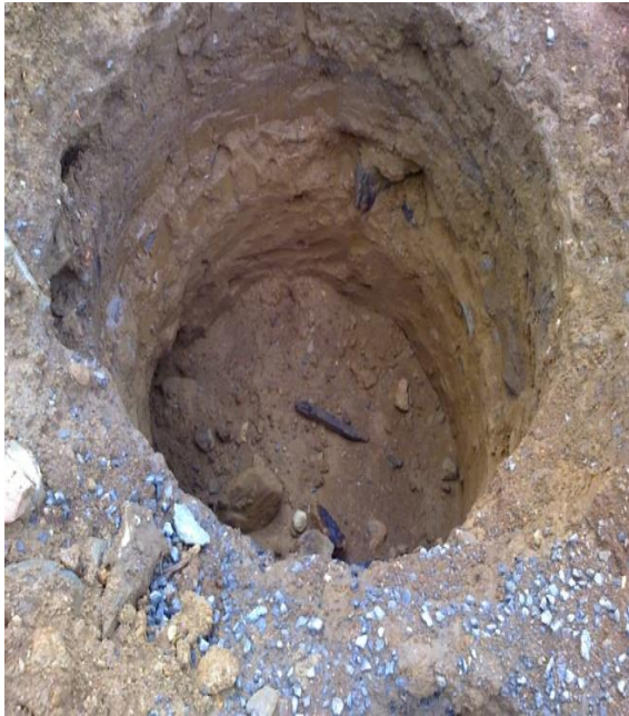
Excavación de Cámara
