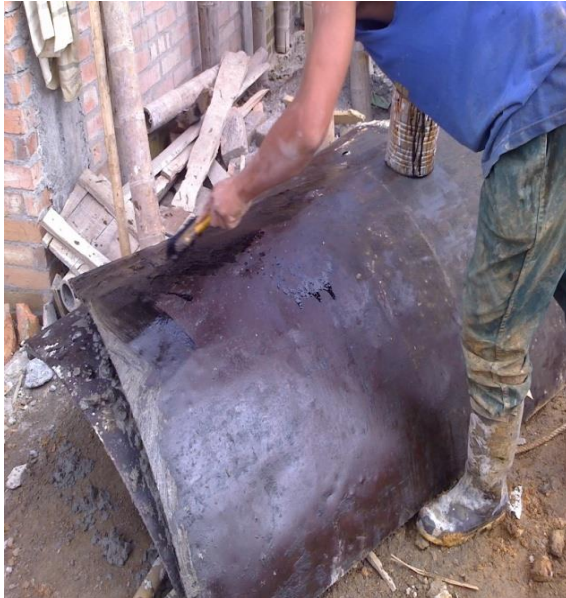
Aplicación de aceite quemado a la Formaleta.
