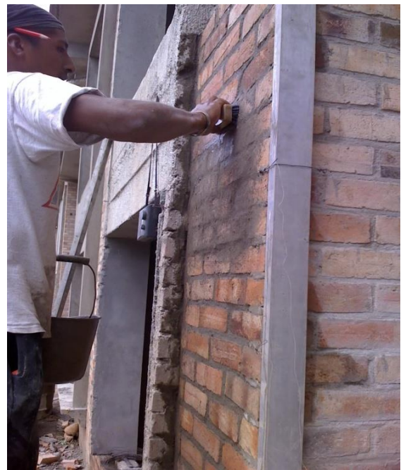
Cepillado del ladrillo pegado.
