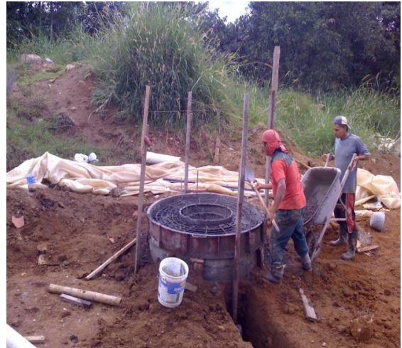
Refuerzo y formaleta de la tapa
