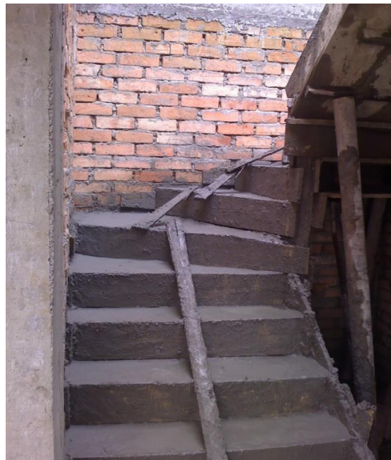
Gradas recién fundidas
