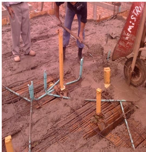
Colocación del concreto
