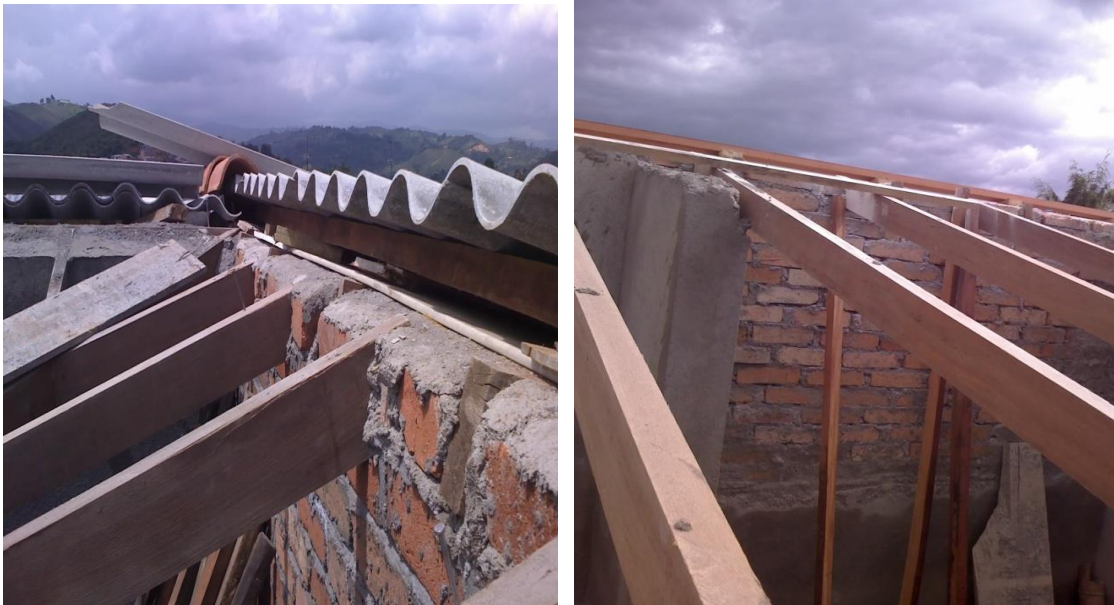
Colocación de los bastidores sobre las teleras
