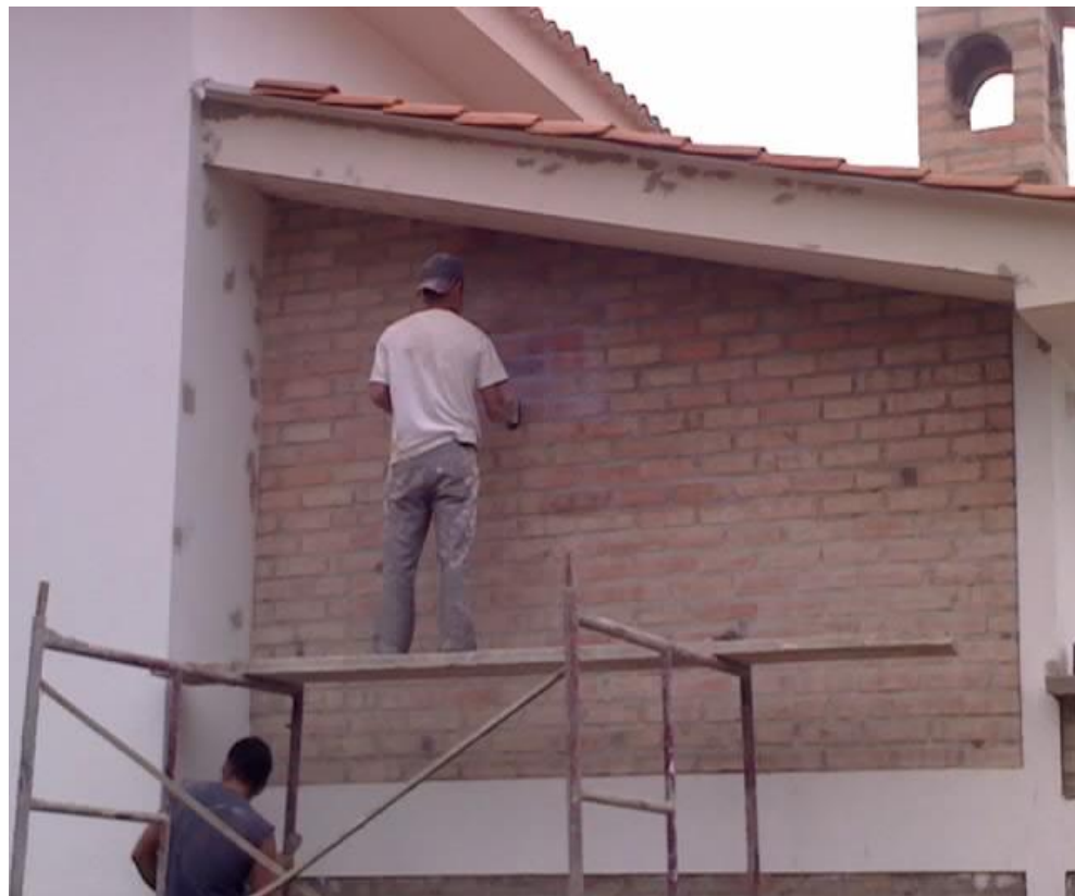
Pintura con Acronal en muros con ladrillo a la vista.
