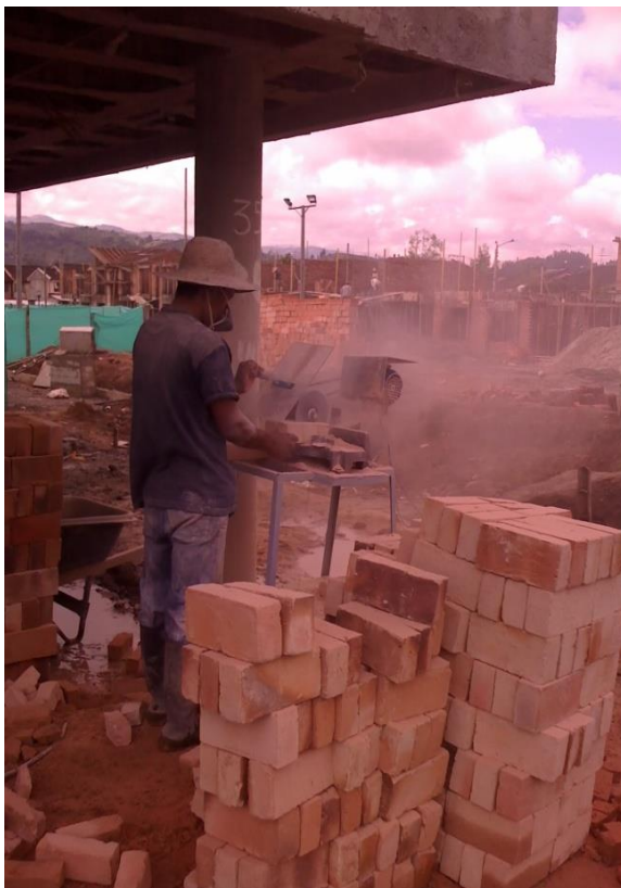
Corte del ladrillo
