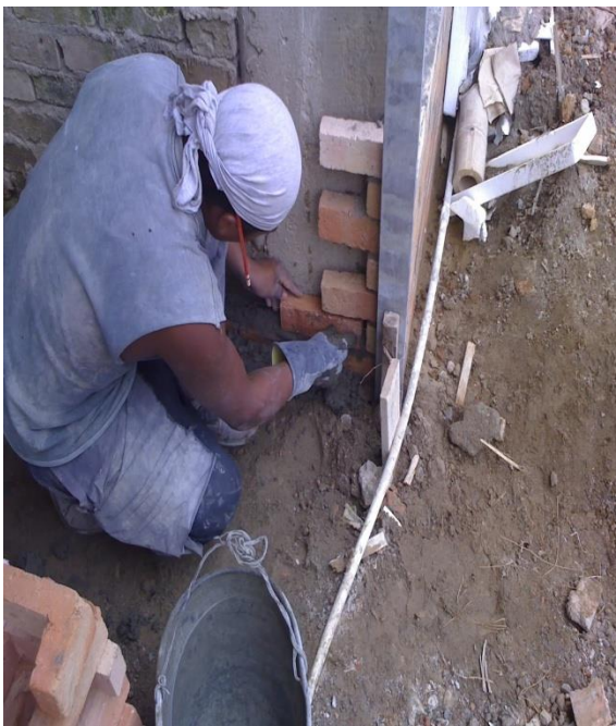
Pega del ladrillo recortado
