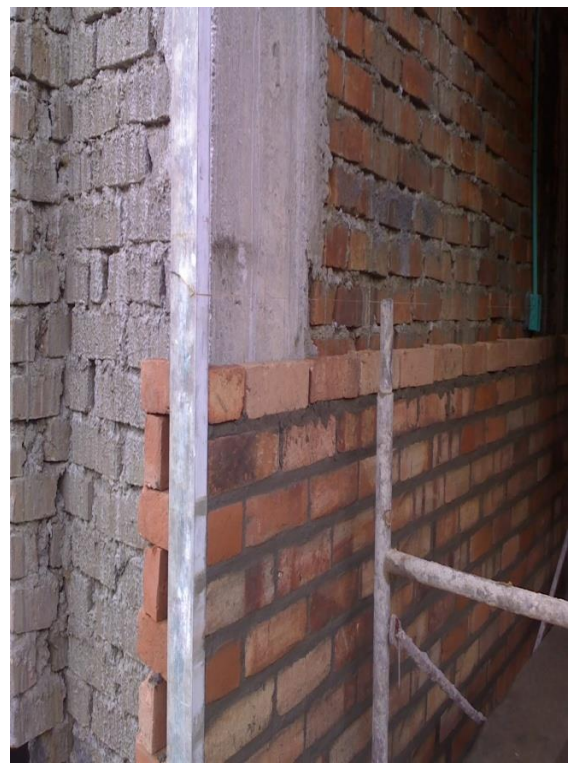
utilización del codal para dar verticalidad con hilo
