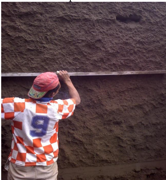
Utilización de codal para nivelar
