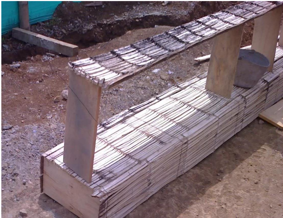
Construcción de casetones
