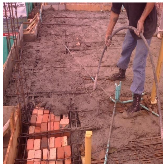
Vibrado de la mezcla
