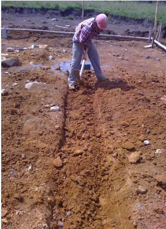
Excavación de las zanjas para colocación de tubería.
