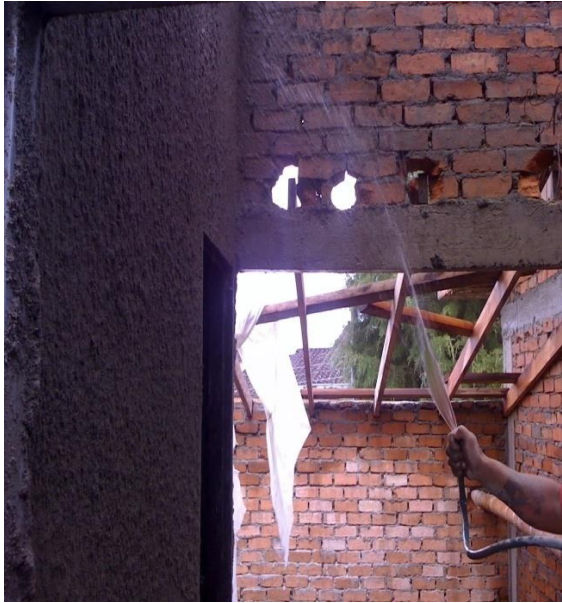
Humedecimiento del muro a repellar
