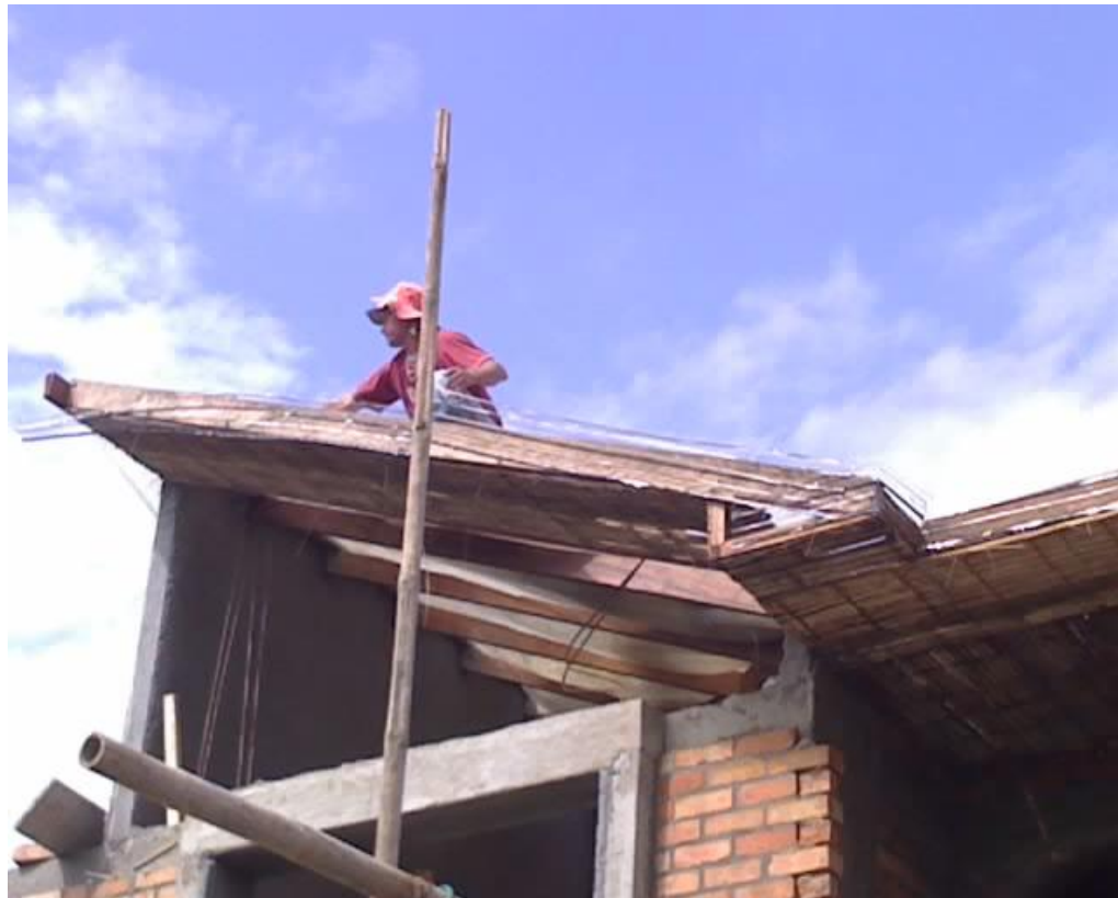
Cielo falso en el segundo piso hacia la calle.
