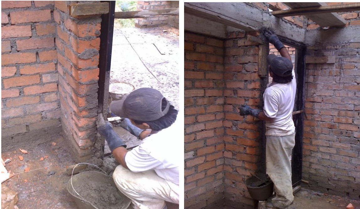
Aplicación del mortero
