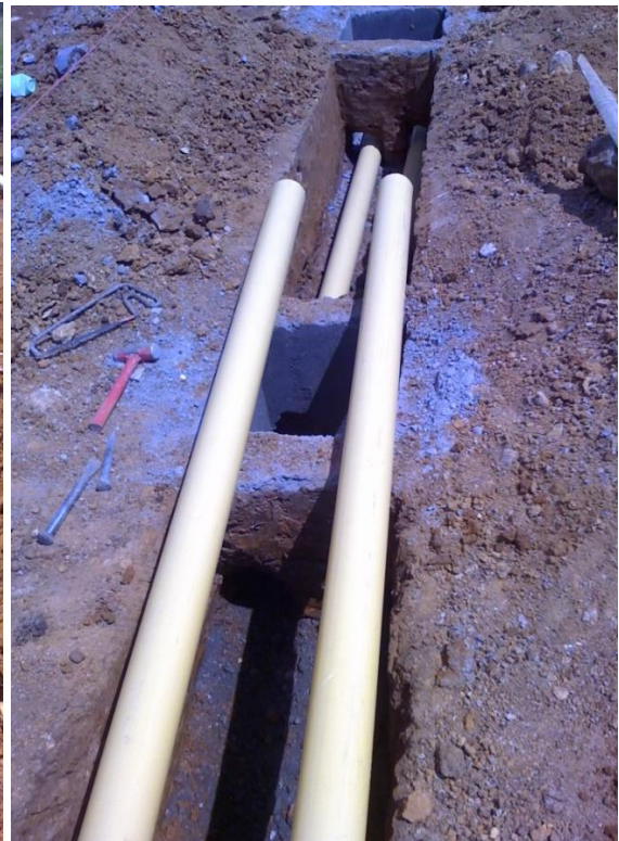
Colocación de las tuberías de conexión entre cámaras.
