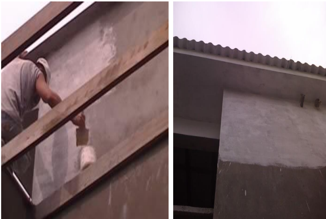
Aplicación de las primeras manos de pintura.
