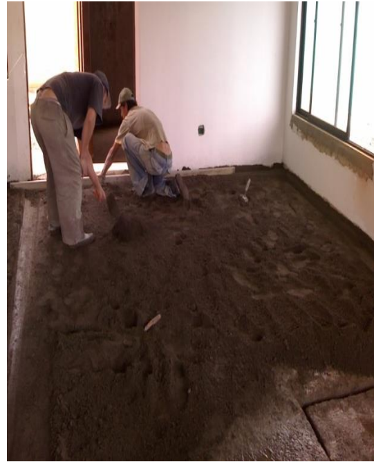
Colocación del mortero de nivelación.
