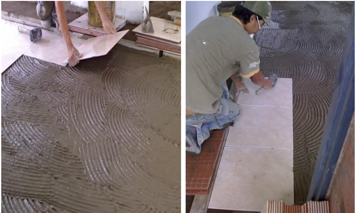
Colocación y pega de cerámicas.
