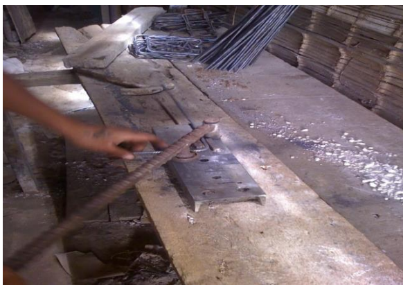
Figurado de estribos.
