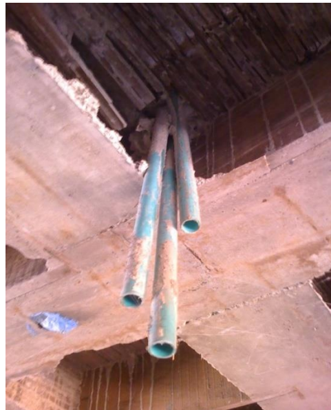
Tuberías en losas de entre piso
