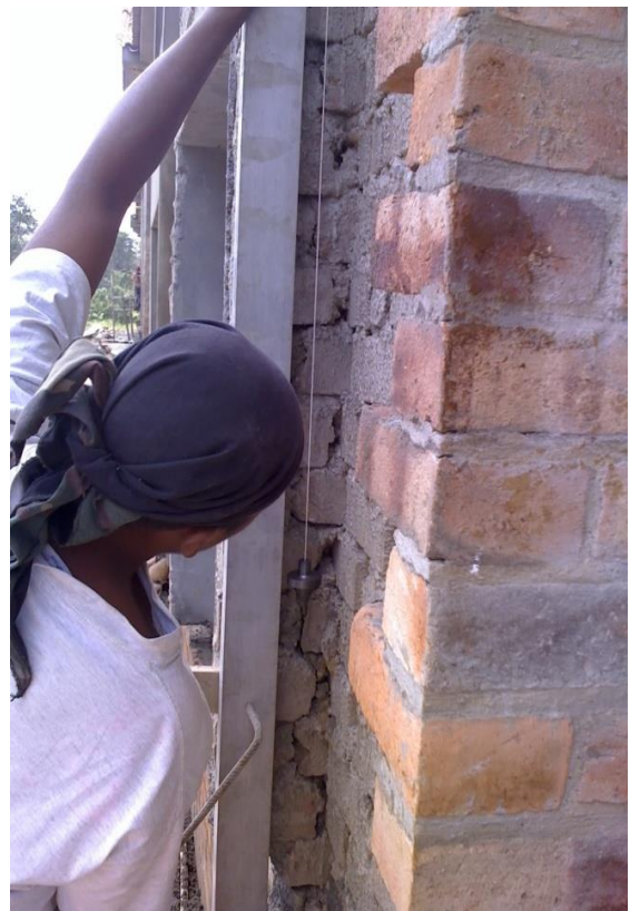
Verticalidad del codal para colocar hilo.
