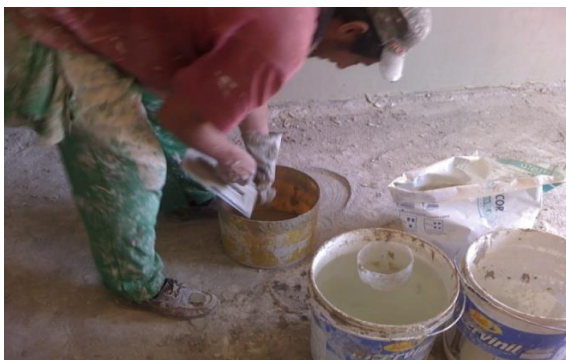
Mezcla del estuco con agua
