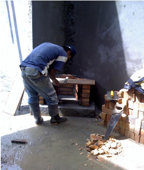
Colocación de formaleta y medición
