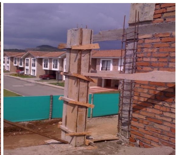
Columna lista para fundición
