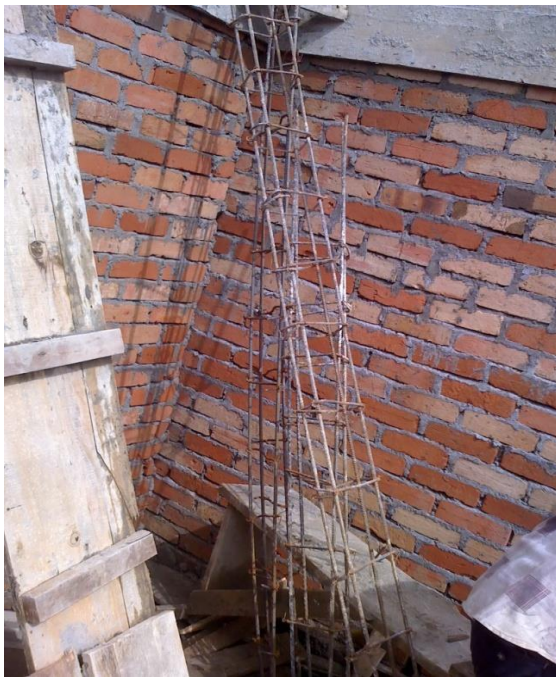
Refuerzo de vigas.
