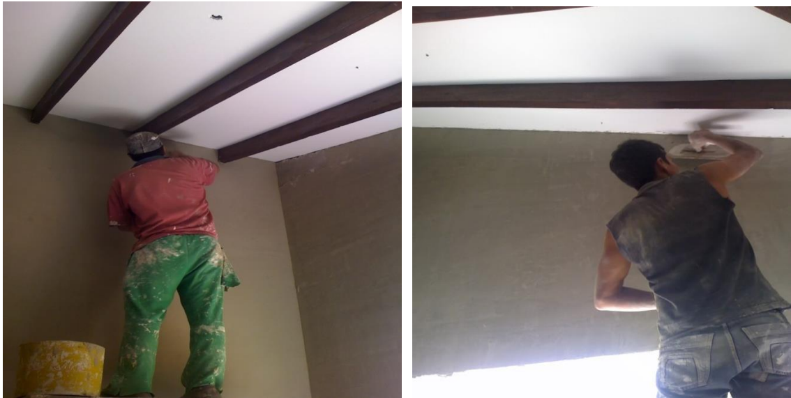
Estuco de paredes.
