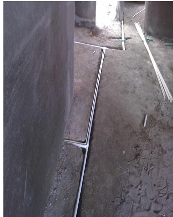
Ubicación de la tubería en los espacios cincelados.
