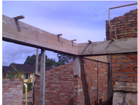
Colocación de la formaleta de las vigas.
