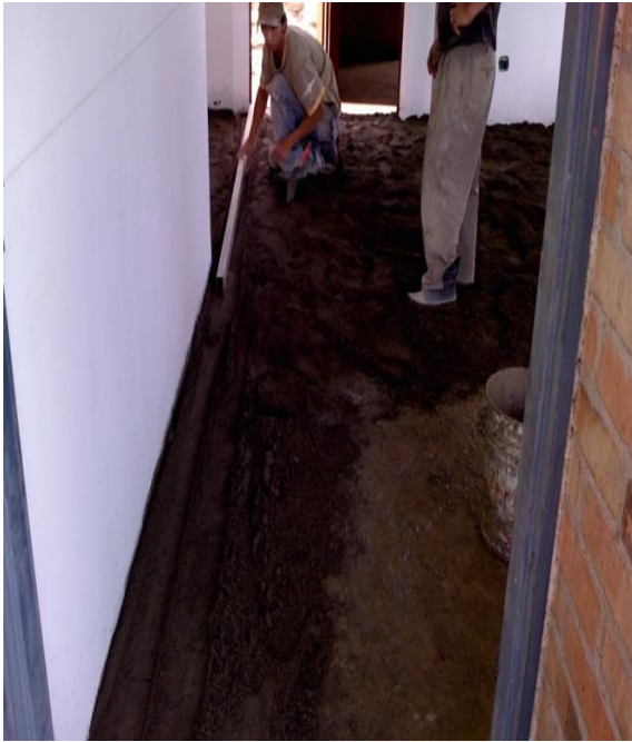
Colocación del mortero de nivelación.
