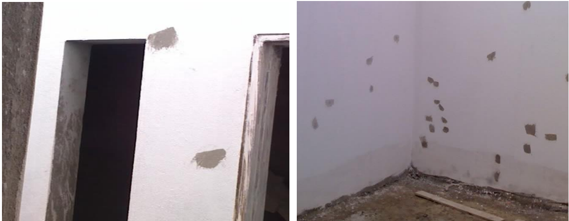
Relleno con agua-cemento
