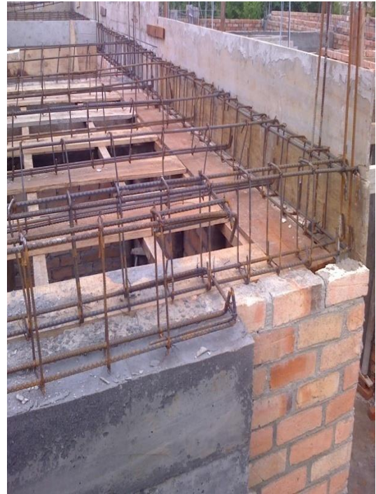
Colocación de Acero de refuerzo
