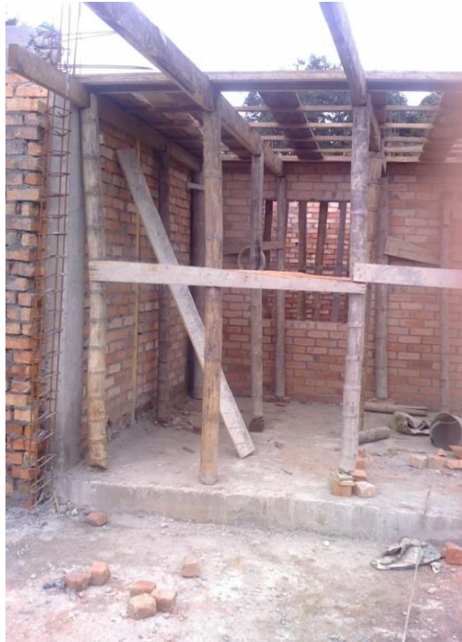
Colocación de tacos
