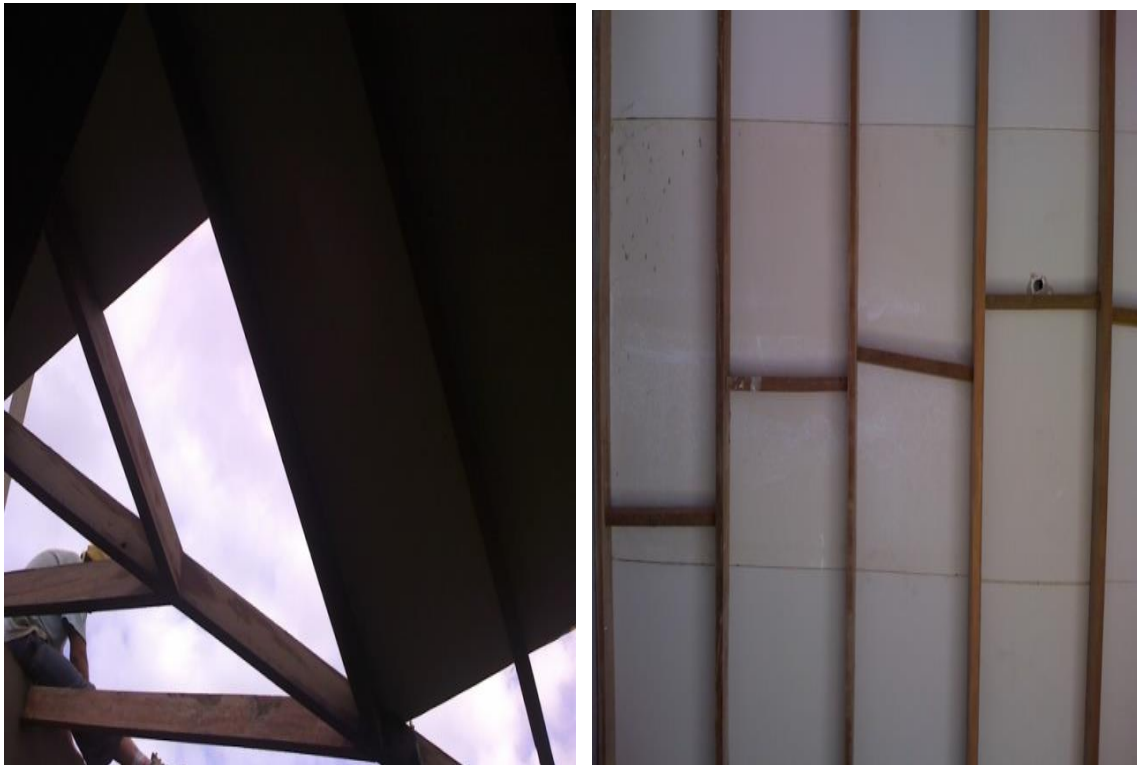
Atornillado del panel sobre las teleras
