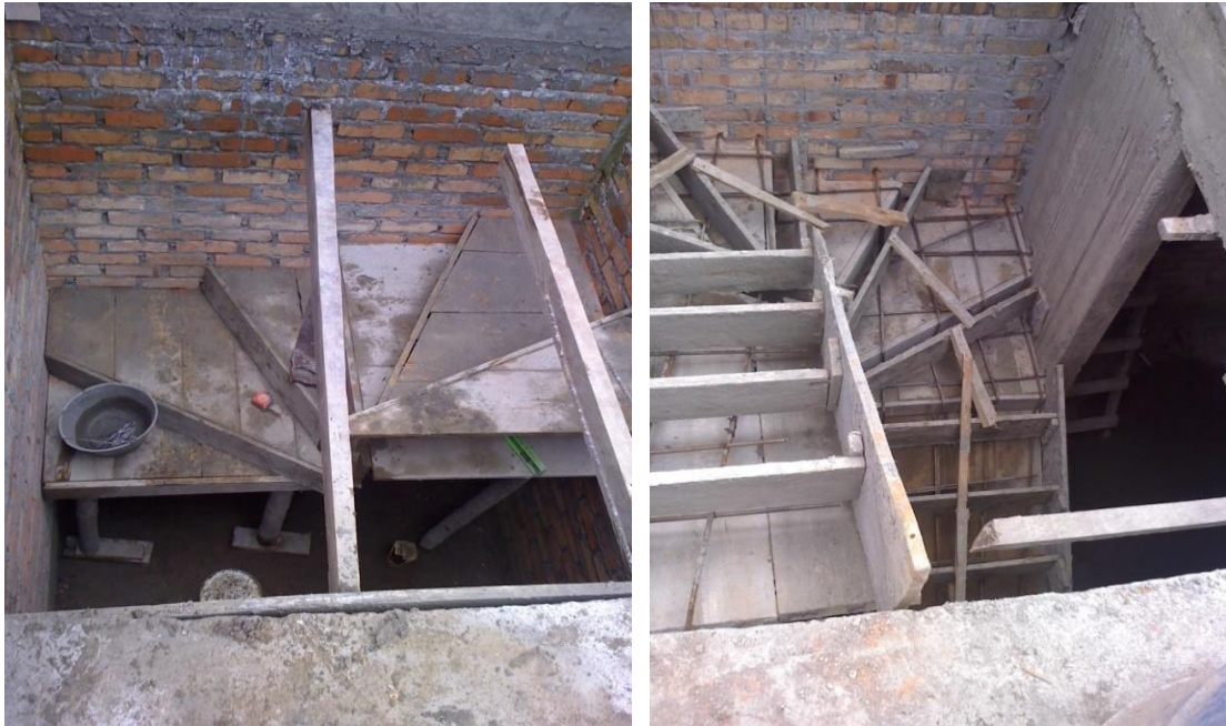
Colocación de formaletas y refuerzo de las gradas.
