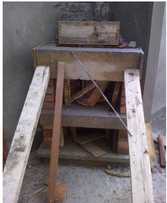
Colocación de formaleta y medición
