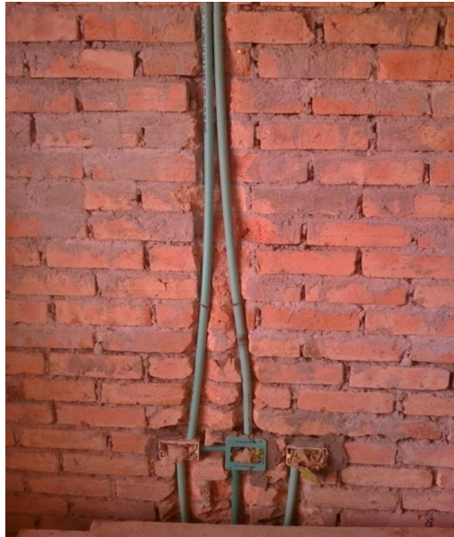
Colocación de tubería desde Las cajas
