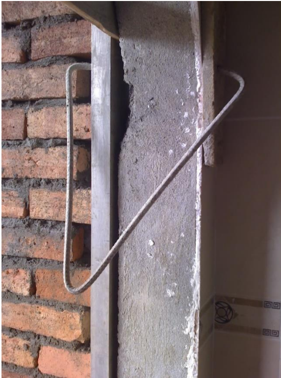
Gancho utilizado para sostén del codal
