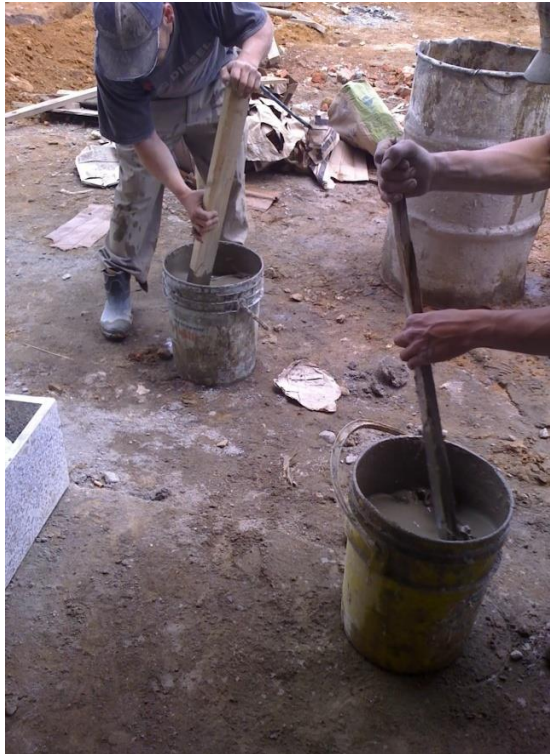
Mezcla de cemento con agua para la pega de cerámica.
