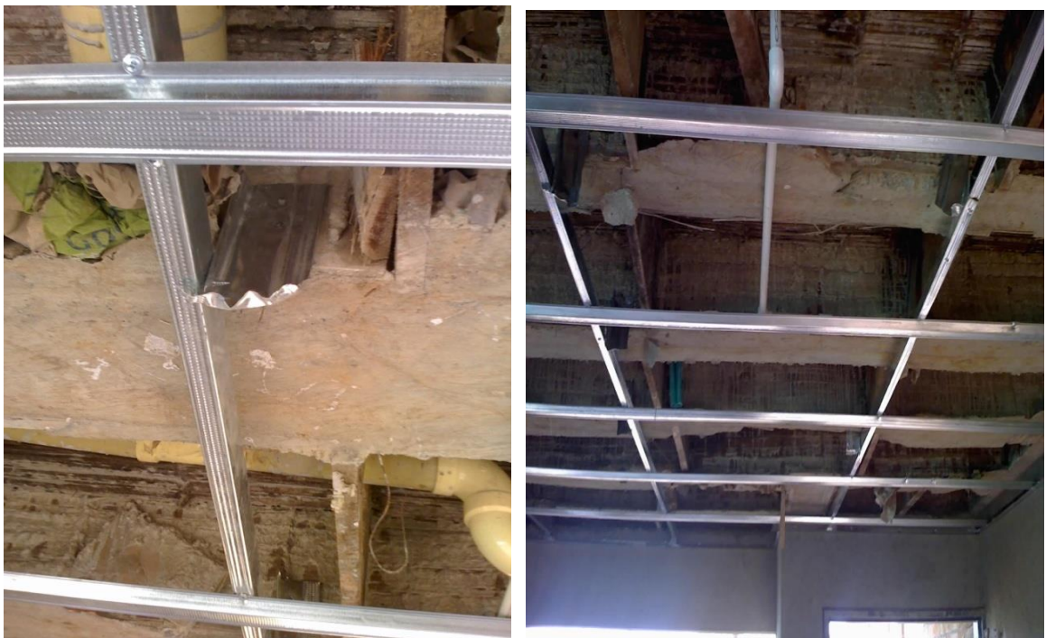
Colocación de la estructura metálica.
