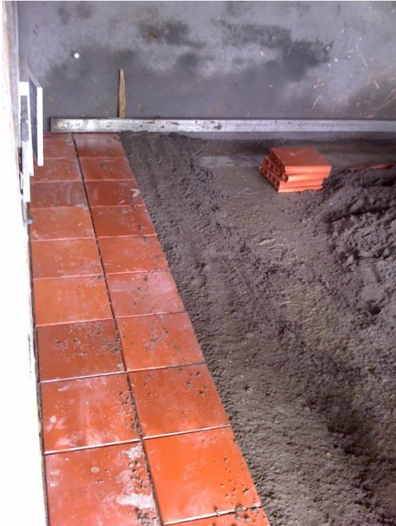
Utilización del codal para Horizontalidad
