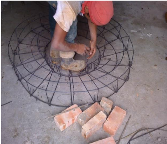
Colocacion del refuerzo de la tapa de la cámara
