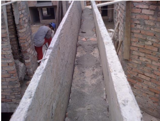
Colocación de la formaleta de las vigas.
