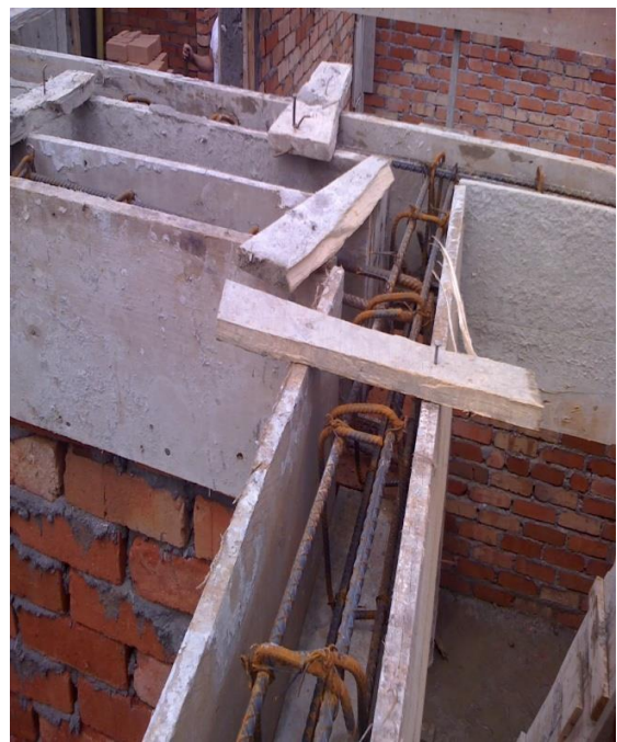
Refuerzo y formaleta ya colocados
