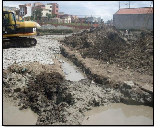
Foto 75 y 76. Construcción de zanjas para drenaje para evacuar las aguas provenientes de la piscina.
