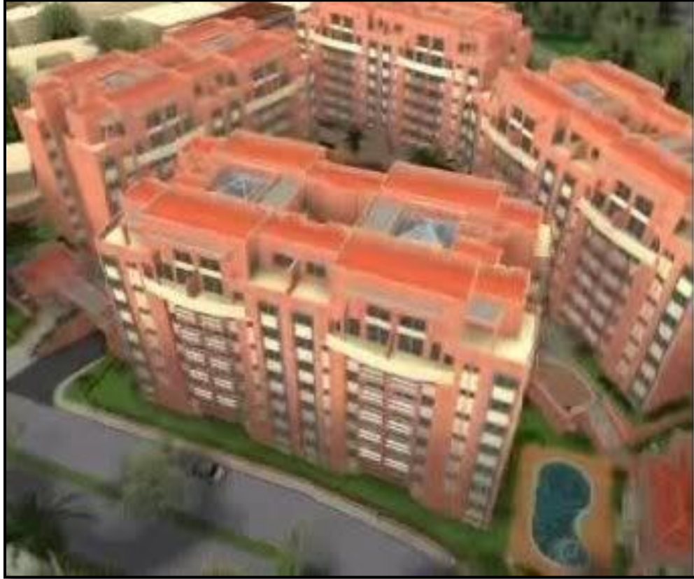
Foto 1. Vista general Conjunto Residencial la Estación
