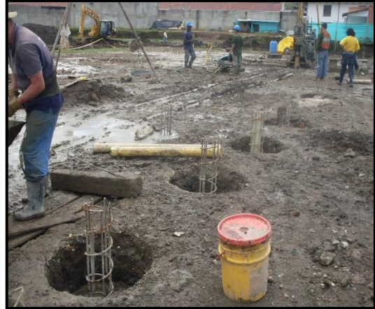
Foto 14. Pilotes torre D
