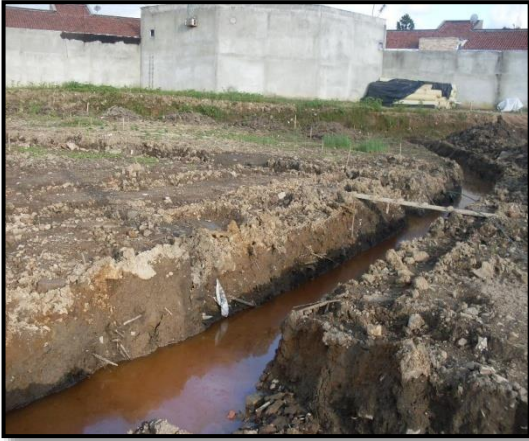
Foto 75 y 76. Construcción de zanjas para drenaje para evacuar las aguas provenientes de la piscina.
