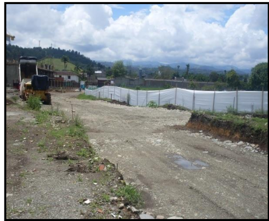
Foto 79 y 80. Construcción de pedraplén que trabajará como filtro para drenaje en la vía 5N
