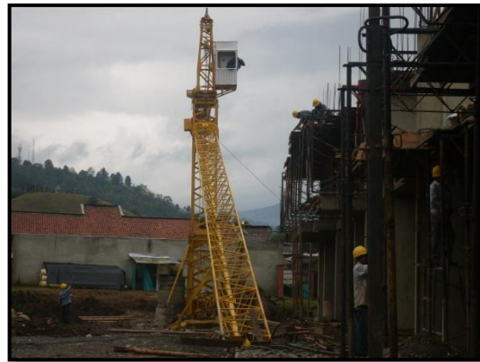
Foto 30. Armado de torre grúa
