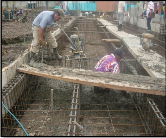
Foto 39 y 40. Fundición de losa inferior de cimentación
