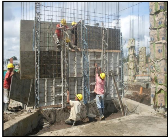
Foto 54. Instalación formaleta metálica para pantallas del primer al sexto nivel
