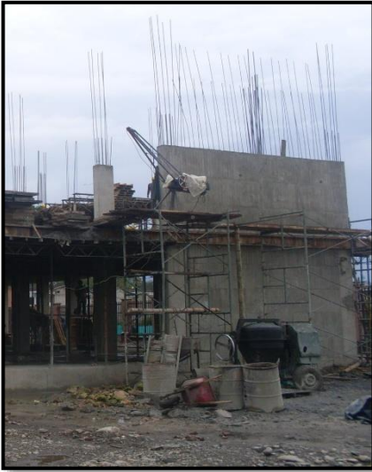
Foto 29. Pluma y mezcladora de un saco
