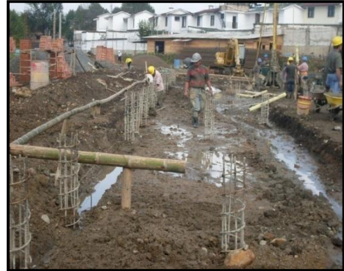
Foto 36. Localización y replanteo para las vigas de cimentación.
