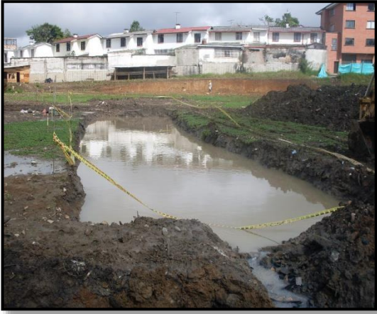
Foto 73 y 74. Piscina para recolectar aguas provenientes del nivel freático y para secar el lote.
