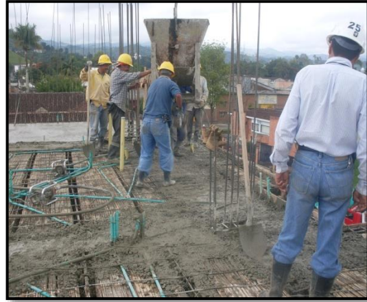
Foto 46. Fundición de losa
