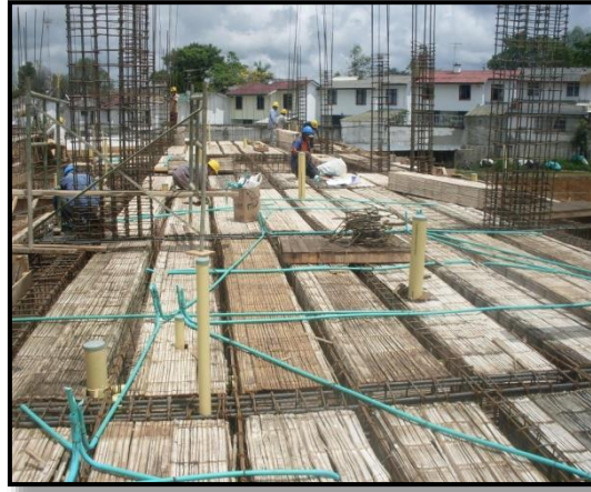
Foto 57 y 58. Instalaciones hidrosanitarias
