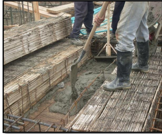
Foto 44. Fundición de panelas de concreto
