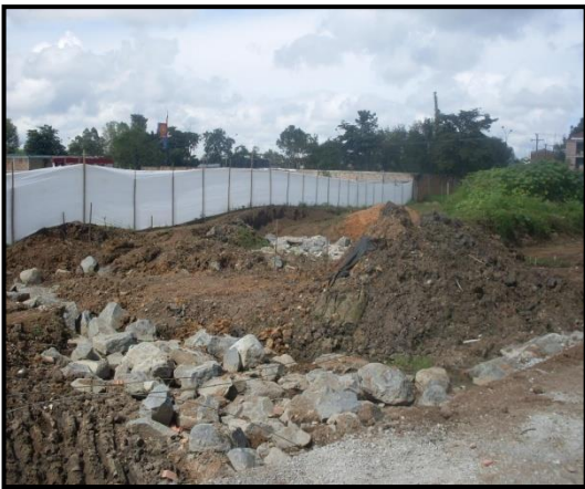
Foto 79 y 80. Construcción de pedraplén que trabajará como filtro para drenaje en la vía 5N
