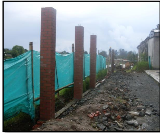
Foto 69 y 70. Columnetas en ladrillo calle 5N Y 6B
