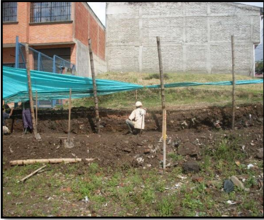
Foto 65. Excavación carrera 6B
