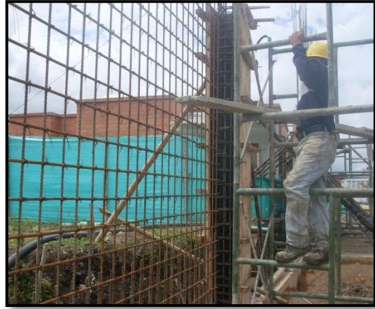
Foto 51 y 52. Armado de pantallas
