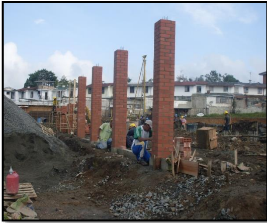
Foto 69 y 70. Columnetas en ladrillo calle 5N Y 6B
