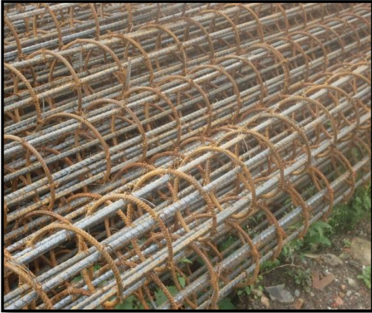
Foto 9. Castillos de acero para pilotes
