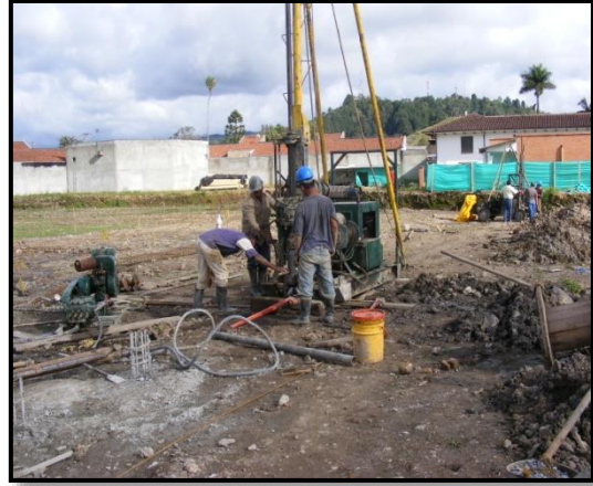
Foto 4. Perforación con el tricono
