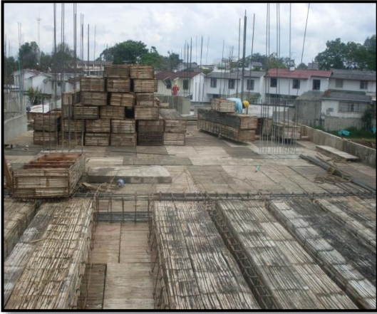
Foto 45. Armado de losa
