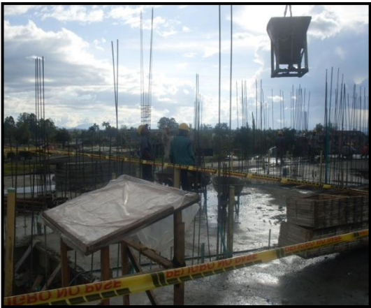
Foto 33. Demarcación de zona segura
