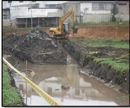
Foto 73 y 74. Piscina para recolectar aguas provenientes del nivel freático y para secar el lote.
