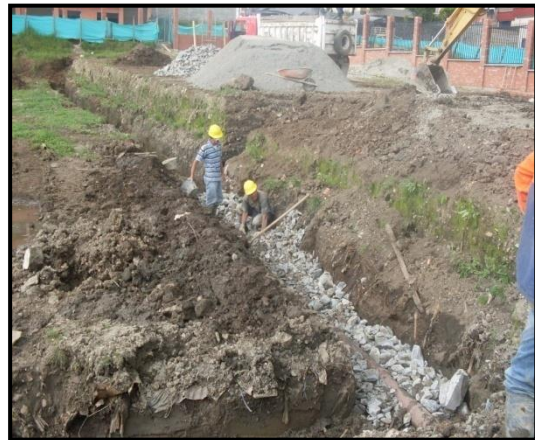
Foto 77 y 78. Construcción de filtros con piedra
