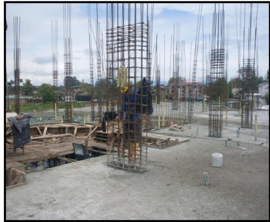
Foto 49 y 50. Armado de columnas 0.30x1.0m
