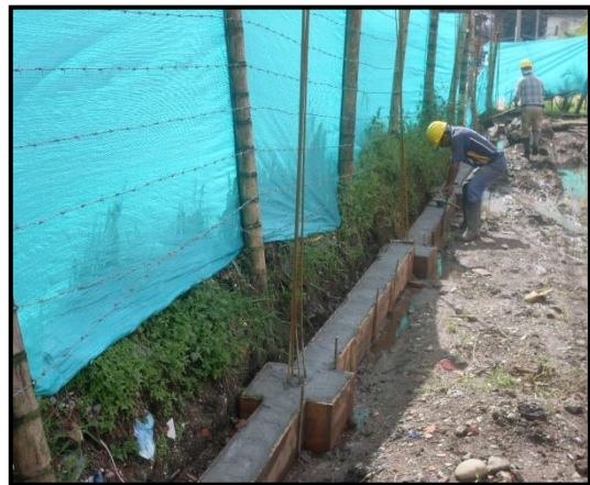
Foto 67 y 68. Viga de cimentación calle 5N y 7N
