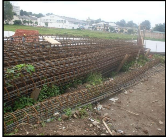
Foto 10. 6 varillas de diámetro ½" y estribos en espiral de 3/8" con paso cada 15 cm
