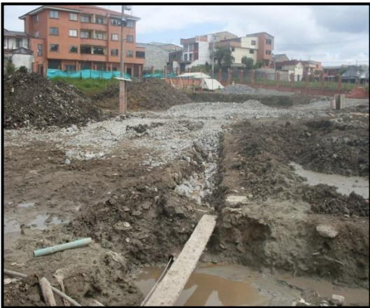
Foto 77 y 78. Construcción de filtros con piedra
