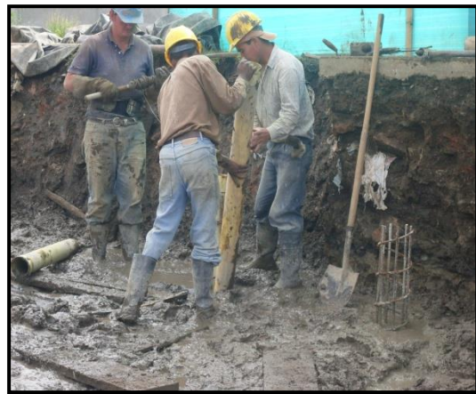
Foto 11 y 12. Fundición de pilotes
