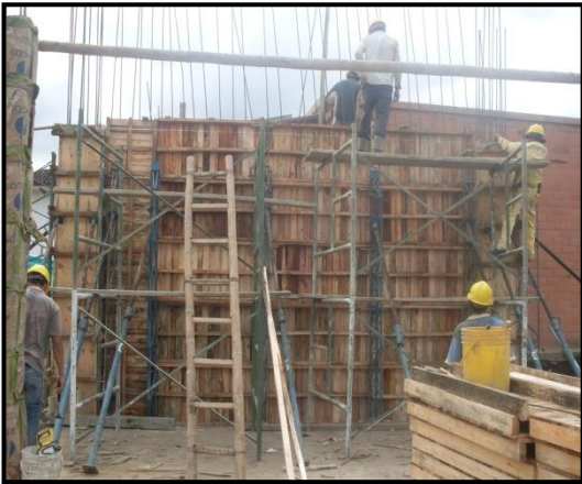
Foto 53. Instalación formaleta de madera para pantallas del sótano
