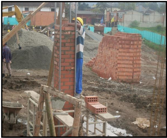
Foto 63. Pega de ladrillo
