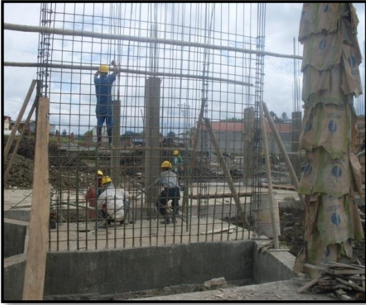
Foto 51 y 52. Armado de pantallas
