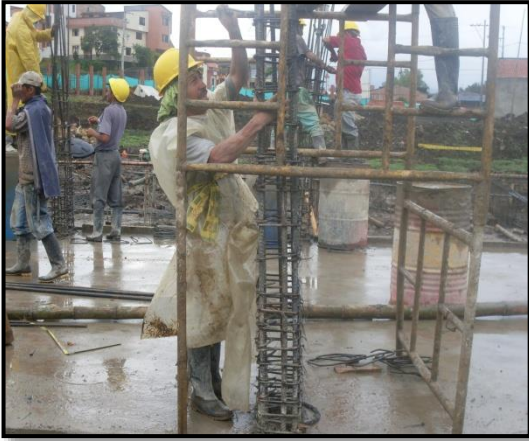
Foto 47 y 48. Armado de columnas 0.30x0.50m
