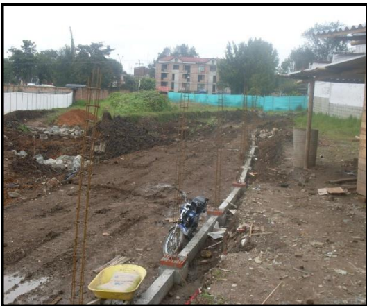
Foto 67 y 68. Viga de cimentación calle 5N y 7N
