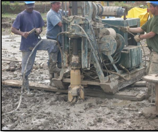
Foto 7. Excavación mecánica con el tricono
