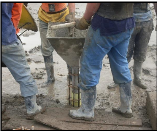
Foto 11 y 12. Fundición de pilotes
