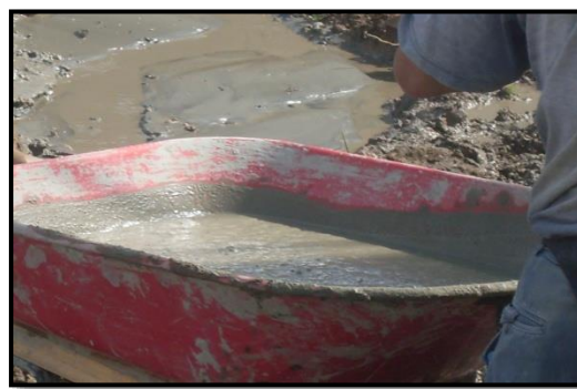
Foto 2. Mezcla de concreto tremie para pilotes
