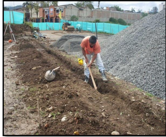
Foto 66. Excavación calle 5N
