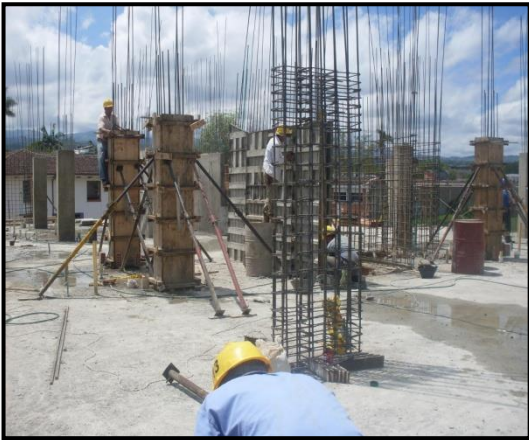
Foto 49 y 50. Armado de columnas 0.30x1.0m
