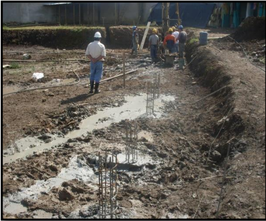
Foto 13. Pilotes torre C
