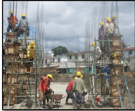
Foto 47 y 48. Armado de columnas 0.30x0.50m
