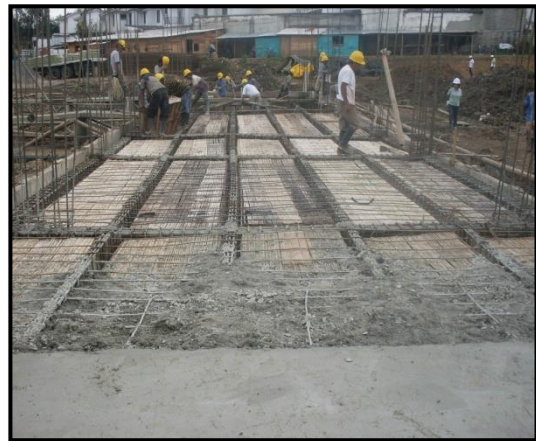
Foto 42. Fundición de losa superior de cimentación
