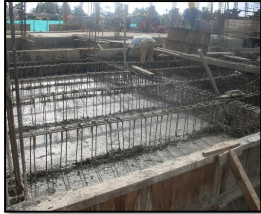
Foto 39 y 40. Fundición de losa inferior de cimentación
