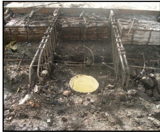
Foto 18. Encamisado pilote No 80 con tubo de pvc
