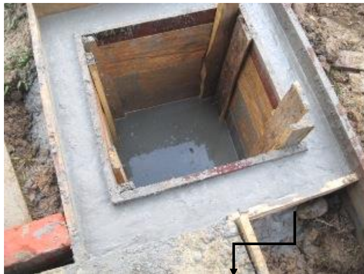
Encofrado de caja de inspección
