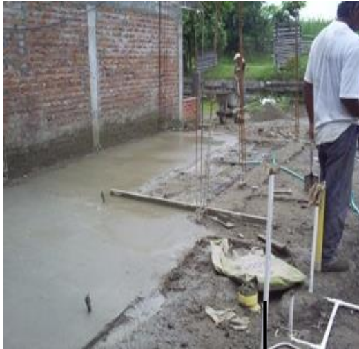
Figura 60. Tuberías subterráneas
