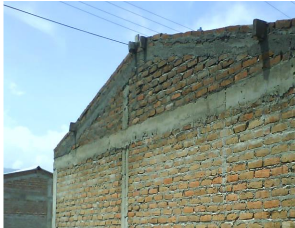
Figura 50. Vigas de madera sobre cinta corona
