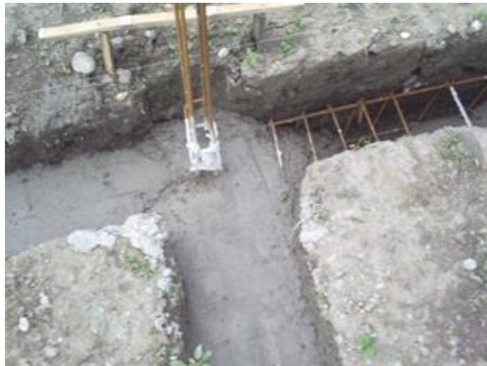
Figura 14. Fundición de viga de cimentación en concreto reforzado
