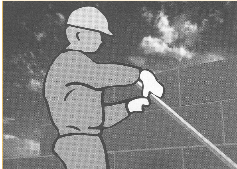
Figura 36. Verificación de la Alineamiento Diagonal (planitud)
