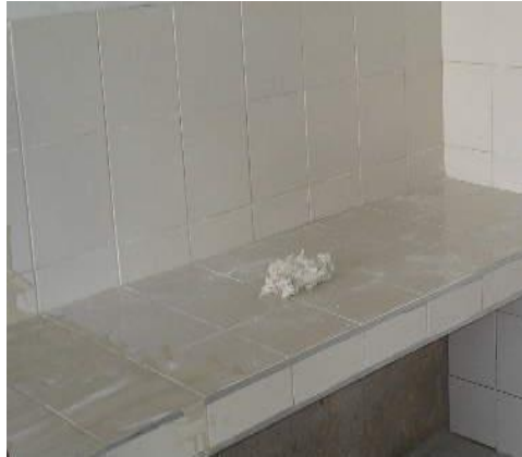
Figura 63. Enchape mesón y muro frontal
