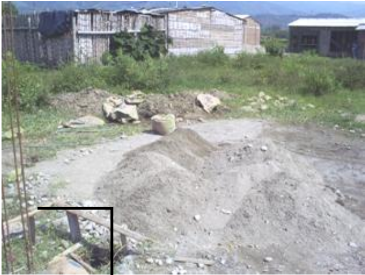
Figura 1. Puente para localización de ejes en el terreno
