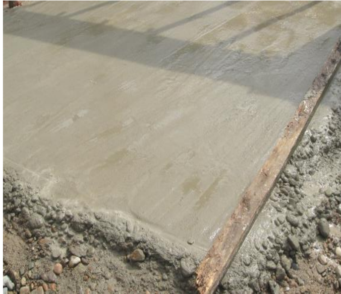
Figura 28. Fundición piso primario
