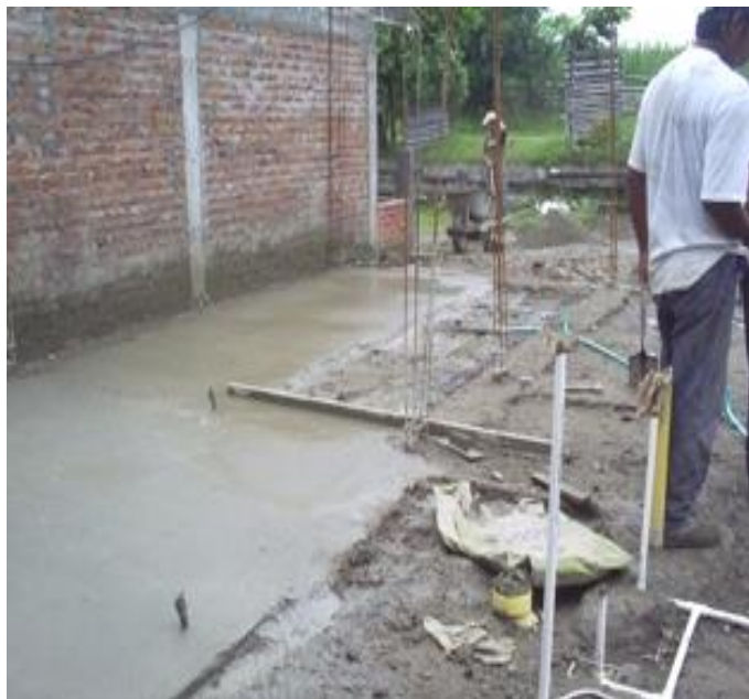
Figura 29. Segundo modelo Fundición piso primario e= 5 cm.
