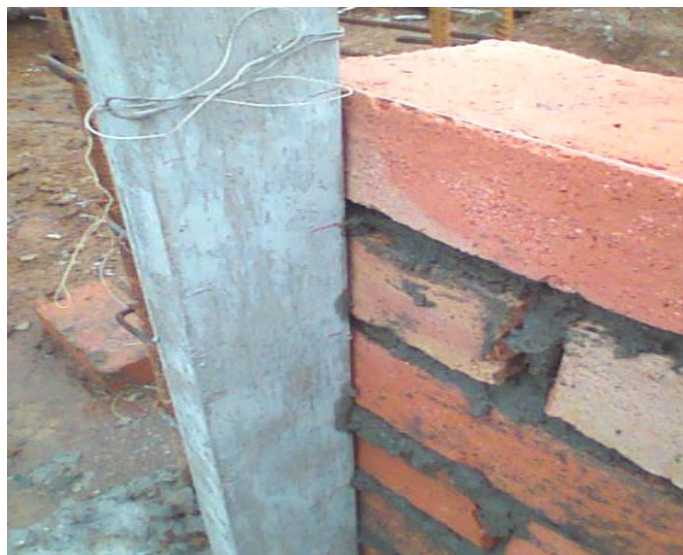
Figura 38. Levantamiento de muro con mira
