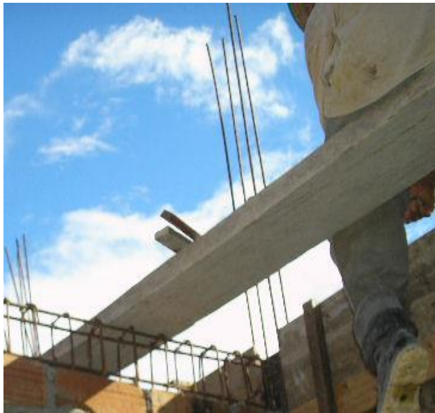
Figura 45. Formaleta Vigas de amarre
