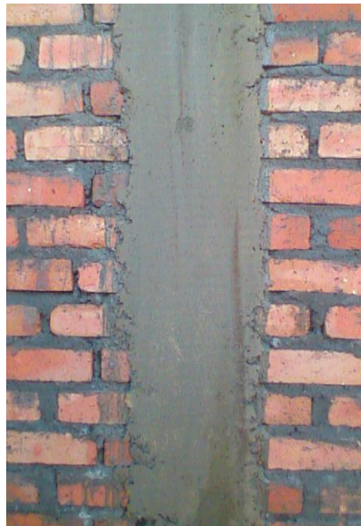
Figura 43. Fundición de la columneta
