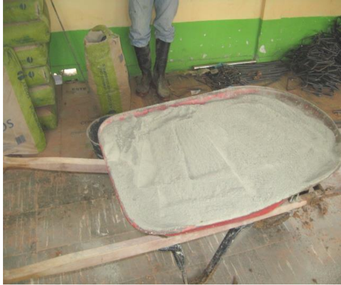
Figura 20. Dosificación de concreto 17.5 mpa
