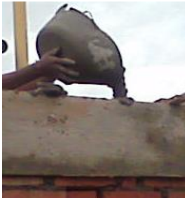
Figura 46. Formaleta y Vaciado □Vigas de amarre□
