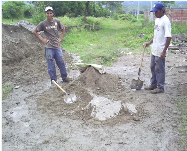
Figura 21. Preparación de la mezcla de concreto
