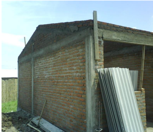
Figura 47. Vista lateral de la vivienda
