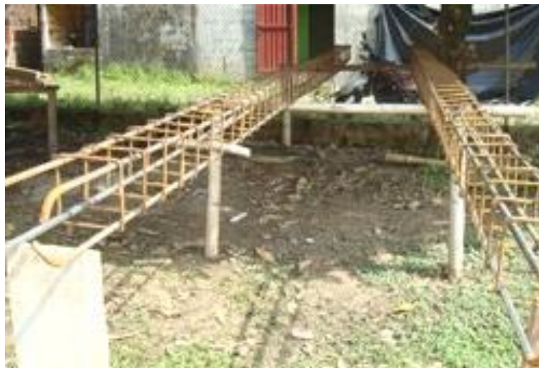
Figura 25 Modelo 1 Castillos de refuerzo viga de cimentación
