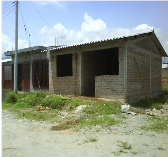
Figura 55. Vivienda con cubierta en teja de asbesto cemento
