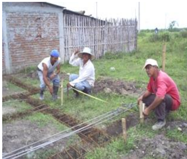
Figura 11. Colocación de aceros para la viga de cimentación
