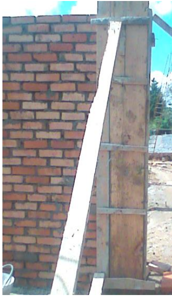
Figura 43. Fundición de la columneta
