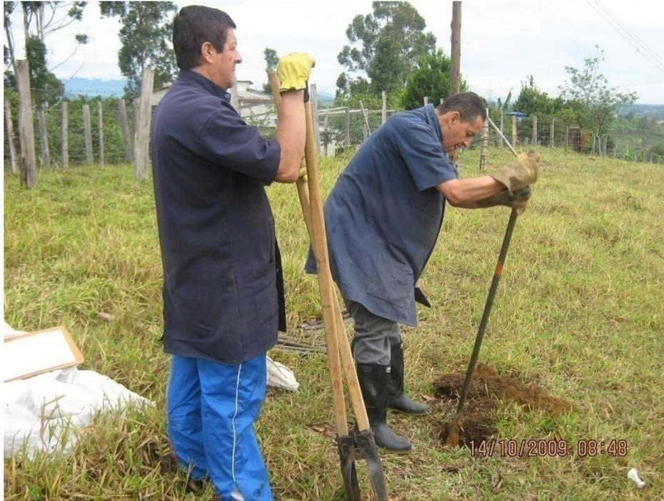
Figura 1. Extracción de la capa vegetal del terreno en el sitio donde se localizará el tanque N°1.
