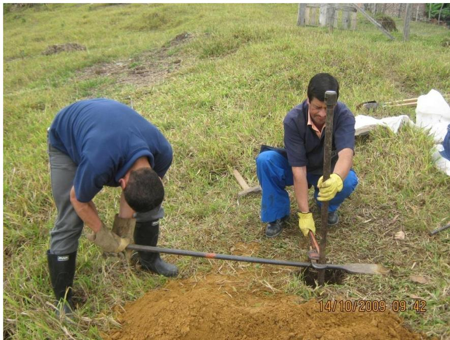
Figura N° 5 Extracción del tubo shelby.
