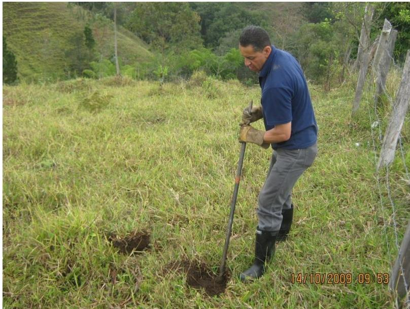
Figura N° 7 Extracción de la capa vegetal en sitio donde se construirá el tanque N°2.
