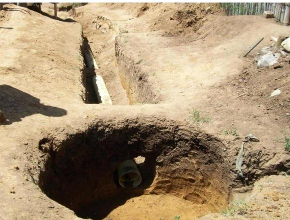
*Tubería instalada, lista para hacer el relleno*
