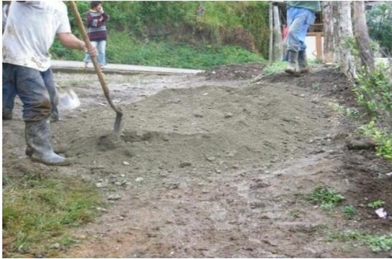
*Mezcla de concreto de forma manual proporciones 1:2:3*
