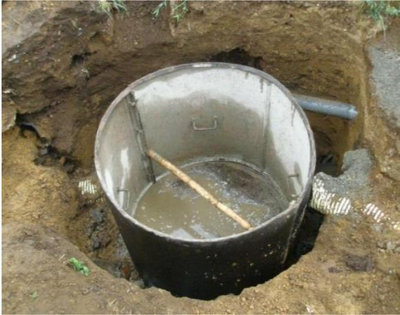
*Instalación de formaleta metálica para la fundición del pozo de inspección.*
