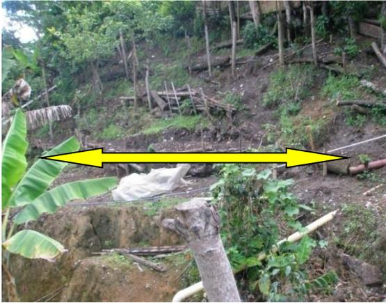
*Esta es la parte donde las familiar proponen la construcción del muro de contención. Aquí se observa la longitud del muro a construir.*
