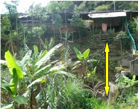
*Aquí se puede observar la altura tan grande del muro que habría que construir y además se evidencia la magnitud del asentamiento*
