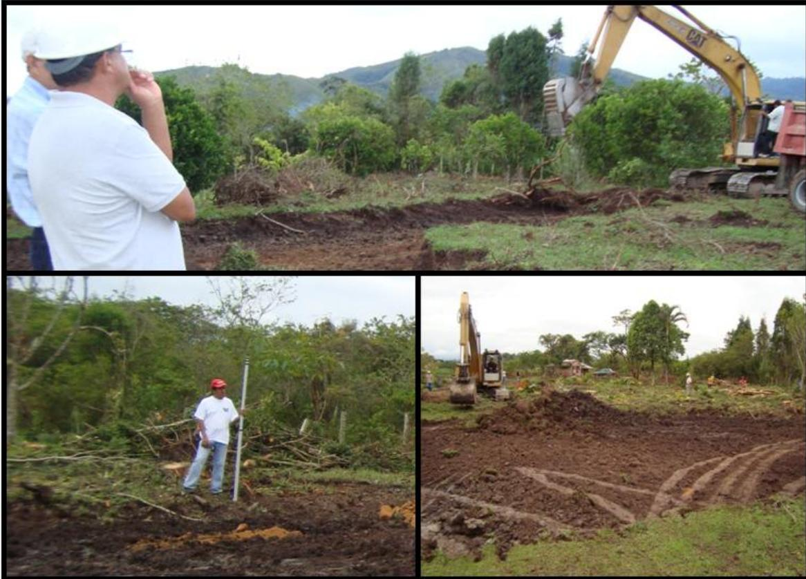
Foto 7. Descapote y conformación de terrazas.
