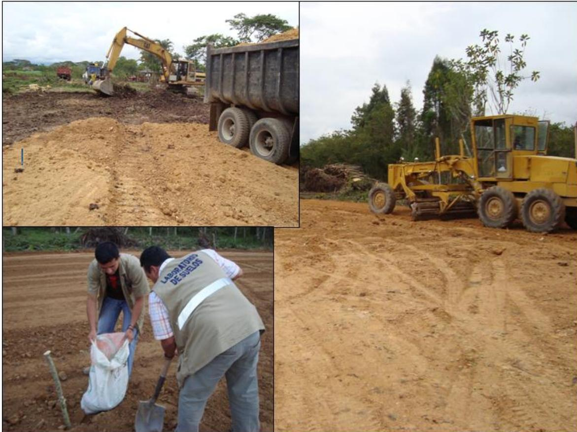
Foto 9. Conformación de terrazas, nivelación y toma de muestra.
