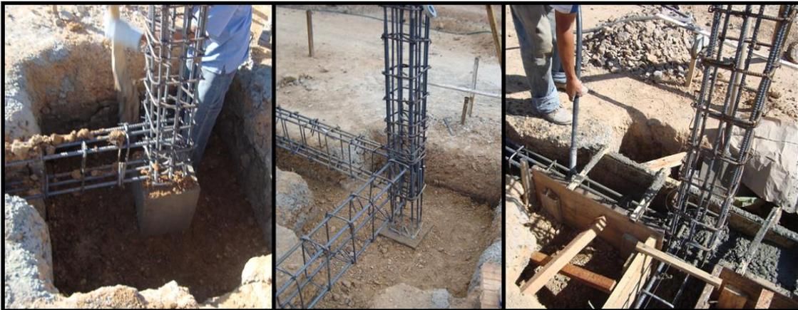
Foto 21. Proceso para la fundición de vigas de cimentación
