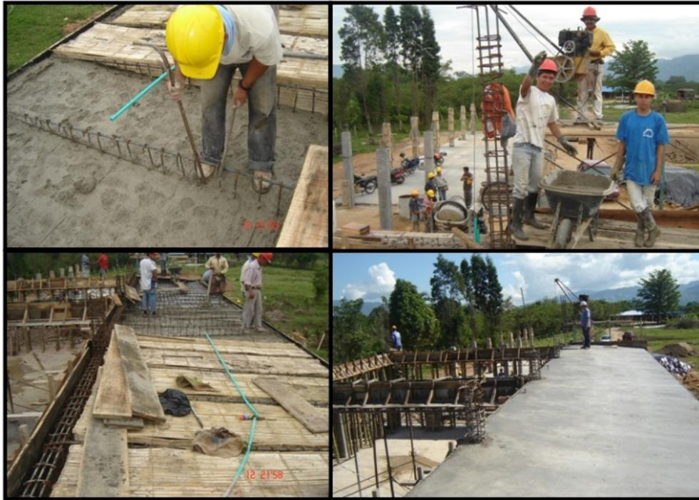
Foto 24. Conformación de losa de cubierta tipo 1
