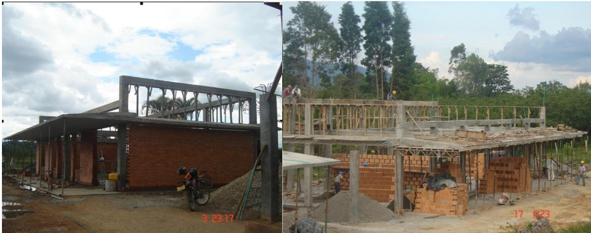
Foto 22. Detalle de estructura aporcada con mampostería no estructural
