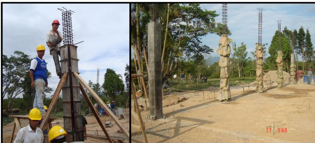
Foto 23. Vaciado y curado de columnas
