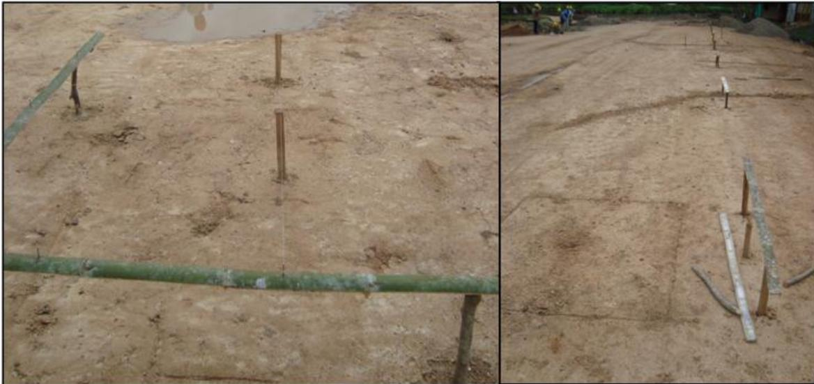
Foto 13. Replanteo con puentes en esterilla de guadua e hilos
