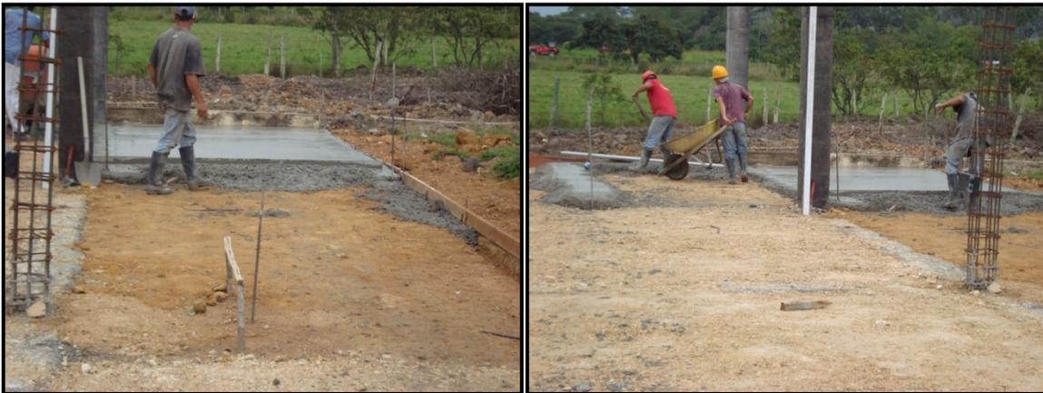
Foto 37. Fundición de placa de piso primario
