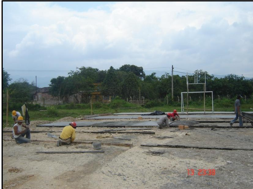
**Foto 42. Preparación y fundición de placa de polideportivo**
