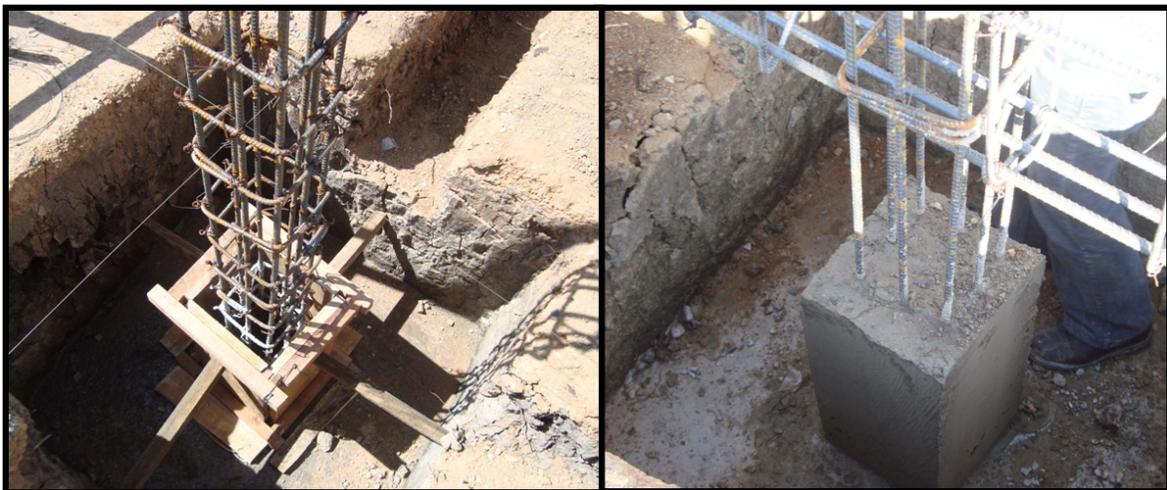
Foto 20. Fundición del pedestal
