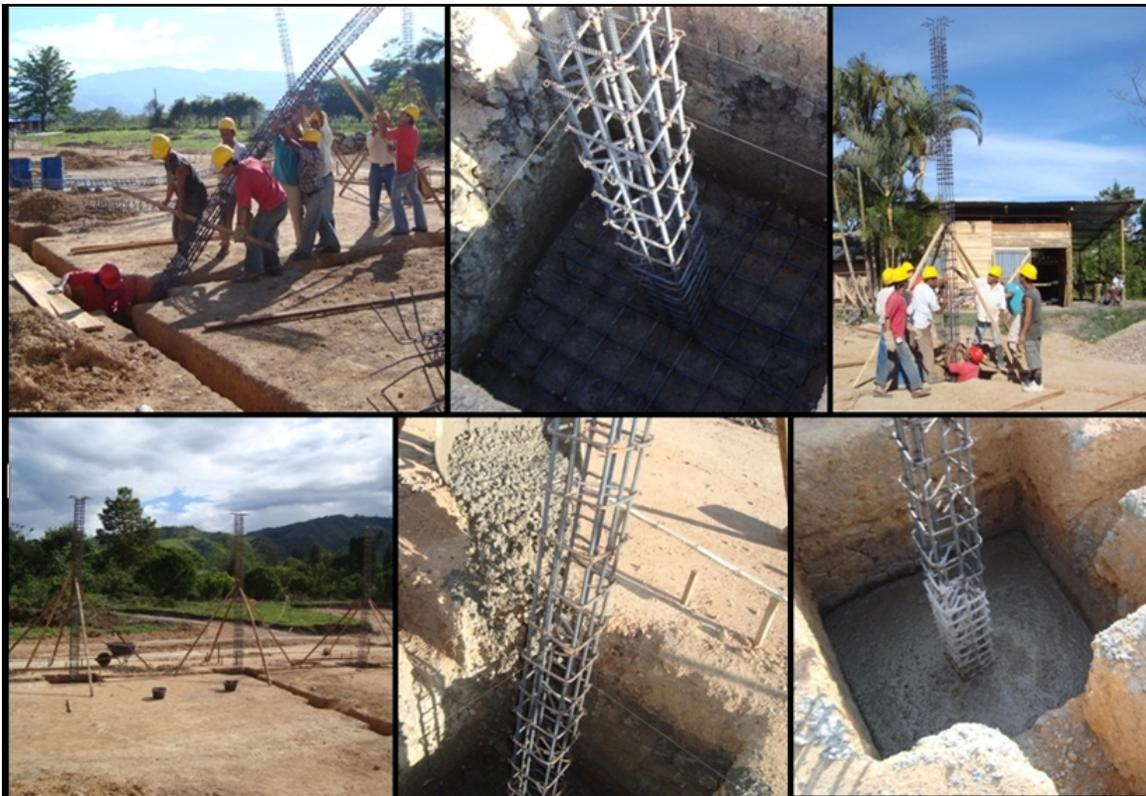
Foto 19. Proceso constructivo de vaciado de zapatas
