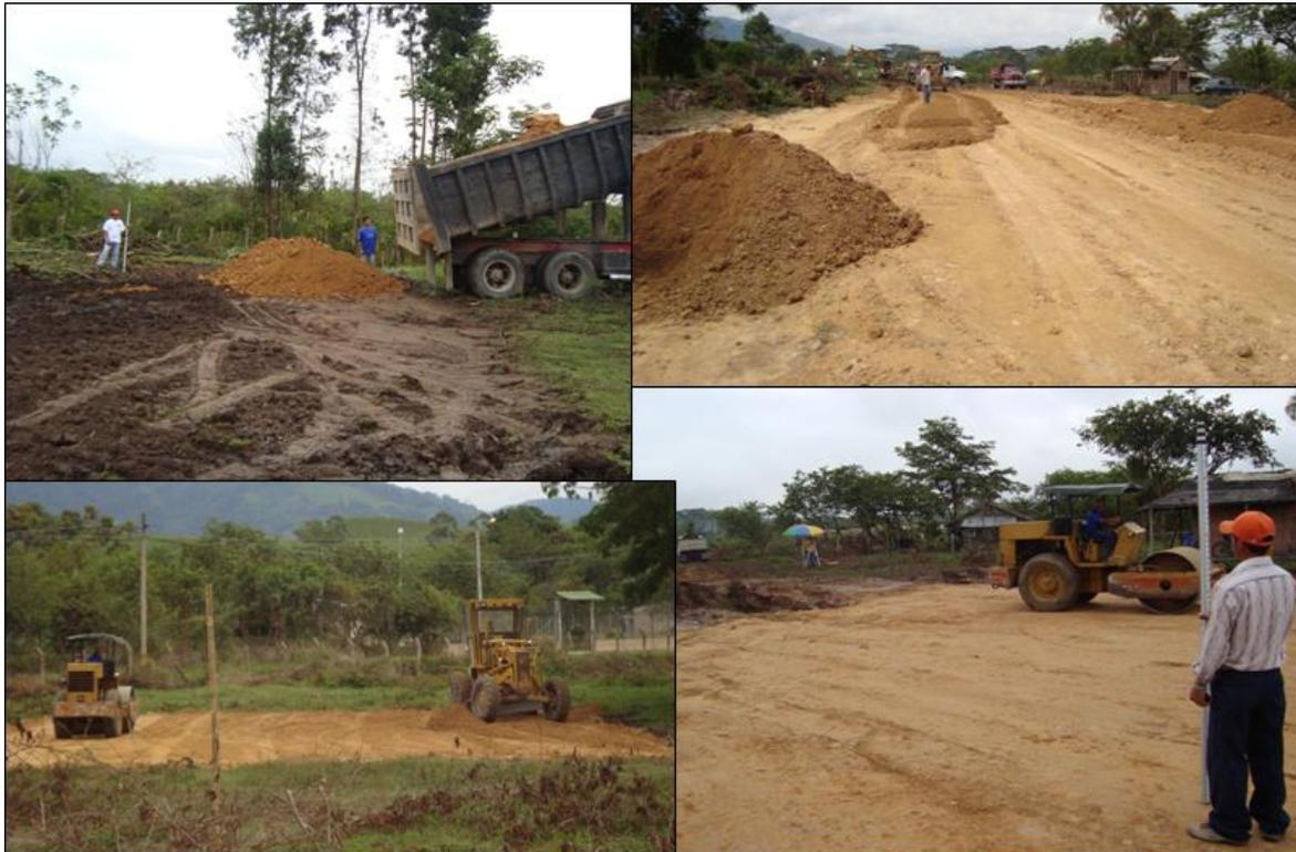
Foto 10. Conformación de terrazas y nivelación.
