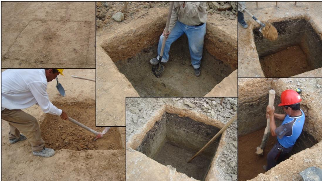
Foto 15. Proceso constructivo de zapatas
