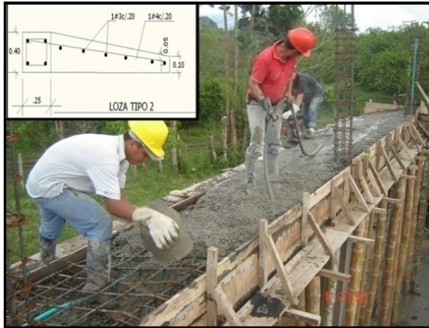
Foto 25. Conformación de losa de cubierta tipo 2
