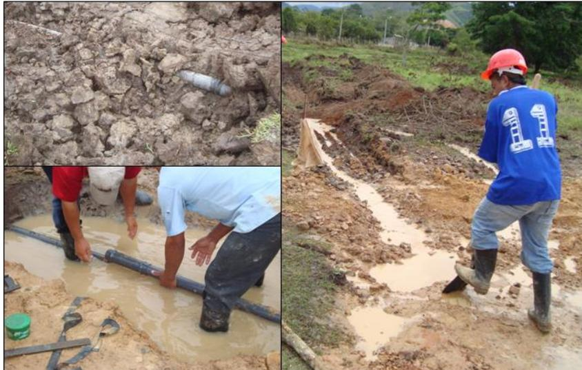
Foto 11. Reparación de tubería de acueducto.
