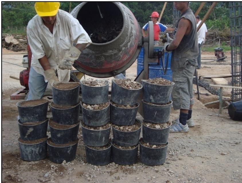
Foto 31. Medición en volumen (baldes de construcción)
