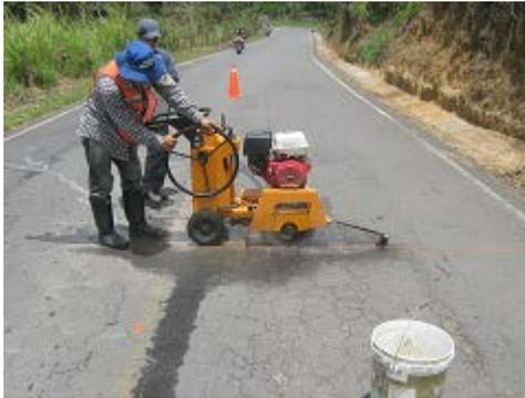
**FOTO Nº 5** Corte de Pavimento existente –
