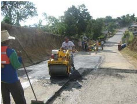
**FOTO N° 19** Compactación de mezcla asfáltica
