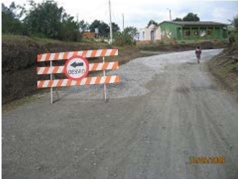
**FOTO N° 45** Señalización y Material de Sub-base extendido en carril derecho
