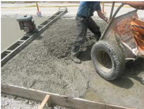
**FOTO N° 64** Vaciado del concreto
