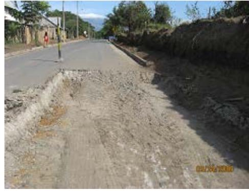
**FOTO N° 90** Excavación en el carril izquierdo
