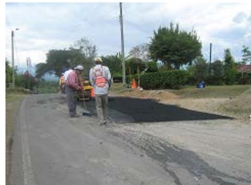
**FOTO N° 20** Compactación de mezcla asfáltica
