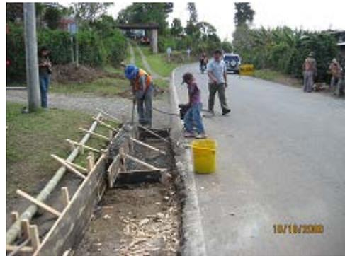
**FOTO N° 30** Fundición berma-cunetas
