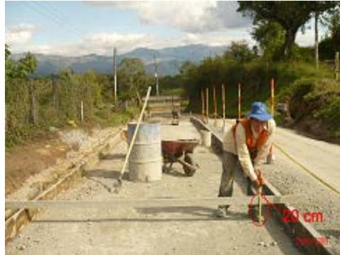
**FOTO N° 59** Verificación de espesores
