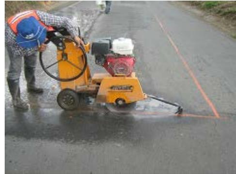
**FOTO Nº 6** Corte de Pavimento existente –
