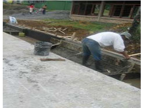
**FOTO N° 80** Nivelación del concreto
