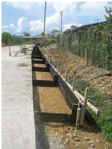
**FOTO N° 77** Superficie para construcción de andén y cunetas
