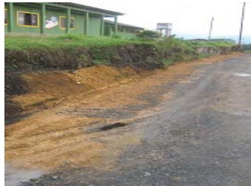
**FOTO N° 56** Rellenos para construcción de andén y berma-cuneta
