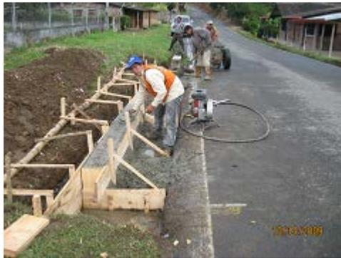
**FOTO N° 29** Fundición berma-cunetas
