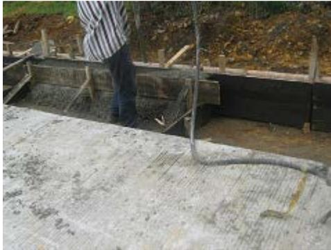
**FOTO N° 79** Vaciado del concreto
