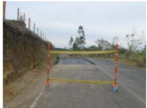
**FOTO N° 14** Imprimación con emulsión asfáltica PR01+0860-PR03+0050
