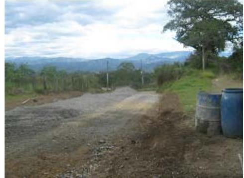
**FOTO N° 46** Material de Sub-base extendido en carril derecho
