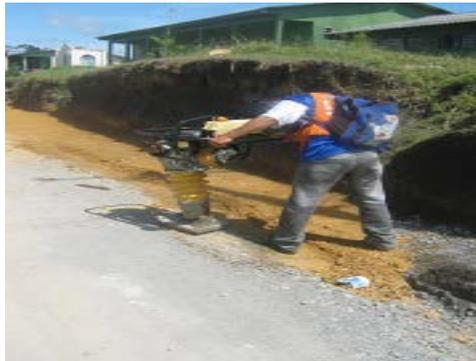
**FOTO N° 55** Rellenos para construcción de andén y berma-cuneta
