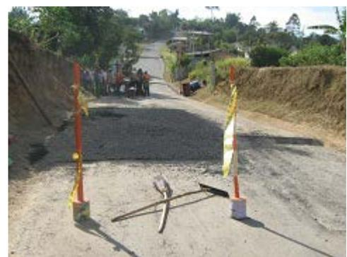
**FOTO N° 16** Extensión de mezcla asfáltica PR01+0860-PR03+0050
