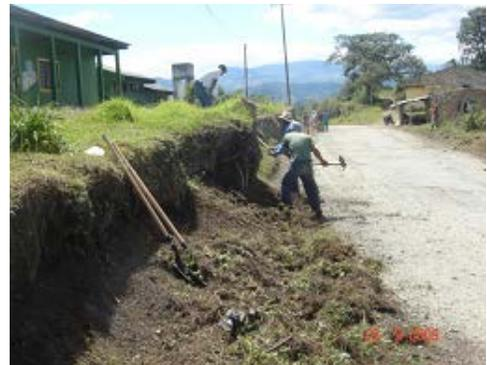
**FOTO N° 42** Perfilamiento del talud Sector Urubamba PR05+0690 al PR05+0730
