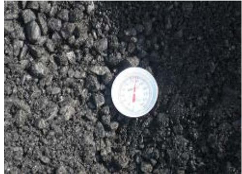
**FOTO N° 18** Verificación temperatura adecuada de la mezcla
