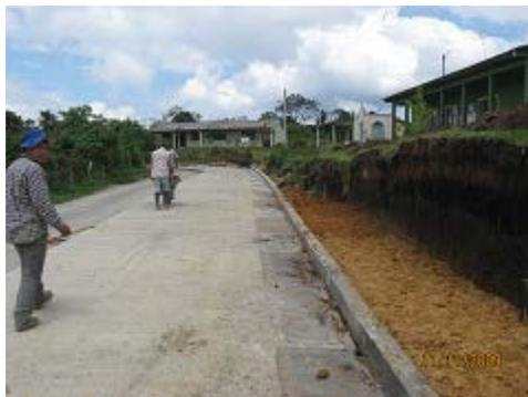
**FOTO N° 83** Relleno para la construcción de andenes
