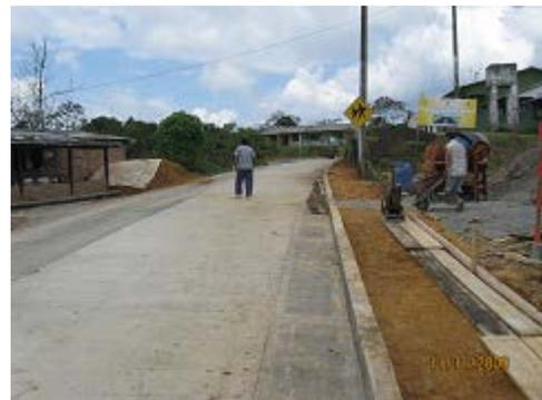
**FOTO N° 84** Relleno para la construcción de andenes
