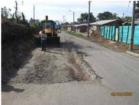
**FOTO N° 91** Excavación en el carril izquierdo
