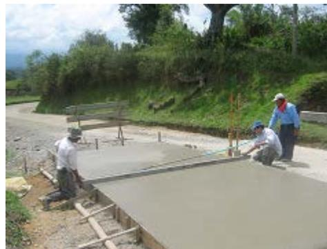
**FOTO N° 69** Nivelación del concreto
