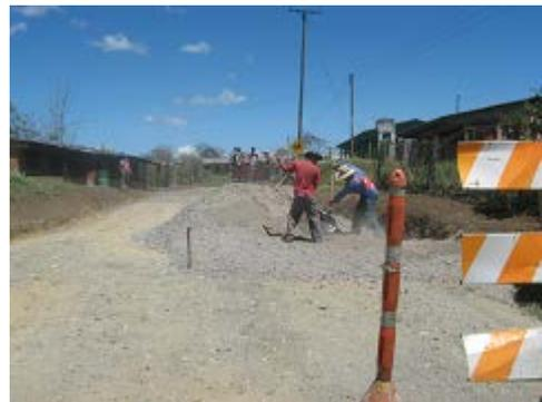
**FOTO N° 44** Acordonamiento del material para sub-base
