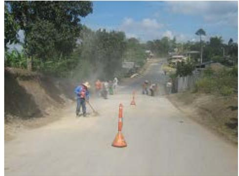
**FOTO N° 12** Limpieza de la base para bacheo, previa a la imprimación PR01+0860-PR03+0050
