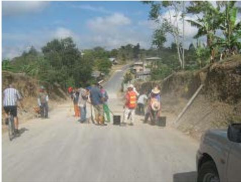
**FOTO N° 11** Limpieza de la base para bacheo, previa a la imprimación PR01+0860-PR03+0050
