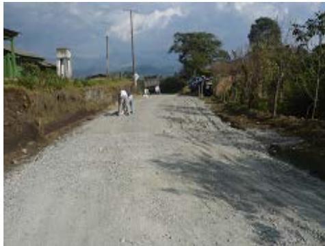
**FOTO N° 47** Material de Sub-base extendido PR05+0625 al PR5+725
