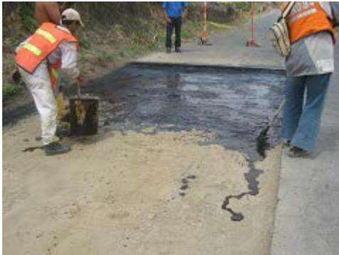
**FOTO N° 13** Imprimación con emulsión asfáltica PR01+0860-PR03+0050
