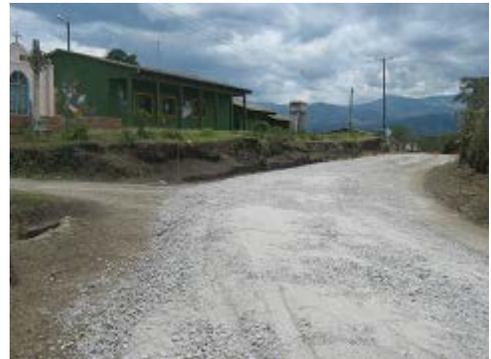
**FOTO N° 48** Material de Sub-base extendido PR05+0625 al PR5+725
