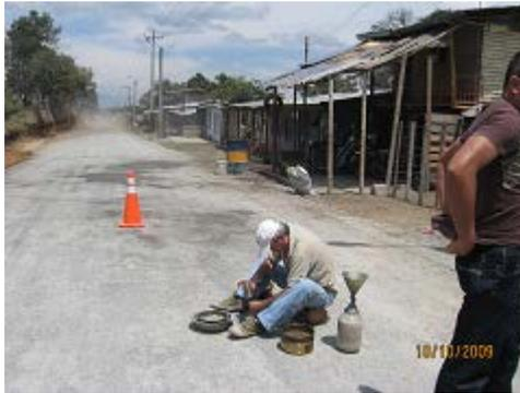
**FOTO Nº 99** Ensayos de densidades capa sub-base
