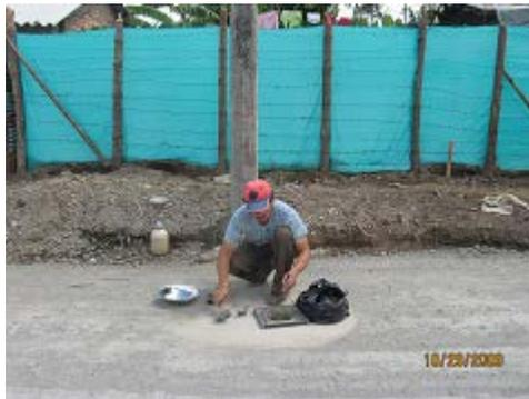
**FOTO N° 105** Ensayo de densidad, capa
