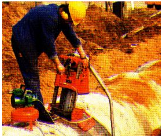
Ilustración 8. Perforación de un tubo de gres
