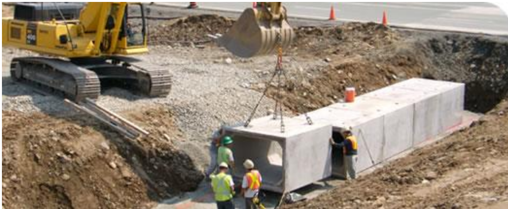
Ilustración 31. Instalación de un Box culvert prefabricado
