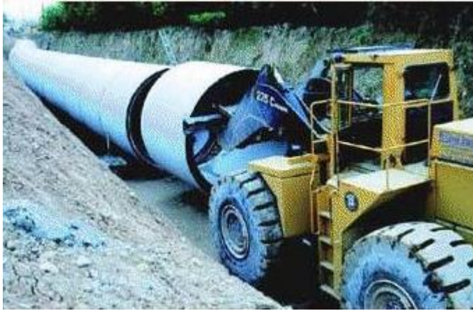
Ilustración 17. Instalación de tubería utilizando cargador
