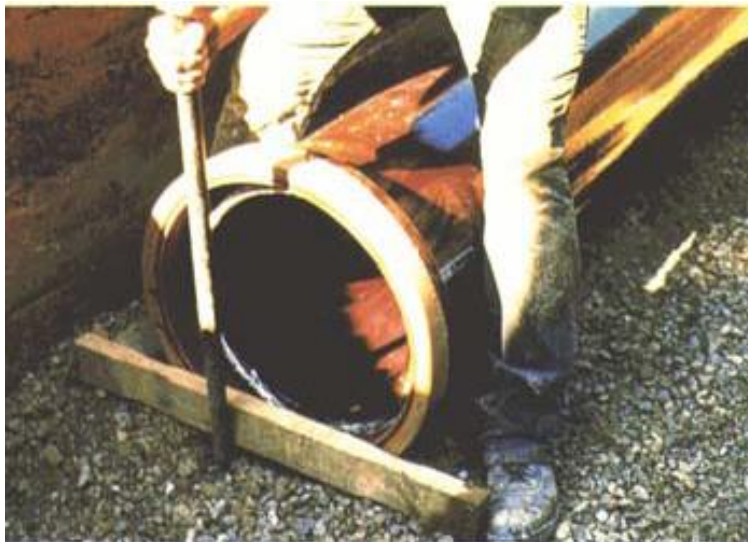
Ilustración 7. Instalación tubería de gres
