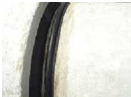
Ilustración 12. Alineación de la campana y el espigo
