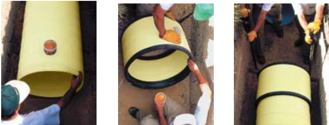
Ilustración 5. Instalación de tubería Novaloc
