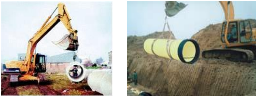
Ilustración 16. Instalación de tubería utilizando grúa o retroexcavadora
