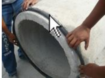
Ilustración 10. Instalación de la junta
