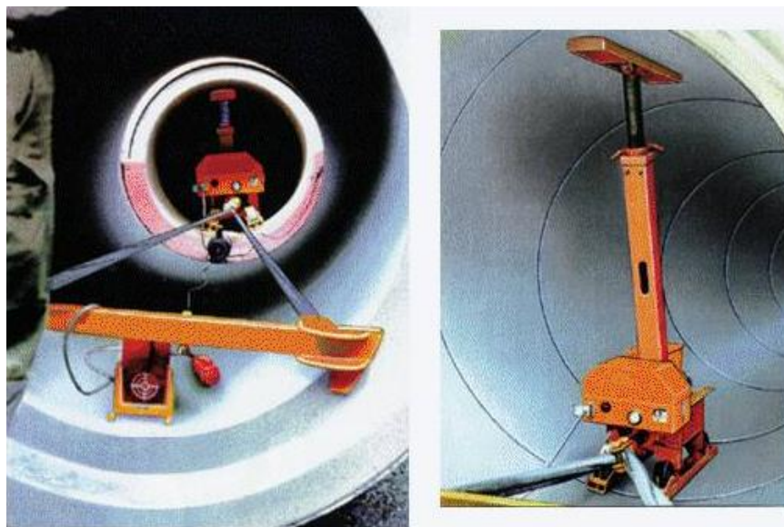
Ilustración 20. Instalación de tubería con ganchos y cadenas de montaje
