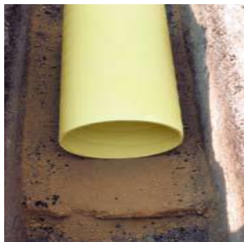
Ilustración 14. Encamado de tubería Novafort Novaloc
