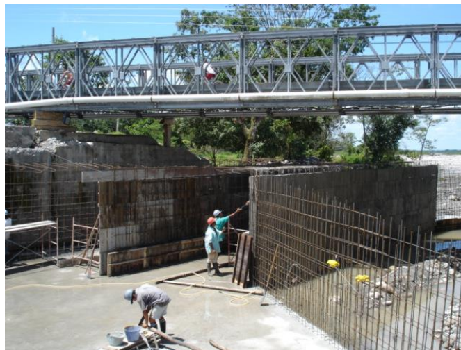
Ilustración 27. Box culvert fundido in-situ
