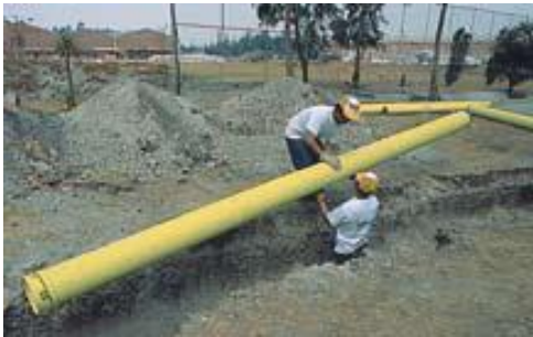
Ilustración 3. Manejo de tubería Novaloc y Novafort
