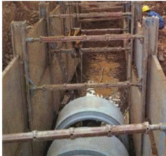
Figura 28. Entibado para instalación de tubería
