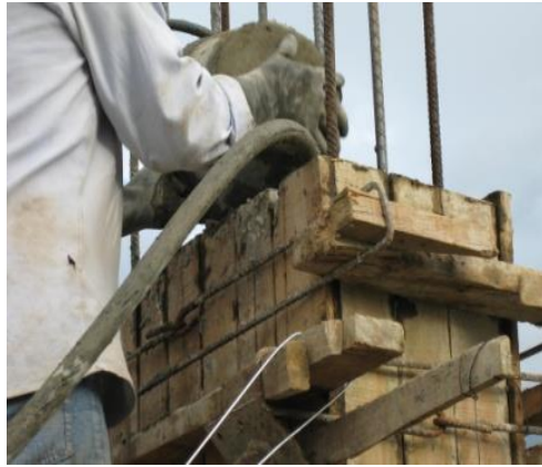
Figura 55. Vaciado del concreto
