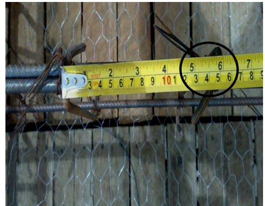
Figura 44. Separación entre ganchos
