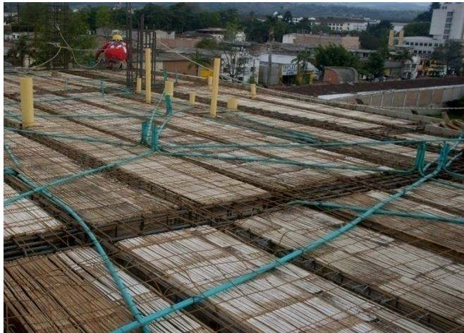
Figura 47. Limpieza de la losa antes de la fundición
