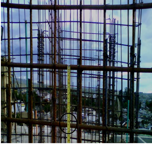
Figura 81. Separación vertical entre varillas
