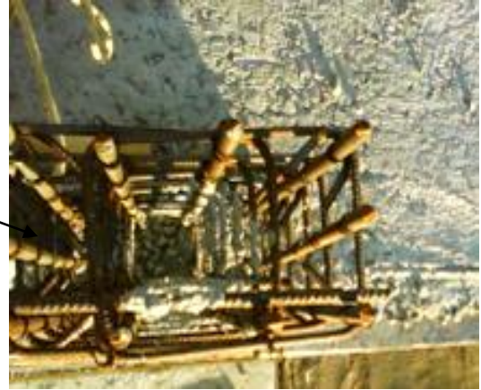
Figura 86. Columna de confinamiento C1
