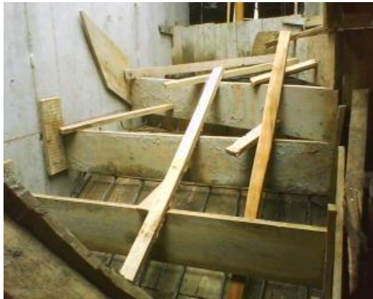
Figura 88. Encofrado para la base de las escaleras e instalación de la formaleta
