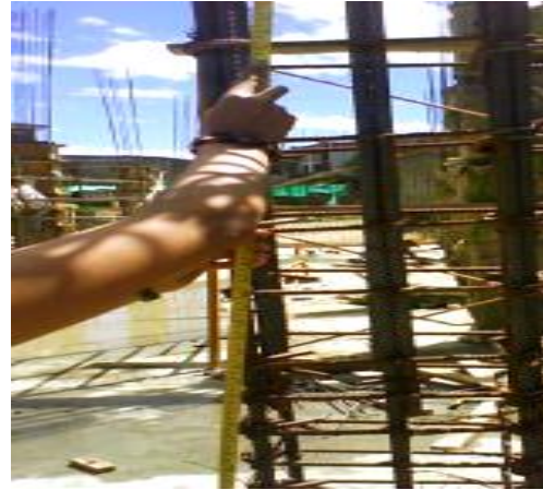
Figura 144. Longitud de traslapo
