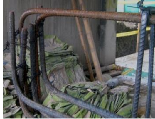
Figura 103. Gancho de viga
