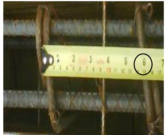
Figura 94. Corrección de la separación
