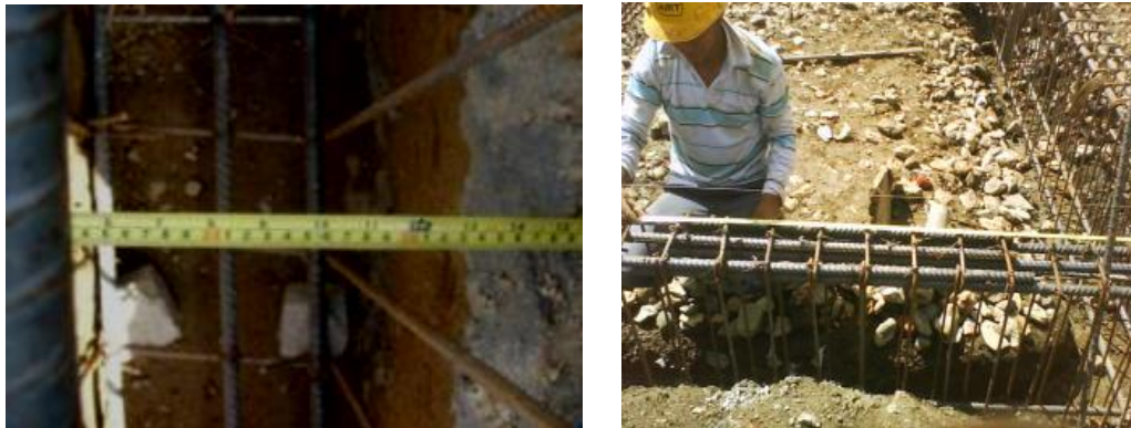
Figura 111. Verificación de las dimensiones de la excavación
