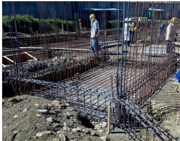
Figura 109. Cimentación torre C
