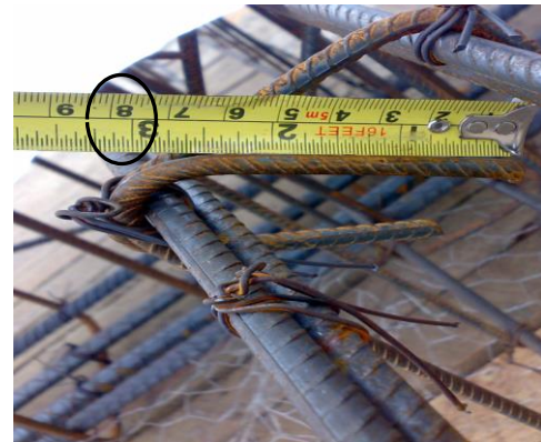
Figura 31. Longitud gancho de estribo
