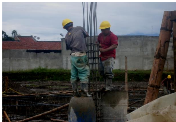
Figura 52. Colocación de los estribo
