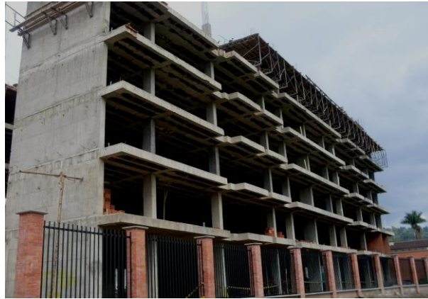
Figura 12. Estado inicial de la obra
