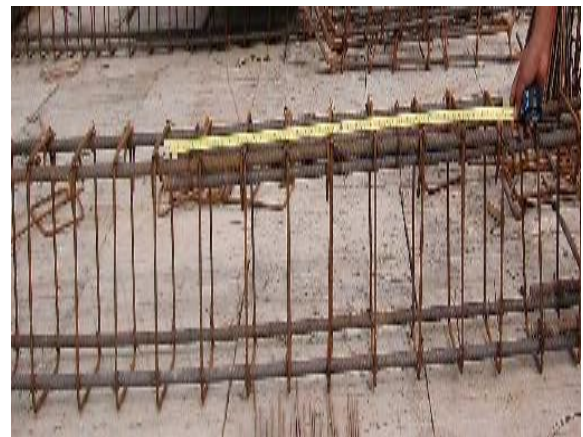
Figura 27. Medida del traslape
