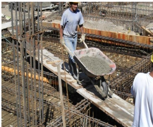
Figura 48. Transporte del concreto a la losa
