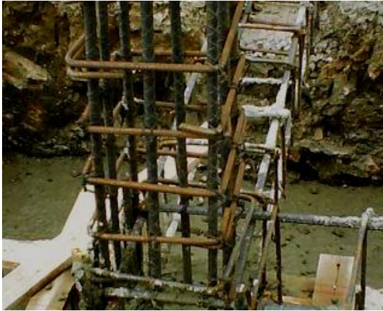
Figura 143. Distribución de los estribos
