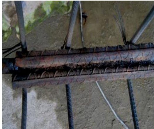
Figura 107. Traslapo con soldadura
