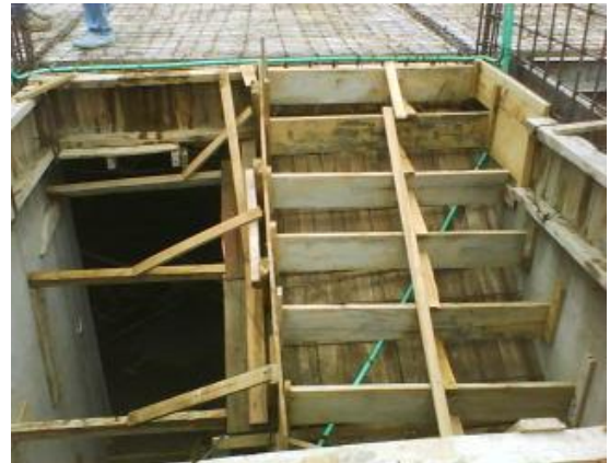
Figura 88. Encofrado para la base de las escaleras e instalación de la formaleta
