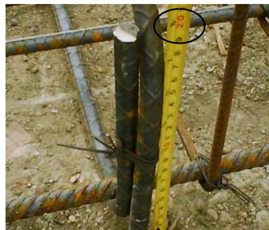
Figura 138. Longitud del gancho de la zapata
