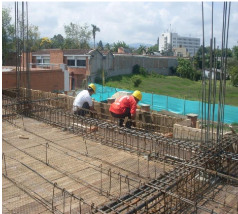
Figura 21. Refuerzo de las vigas de borde Figura 22. Colocación de los estribos por grupos
