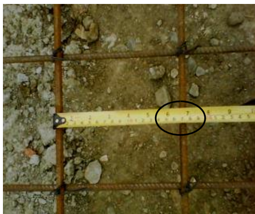
Figura 129. Separación de las varillas de refuerzo
