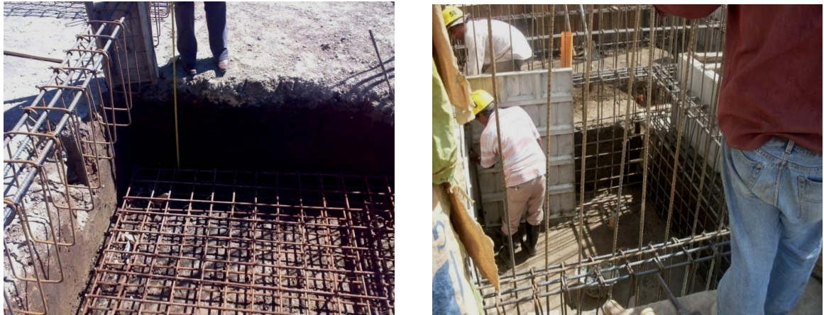
Figura 75. Armado del refuerzo e instalación de la formaleta
