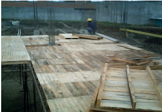
Figura 20. Limpieza de la formaleta
