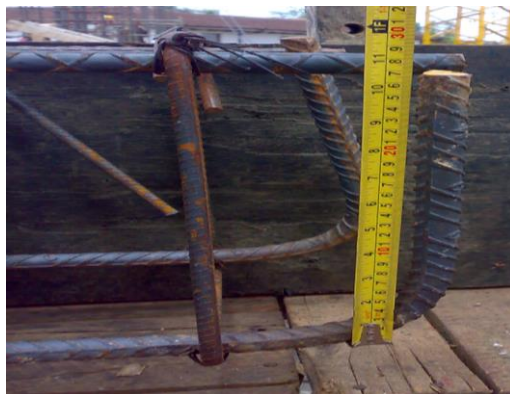
Figura 30. Longitud gancho de viga
