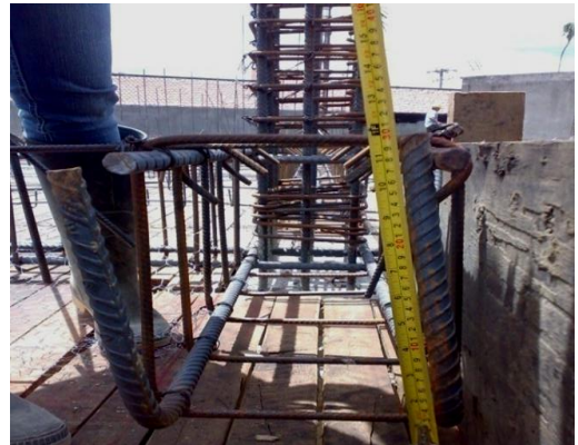
Figura 39. Longitud gancho de viga
