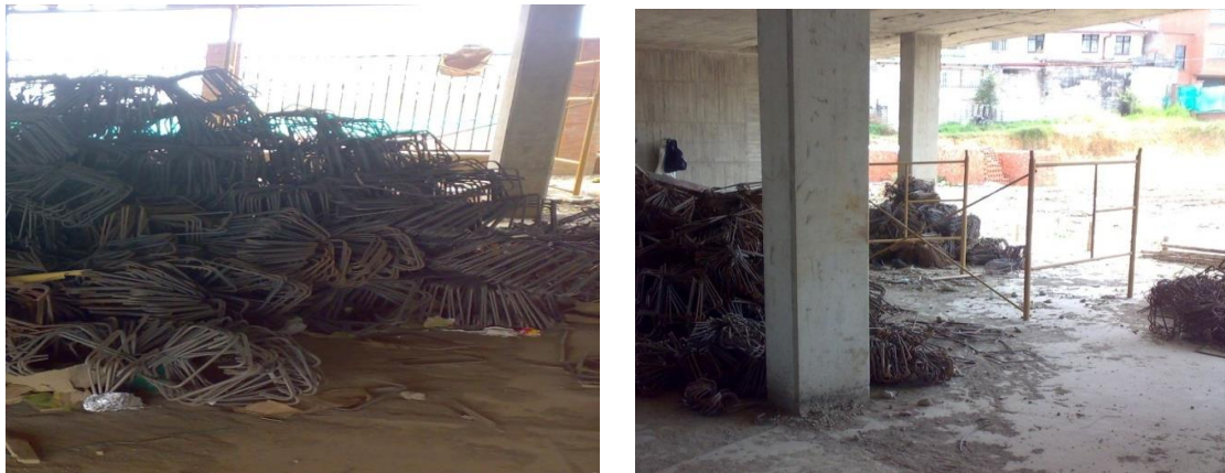
Figura 14. Almacenamiento del acero bajo techo de concreto
