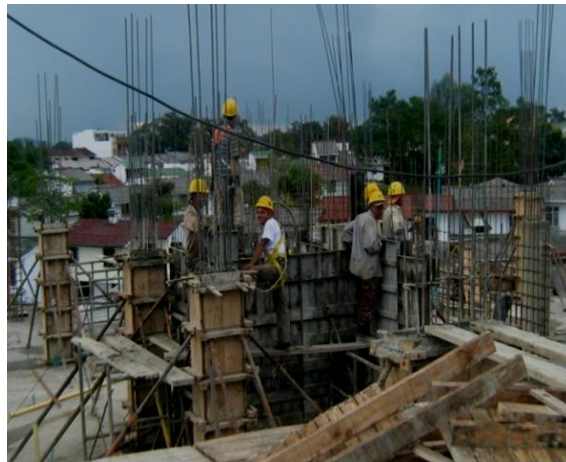
Figura 76. Compactación por vibración interna
