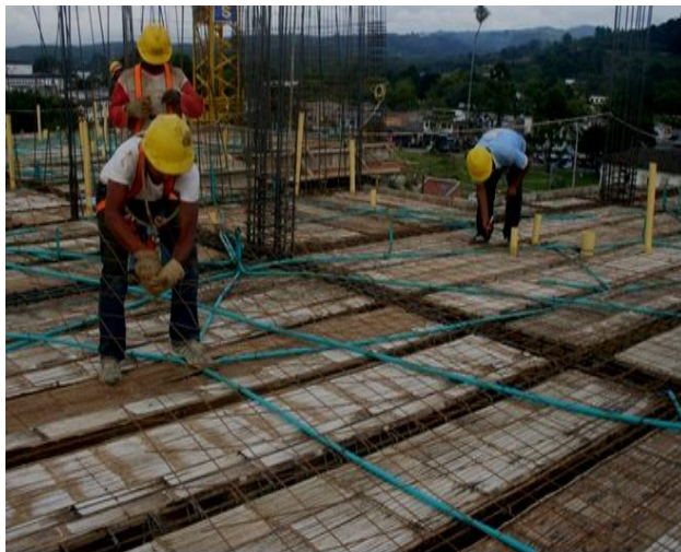
Figura 87. Colocación del acero de temperatura
