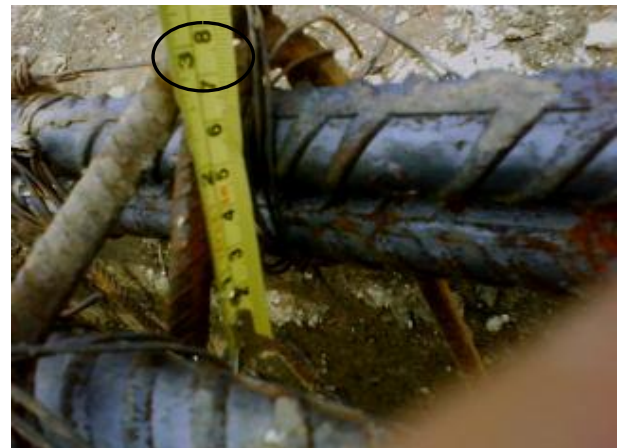
Figura 115. Longitud del gancho
