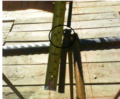
Figura 99. Longitud del gancho
