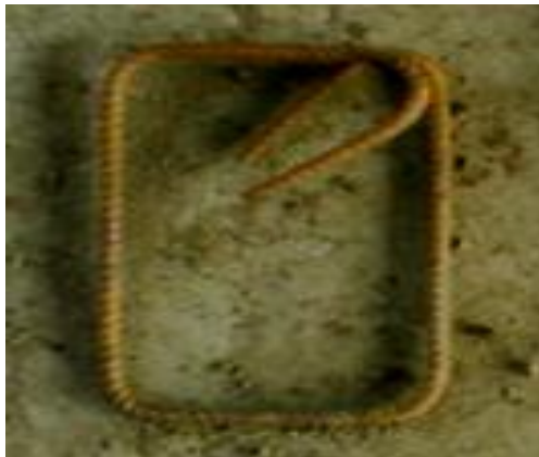
Figura 79. Forma del estribo
