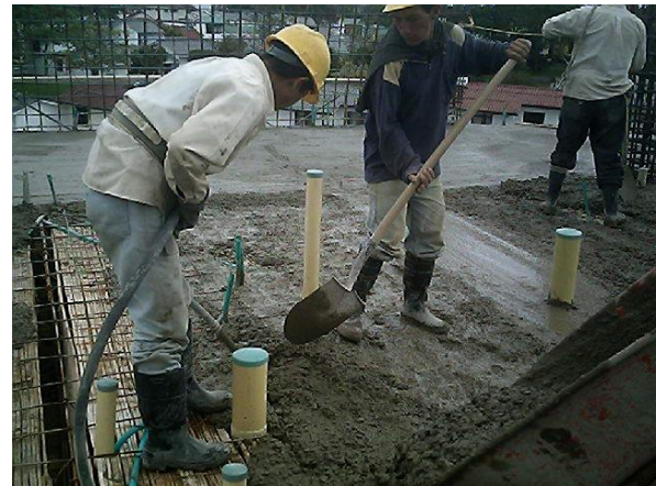
Figura 49. Vaciado del concreto en el sitio requerido
