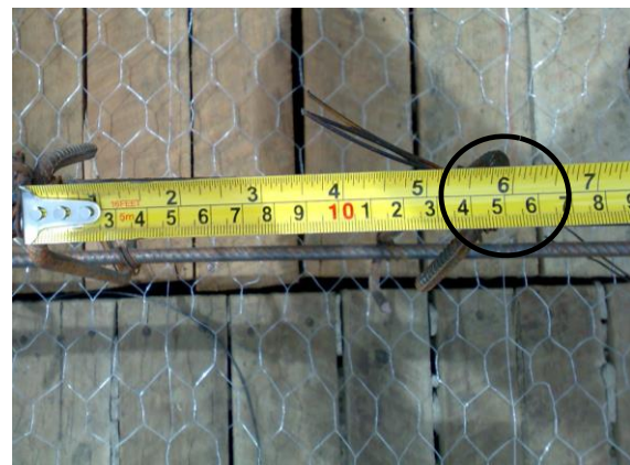
Figura 46. Separación entre ganchos
