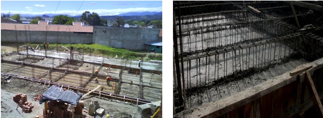
Figura 110. Vigas de cimentación
