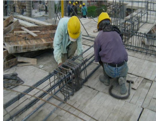
Figura 21. Refuerzo de las vigas de borde Figura 22. Colocación de los estribos por grupos
