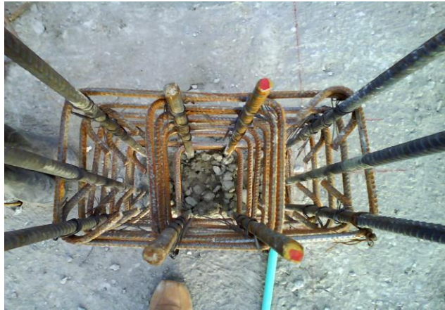
Figura 60. Armado de estribo
