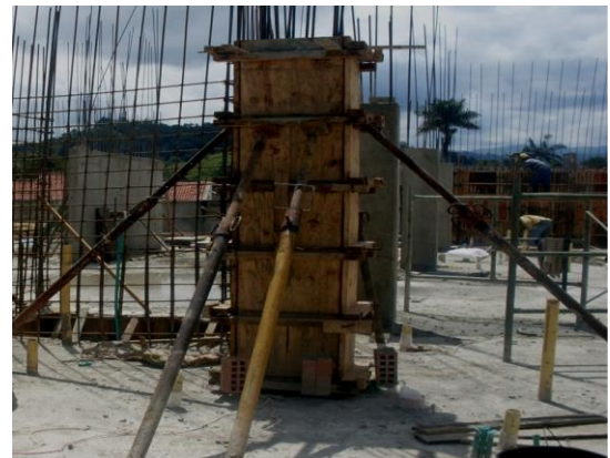
Figura 54. Formaleta de la columna
