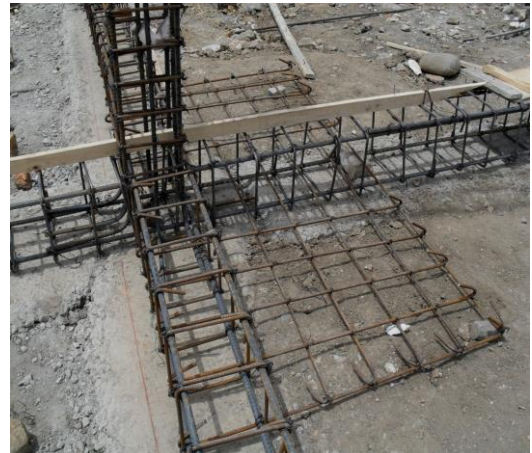
Figura 132. Refuerzo de la zapata
