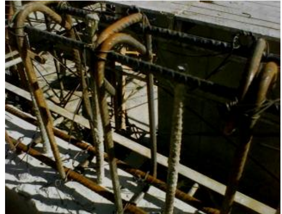
Figura 92. Armado de viga
