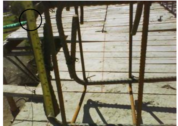
Figura 97. Longitud del gancho de la viga
