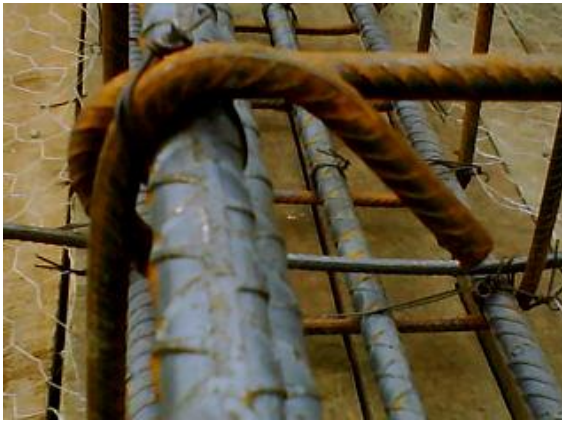
Figura 24. Gancho de los estribos
