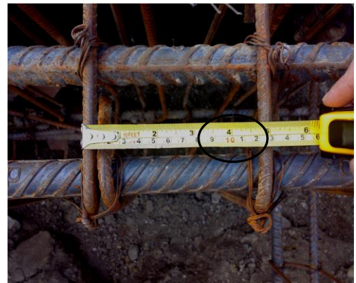
Figura 119. Corrección de la separación
