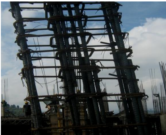
Figura 61. Longitud de traslazo
