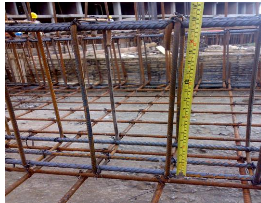
Figura 123. Altura de zapata
