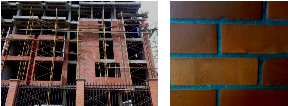
Figura 7. Ladrillo a la vista
