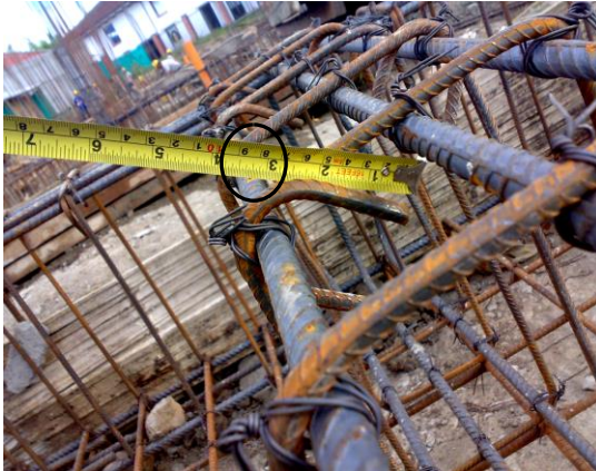
Figura 120. Longitud del gancho
