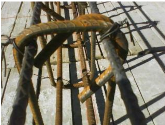
Figura 98. Gancho de estribo
