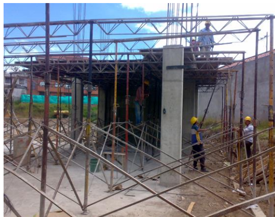
Figura 19. Formaleta para la losa
