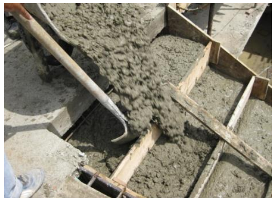
Figura 89. Colocación del acero de refuerzo y vaciado del concreto
