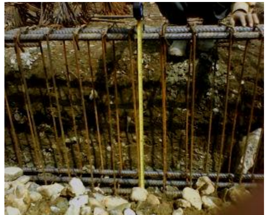
Figura 113. Altura de zapata
