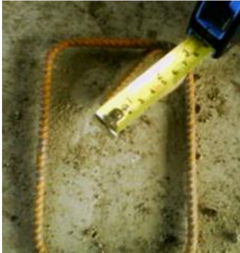
Figura 63. Longitud del gancho
