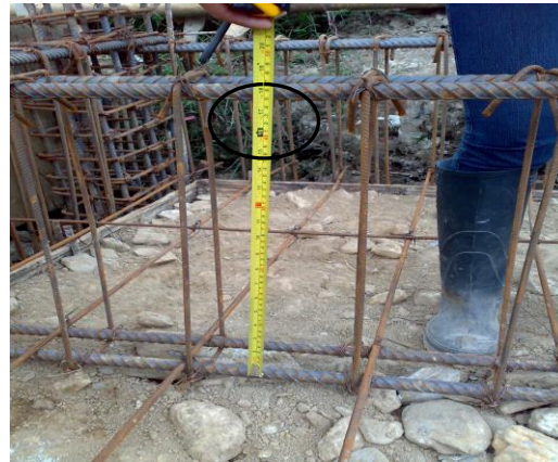
Figura 117. Altura de zapata
