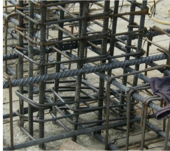
Figura 66. Armado de columna
