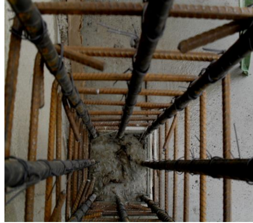
Figura 140. Colocación de estribos
