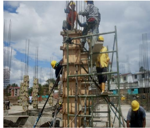
Figura 56. Compactación por vibración interna
