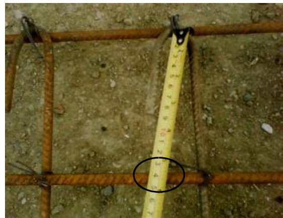
Figura 130. Longitud del gancho
