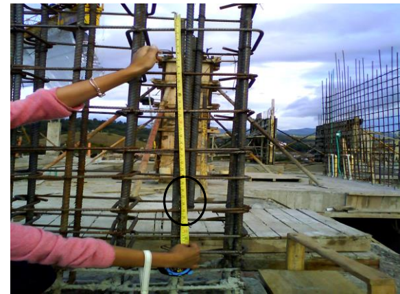
Figura 84. Traslapo vertical
