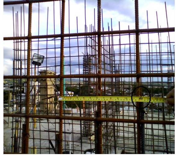
Figura 82. Separación horizontal entre varillas
