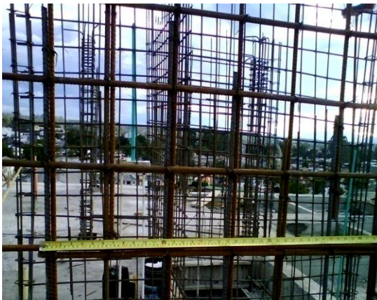
Figura 83. Traslapo horizontal
