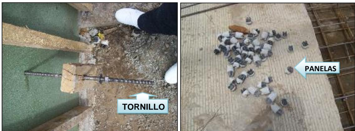
Las formaletas tenían unos orificios por los cuales se pasaban unos tornillos de lado y lado de la viga, sin afectar el recubrimiento del la estructura de acero (figura 14 izq.). El recubrimiento del acero se hizo con panelas prefabricadas, por medio de los ganchos que estas presentan se fijaron en la varillas.
