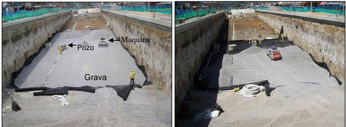
En la figura 42 se muestra finalmente como queda el material mejorado que es puesto después de la ubicación del geotextil, para después ubicar la sub-base.
