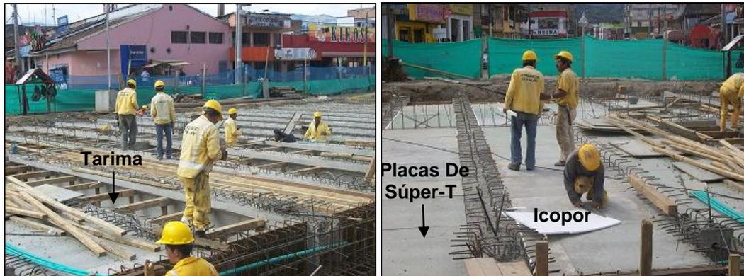
De esta manera se hizo una tarima provisional de madera, que resistiera el peso del concreto y a su vez fuera removible verificando que esta tuviera el nivel requerido en la losa, lo cual era muy importante a la hora del empalme con la antigua vía (figura 27).
