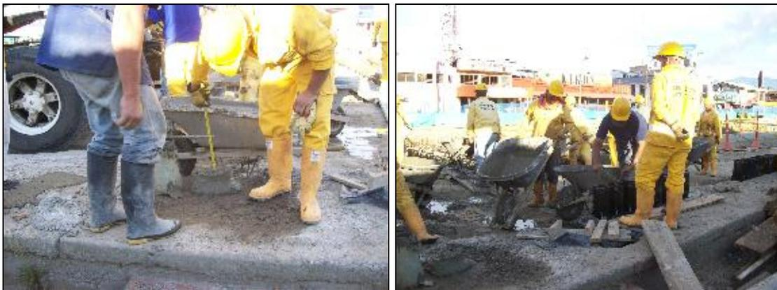
Cuando llega el mixer a la obra se realizaba el ensayo de asentamiento con el fin de autorizar por parte de Interventoría la fundición de las vigas, se tomaban 8 cilindros con el fin de observar la resistencia requerida por el diseñador garantizando la calidad de las vigas (ver figura 19).
