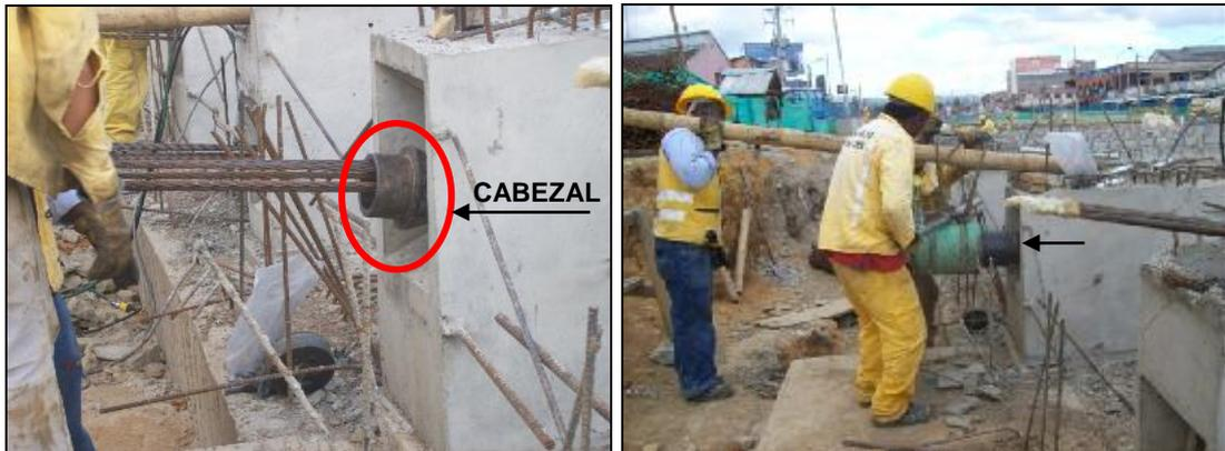
Con las vigas ya referenciadas se seleccionaba la que se deseaba tensionar, de esta manera se procedía a armar el equipo que se necesitaba para el tensionamiento. Este proceso consistía en ubicar una araña de acero que tenía unos orificios por los cuales iban a pasar los cables a tensionar, se ubicó el cabezal sobre la araña (figura 23 izq.), se ubicó el gato hidráulico en el cabezal (figura 24.) y finalmente se ubicó una araña en la parte final del gato hidráulico.
