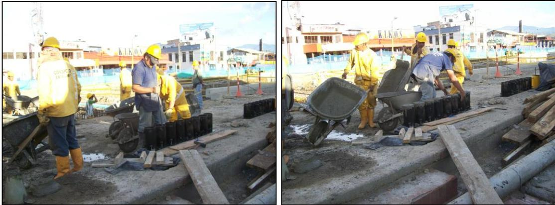
En la figura 21 se puede observar que se construyó una tarima provisional para dar paso al bugui con concreto, con el fin de tener una uniformidad a la hora de la evacuación de la mezcla en la estructura.
