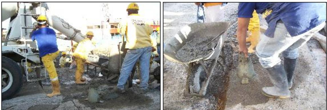
Para verificación del control adecuado de la calidad del concreto fue necesario realizar una serie de ensayos y tomar muestras en presencia de la Interventoría (ver figura 17), para medir la resistencia a la compresión del hormigón. Se supervisó los ensayos y muestras tomadas, tal como se describen a continuación.
