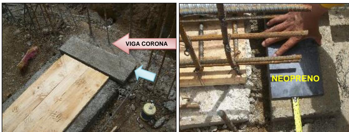
Los neoprenos (figura 11) son apoyos elastoméricos utilizados en Puentes o Estructuras elevadas, los cuales permiten la transferencia uniforme de cargas en la estructura, movimiento debido a la dilatación y contracción térmica del
