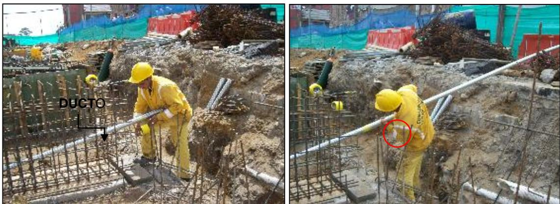
Por cada viga se utilizaron 12 ductos; estos tenían de longitud de 5m y un espesor de 5cm, para la formación de cada ducto se utilizaron 3 ductos, los cuales eran empalmados con una cinta de color amarillo (ver figura 12) especial para unirlos. En la sección terminal del ducto se ubico un cabezal (ver figura 13) el cual se unió con una sección del ducto corto para después unirlo a la sección larga, esto se realizó a lado y lado de la viga.
