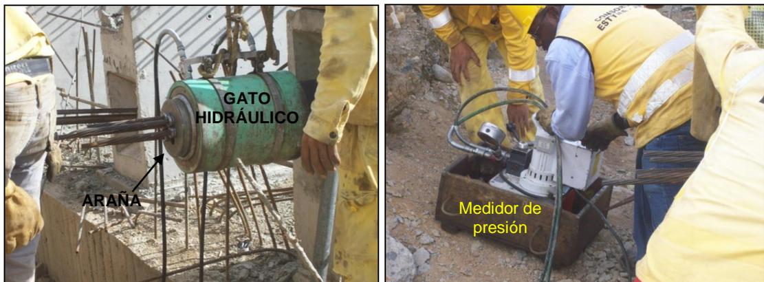
Se ubicó una cuña en los cables con el fin de no permitir que al tensionar estos se regresen. Se seleccionó un cable testigo para chequear el tensionamiento de los otros cables, midiéndolo como se observa en la figura 25 der. Una vez verificado la calibración el medidor de presión este se conectó al gato hidráulico
