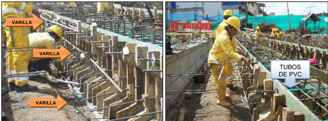
Los tubos de PVC (figura 15 der.) funcionaron como pasadores de los tornillos que ajustaban las formaletas, una vez fundidas las vigas, los tornillos removibles (56 en total) eran retirados con el fin de usarlos nuevamente, 40 tornillos ubicados en la parte inferior no se quitaban.
