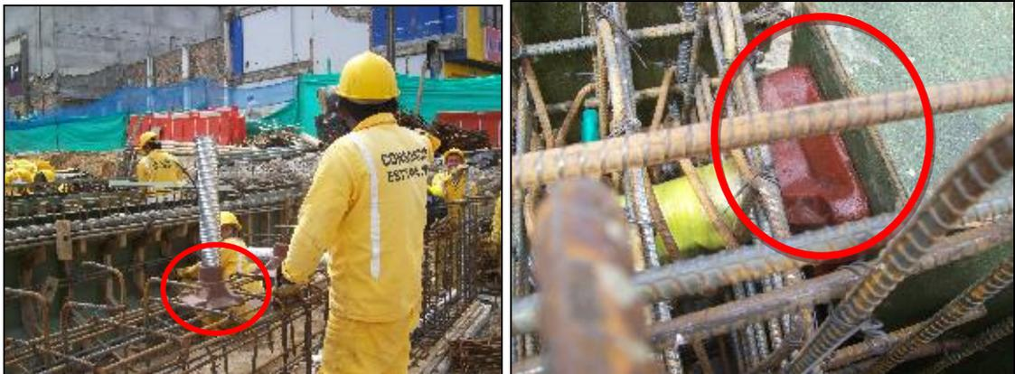
La función del cabezal era darle entrada a los aceros que se ubicaran dentro de este para el respectivo tensionamiento después de fundido.
