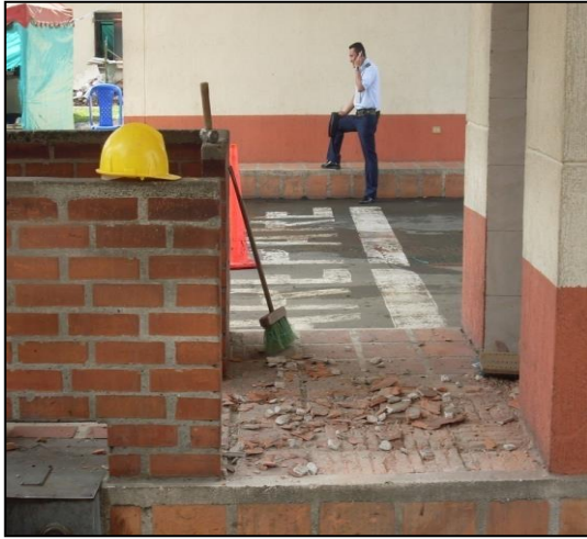
Imagen 48. Demolición de pisos en guardia vehicular
