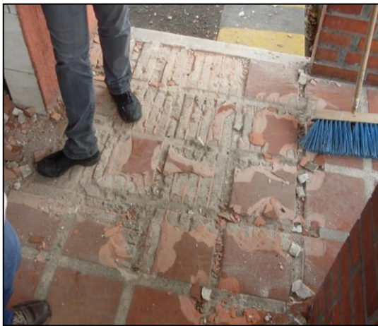
Imagen 50. Demolición de pisos
