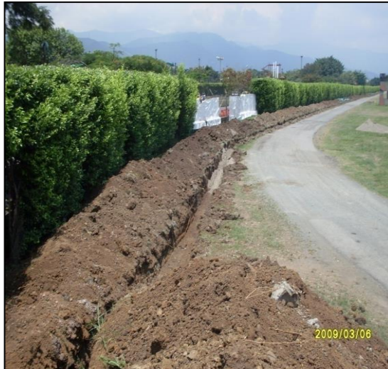
Imagen 62. Excavación en el perímetro de la base
