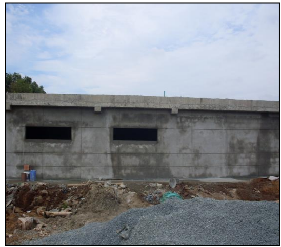
Imagen 6. Pañete de fachada
