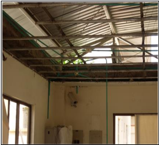
Imagen 23. Desmonte de cubierta módulo peatonal
