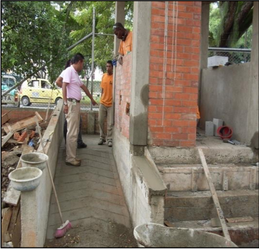
Imagen 36. Fundición de escalera
