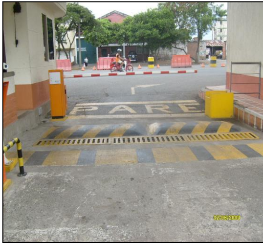
Imagen 52. Resaltos de salida terminados con pintura de tráfico amarillo y negro
