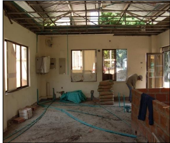
Imagen 25. Armado de tuberías para instalaciones y puntos eléctricos tanto aéreos como de nivel de piso
