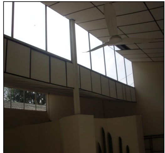
Imagen 58. Instalación de ventanería en aluminio
