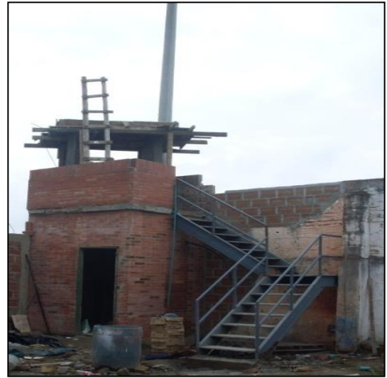
Imagen 46. Fundición de cubierta en concreto macizo
