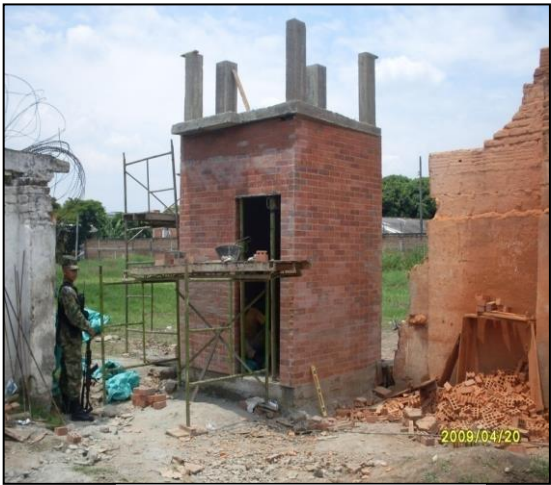
Imagen 44. Terminación de mampostería en el primer piso
