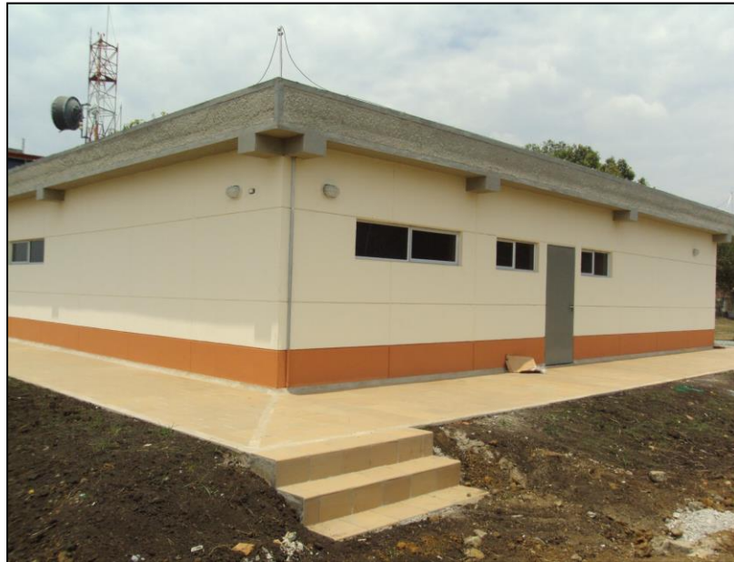
Imagen 21. Central de cámaras totalmente terminada
