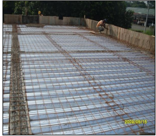
Imagen 4. Instalación de steel deck para el desarrollo general de la cubierta
