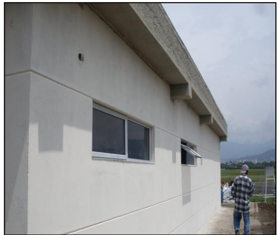
Imagen 10. Instalación de ventanería en aluminio
