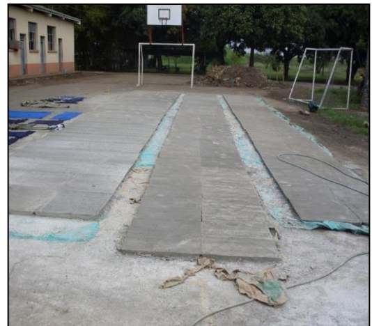
Imagen 65. Fundición de tapas de cajas en concreto
