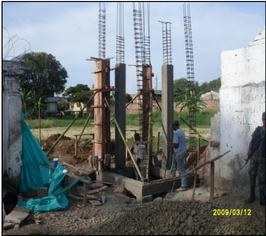
Imagen 41. Armada de columnas en garita gruse-7
