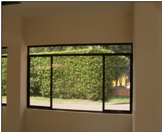
Imagen 30. Ventanería en lámina instalada
