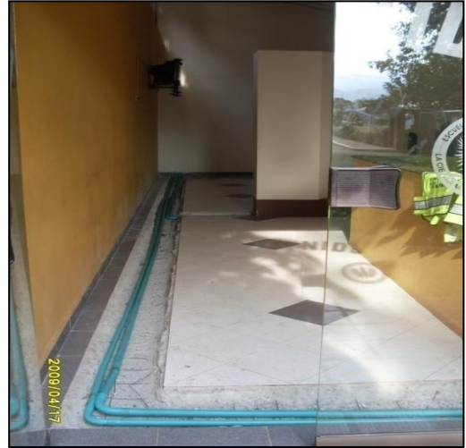
Imagen 56. Regatas para tuberías y caja eléctricas
