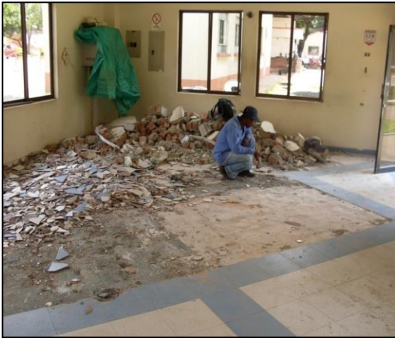
Imagen 22. Demolición de pisos módulo peatonal
