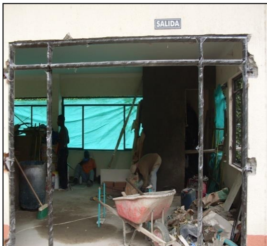
Imagen 26. Adecuación de vanos de puertas
