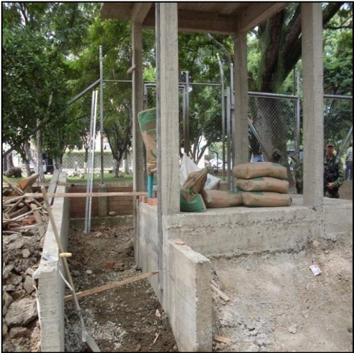
Imagen 34. Preparación de formaleta para la fundición de rampa
