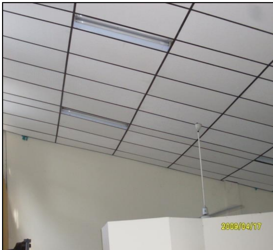
Imagen 57. Instalación de cielo raso
