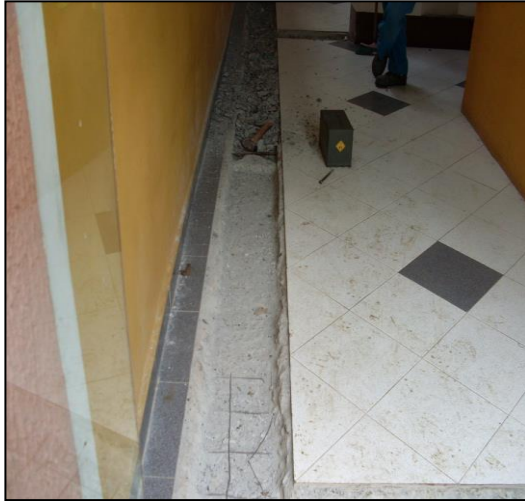
Imagen 55. Demolición de piso en despacho de aeronaves
