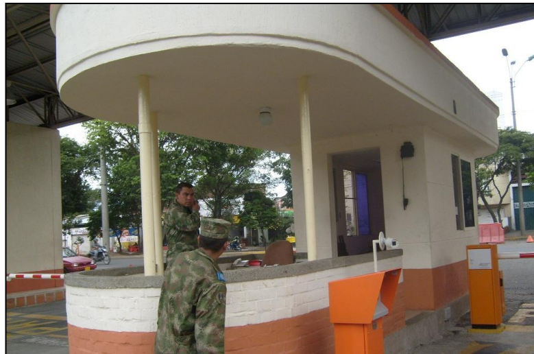
Imagen 54. Guardia vehicular totalmente terminada
