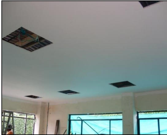
Imagen 28. Instalación de cielo raso en dry wall
