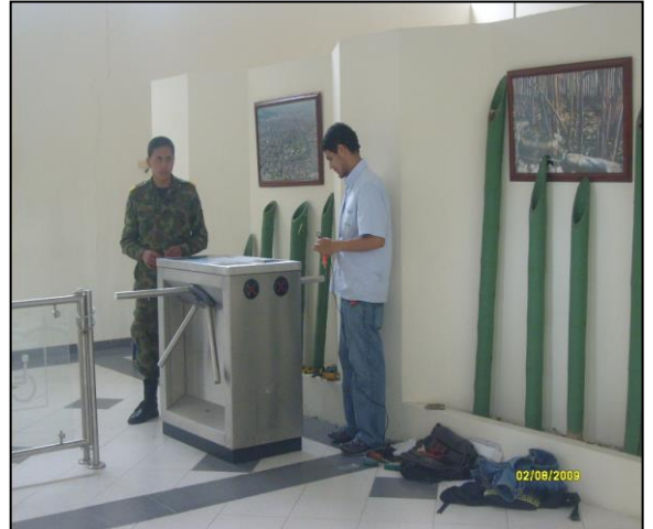
Imagen 60. Instalación del molinete de acceso
