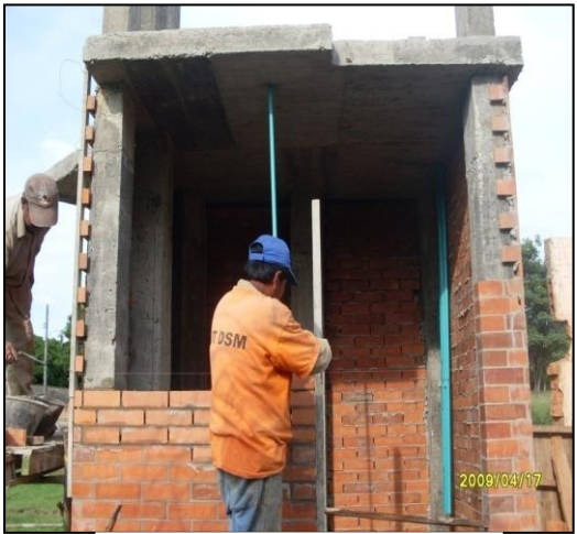
Imagen 43. Desarrollo de mampostería
