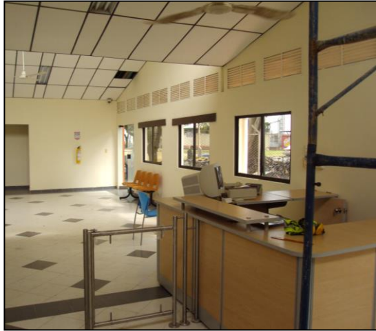
Imagen 59. Instalación de mueble en zona de atención
