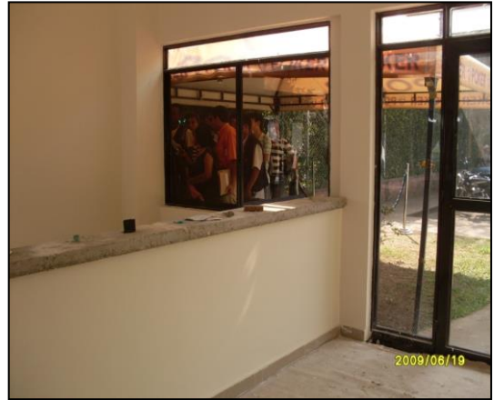
Imagen 29. Acabado del muro divisorio
