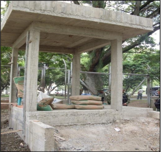
Imagen 35. Cubierta fundida en concreto macizo
