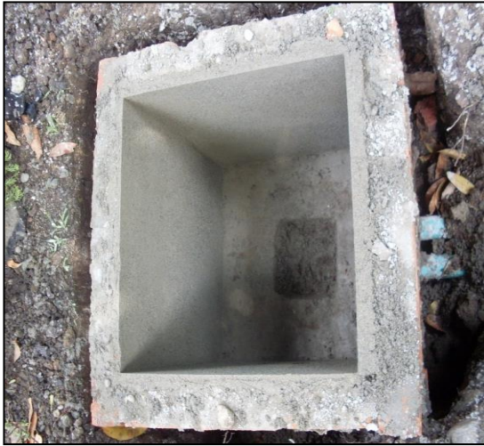
Imagen 66. Caja de registro pañetada
