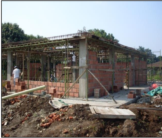
Imagen 3. Desarrollo de mampostería y armada de vigas aéreas
