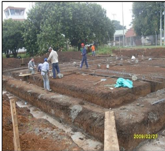
Imagen 1. Desarrollo de la cimentación de la central de cámaras
