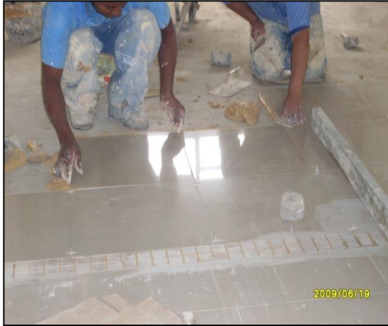
Imagen 7. Enchape de piso en porcelanato brillante y con cenefa de cuadrícula para la sección de oficinas
