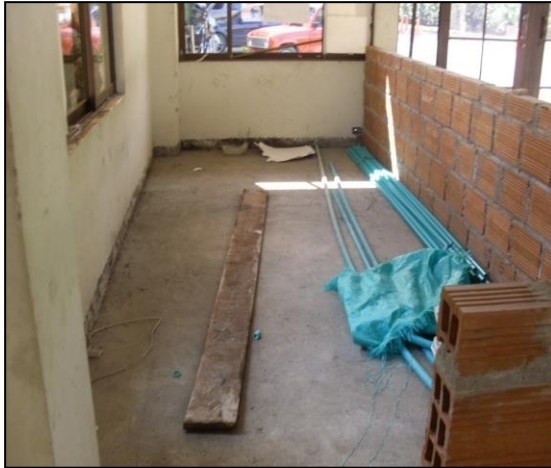
Imagen 24. Construcción del muro divisorio de la zona de atención al usuario
