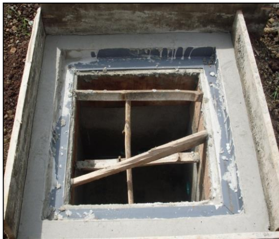
Imagen 64. Fundición de los marcos de las cajas de registro
