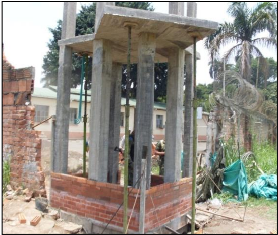
Imagen 42. Inicio de mamposterías, fundición de columnas
