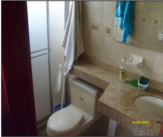
Imagen 15. Baño del cuarto de alojamiento en su estado final
