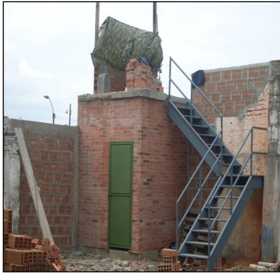
Imagen 45. Inicio de mampostería segundo piso e instalación de escalera
