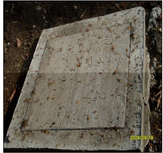
Imagen 67. Caja de registro terminada
