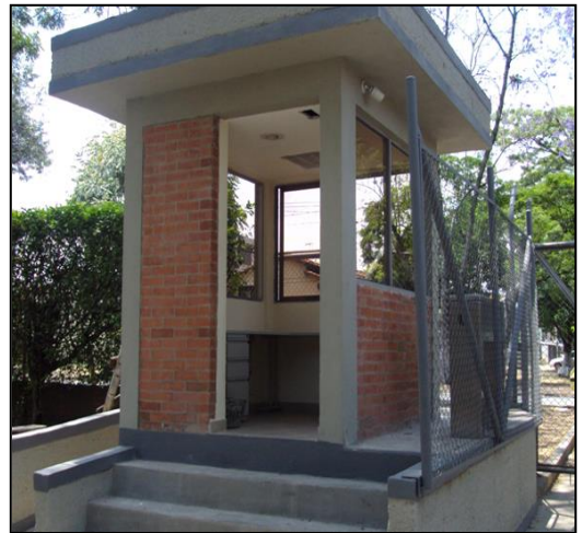
Imagen 38. Garita sanidad totalmente terminada
