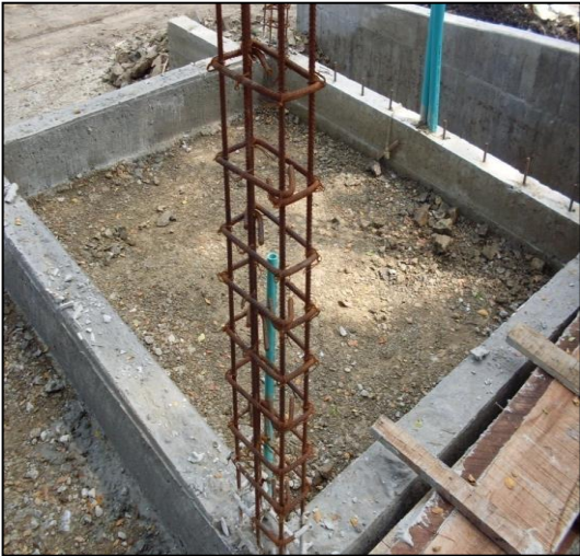
Imagen 33. Armada de columnas en garita sanidad
