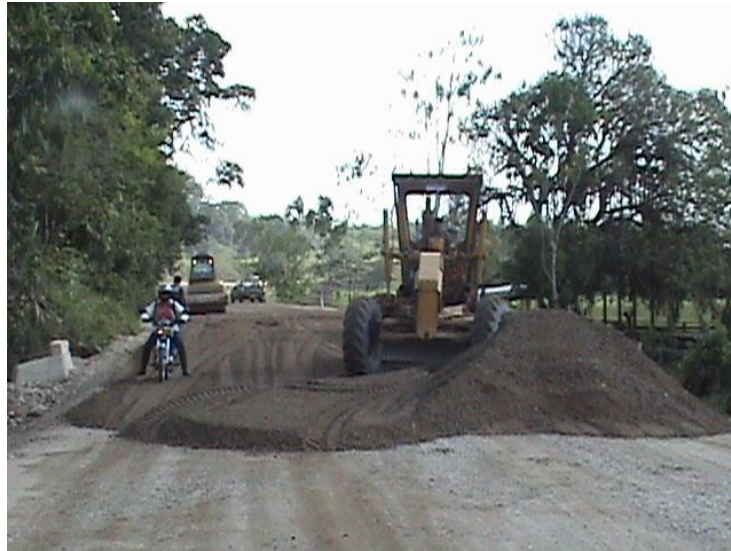
Fotografía No.32 Conformación primera capa de Base Granular K9+750
