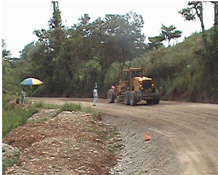
Fotografía No.36 Cereo de Base Granular K9+450
