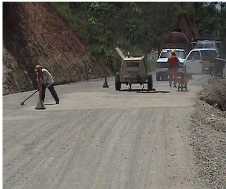
Fotografía No.38 Remoción de partículas gruesas con escobas manuales. K8+710
