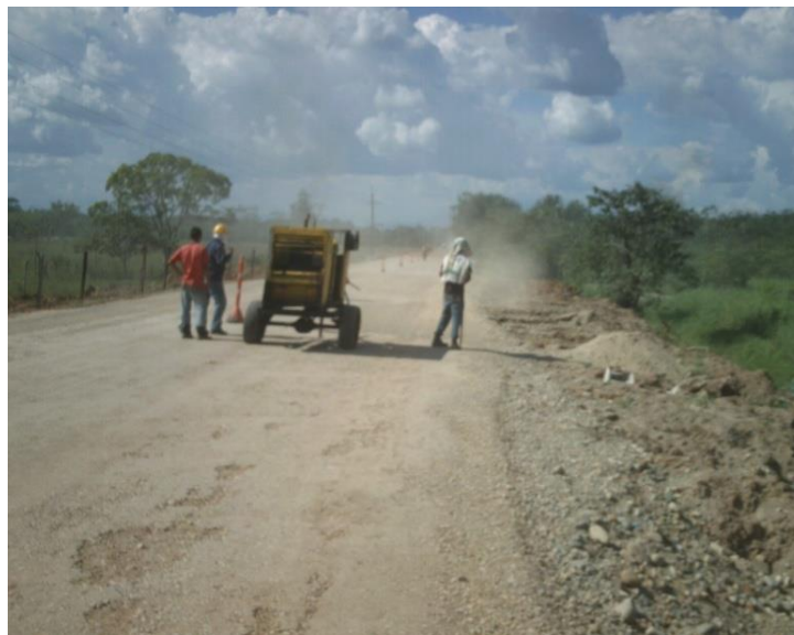
Fotografía No.40 Compresor de aire para remoción de polvo. K7+060
