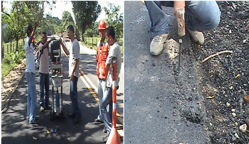
Fotografía No.51 Evaluación pavimento ubicado entre las abscisas K6+685-K7+000
