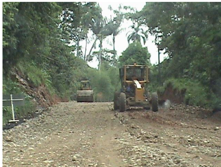
Fotografía No.27 Conformación y compactación de pedraplén K10+280
