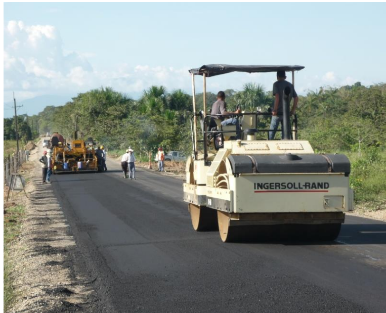
Fotografía No.47 Compactación de Carpeta Asfáltica K7+040 CI
