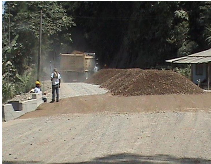
Fotografía No.29 Acordonamiento de Sub-base Granular K10+450
