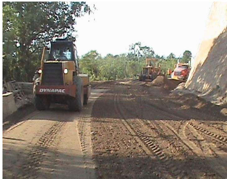
Fotografía No.30 Extendido, conformación y compactación de Sub-base Granular K9+940
