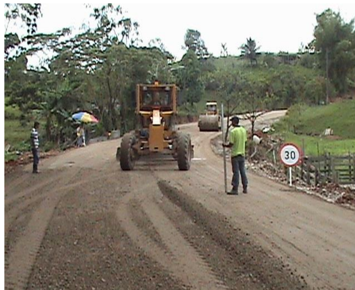
Fotografía No.35 Cerezo de Base Granular K9+000
