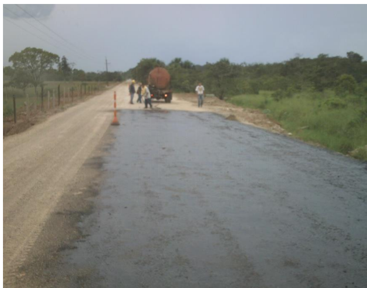
Fotografía No.41 Proceso de imprimación K7+000
