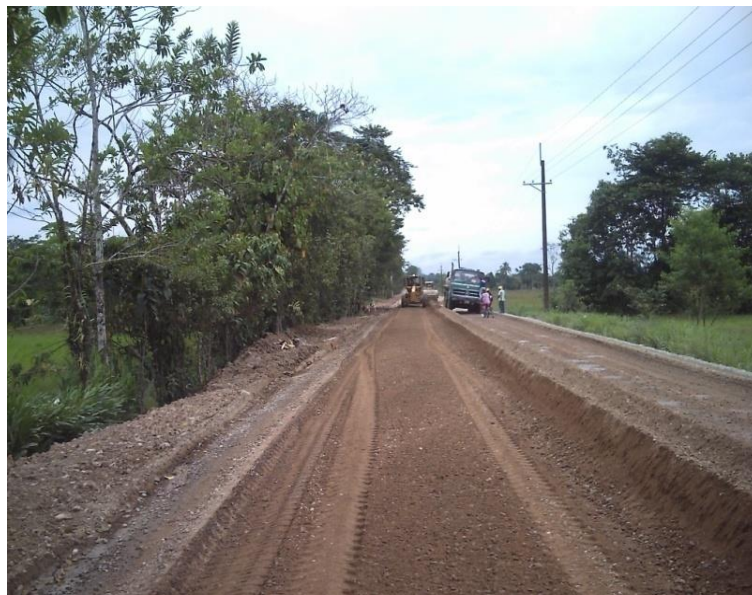
Fotografía No.37 Escarificación, re nivelación de Base comprendida entre el K7+600-K7+800
