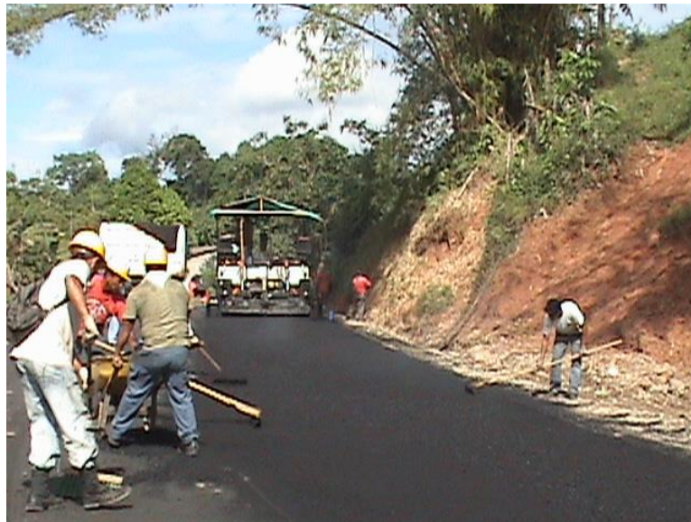
Fotografía No.46 Terminado de Carpeta Asfáltica K8+850 CD
