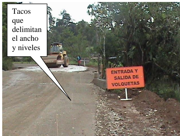
Fotografía No.33 Tacos con Anchos y Niveles para Conformación de Base Granular K9+750
