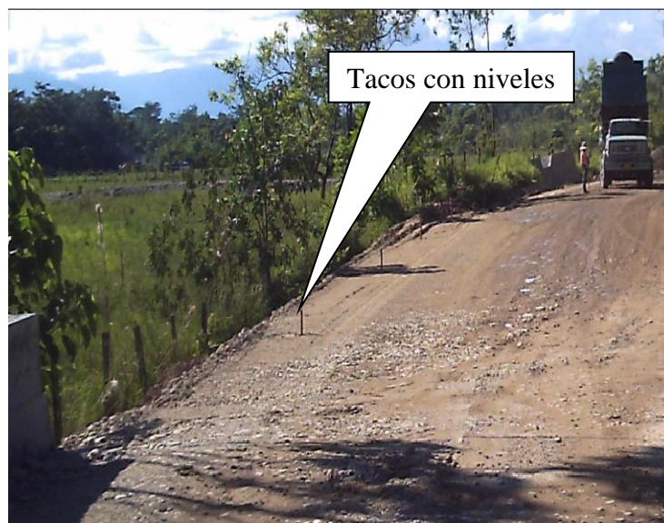
Fotografía No.28 Ancho y Niveles definidos para conformar la Sub-base K9+630
