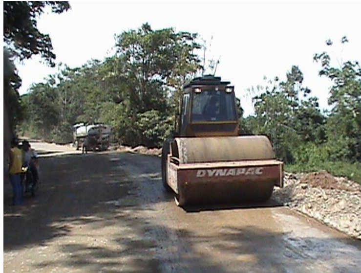
Fotografía No.31 Humectación y compactación de Sub-base Granular. K10+430
