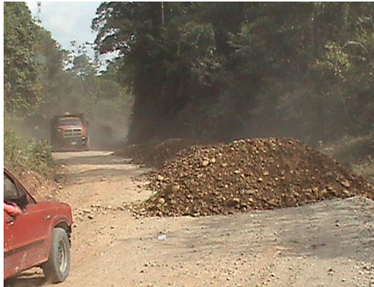
Fotografía No. 26 Material Crudo de Rio acordonado K13+150
