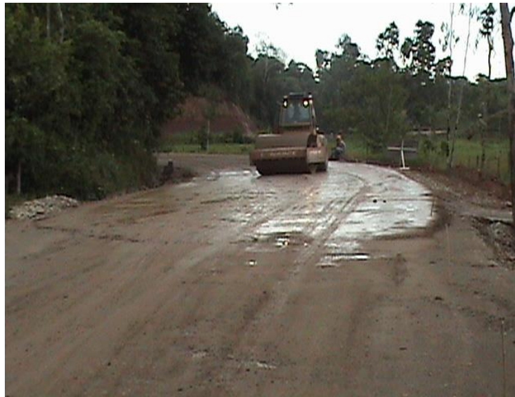
Fotografía No.34 Compactación primera capa de base de Base Granular K9+700
