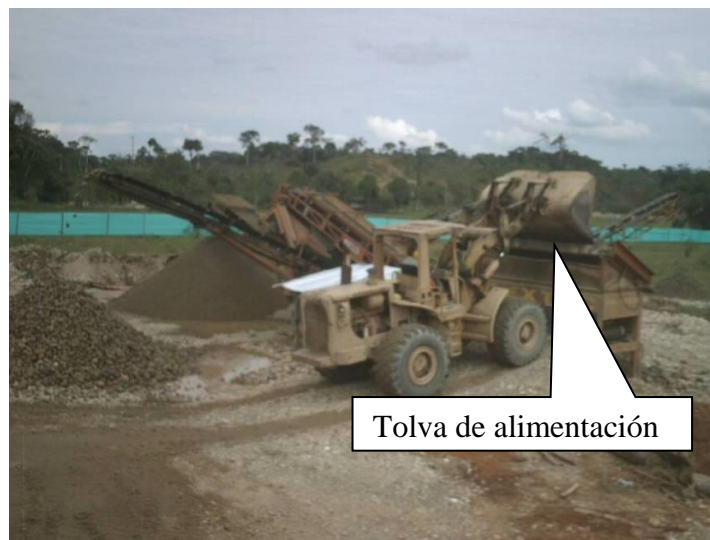
Fotografía No. 18 Producción de Sub-base Granular
