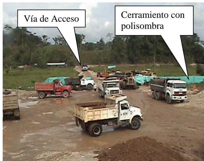
Fotografía No.12 Vía de Acceso a la Planta
