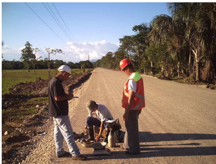
Fotografía No.49 Densidad de Campo, Base Granular K7+380
