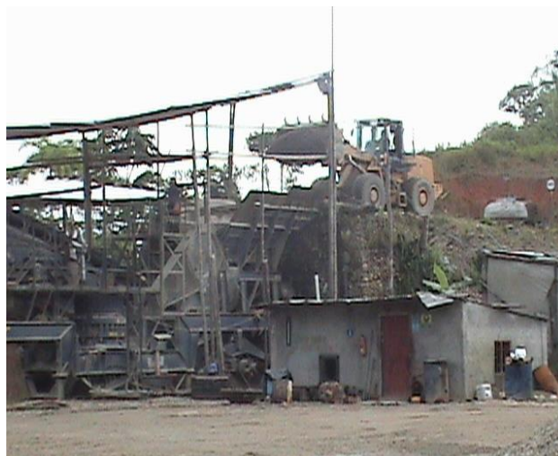
Fotografía No.9 Planta Trituradora, producción de Triturado para Base y MDC-2
