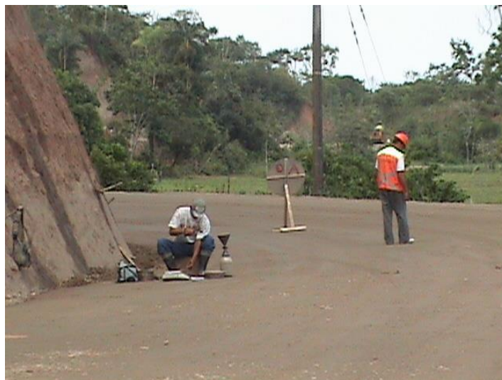
Fotografía No.48 Densidad de Campo, Sub-base Granular K9+280
