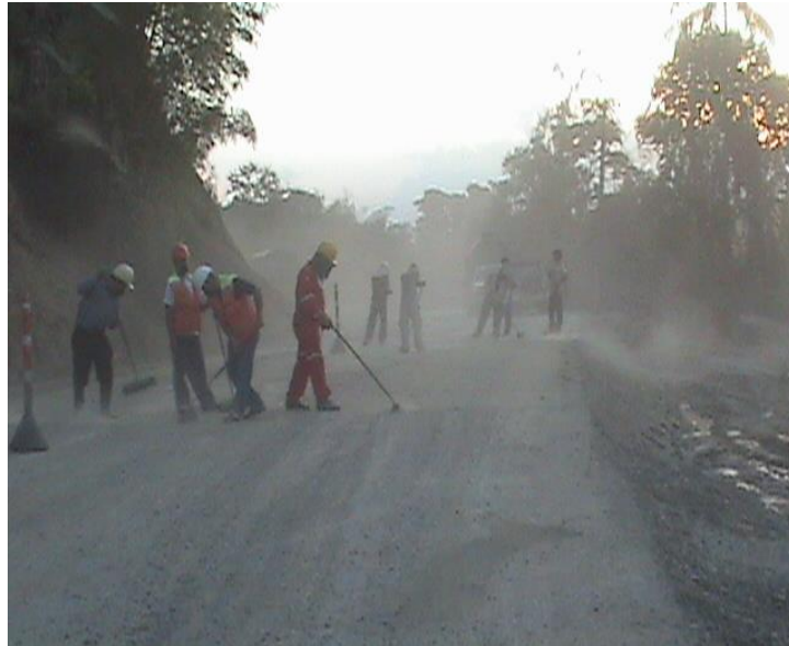
Fotografía No.39 Remoción de partículas gruesas con escobas manuales. K8+850
