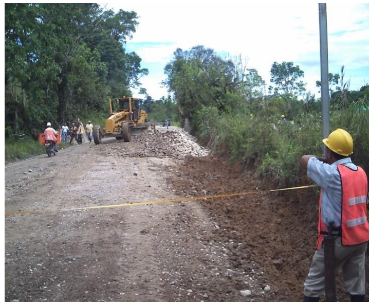
Fotografía No. 25 Ampliación y conformación de Pedraplén K9+800
