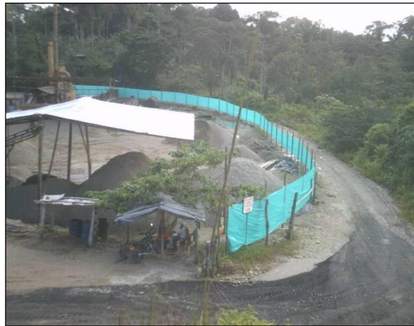
Fotografía No.7 Cerramiento lateral con poli-sombra Acopio la Carmelita
