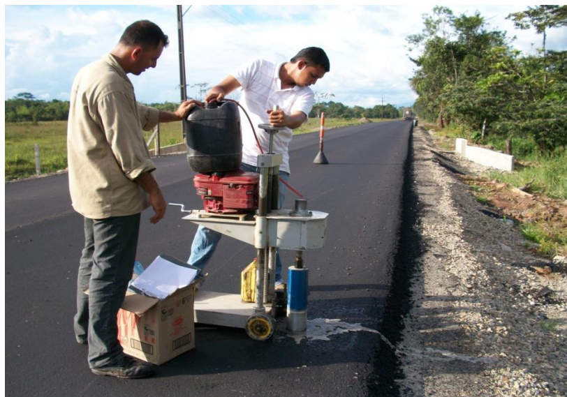
Fotografía No.50 Extracción de núcleos, K7+150 CD Carpeta de rodadura construida en su totalidad
