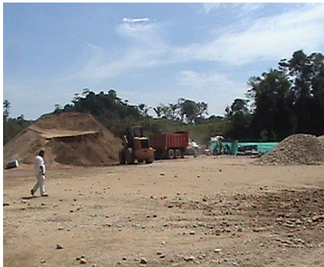
Fotografía No.14 Patio, Acopio Sub-base
