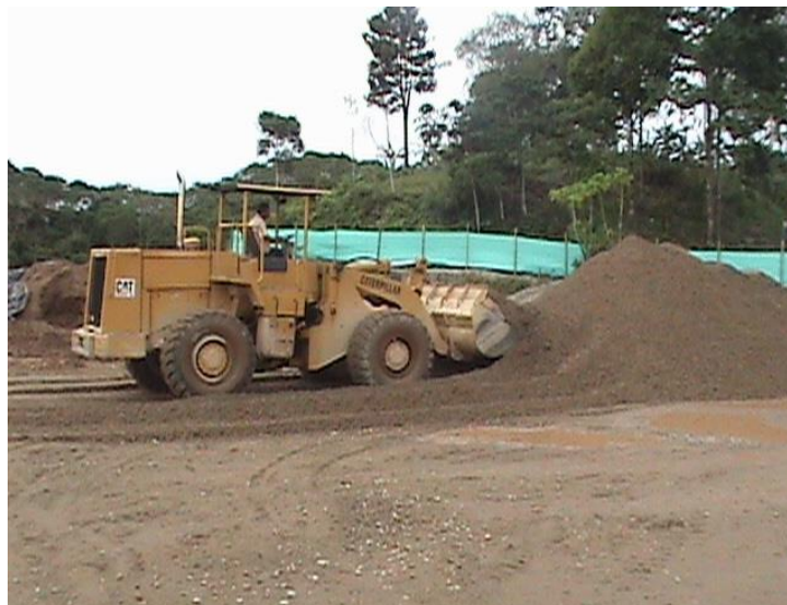
Fotografía No.21 Mezclado Base + 10% de filler
