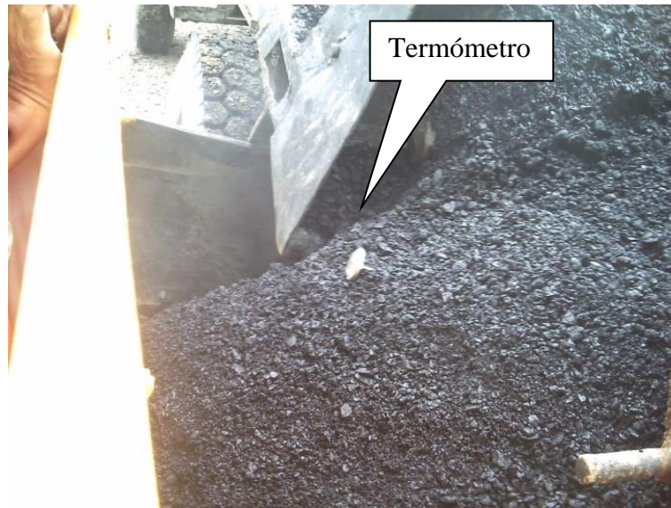
Fotografía No.45 Control de temperatura de llegada y extendido
