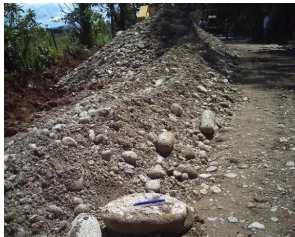
Fotografía No.16. Material crudo de rio para reemplazo de material
