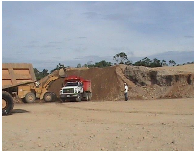
Fotografía No.15. Acopio Material Crudo de Rio, Material para Pedraplén
