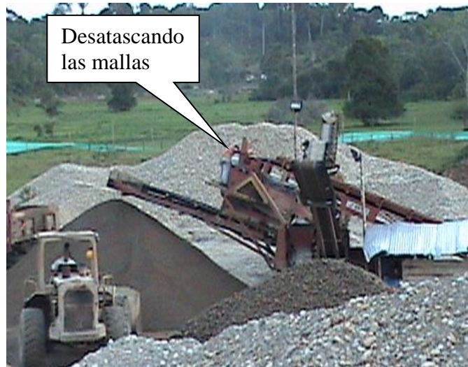
Fotografía No. 19 Limpieza de mallas
