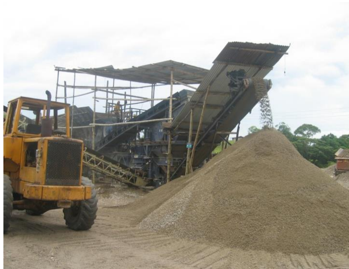
Fotografía No. 20 Producción de Base Granular
