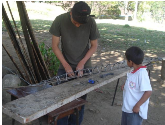
Figura 38. Refuerzo de la viga perimetral
