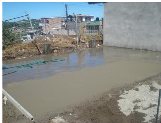
Figura 9. Fundición de piso primario
