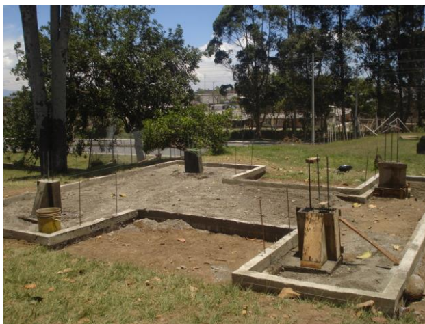
Figura 40. Pedestales de la obra
