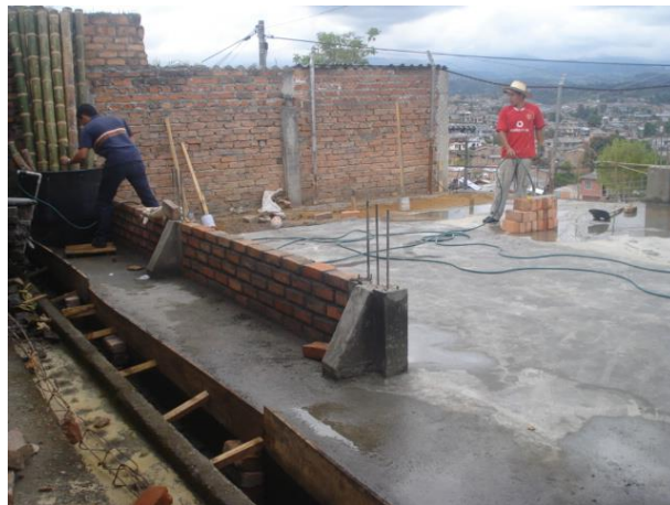
Figura 49. Aceros en pedestales sin inclinar
