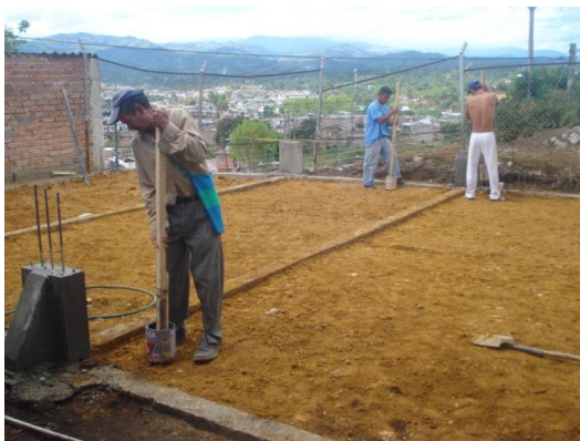
Figura 7. Compactación del suelo
