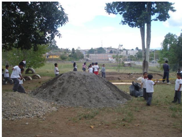
Figura 35. Material a utilizar en la obra
