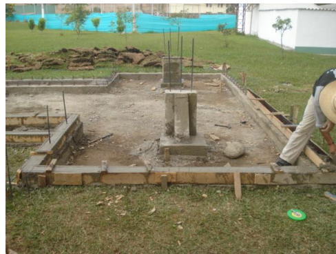
Figura 24. Viga perimetral
