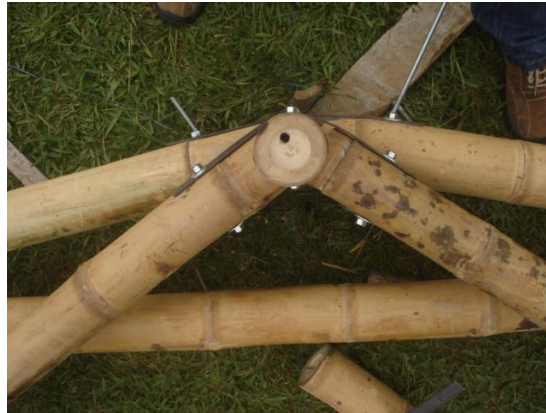
Figura 26. Detalle de la unión de los elementos
