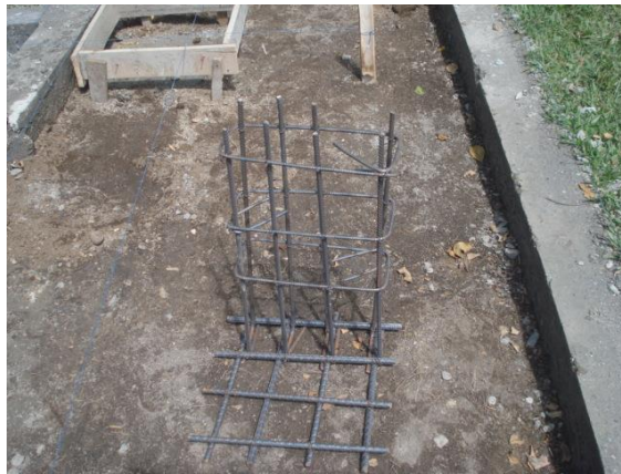
Figura 23. Refuerzo de zapatas
