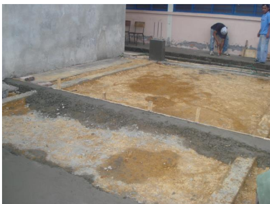
Figura 8. Niveles para suelo primario
