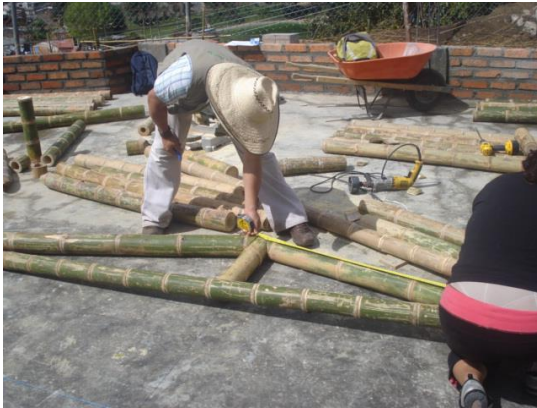
Figura 15. Construcción de la cercha
