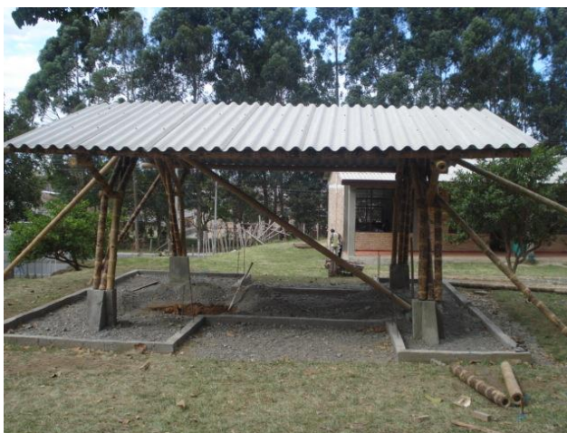
Figura 42. Cubierta en eternit
