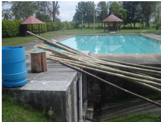
Figura 25. Tratamiento a la guadua
