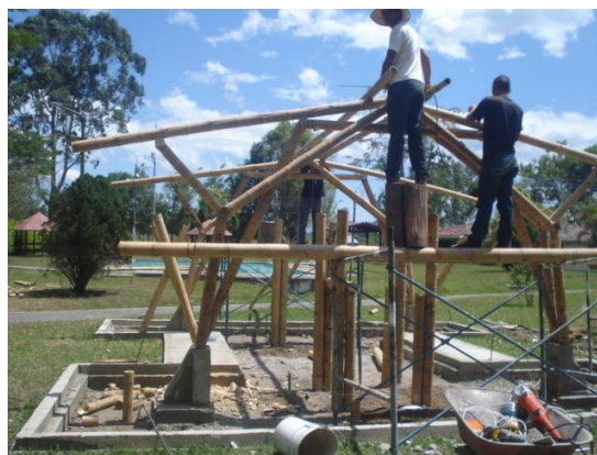
Figura 27. Posicionamiento de las cerchas
