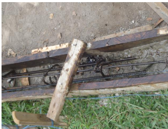
Figura 45. Aplicación del aceite quemado
