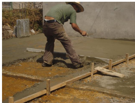
Figura 44. Fundición del piso primario
