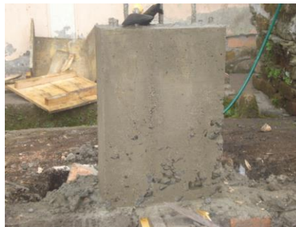
Figura 43. Pedestal con hormiguero
