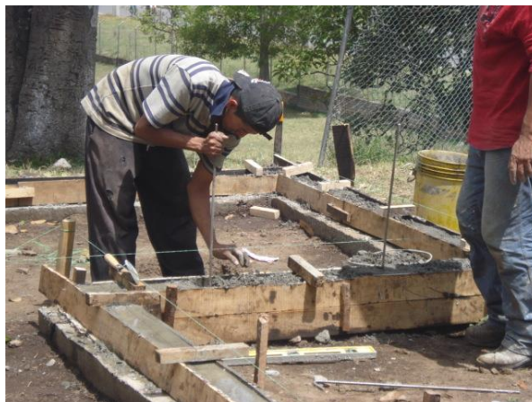
Figura 39. Vibrado del concreto
