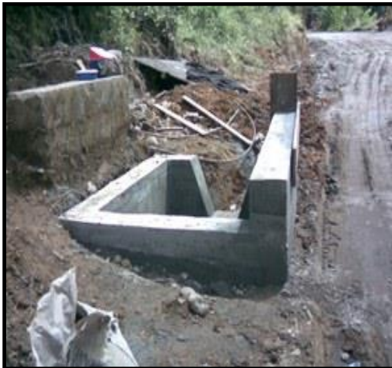
Foto N°5: Construcción caja de entrada alcantarilla de 36", abscisa PR18+434.
