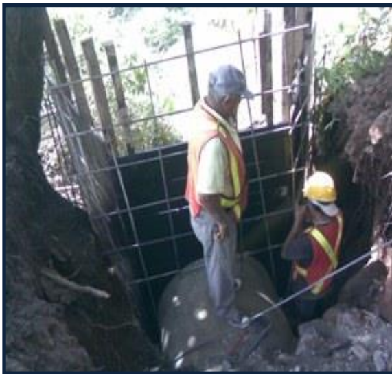
Foto N°9: Construcción de cabezal de salida alcantarilla PR20+125.
