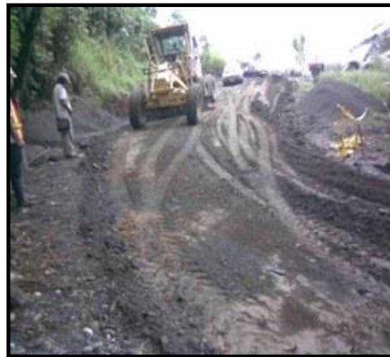
Foto N°14: Conformación de subrasante absisa PR20+000 al PR20+200.
