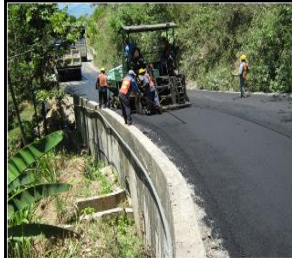
Foto N° 20: Colocación de la carpeta asfáltica en la abscisa PR21 + 984.
