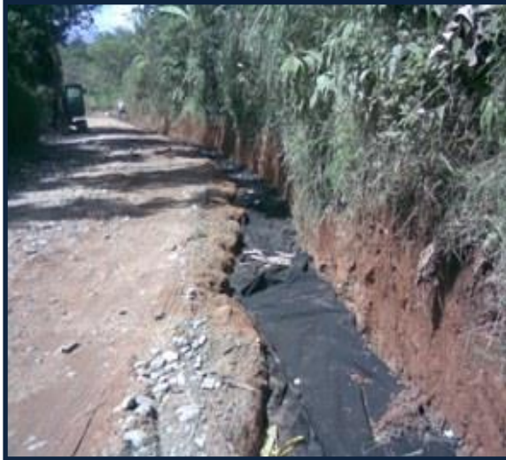
Foto N°7: Construcción de filtros del PR20+150 al PR 20+190.
