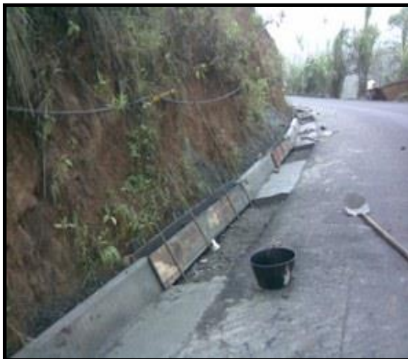
Foto N°13: Construcción de cunetas PR19+150.
