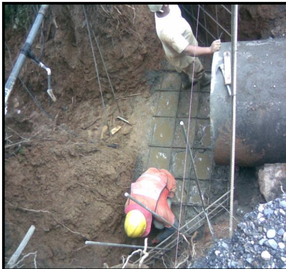
Foto N° 15: Construcción de cabezal de salida de alcantarilla PR20+897.
