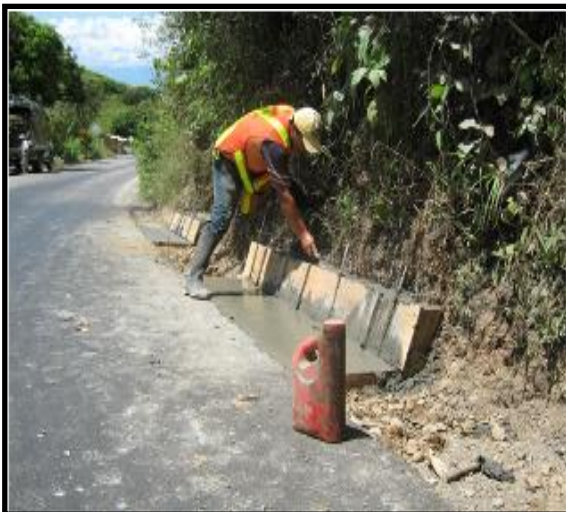
Foto N° 21: Construcción de cunetas en el PR19 + 540.
