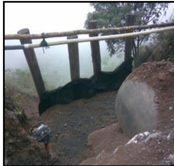
Foto N°6: Construcción obra de salida de alcantarilla, abscisa PR18+140.
