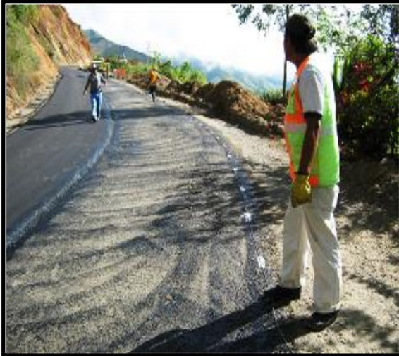
Foto N°19: Demarcación del ancho de carpeta en la abscisa PR20 + 970.
