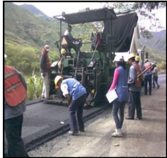
Foto No.26: Toma de temperatura a la mezcla de asfalto, por parte de la interventoría, entre las abscisas PR21+210 al PR21+500.
