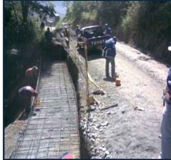
Foto N°8: Colocación hierro en la zapata del muro de contención del PR20+325.
