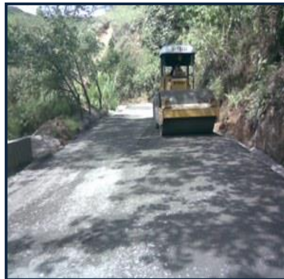
Foto N°10: Compactación de la capa de base entre el PR19+200 al PR19+400.
