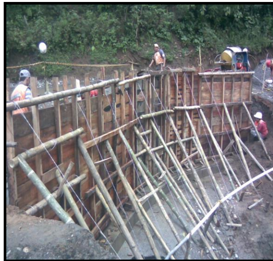
Foto N° 16: Encofrado para la construcción de muro de contención PR20+185.
