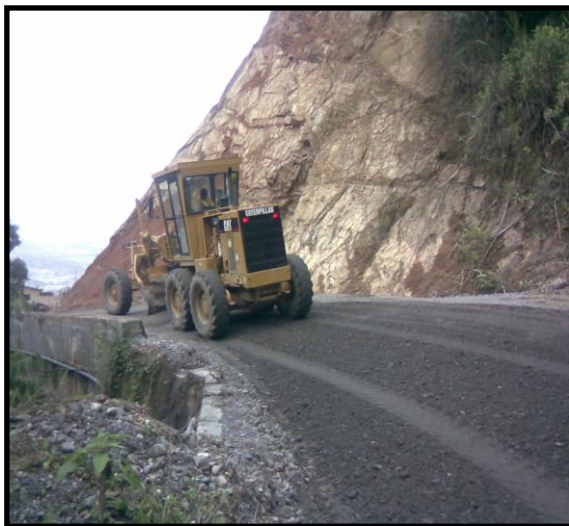
Foto N° 17: Colocación de base entre las abscisas PR21+000 al PR22+000.
