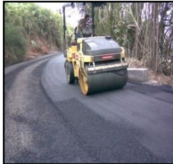
Foto N°12: Pavimentación del tramo PR19+730 a PR19+950.
