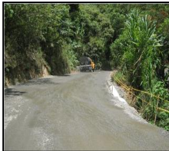
Foto N° 22: Riego y compactación material de base en la abscisa PR 21 + 550.
