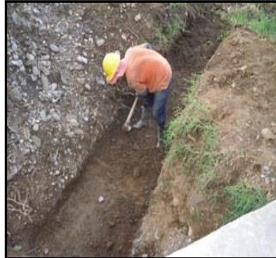
Foto N° 24: Excavación para dissipador ubicado en la abscisa PR19+080.
