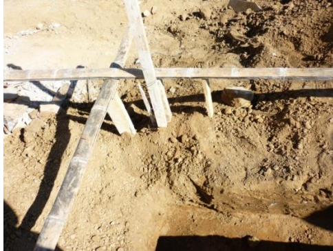
Ilustración 4. Verificación de distancias de ejes y paramentos
