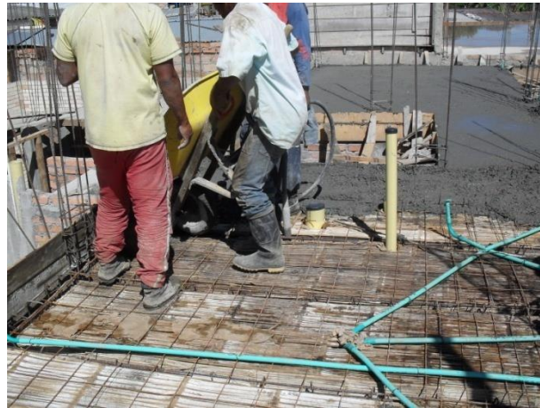
Ilustración 36. Fundición de la losa
