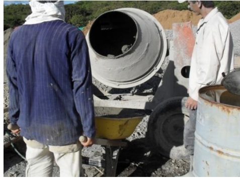
Ilustración 6. Producción de concreto en obra
