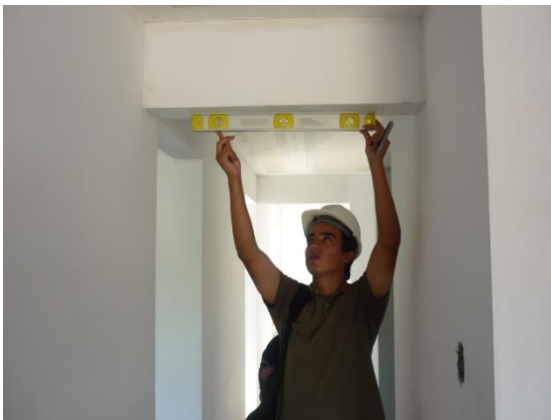
Ilustración 10. Medición del nivel de un dintel
