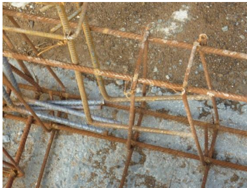
Ilustración 5. Estribos y ganchos en el acero
