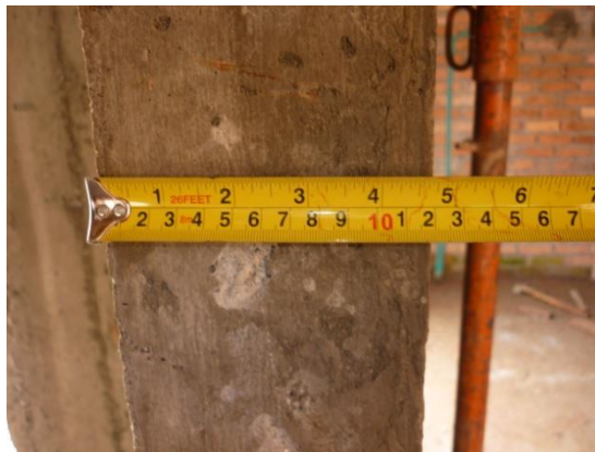
Ilustración 26. Medición del espesor de una columna
