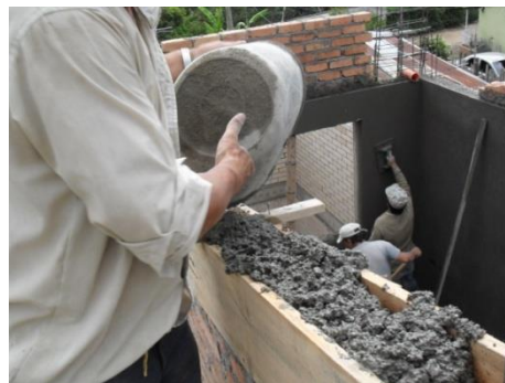
Ilustración 41. Fundición de cinta de amarre
