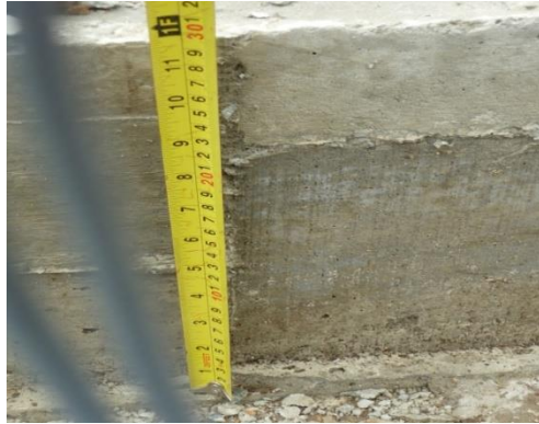
Ilustración 15. Medición del alto de una zapata
