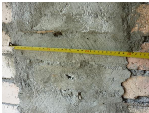
Ilustración 28. Medición del ancho de una columna
