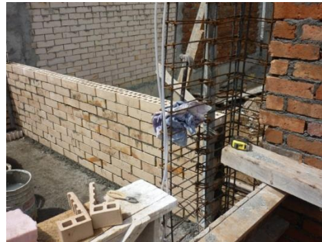
Ilustración 21. Pega de muro con mampostería de perforación vertical de 10 orificios
