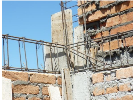
Ilustración 39. Refuerzo en vigas de amarre
