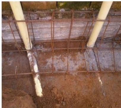
Figura 49. Tubería de desagüe corregida ubicada sobre pie de la zapata Z1.
