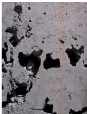
Figura 43. Cimiento que requiere mezcla de Mortero.
