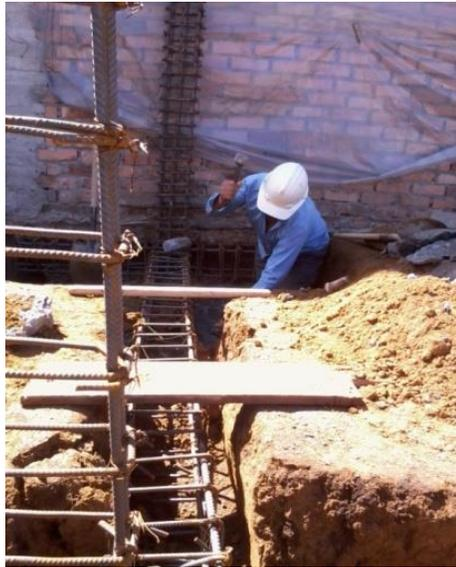
Figura 47. Operario demoliendo la zapata de Cimentación.
