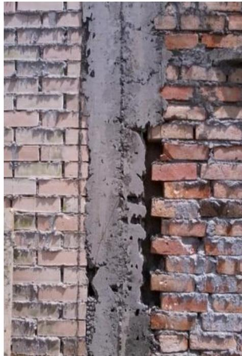
Este problema debía ser solucionado de inmediato y en una primera solución para la casa 83, se optó por utilizar un reparador de elementos estructurales llamado Sikatop-122, el cual es un mortero que tiene gran adherencia al concreto y alcanza altas resistencias en poco tiempo. Este producto se especifica mejor en la tabla del **anexo B**.
