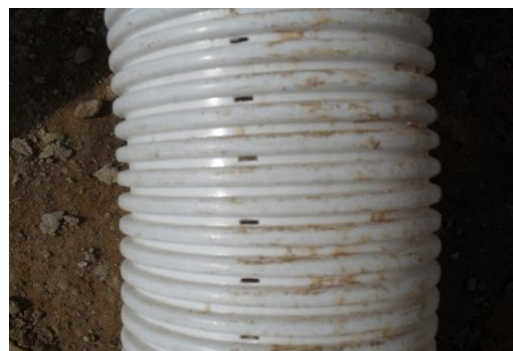
Figura 80. Agujeros tubería cordrenaje
