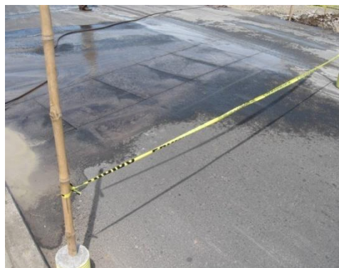
Figura 68. Cortes realizados
