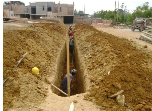
Figura 13. Excavación alcantarillado sanitario
