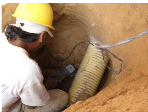
Figura 59. Corte de tubo de 6".
