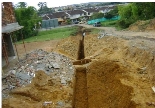
Figura 10. Excavación alcantarillado.
