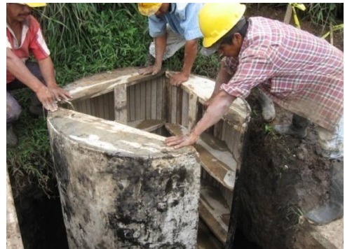
Figura 36. Encofrado cilindros 2.
