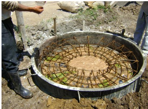
Figura 47. Encofrado brocales 3
