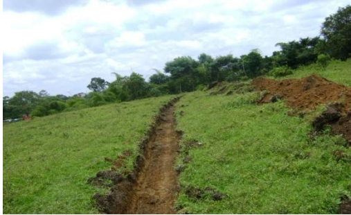
Figura 4. Canal para bajar nivel freático.
