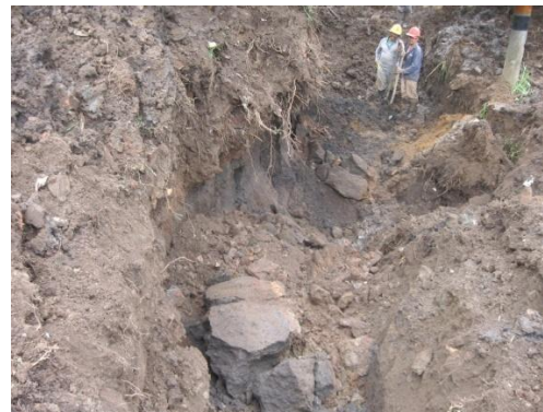
Figura 90. Excavación inestable 2.
