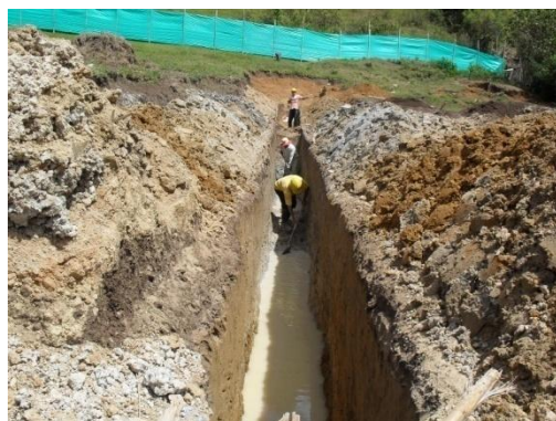
Figura 76. Excavación alcantarillado.
