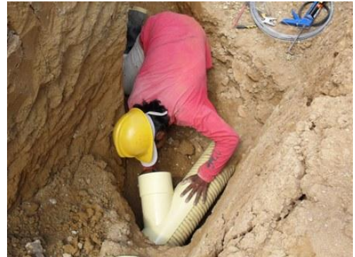
Figura 62. Empalme de la silla al tubo de 8”.
