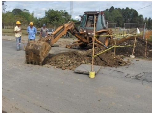
Figura 69. Utilización de retroexcavadora
