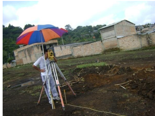
Figura 6. Nivelación del terreno
