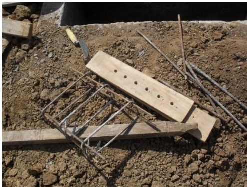
Figura 103. Viga de hierro usada
