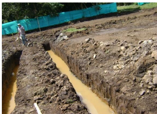
Figura 75. Zona nivel freático alto
