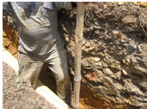
Figura 32. Chequeo pendiente
