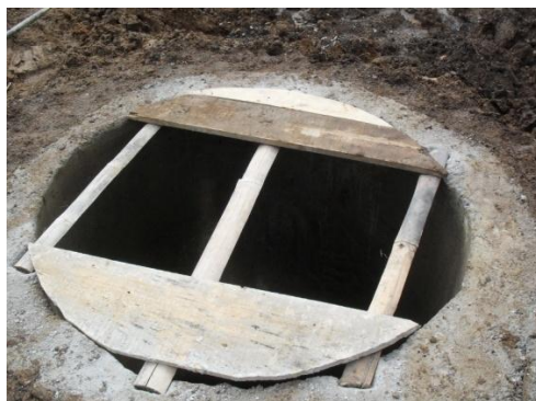
Figura 45. Encofrado brocales 1
