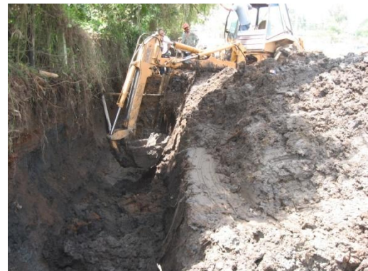
Figura 92. Utilización retro en terreno inestable
