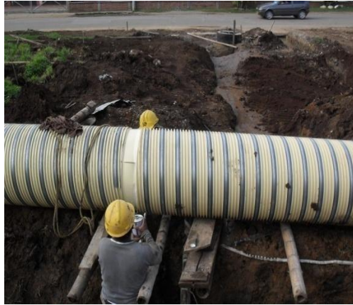
Figura 87. Unión con soldadura
