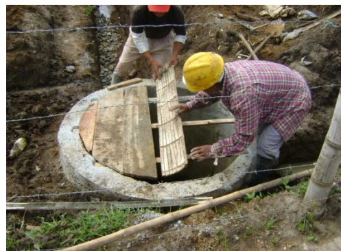
Figura 46. Encofrado brocales 2.
