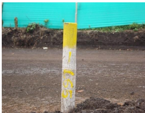
Figura 9. Estacas para corte de vías.
