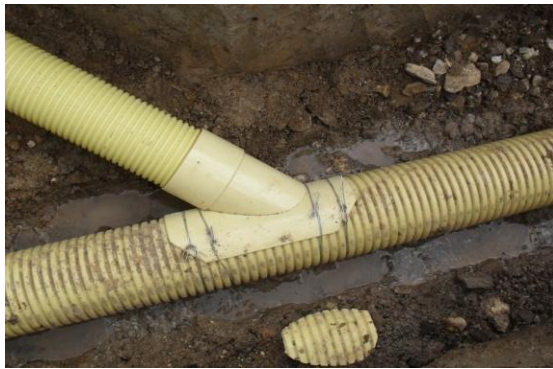
Figura 63. Utilización alambre galvanizado
