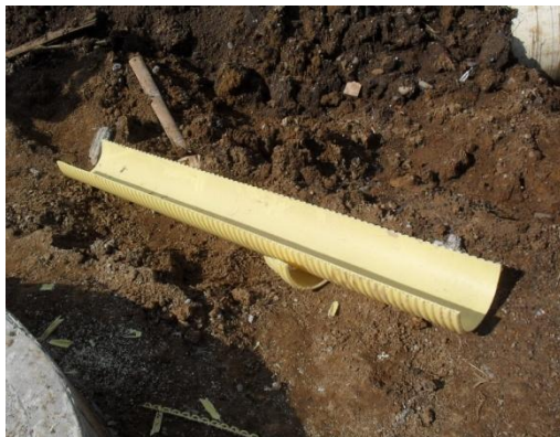
Figura 53. Corte de tubo de 10"
