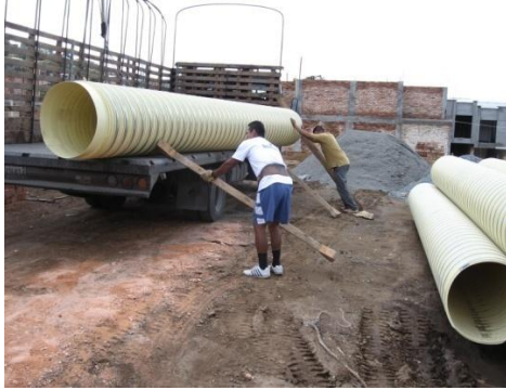
Figura 23. Descargue tubería
