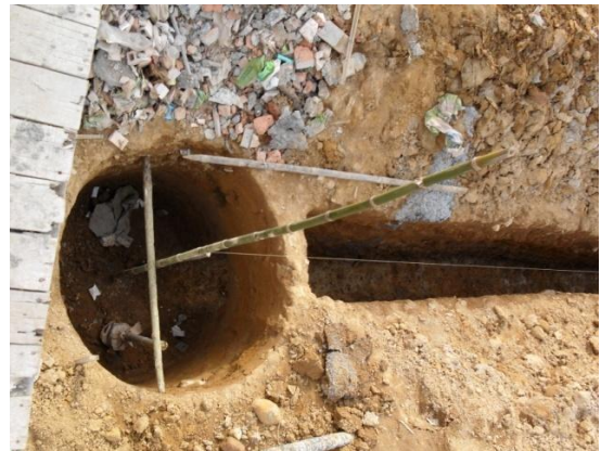
Figura 26. Excavación cámaras
