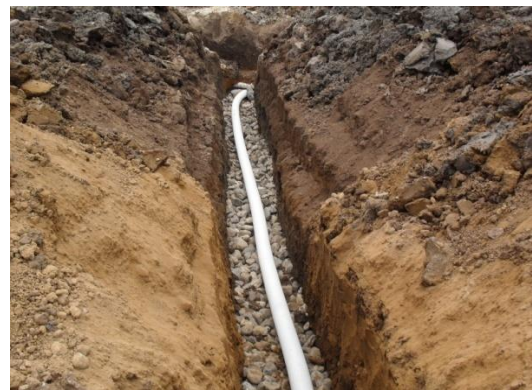
Figura 82. Tubería filtro instalada
