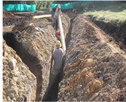
Figura 28. Descenso tubería
