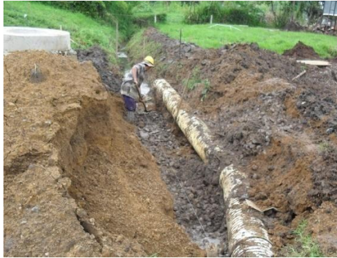
Figura 85. Ensamble tubería 27" .
