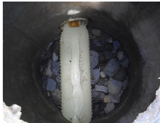
Figura 54. Colocación de capa de piedra
