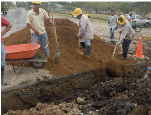
Figura 73. Relleno tramo vía
