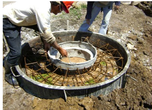
Figura 48. Encofrado brocales 4.
