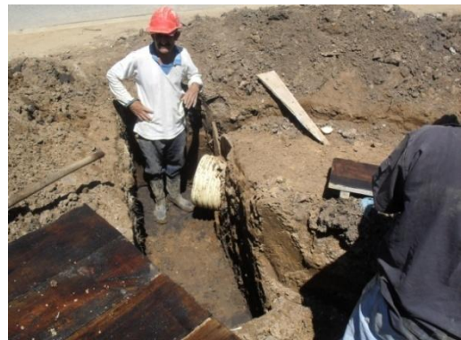
Figura 100. Encofrado sumideros.
