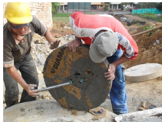
Figura 52. Colocación manija para levantar tapa
