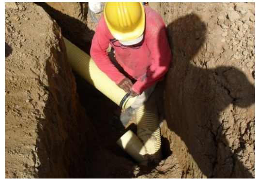
Figura 64. Colocación de empaque al tubo de 6"
