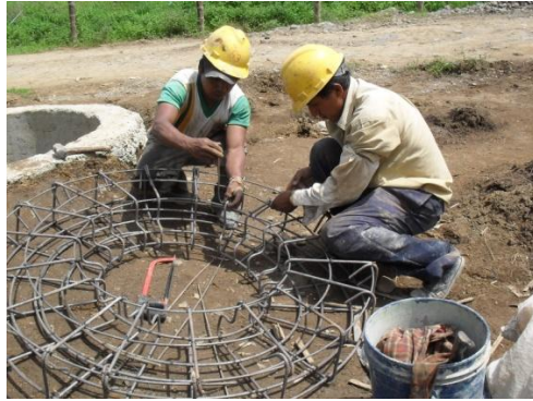
Figura 43. Amarre refuerzo brocales
