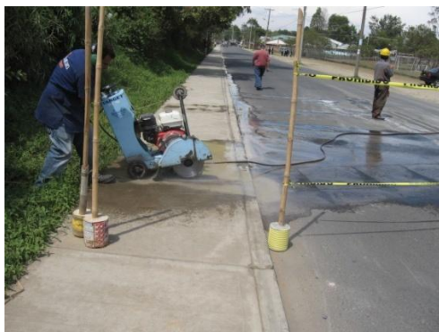
Figura 67. Corte vía para pase
