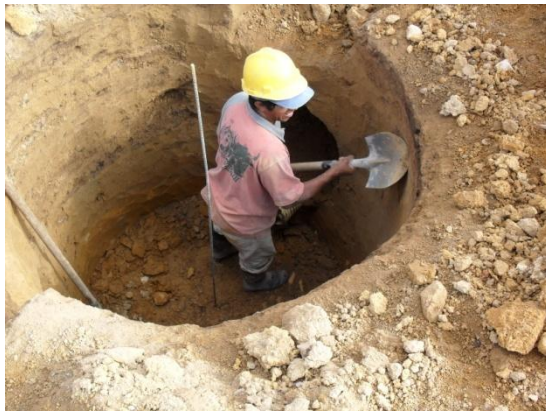
Figura 25. Excavación cámaras
