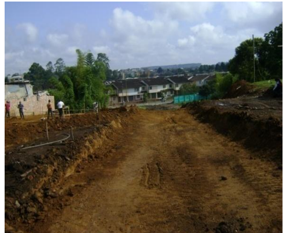
Figura 8. Chequeo de cajeo de vía.
