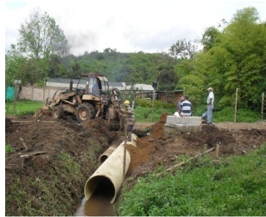
Figura 88. Descenso tubería fondo caño.
