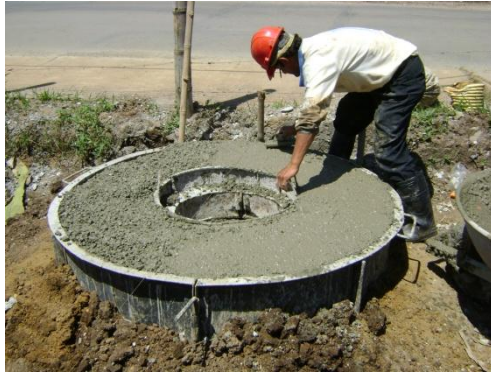
Figura 49. Fundición brocales
