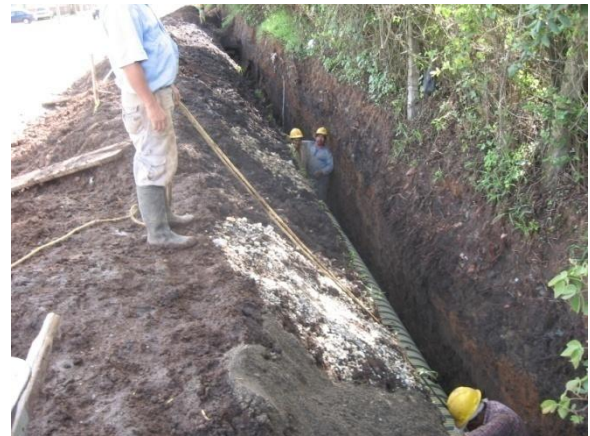
Figura 94. Descenso tubería con manila
