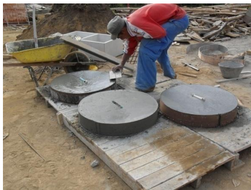
Figura 51. Fundición tapas cámaras
