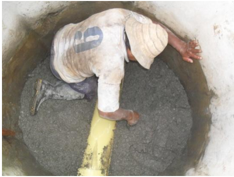
Figura 55. Fundición piso cañuela
