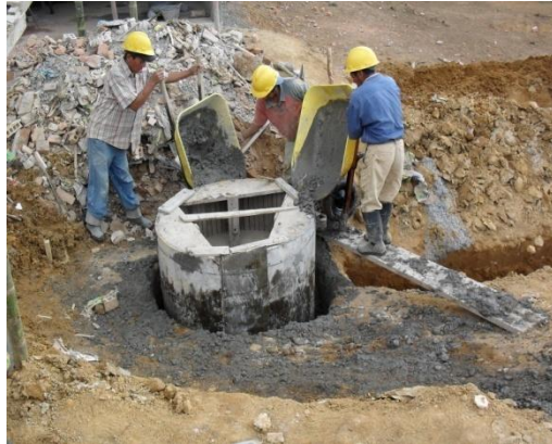
Figura 39. Fundición cilindros cámaras
