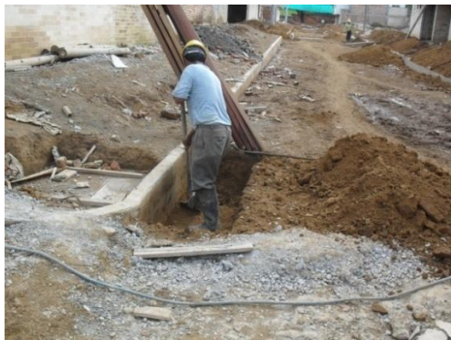
Figura 99. Excavación sumideros
