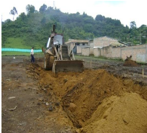
Figura 7. Cajeo de la vía principal
