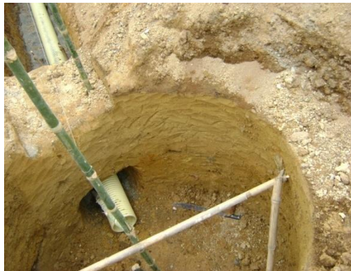
Figura 33. Estacas para pasar niveles
