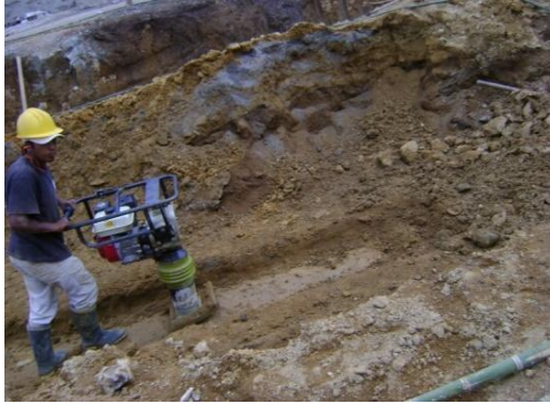
Figura 65. Compactación relleno
