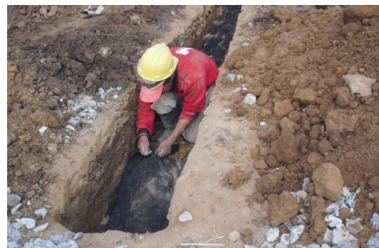
Figura 84. Cocido de geotextil NT.
