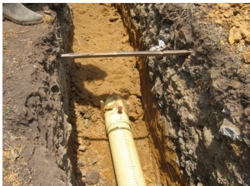
Figura 31. Chequeo alineamiento
