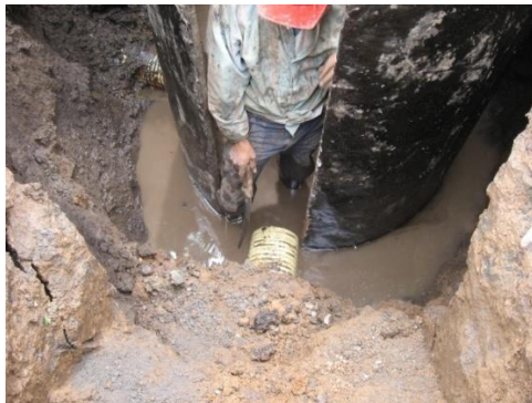
Figura 35. Encofrado cilindros 1.
