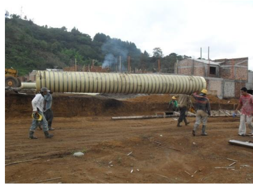
Figura 86. Transporte tubería 27"
