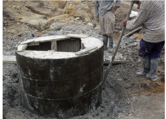
Figura 40. Compactación concreto cilindros
