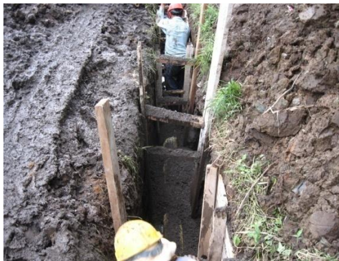
Figura 91. Entibada excavación
