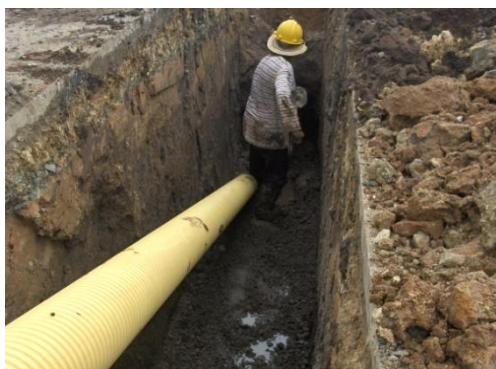
Figura 71. Descenso tubería
