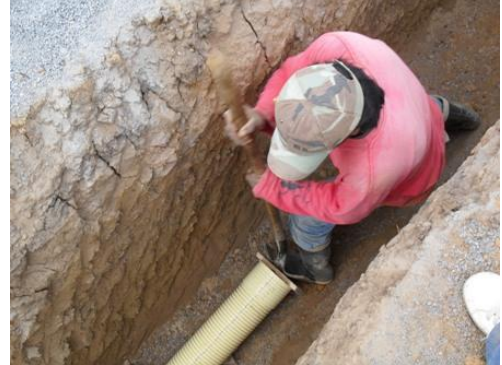
Figura 66. Empuje tubo domiciliaria
