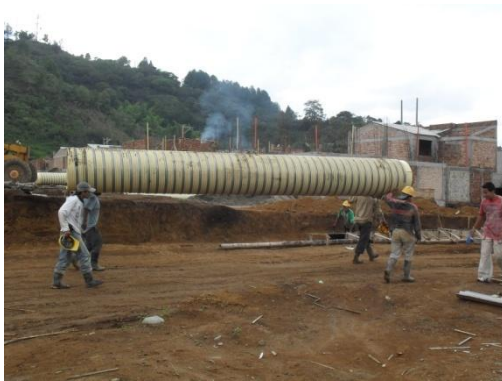
Figura 93. Transporte tubería RIB-LOC
