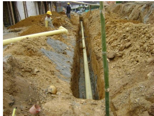
Figura 34. Tramo en excavación
