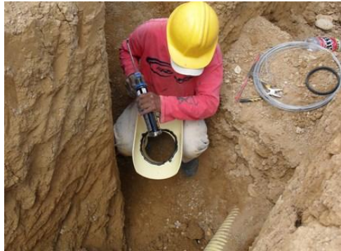
Figura 61. Utilización de Sikaflex 221
