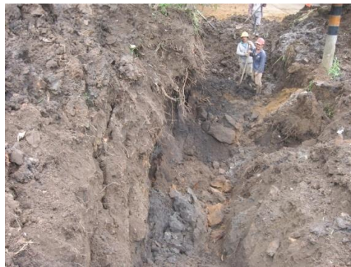
Figura 89. Excavación inestable 1
