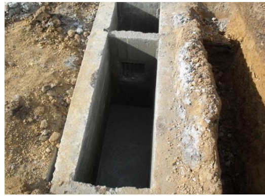
Figura 106. Cajón sumidero fundido.
