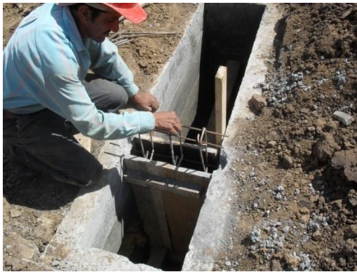
Figura 105. Colocación viga de refuerzo
