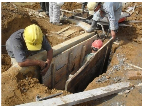
Figura 101. Encofrado sumideros
