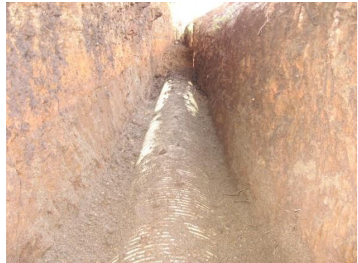
Figura 98. Capa de grava como filtro.
