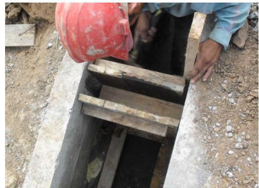
Figura 104. Encofrado tabique divisorio
