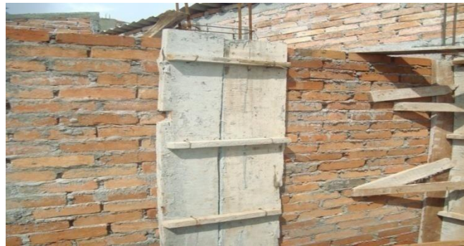
Figura 14: Formaleta en obra de columnas.
