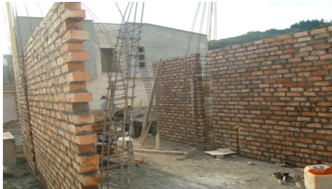
Figura 28. Muro en sogá ladrillo común primer piso casa 43.
