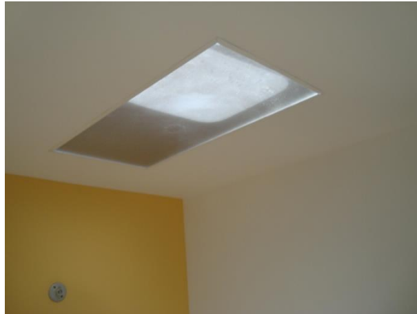
Figura 42: cielo raso segundo piso casa 2.
