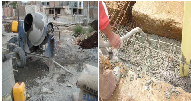
Figura 6: Mezcladora para preparación de concreto.
