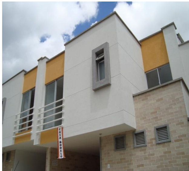
Figura 47: Pintura de fachada casa 2.
