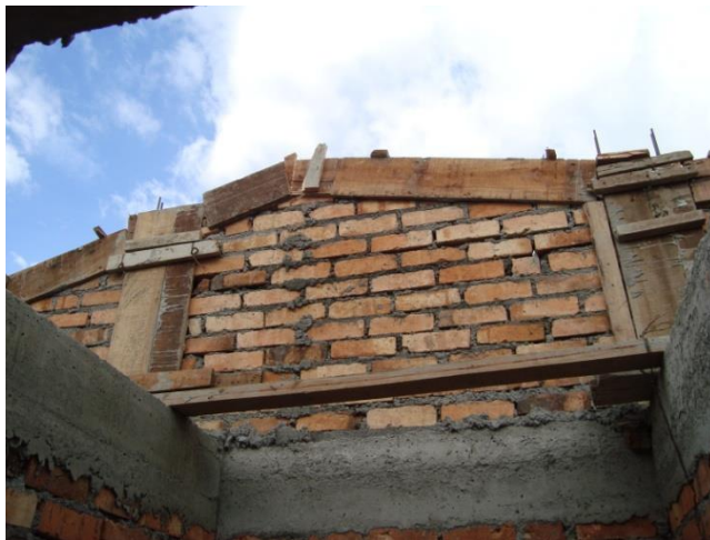
Figura 30. Muro en sogá ladrillo común culatas casa 43.
