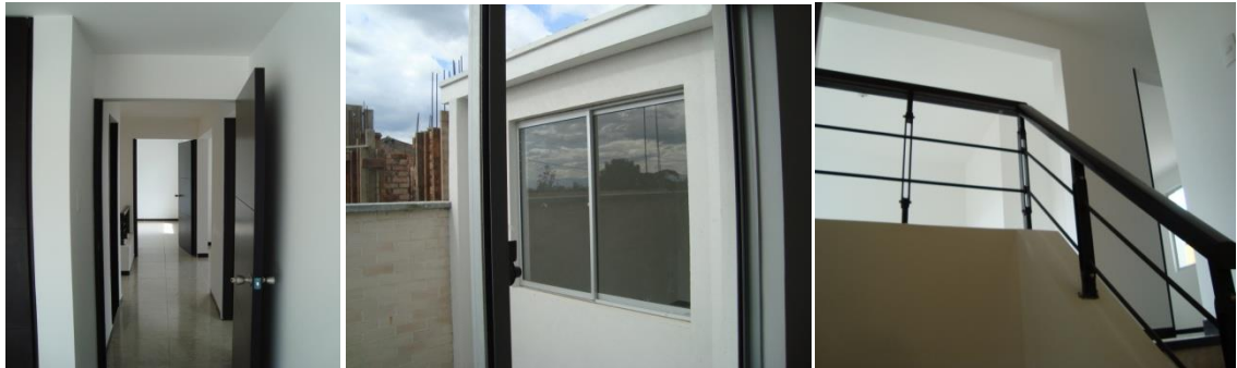
Figura 58: Carpintería de madera, aluminio y metálica.
