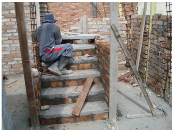
Figura 31: Gradas y escalones casa 52.
