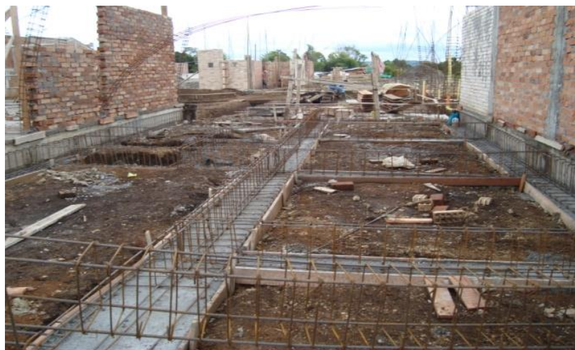
Figura 21: Solado y acero para la zapata corrida casa 43.
