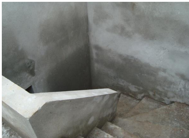
Figura 43: Repello de carteras y muros interiores casa 52.
