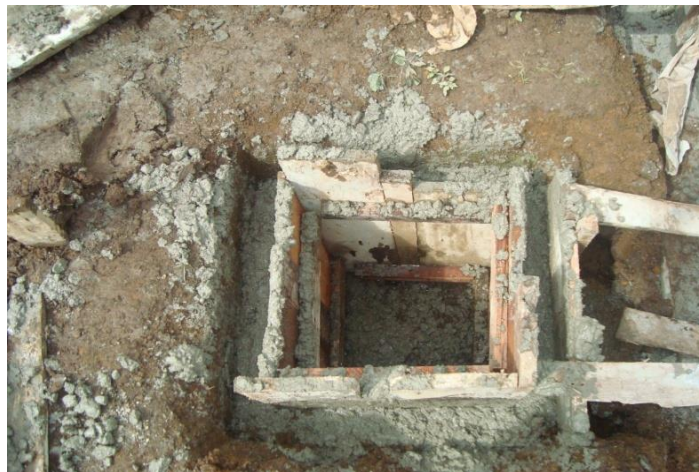
Figura 12: Formaleta en obra para caja de inspección.
