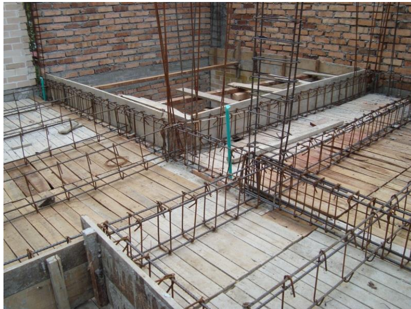
Figura 36: Acero y formaleta de la losa de entrepiso casa 43.
