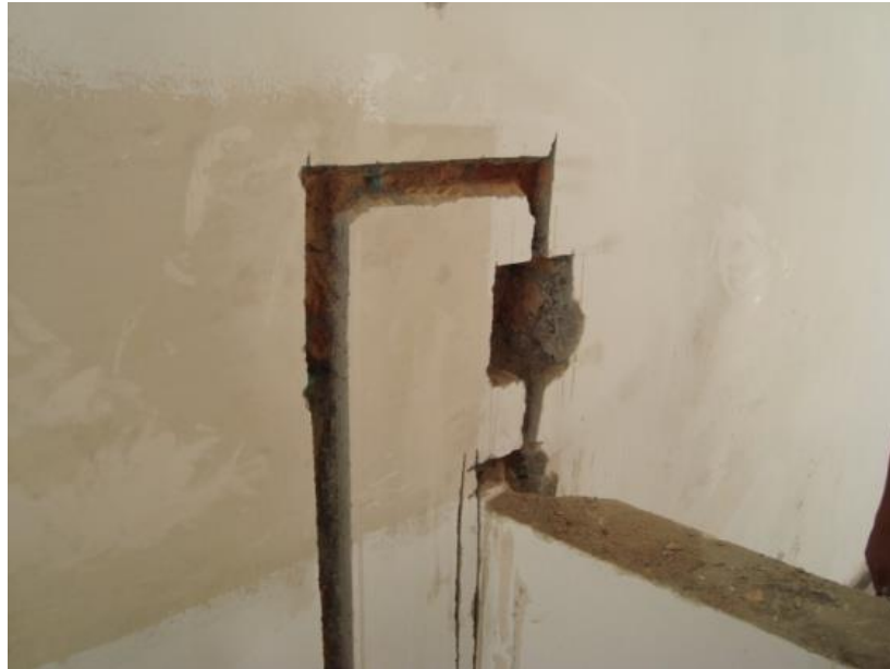
Figura 40: Regatas de Instalación de gas domiciliario casa 42.
