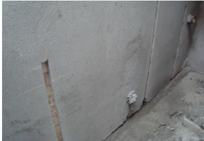
Figura 38: Regatas de instalación hidráulica del primer piso casa 42.
