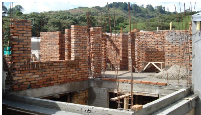
Figura 29: Muro en sogá ladrillo común segundo piso, casa 42.
