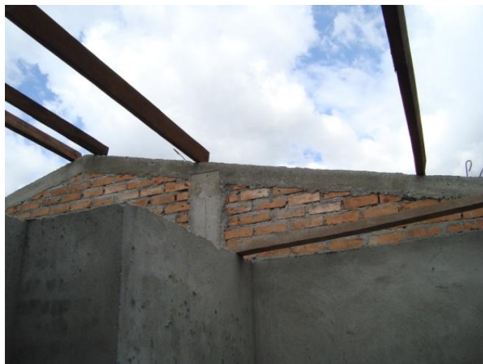
Figura 33: Columnas culatas casa 43.
