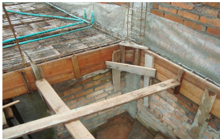
Figura 16: Formaleta en obra para vigas de amarre.
