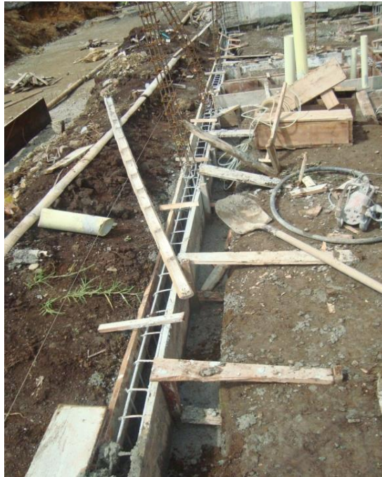
Figura 8: Formaleta en obra zapata tipo Z1.
