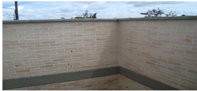
Figura 26. Muro en soga ladrillo a la vista segundo piso casa 2.
