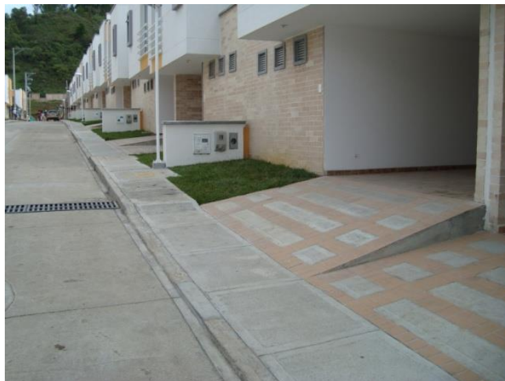
Figura 55: Acceso de carro al garaje, andenes y andenes y antejardín casa 4.
