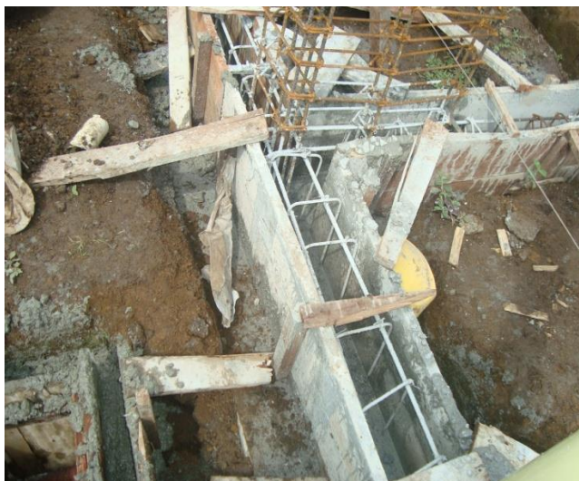
Figura 10: Formaleta en obra para zapata tipo Z3 y Z4.
