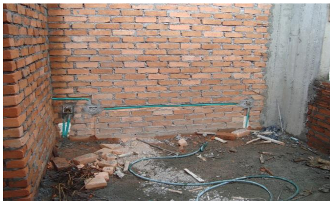
Figura 39: Regatas de instalación eléctrica del segundo piso casa 43.
