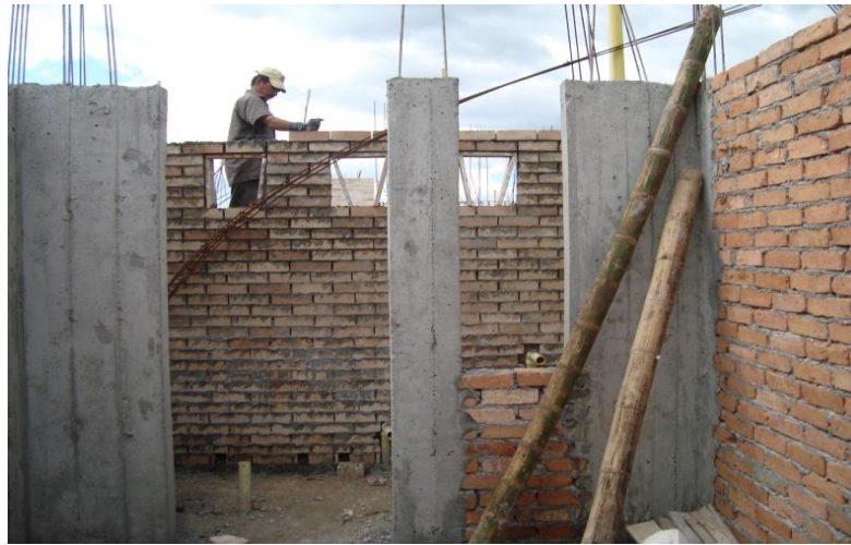
Figura 32: Columnas C1 y C2, casa 52.
