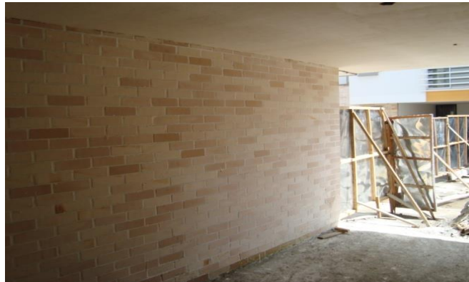
Figura 25. Muro en sogá ladrillo a la vista primer piso casa 43.
