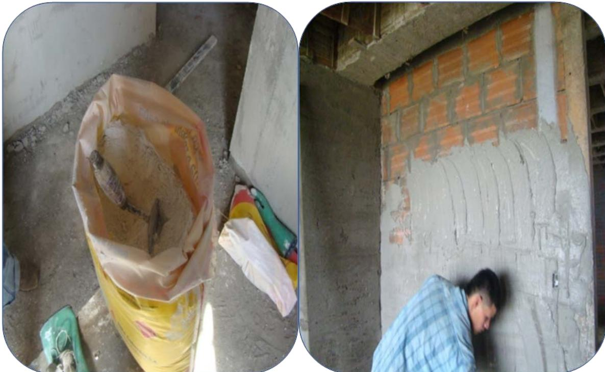
Los muros se debían preparar colocando un toldillo adherido con acronal, en los lugares donde se realizaron regatas y hubo necesidad de hacer resanes, esto con el objeto de evitar las fisuras en un futuro, ya que había unión de materiales heterogéneos.
