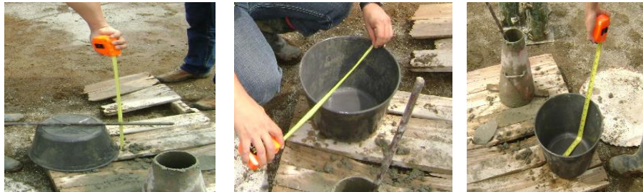
Fotos No.47, 48, 49 Medición de baldes para el agua de mezcla
