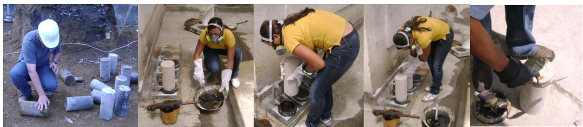
Fotos No. 55, 56, 57, 58, 59 Verificación de la edad de cilindros y encofrado
