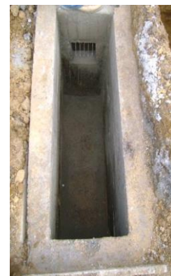
Foto No. 25 Sumideros sobre la Vía
