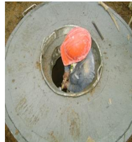
Foto No. 23 Desencofrado Cajas de Inspección
