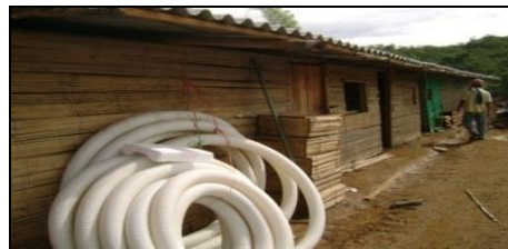
Foto No. 1 Campamento
