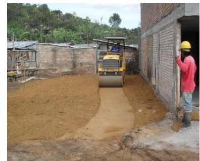
Foto No. 12 Compactación
