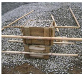
Foto No. 35. Cajones 0.04 m 3 Para Agregado Grueso
