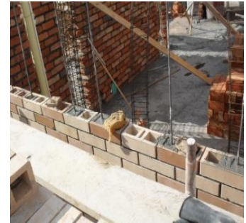
Foto No. 17 Mampostería PV (2 Orificios)
