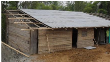
Foto No. 29. Elaboración de Bodega para Almacenamiento del Cemento
