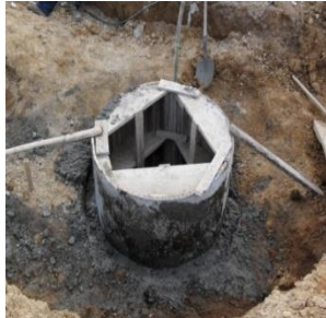
Foto No. 21 Fundición de Caja de Inspección
