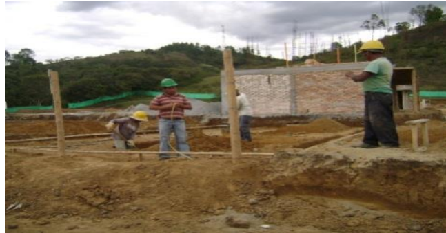
Foto No. 8 Localización y Replanteo de casas
