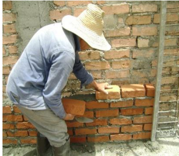
Foto No.15 Mampostería Maciza
