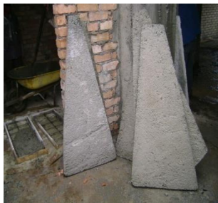
Foto No. 18 Peldaños Utilizados
