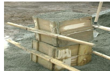
Foto No. 34 Cajones 0.04 m 3 para Agregado Fino
