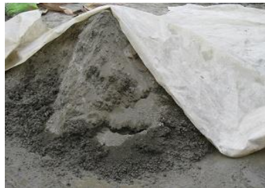
Foto No. 51 Protección de la arena contra la lluvia
