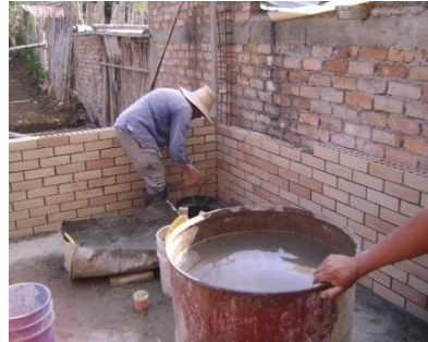
Foto No. 16 Mampostería PV (10 Orificios)
