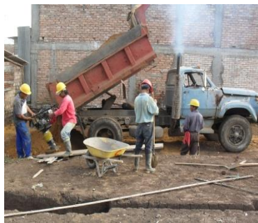
Foto No. 10 Material de Relleno
