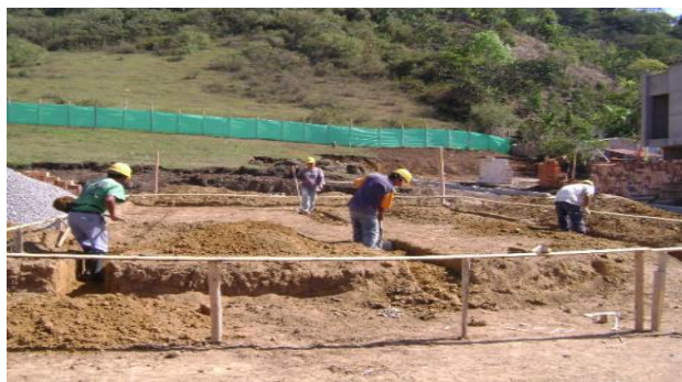
Foto No. 9 Excavaciones
