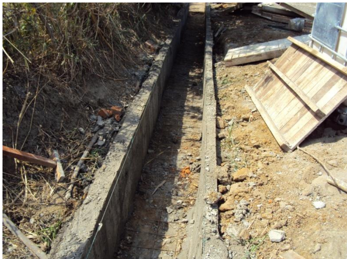
Foto 26. Construcción canal rectangular - Sección 3
