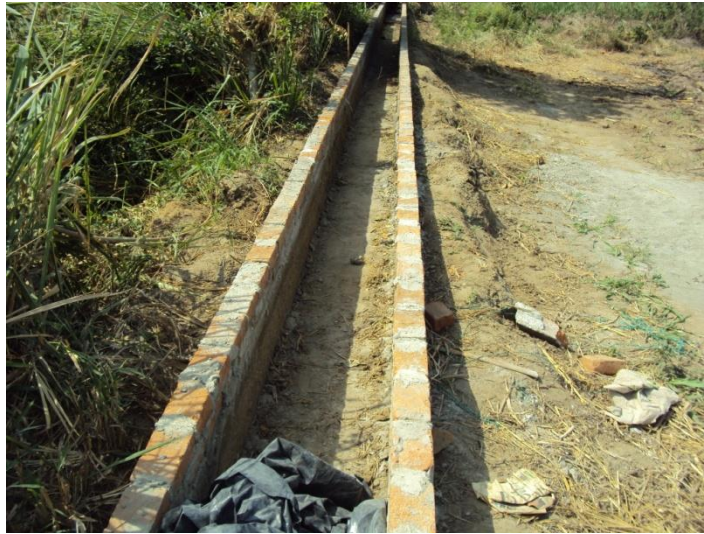
Foto 27. Levantar muros h=0.20 m - Sección 8
