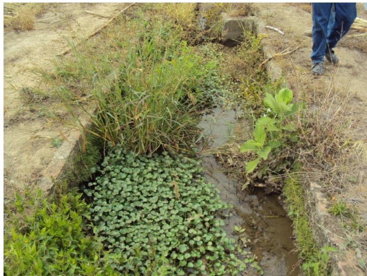
Foto 23. Limpieza de desarenador
