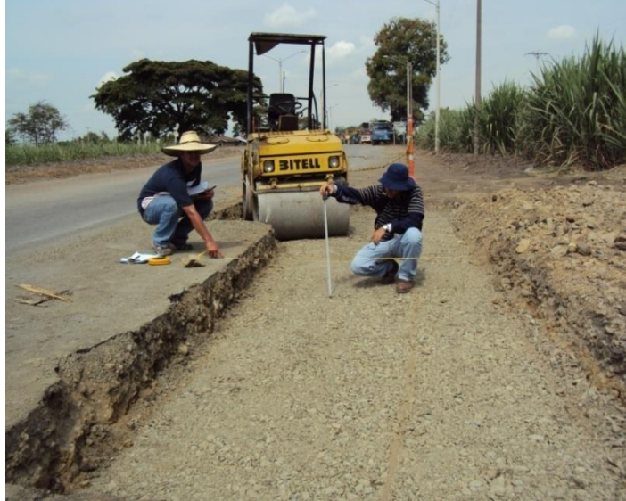
Foto 35. Chequeo de espesor base granular
