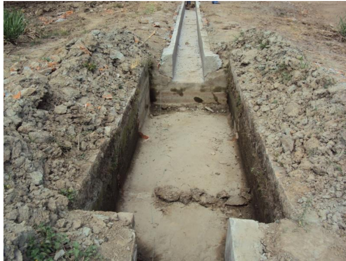
Foto 29. Limpieza de desarenador
