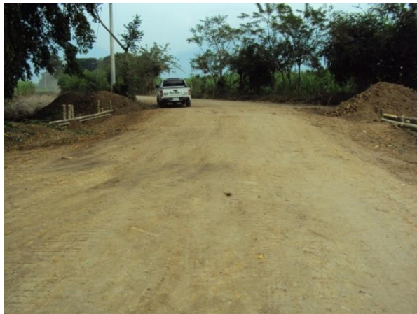
Foto 49. Paso provisional finalizado
