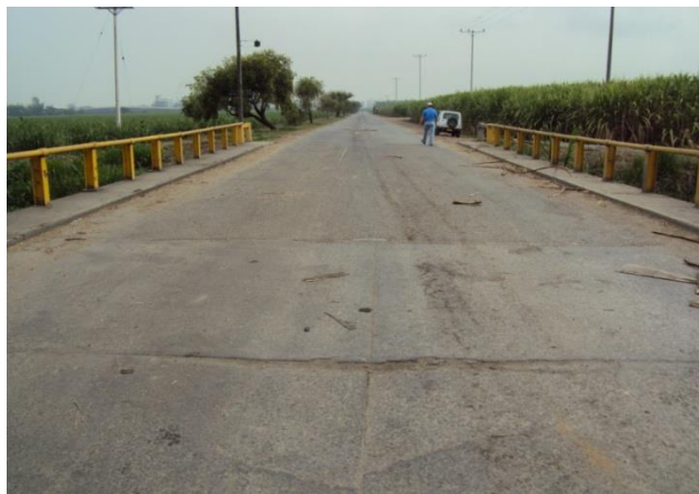
Foto 32. Puente sobre el río Párraga
