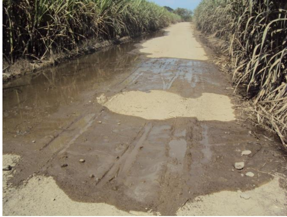
Foto 16. Vía San Marcos
