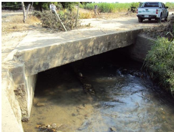
Foto 44. Pontón vía pública
