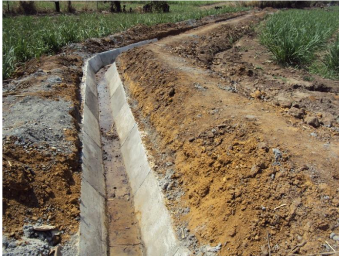
Foto 25. Construcción canal trapezoidal - Sección 1
