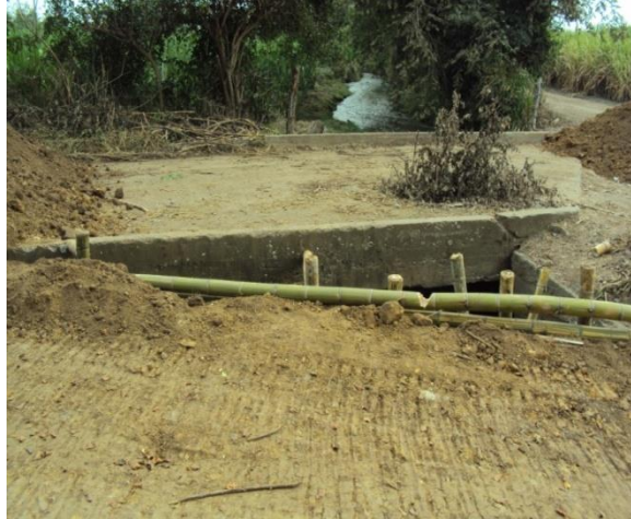
Foto 48. Construcción de paso aguas arriba del pontón
