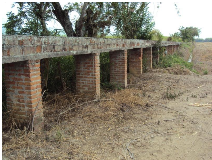
Foto 28. Repellar para impermeabilizar – Sección 5
