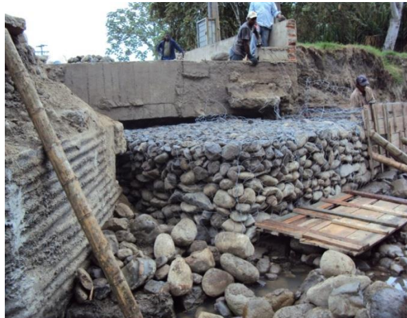
Foto 42. Construcción de gaviones
