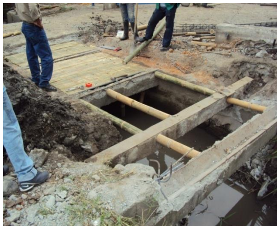
Foto 52. Construcción de losa
