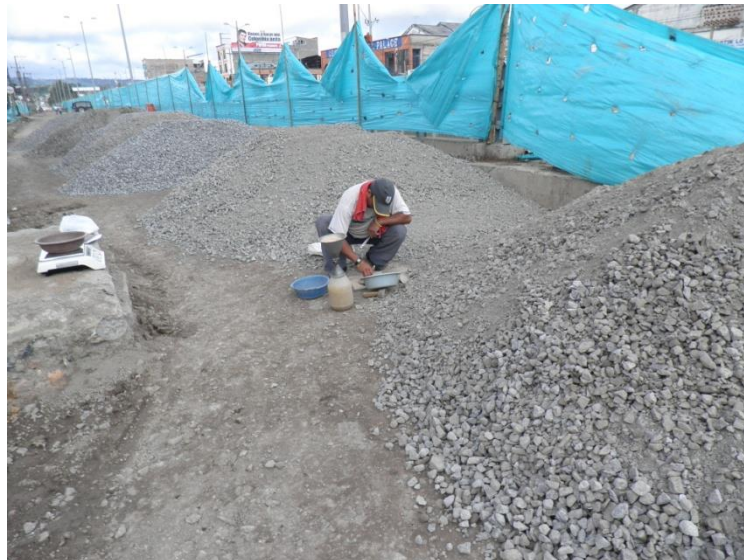
Fotografía No. 5 Acopio de material K0 + 482
