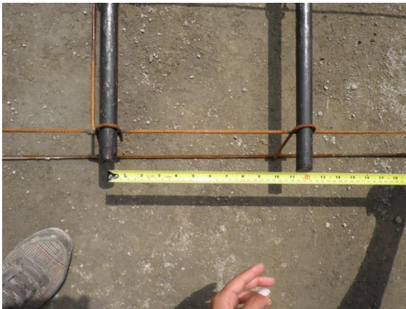
Fotografía No. 10 Chequeo separación dovelas
