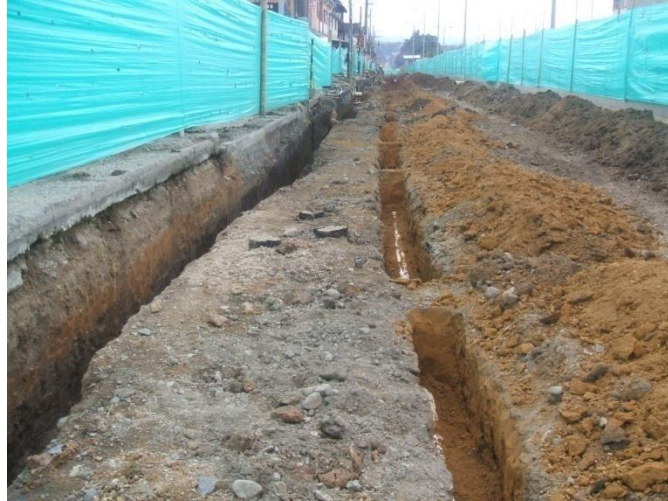
Fotografía No. 2 Excavación Tubería acueducto y alcantarillado K0 + 630
