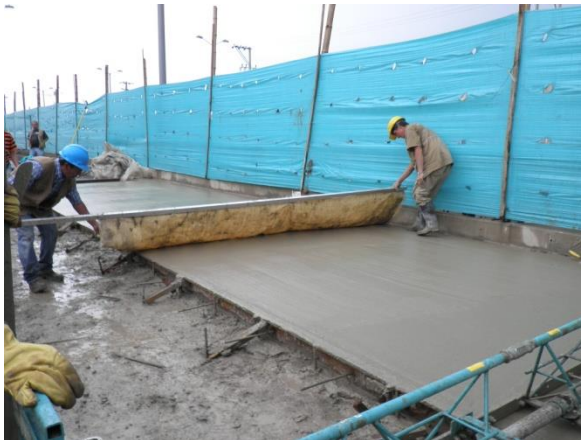
Fotografía No. 17 Microtexturizado K0 + 290
