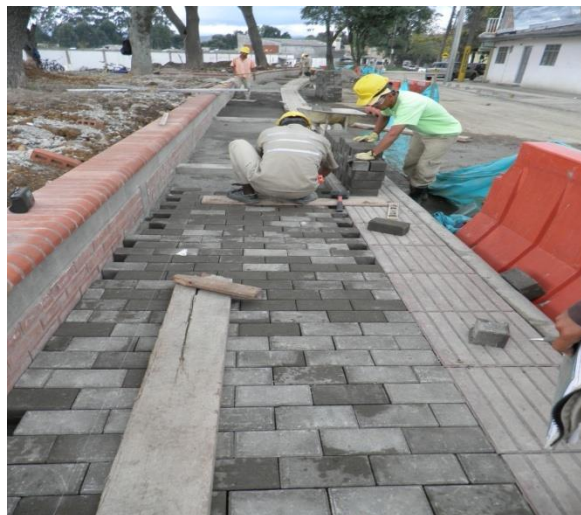
Fotografía No 32 Instalación piezas de adoquín Parque El Cadillal
