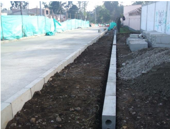
Fotografía No. 28 Instalación Sardinel
