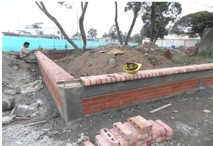
Fotografía No. 26 Instalación de alfajía Parque El Cadillal
