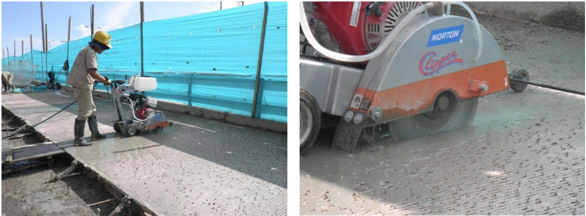
Fotografía No. 19 Corte de las juntas
