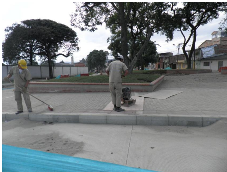
Fotografía No. 36 Compactación y barrido de adoquín Parque El Cadillal
