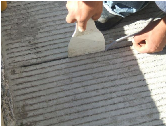
Fotografía No. 20 Sello de plástico no adherente de polietileno K0 + 250
