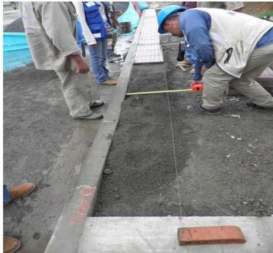
Fotografía No. 31 Instalación loseta guiadora Parque El cadillal
