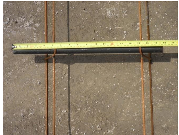
Fotografía No. 11 Chequeo longitud pasadores o dovelas
