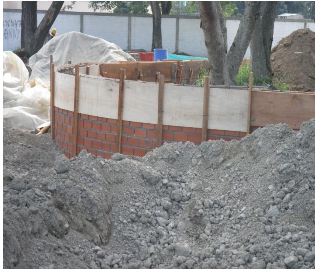
Fotografía No. 23 Formaleta Fundición viga de amarre Parque El Cadillal
