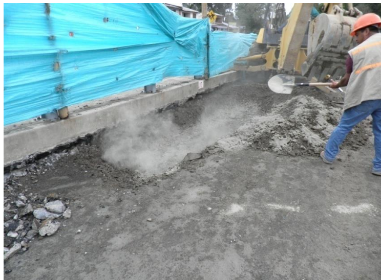
Fotografía No. 9 Estabilización con cemento K0 + 080
