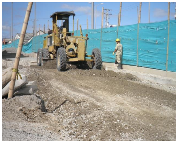
Fotografía No. 6 Extendido y conformación Sub-base K0 + 270
