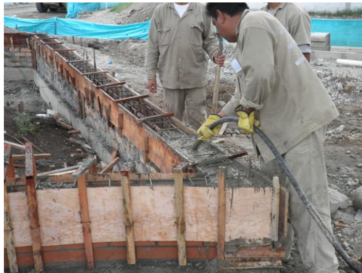
Fotografía No. 25 Clocación de concreto vigas de amarre Parque El Cadillal
