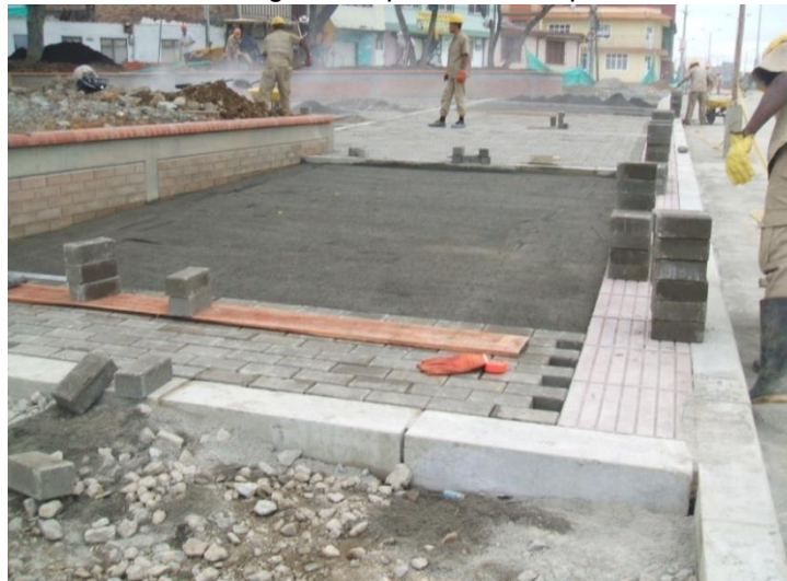
Fotografía No 30 Capa de arena enrasada y nivelada
