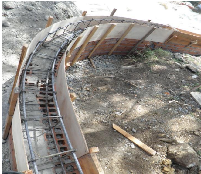
Fotografía No. 24 Acero de refuerzo jardineras Parque El Cadillal
