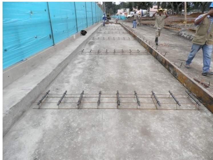
Fotografía No. 14 Ubicación refuerzo transversal K0 + 251 – K0 + 275
