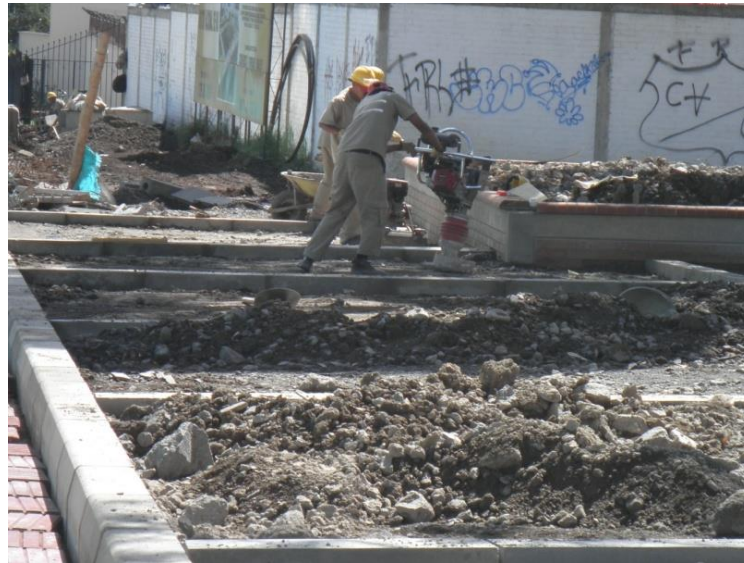
Fotografía No. 27 Nivelación capa de sub-base Parque El Cadillal
