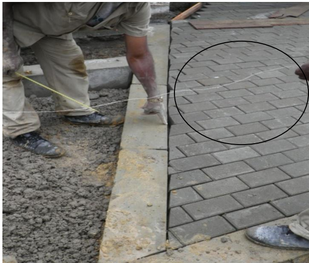
Fotografía No. 33 Malos remates piezas de adoquín Parque El Cadillal
