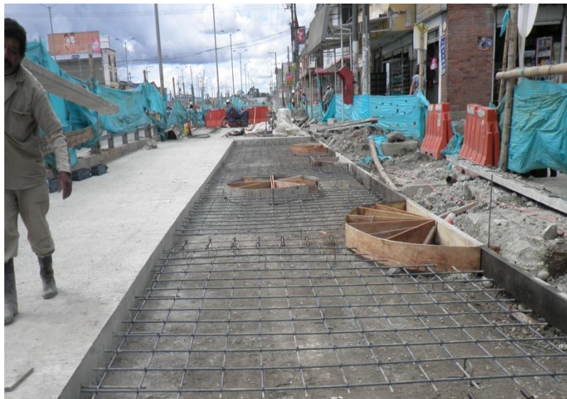
Fotografía No 15 Instalación parrillas de refuerzo K0 + 650
