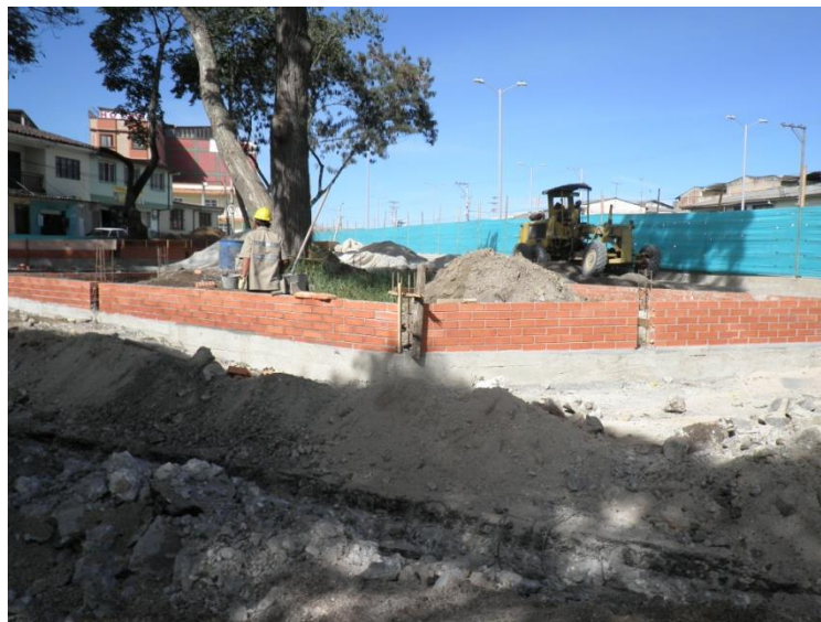
Fotografía No 22 Instalación mampostería Parque El Cadillal
