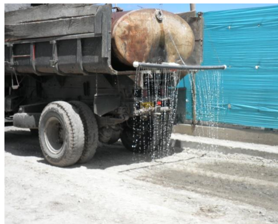
Fotografía No. 7 Humectación Sub-base granular K0 + 270
