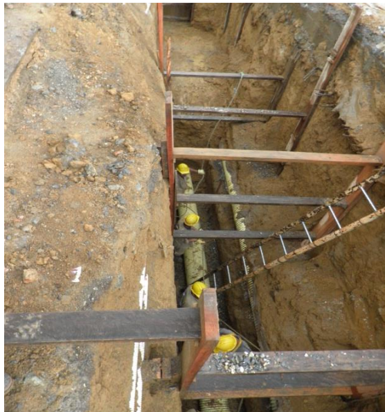
Fotografía No. 3 Instalación tubería alcantarillado K0 + 250
