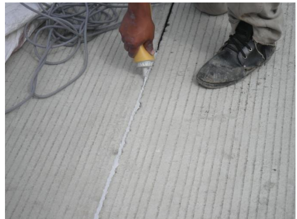
Fotografía No. 21 Sellamiento de la Junta con silicón K0 + 250
