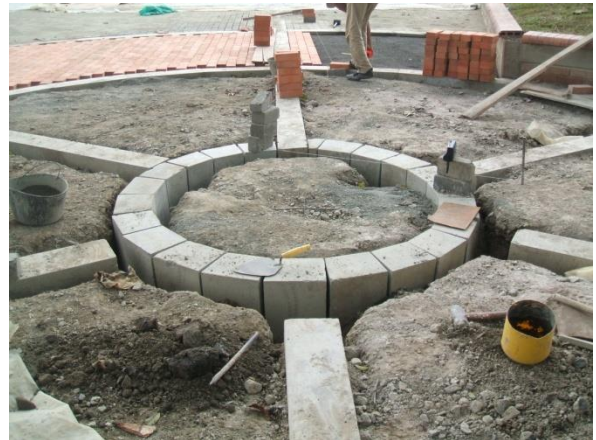
Fotografía No 29 instalación de Bordillo Parque El Cadillal
