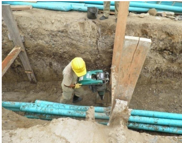
Fotografía No. 4 Compactación con saltarín Material de relleno alcantarillado
