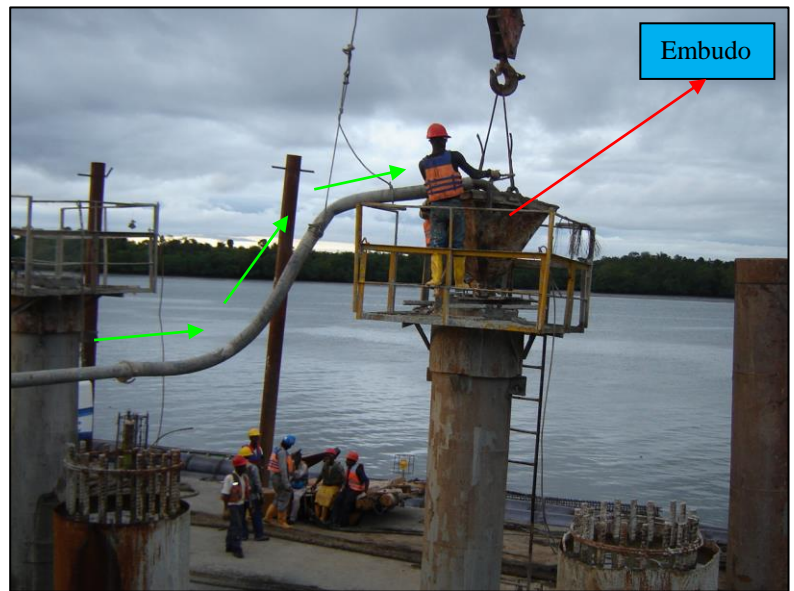
Fotografías 40 a 68 Proceso constructivo de un pilote in-situ de extracción de sección circular con camisa perdida
