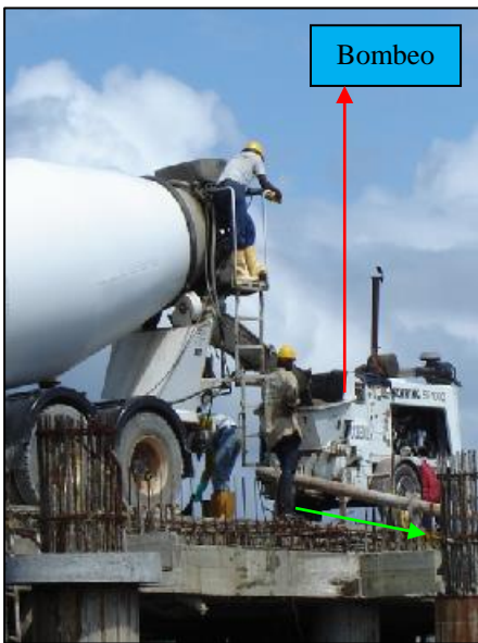
Fotografías 40 a 68 Proceso constructivo de un pilote in-situ de extracción de sección circular con camisa perdida
