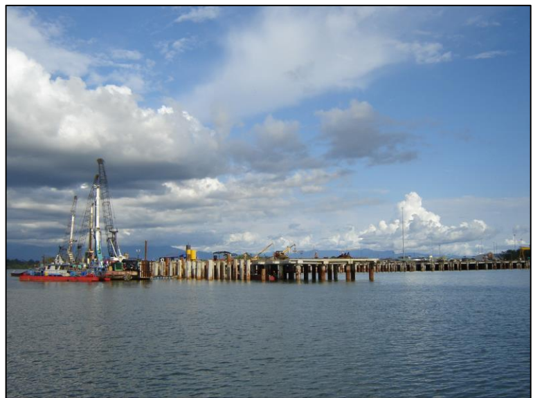
Fotografías 79 a 96 Estado de la obra
