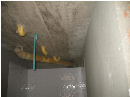
**Foto 94. Tubería descolgada en el baño.**
