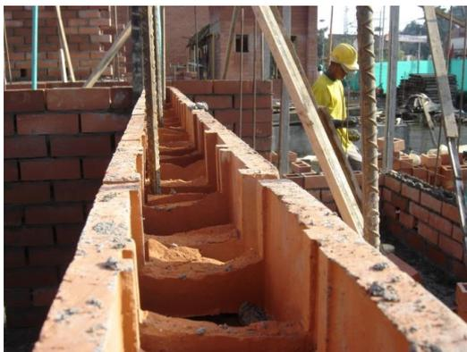
Foto 28. Colocación ladrillo viga-bloque
