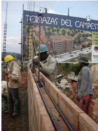
Foto 62. Viga de refuerzo con 2 barras de ½ pulgada.
