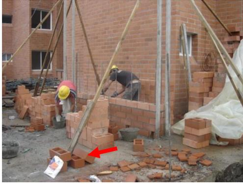
**Foto 16. Aseguramiento de bastidores con ladrillos.**
