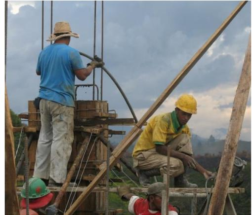
Foto 147. Vibrado del concreto.
