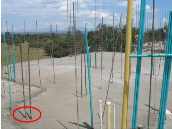
Foto 59. Refuerzo vertical de las dovelas embebido en la losa.
