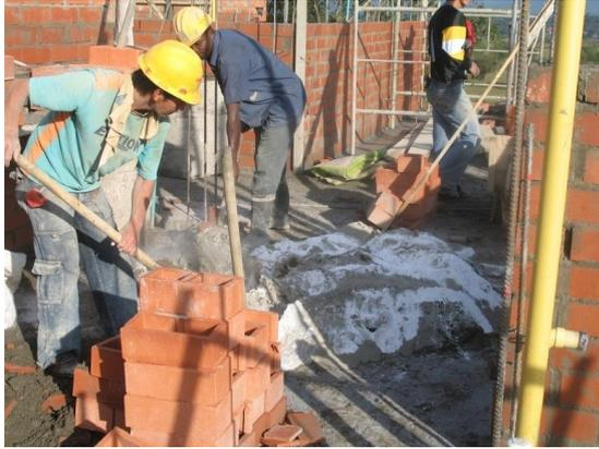
Foto 55. Mezclado en seco de la arena con la cal.
