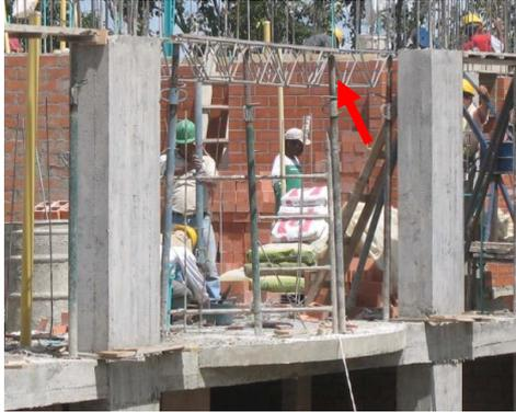
**Foto 84. Colocación de encofrado de las vigas perimetrales.**
