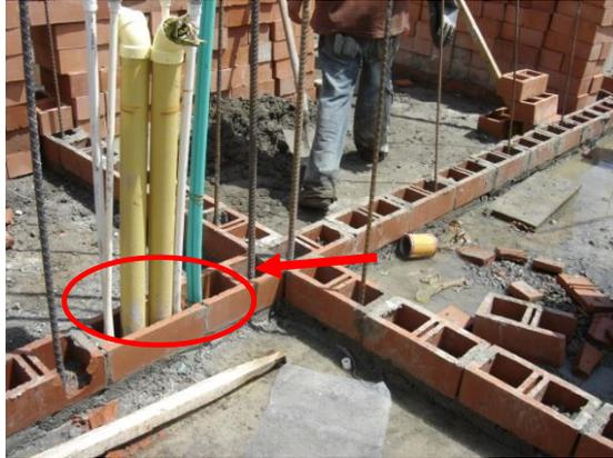
**Foto 23. Tubería hidrosanitaria y eléctrica debidamente centradas.**
