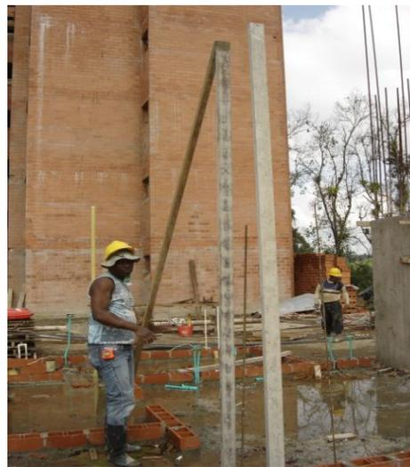
Foto 15. Colocación bastidores de madera
