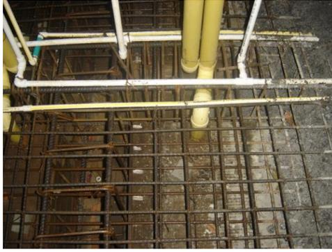
**Foto 93. Tubería de agua potable.**
