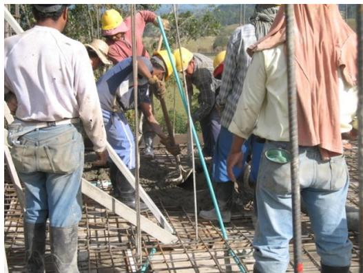
**Foto 110. Regado del concreto con palas.**
