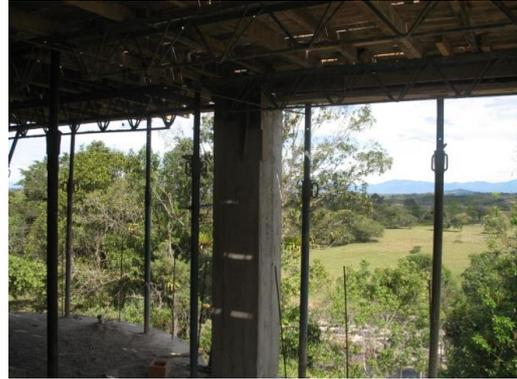
**Foto 83. Colocación de encofrado.**
