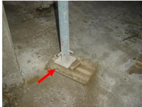
**Foto 85. Fijación de los puntales a la losa.**
