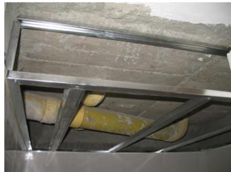
**Foto 95. Baño con esqueleto para poner el cielo falso.**
