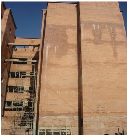
**Foto 44. Fachada antes de limpiar e impermeabilizar.**
