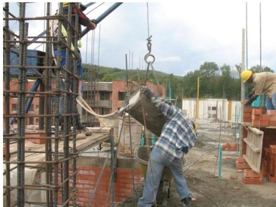
**Foto 146. Descargue del concreto en carretillas.**
