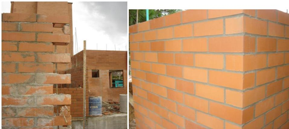
Foto 6. Construcción muro en traba.
