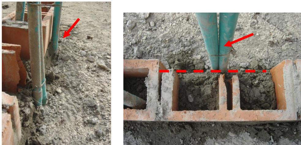
**Foto 76. Tubería que quedó desalineada, durante la construcción del a losa.**
