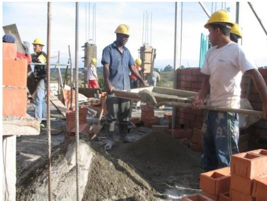
Foto 56. Tamizado de la mezcla arena-cal.
