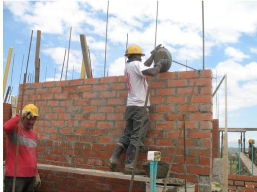
Foto 37. Colocación y compactación del grouting en las celdas superiores.
