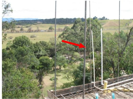
**Foto 109. Demarcación de los niveles para fundir la losa.**
