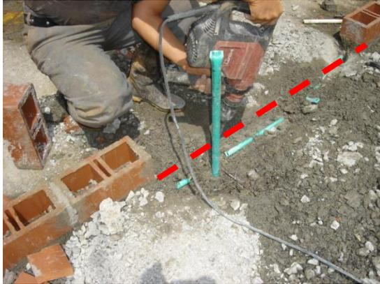
**Foto 77. Rompimiento superficial de la losa para reubicación de tubería.**
