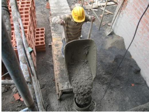
**Foto 145. Transporte del concreto con el balde de la pluma grúa.**
