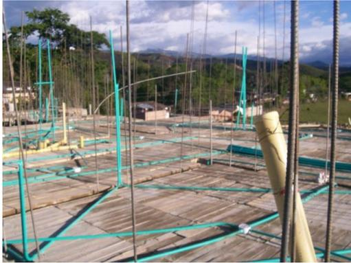
Foto 89. Instalación de tubería para redes eléctricas.
