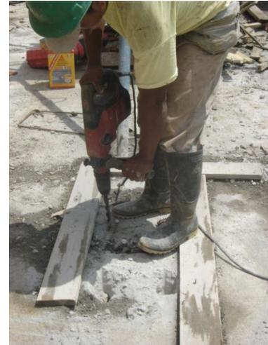
Foto 159. Anclaje de barras en la posición correcta
