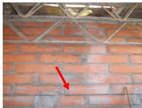
Foto 81. Cimbrado de los muros para colocación de la formaleta.
