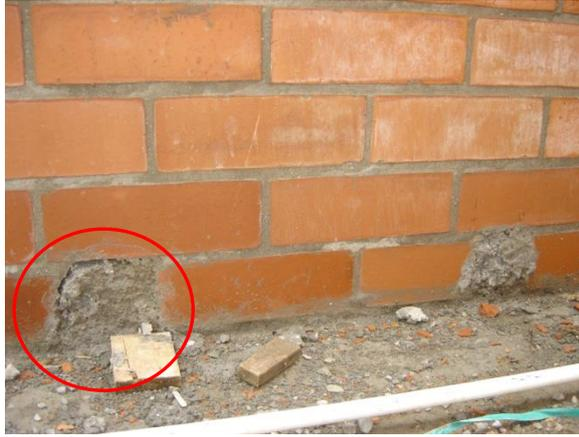
**Foto 31. Ventana de inspección después del llenado con grouting**
