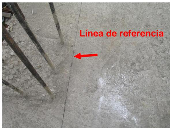
Foto 9. Línea de referencia para la ubicación de muros.
