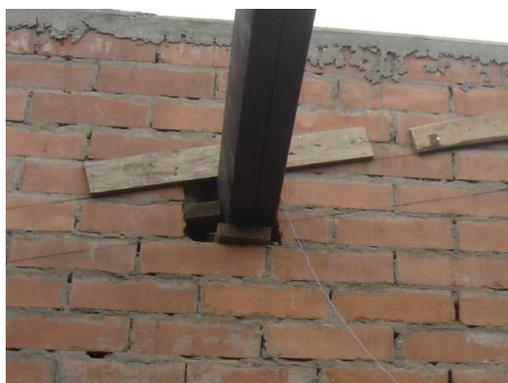
Foto 182. Colocación de perlines sobre el muro con cuñas de madera.
