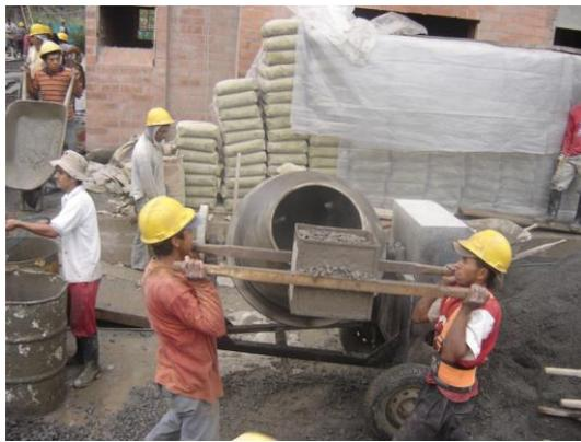
**Foto 144. Mezclado de los componentes del concreto.**
