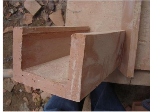
Foto 47. Unidad de mampostería Viga-bloque luego de quitar las 2 pestañas y lista para colocar.
