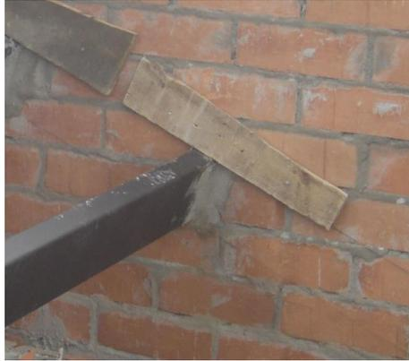
Foto 184. Relleno de los apoyos del perlin con mortero.
