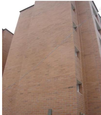
**Foto 45. Fachada después de limpiar e impermeabilizar.**
