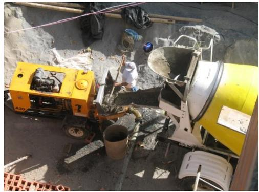
Foto 105. Descarga del concreto sobre la tolva de la bomba.
