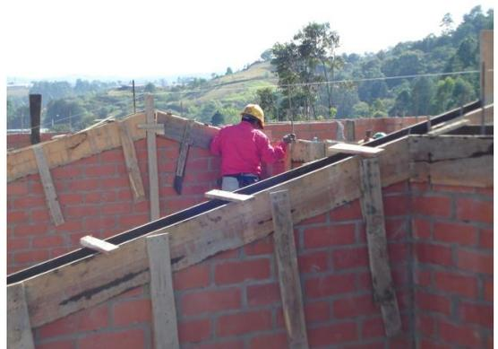
**Foto 180. Ubicación de los anclajes para los perlines.**
