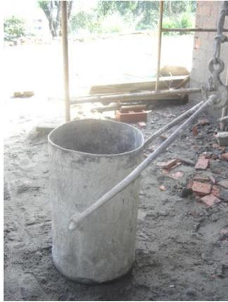
Foto 65. Recipiente utilizado para transportar la arena por la pluma grúa.
