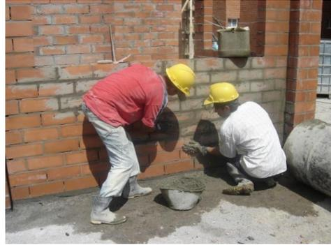
Foto 38. Revitado del muro.
