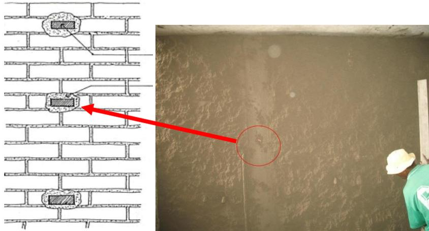
Foto 164. Colocación de puntos guías.
