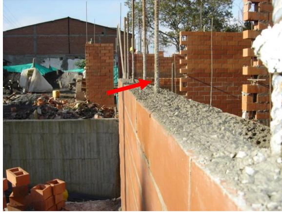
Foto 34. Continuidad del acero de refuerzo vertical por la viga.
