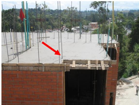
**Foto 10. Continuidad del refuerzo vertical de los muros a través de la losa.**
