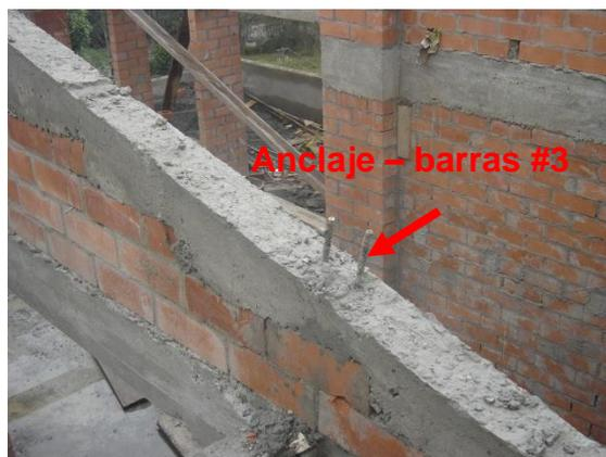
Foto 181. Anclaje para soldar el perlin.
