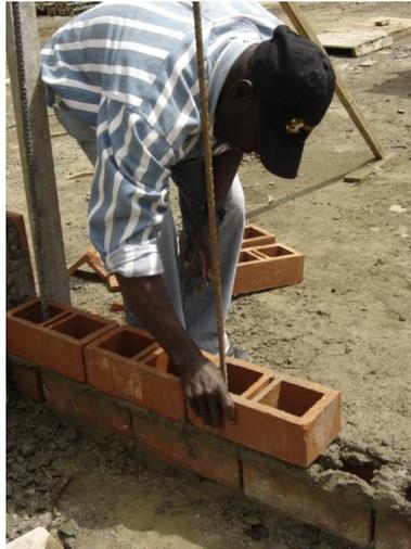
Foto 25. Colocación de la segunda hilada de ladrillos.
