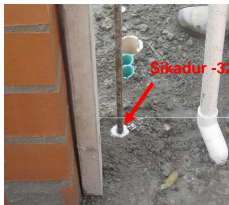
Foto 11. Anclaje del refuerzo vertical.
