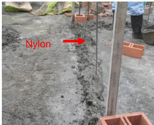
Foto 20. Colocación del mortero de pega para la primera hilada de ladrillos
