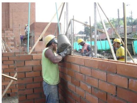
Foto 30. Llenado de celdas con mortero de inyección (grouting)
