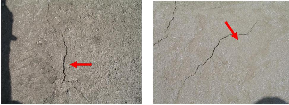
Foto 132. Presencia de fisuras luego de la fundición.
