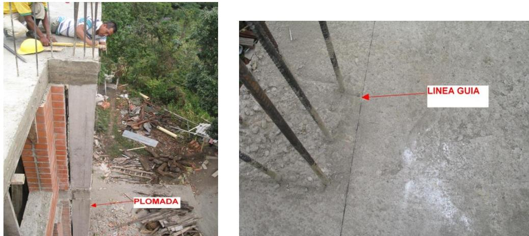
Foto 134. Cimbrado de las columnas sobre la losa.
