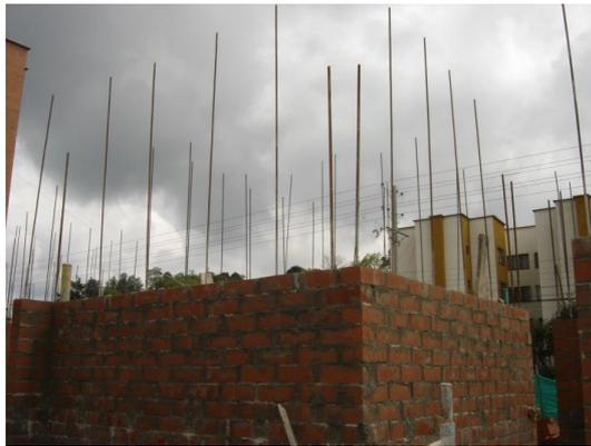
**Foto 36. Colación del refuerzo vertical después de la hilada numero 11.**
