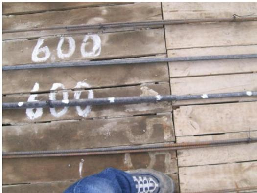
Foto 101. Marcas con pintura para la colocar el refuerzo de losa en la otra dirección.
