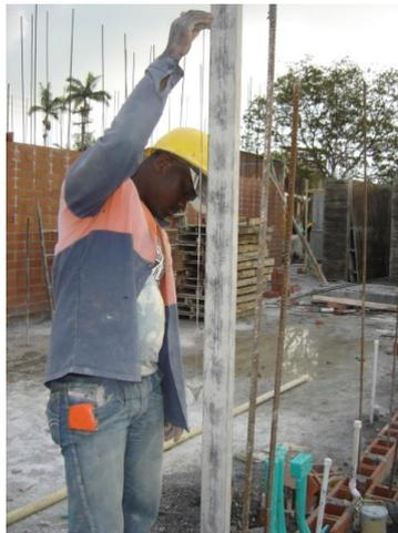
**Foto 17. Verificación de la verticalidad de los codales.**
