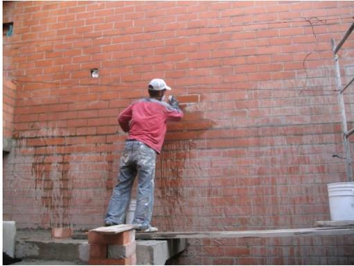
**Foto 43. Limpieza del muro con ácido nítrico.**
