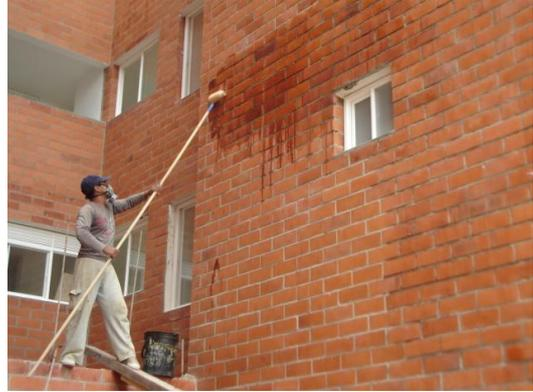
**Foto 42. Aplicación de impermeabilizante**
