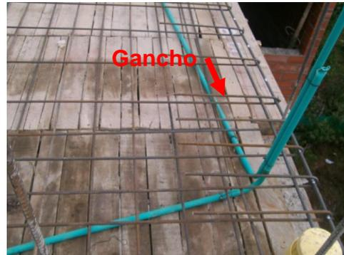
Foto 98. Colocación refuerzo de losa en una dirección.
