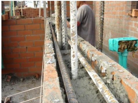
**Foto 33. Colocación de las barras de  $\frac{1}{2}$  pulgada en la viga.**
