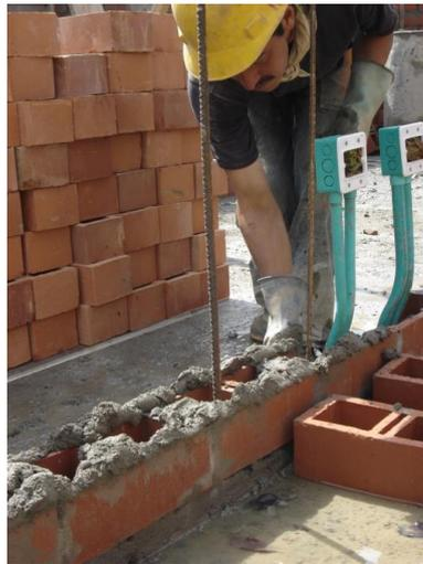
**Foto 24. Aplicación del mortero de pega en las juntas horizontales y verticales.**
