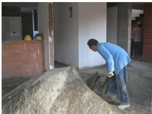
Foto 173. Mezcla homogénea en seco.
