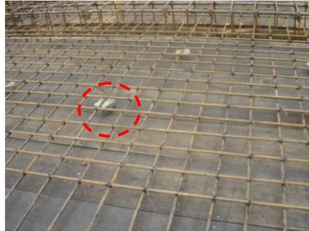
**Foto 104. Colocación de panelas para garantizar recubrimiento.**
