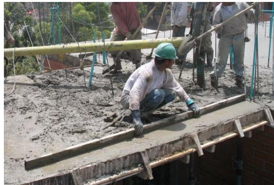
**Foto 113. Enrase del concreto con el codal.**
