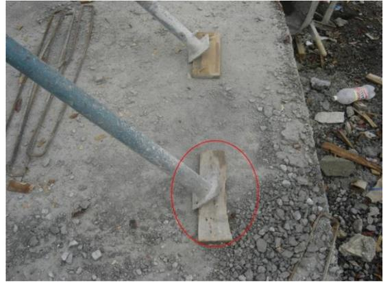
Foto 139. Aseguramiento de los puntales con la losa.
