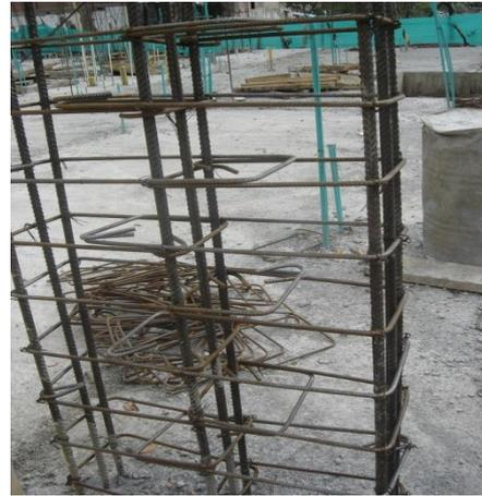
Foto 136. Colocación de estribos.
