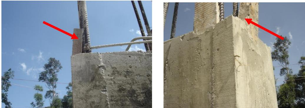
Foto 143. Recubrimientos para el refuerzo de columnas.
