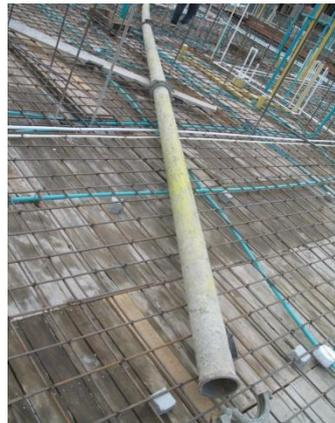
Foto 126. Tubería para bombear el concreto.
