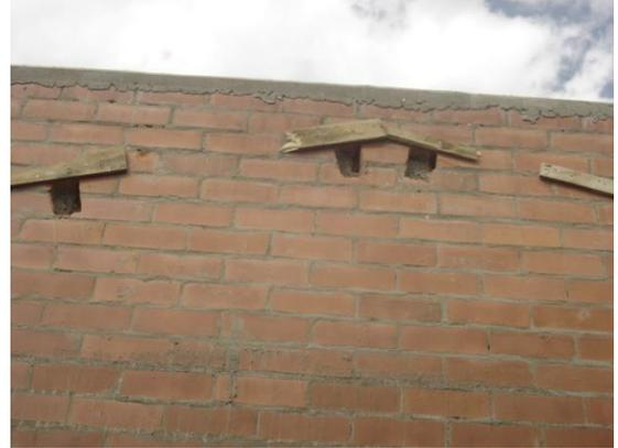
**Foto 179. Apoyos de perlines sobre el muro.**
