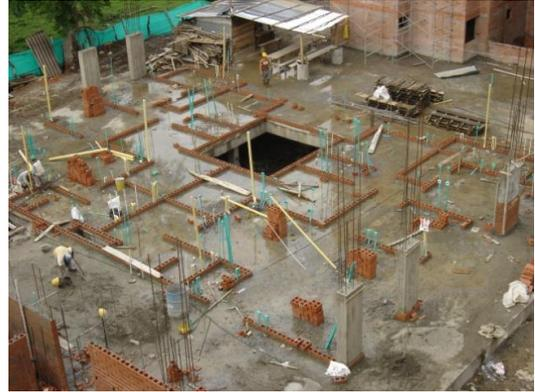
Foto 13. Replanteo de muros primer piso.
