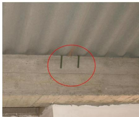
**Foto 202. Gancho para asegurar teja con viga.**
