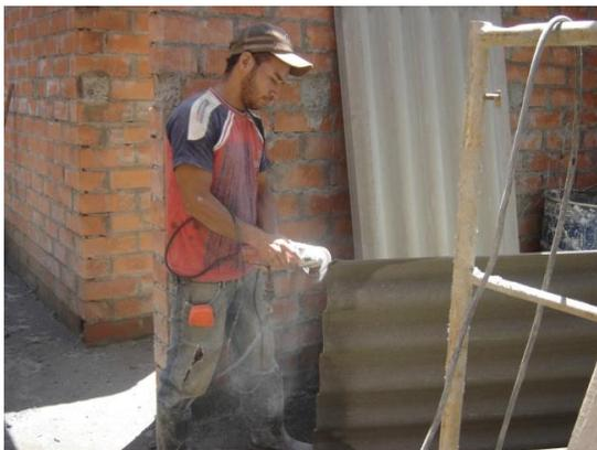
Foto 198. Despunte de tejas con pulidora.
