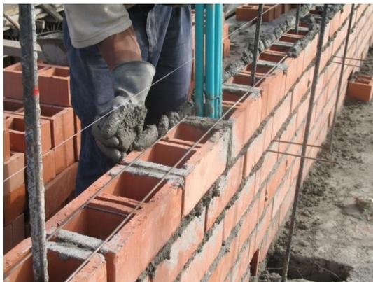
Foto 26. Refuerzo horizontal (escalerilla de 4mm)
