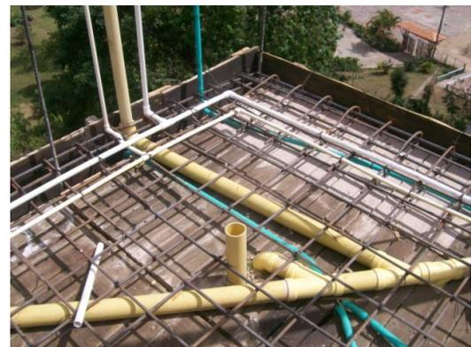
Foto 100. Refuerzo de losa en dos direcciones.
