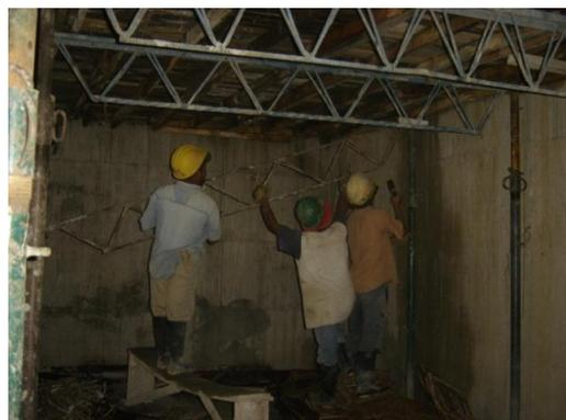
Foto 117. Desencofrado losa de concreto.
