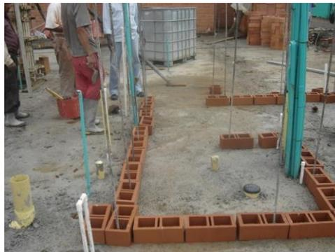
**Foto 12. Modulación de los ladrillos de la primera hilada**
