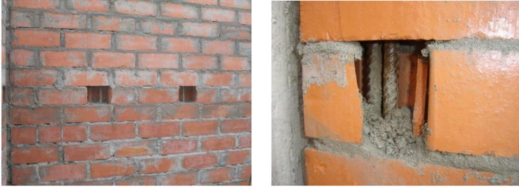
**Foto 35. Ventanas de inspección en la hilada numero 12.**
