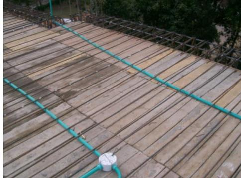
Foto 99. Colocación refuerzo de losa en una dirección.
