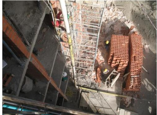
La tubería por la que se conducía el concreto era rígida excepto en el extremo por donde salía el concreto, donde tenía una tubería flexible (trompa de elefante), que permitía que los obreros la trasladaran continuamente para poder hacer una distribución uniforme del concreto y en lo posible cerca de su posición final con el fin de evitar la segregación.<sup>35</sup>
