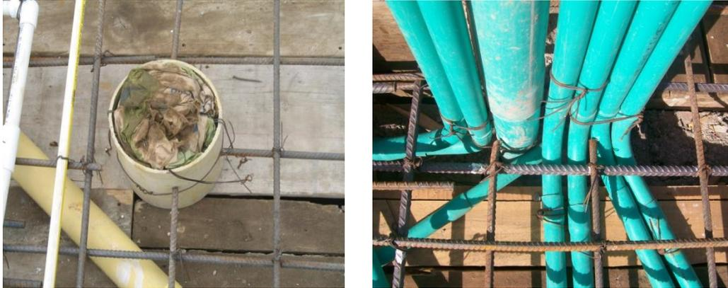
**Foto 130. Corte de barras para colocación de un bajante.**
