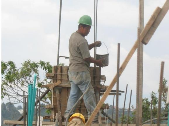
Foto 148. Vaciado del concreto.
