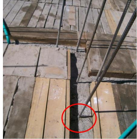
Foto 58. Continuidad del refuerzo vertical a través de la losa de entrepiso.
