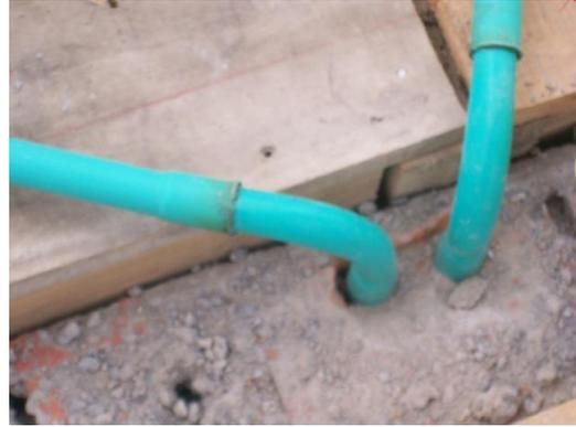
Foto 88. Tubería interruptores-lámpara, embebida en dovelas de los muros de piso anterior.
