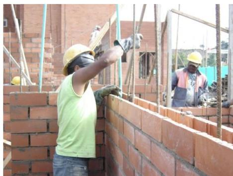
Foto 29. Compactación de las celdas llenadas con grouting
