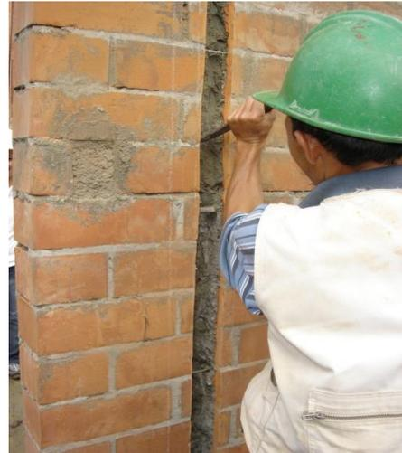
**Foto 72. Rompimiento del muro.**
