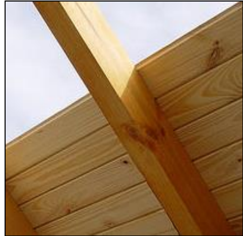
Ilustración 80. Instalación del machimbre de manera interna o externa.
