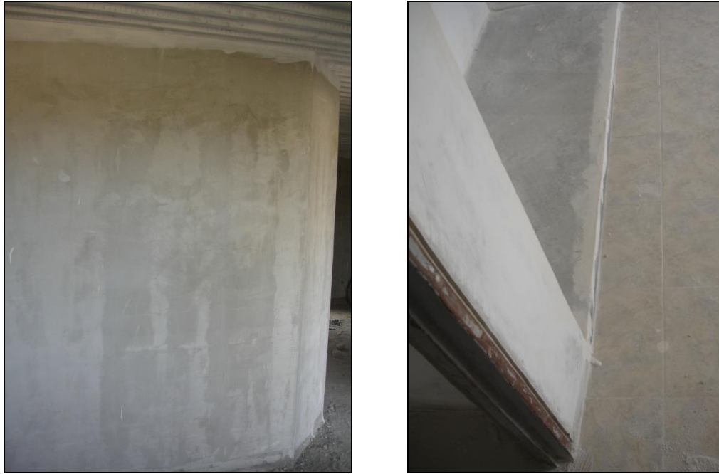
Ilustración 25. Paredes estucadas con bordes terminados y dilataciones de puertas perfectas.
