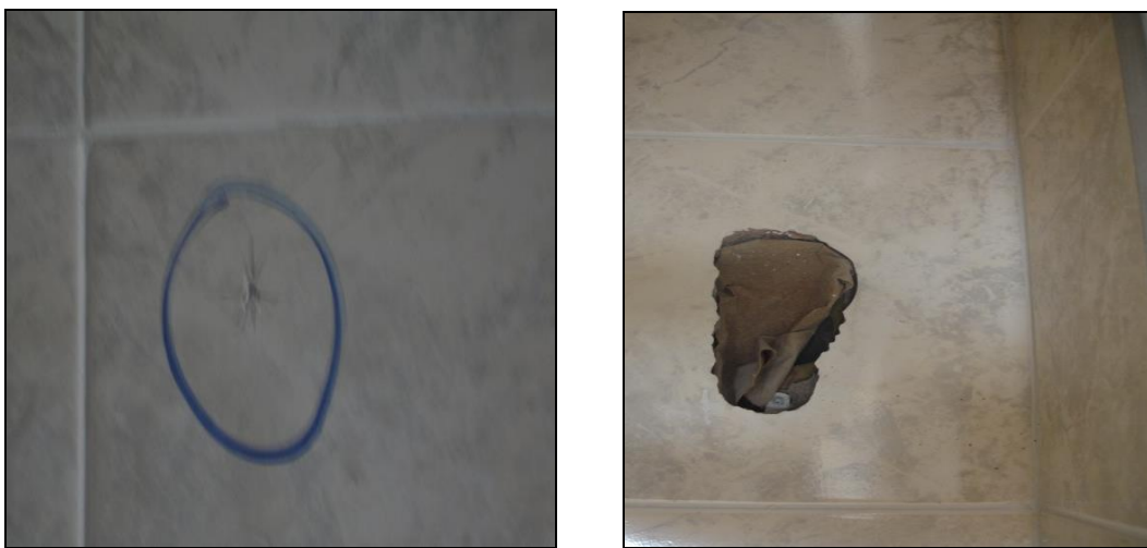
Ilustración 36. Piezas despicadas o mal cortadas.
