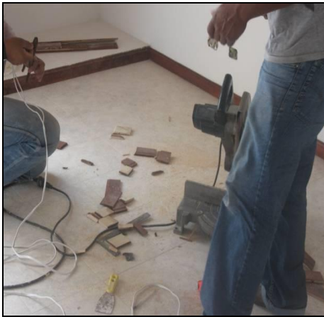
Ilustración 39. Colocación de guarda escobas.
