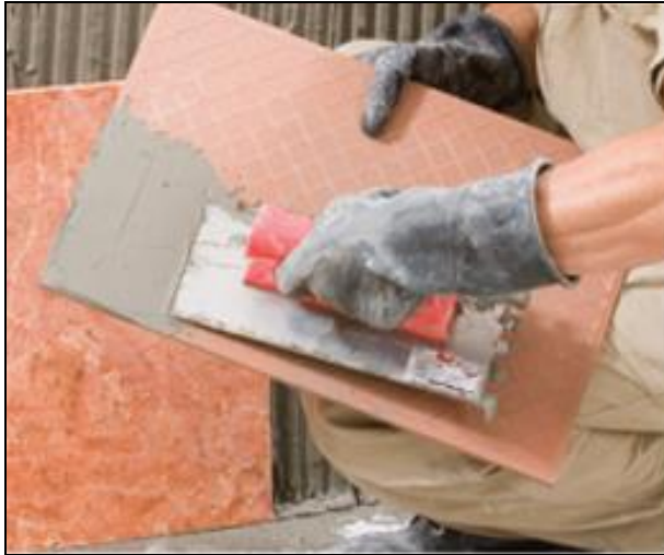
Ilustración 101. Aplicación de la mezcla sobre la pieza de cerámica.
