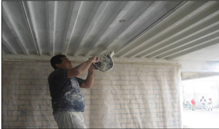
Ilustración 84. Aplicación de la perlita manualmente.
