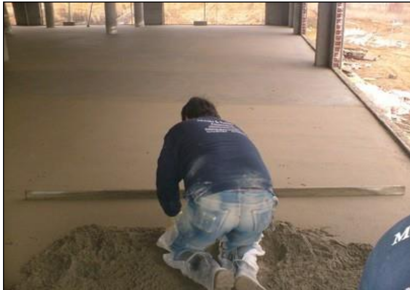
Ilustración 87. Vaciado del mortero y nivelación.
