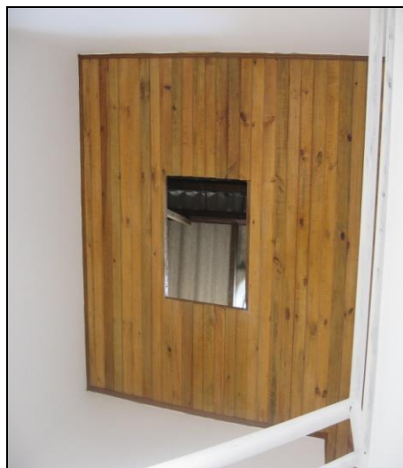
Ilustración 21. 22.a Instalación del machimbre terminada.
