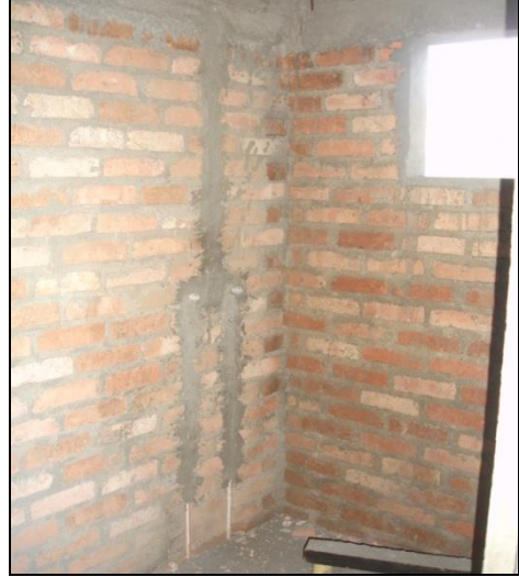
Ilustración 11. Superficies listas para repellar
