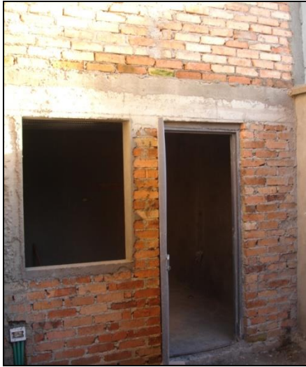
Ilustración 11. Superficies listas para repellar
