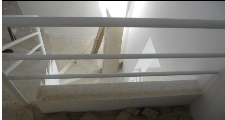
Ilustración 51. Pasamanos instalados.
