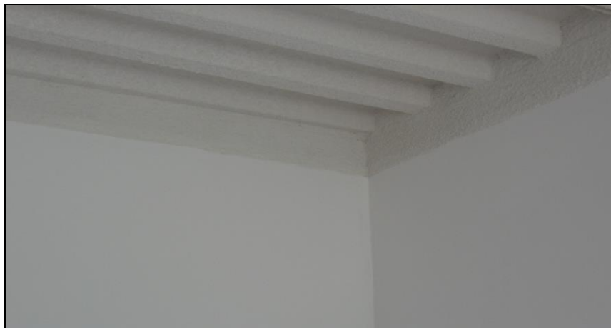
Ilustración 85. Cielo raso en perlita terminado.
