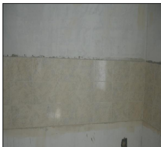
Ilustración 34. Enchape de baño y cocina terminados.
