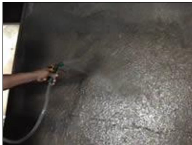
Ilustración 64. Curado del repello.
