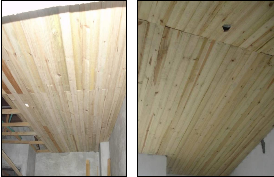
Ilustración 18. Supervisión del trabajo 19a. Instalación completa.
