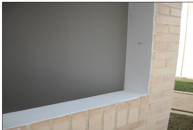
Ilustración 68. Muros y carteras completamente estucadas.
