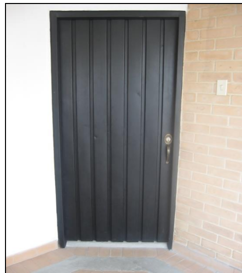
Ilustración 45a. Puerta terminada.
