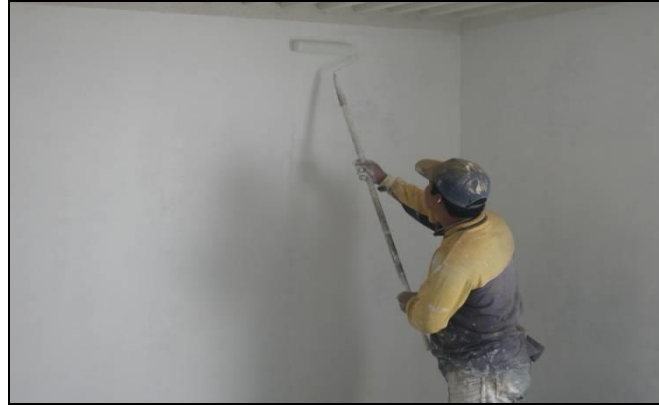
Ilustración 45. Aplicación de pintura en muros interiores.
