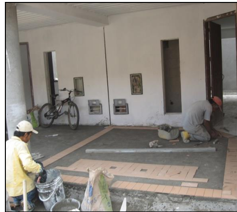
Ilustración 30. Enchape de pisos interiores y exteriores.
