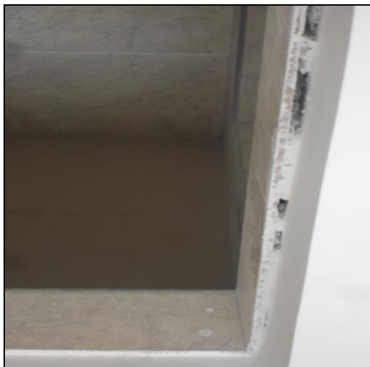
Ilustración 38. Piezas mal adheridas Ilustración 39a. Piezas correctamente adheridas.
