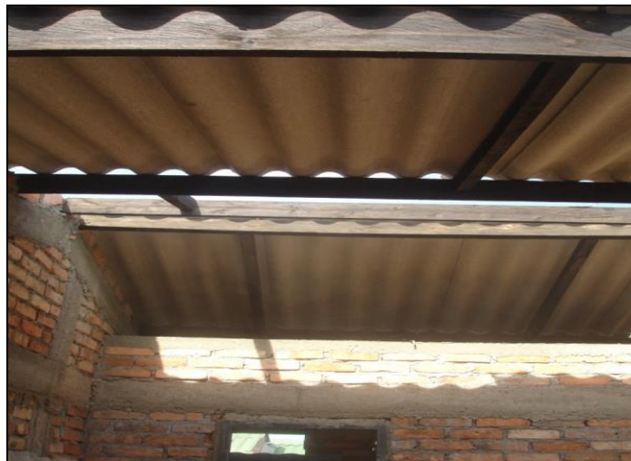
Ilustración 9. Colocación de las tejas
