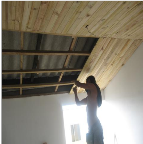
Ilustración 80. Instalación del machimbre de manera interna o externa.
