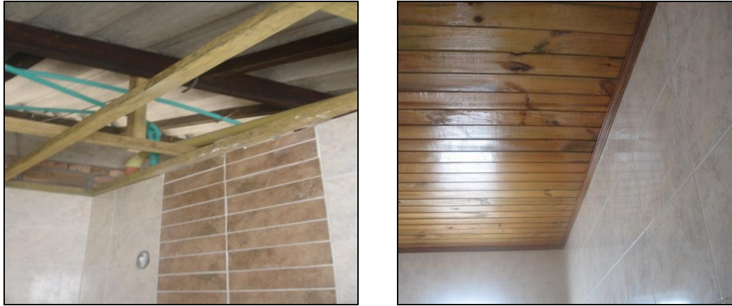
Ilustración 22. Instalación del machimbre en baños.
