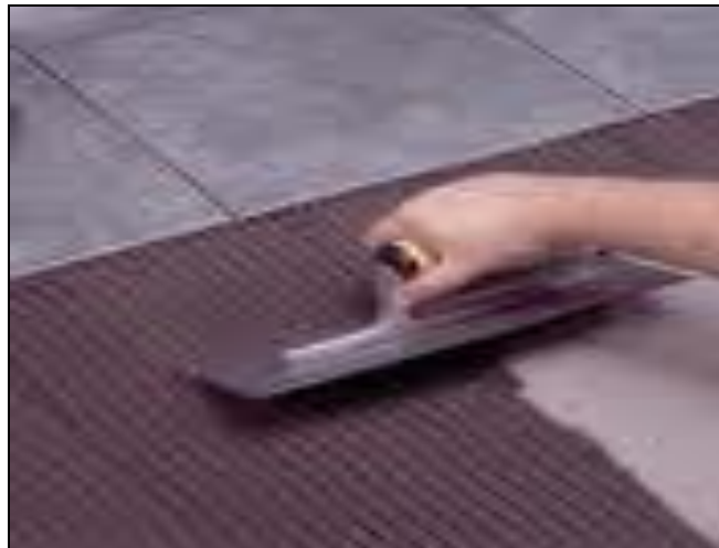
Ilustración 92. Aplicación del mortero de pega con llana metálica.
