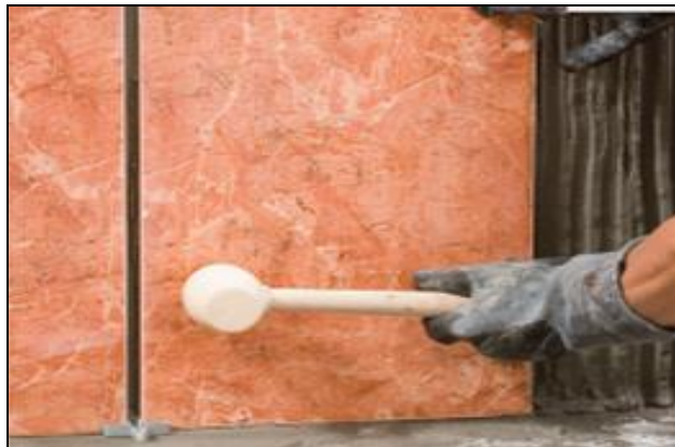
Ilustración 102. Ajuste de las piezas con el martillo de caucho.
