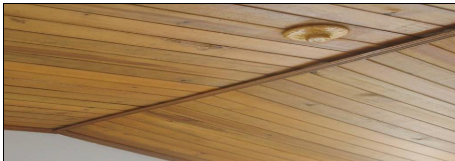
Ilustración 19. Instalación completa de tapa luces.
