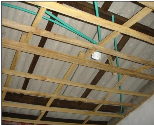
Ilustración 14. Estructura en madera instalada correctamente.
