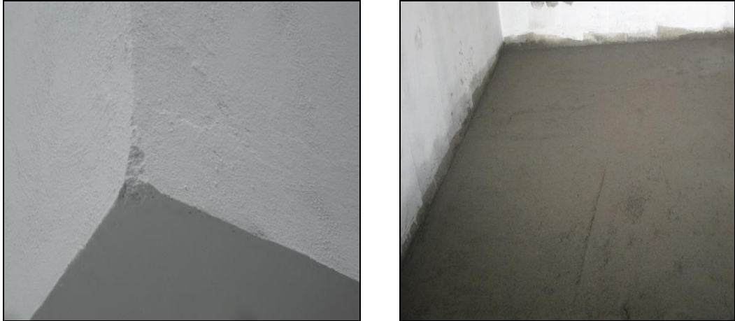
Ilustración 27. Nivelación del piso terminada.
