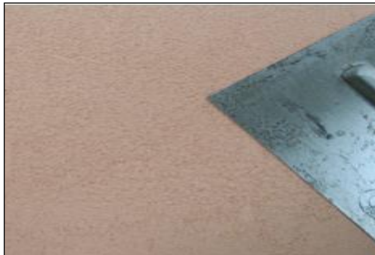
Ilustración 66. Superficie lista para ser estucada.
