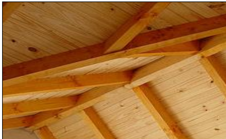
Ilustración 82. Listones sosteniendo el machimbre internamente.
