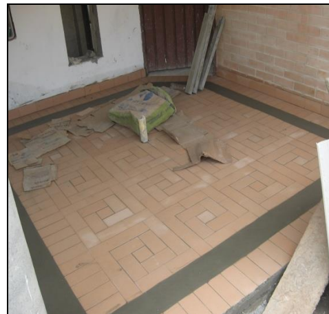
Ilustración 32. Enchape de habitación y garaje terminado.
