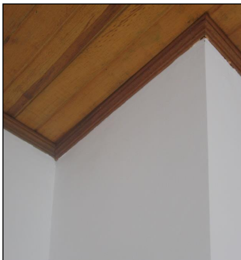
Ilustración 21. 22.a Instalación del machimbre terminada.
