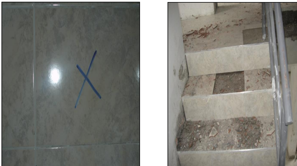
Ilustración 35. Piezas marcadas y retiradas para cambiar.
