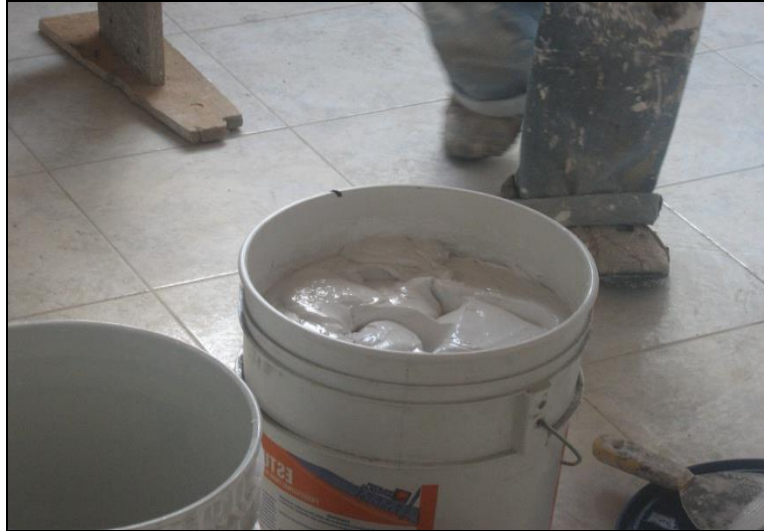
Ilustración 23. Estuco usado en paredes.
