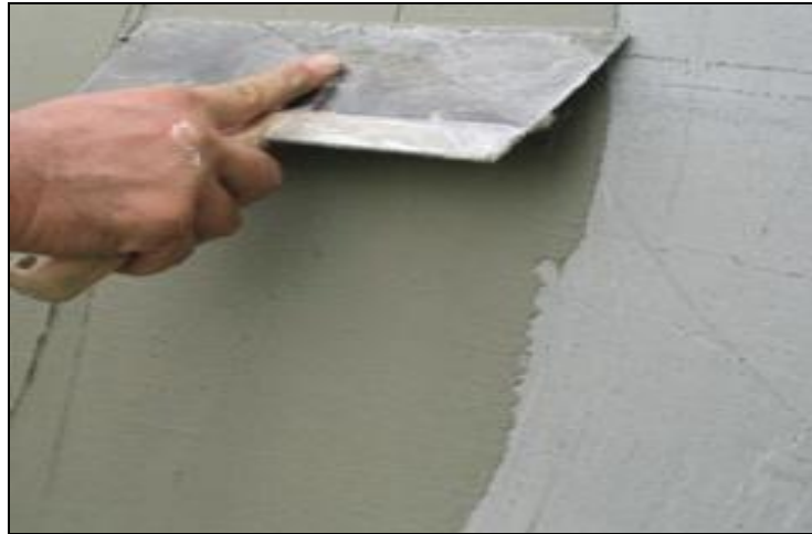
Ilustración 67. Aplicación del estuco.
