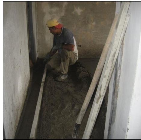
Ilustración 27a. Nivelación del piso
