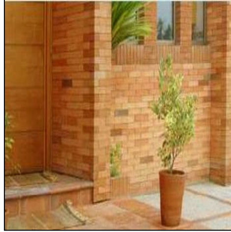
Ilustración 107. Enchapes de fachadas.
