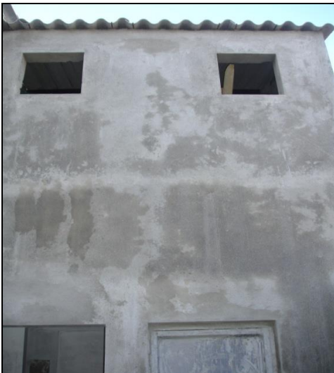
Ilustración 12. Paredes repelladas
