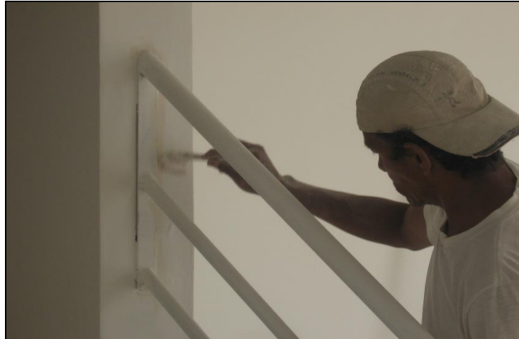
Ilustración 47. Aplicación de pintura en pasamanos.
