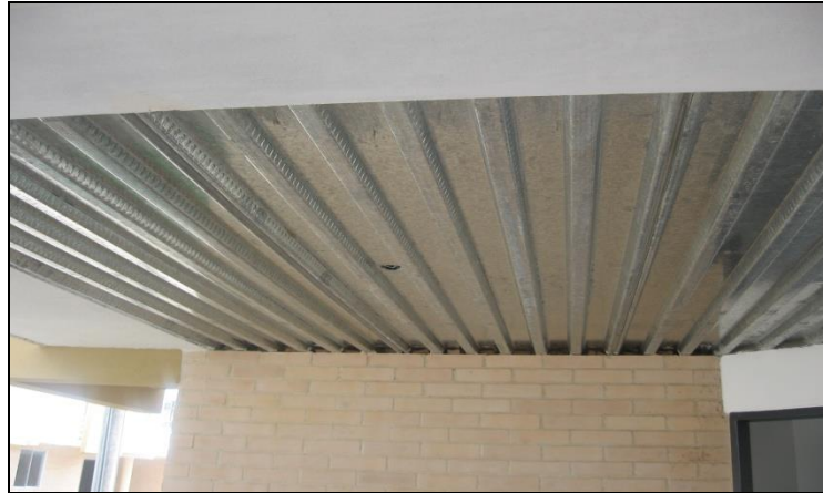
Ilustración 40. Cielo raso listo para la aplicación del producto.
