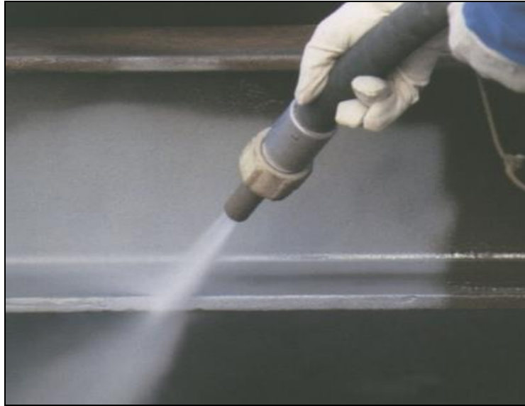
Ilustración 78. Aplicación de la pintura con compresor.
