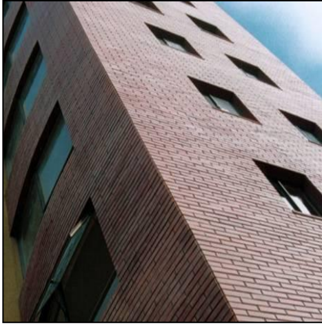
Ilustración 107. Enchapes de fachadas.
