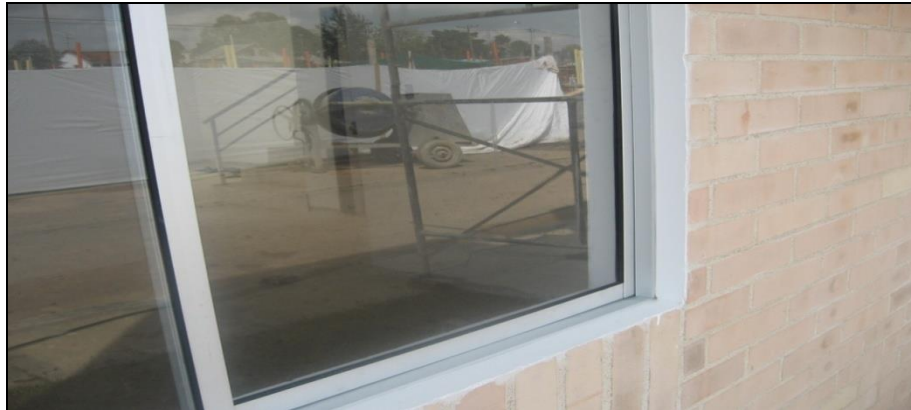
Ilustración 50. Ventanas instaladas correctamente.
