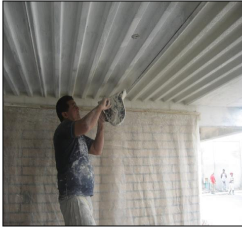
Ilustración 41. Aplicación del producto y cielo raso terminado.
