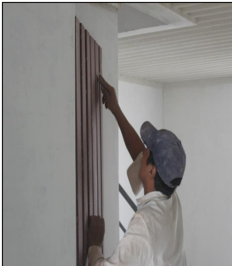
Ilustración 44. Limpieza de la puerta metálica
