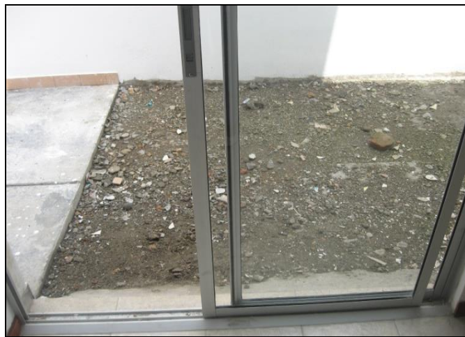
Ilustración 49. Puerta ventana primer piso.
