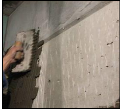
Ilustración 33. Preparación de mortero Ilustración 34a. Picado del muro y aplicación.
