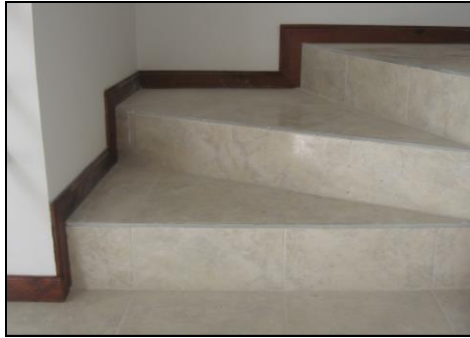
Ilustración 98. Pirlanes en las escaleras.
