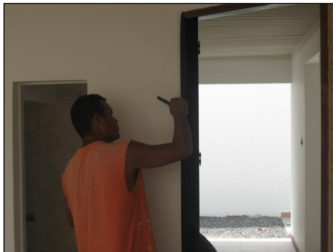
Ilustración 77. Aplicación de pintura en recintos cerrados.
