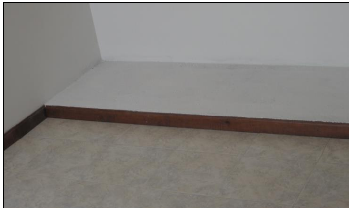
Ilustración 99. Guarda escoba instalado.
