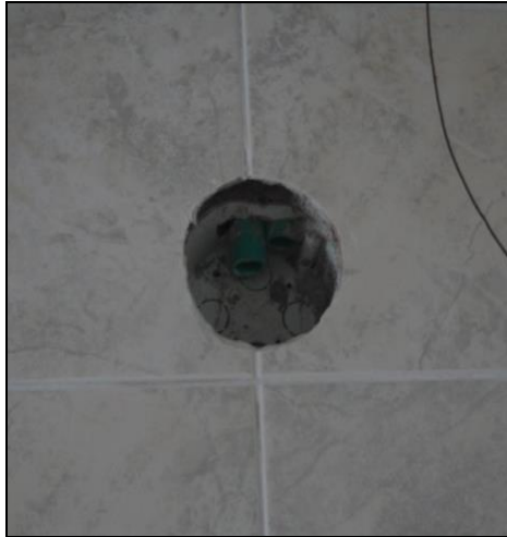
Ilustración 37. Piezas cortadas correctamente Ilustración 38a. Piezas mal colocadas.
