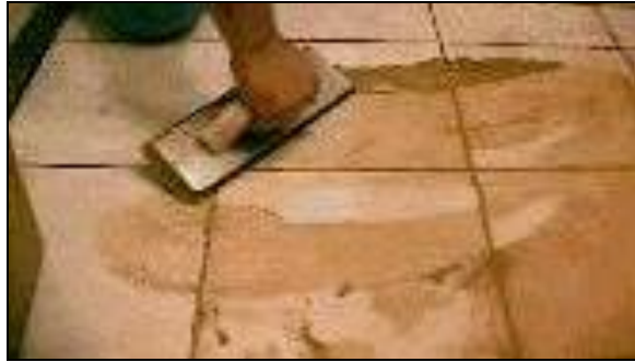
Ilustración 31. Relleno de las uniones.
