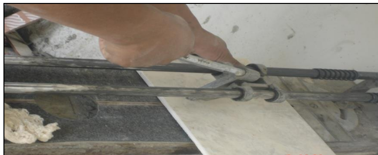
Ilustración 28. Corte de las piezas de cerámica.
