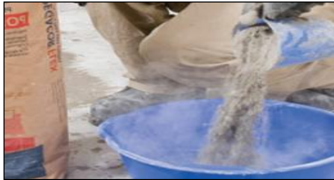
Ilustración 100. Elaboración del mortero de pega pegacor flex.
