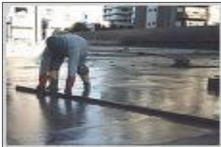
Ilustración 88. Acabado del piso con llana de madera.
