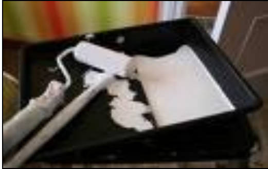
Ilustración 71. Como eliminar el exceso de pintura.
