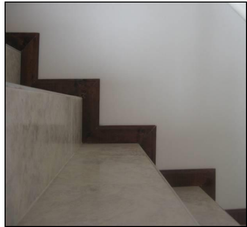
Ilustración 39. Colocación de guarda escobas.
