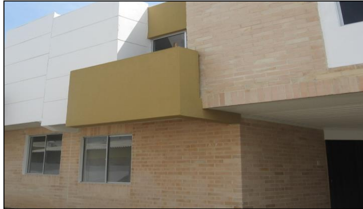
Ilustración 46. Muros exteriores terminados.
