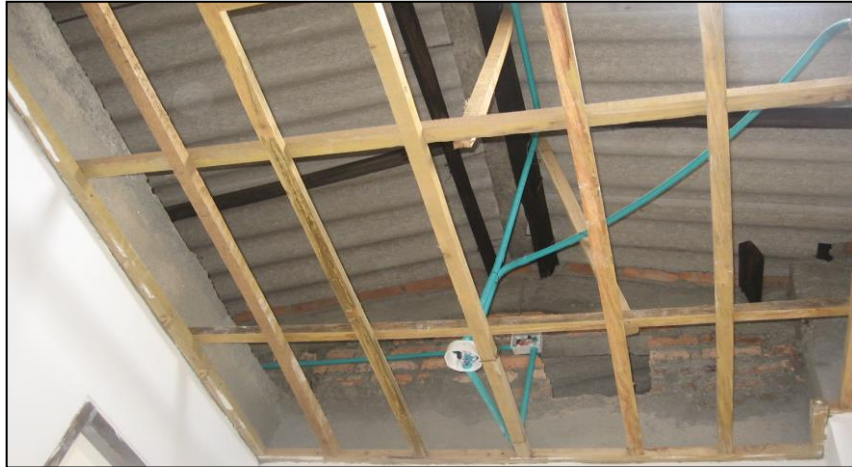
Ilustración 79. Estructura de madera.
