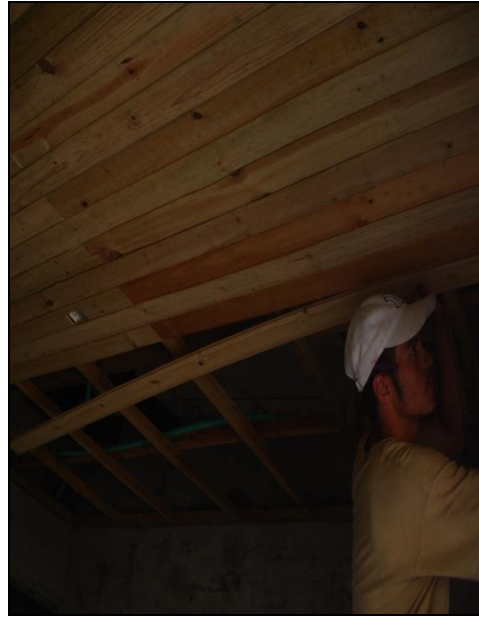
Ilustración 17. Machimbre inmunizado e instalacion.
