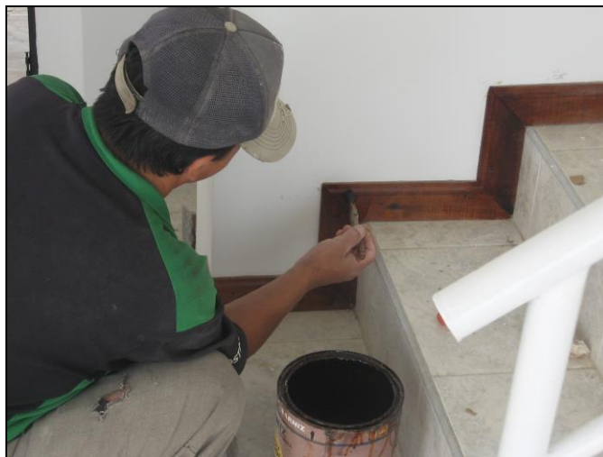
Ilustración 74. Aplicación de la pintura en madera siguiendo las vetas.
