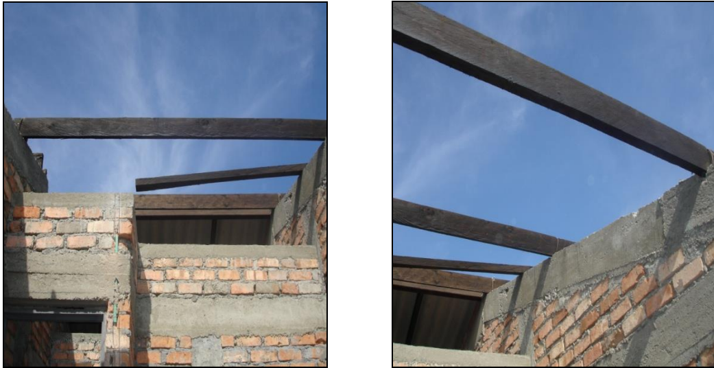
Ilustración 8. Detalle del proceso de instalación de las correas.
