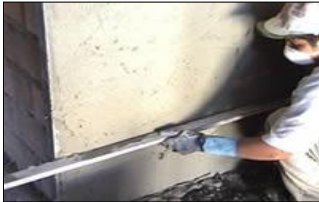
Ilustración 63. Uso del codal para uniformizar la superficie.
