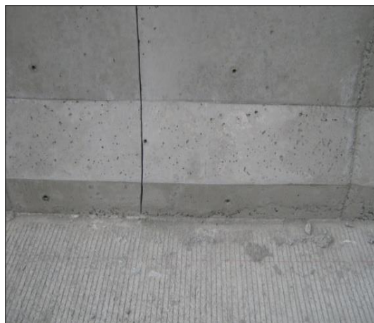
Hormigqueo en el separador New Jersey
