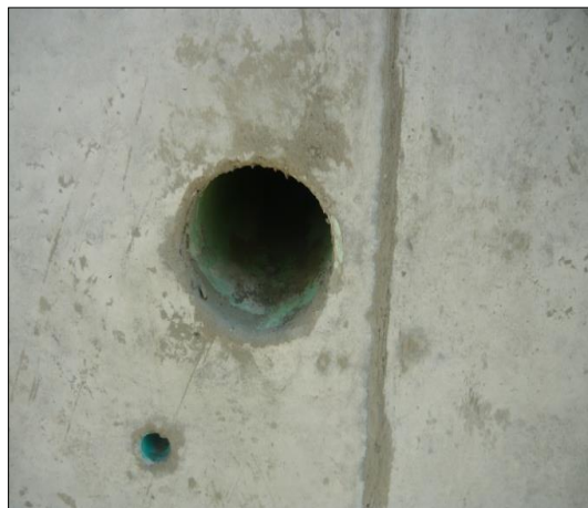
Lagrimales de los muros pantalla
