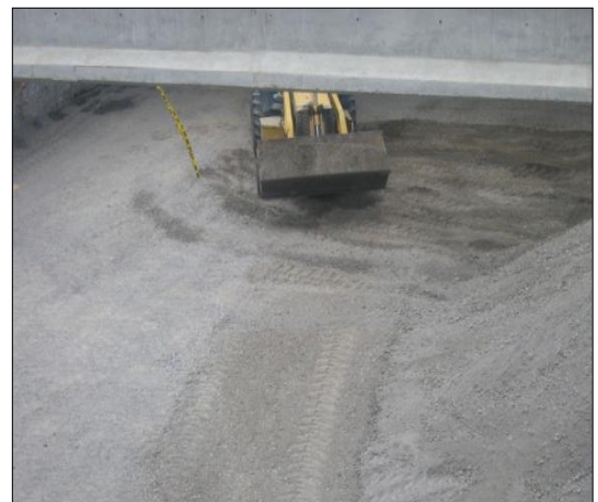
Nivelación del material de subbase
