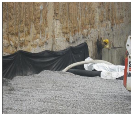
Colocación de la geomalla y el material de filtro
