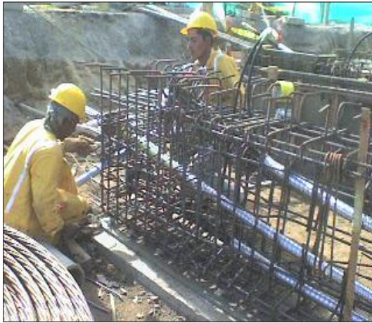
Colocación de los aceros y formaleta de las vigas postensadas
