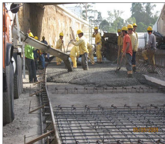
Losas de zona dos que requirieron refuerzo debido a su geometría
