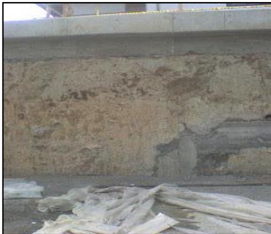
Viga de amarre de los muros pantalla
