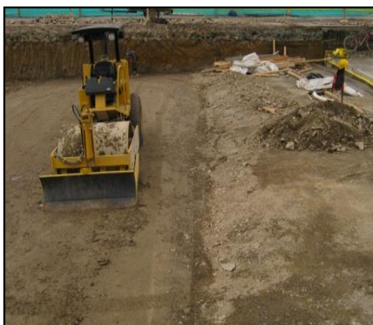
Compactación con una máquina Marca CAT CS323C
