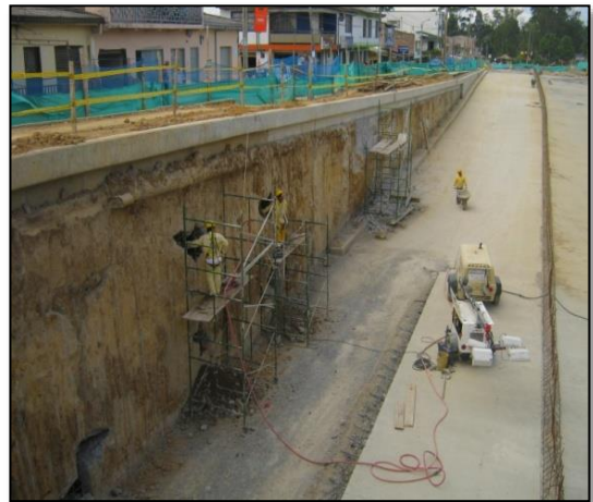
Arreglo del hormiguero en las pantallas
