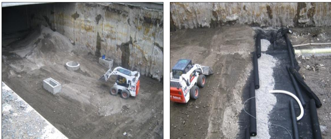
Nivelación del material de reemplazo
