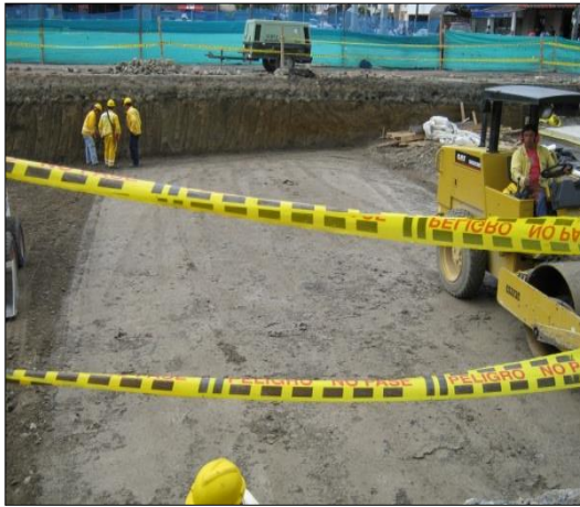
Compactación del material de subbase
