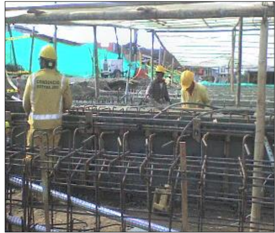
Colocación de los aceros y formaleta de las vigas postensadas
