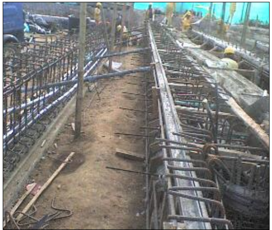
Puntales de la formaleta de las vigas postensadas
