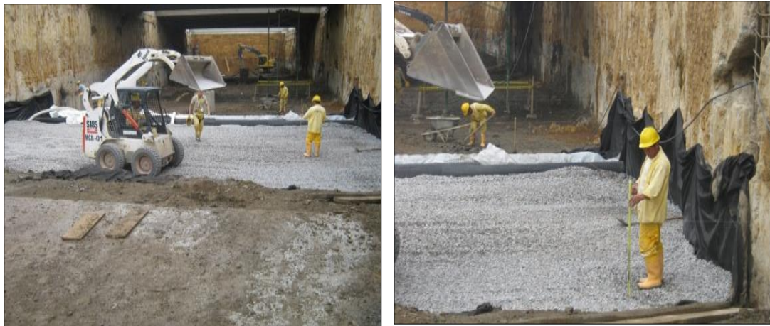
Nivelación del material de filtro
