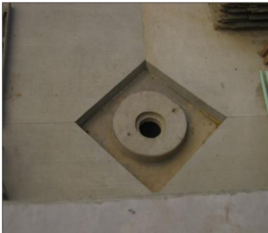
Modulación de la losa, cámaras de inspección
