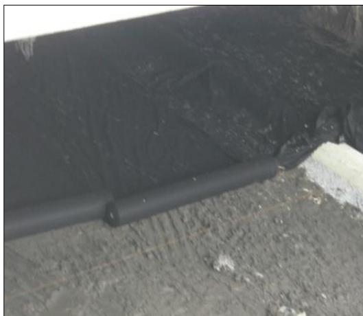
Colocación del geotextil Nt – 2500
