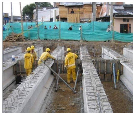
Colocación de aceros y formaleta de las riostras
