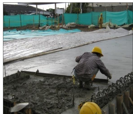
Fundición del concreto
