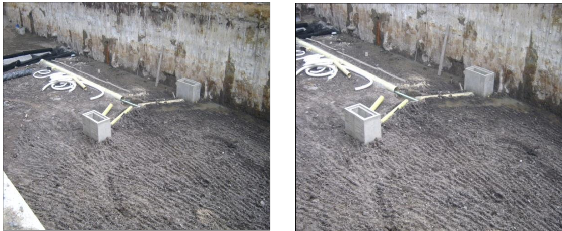
Proceso constructivo del colector del Deprimido
