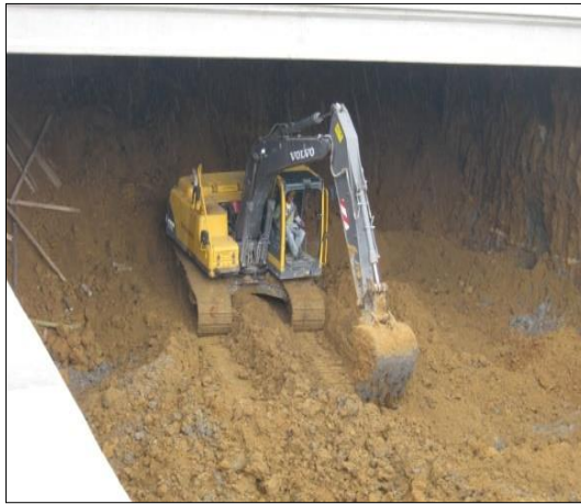
Excavación en costado norte
