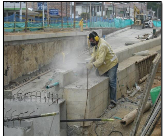
Viga de amarre de los muros pantalla
