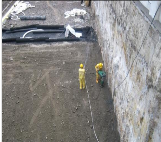
Compactación del material de reemplazo
