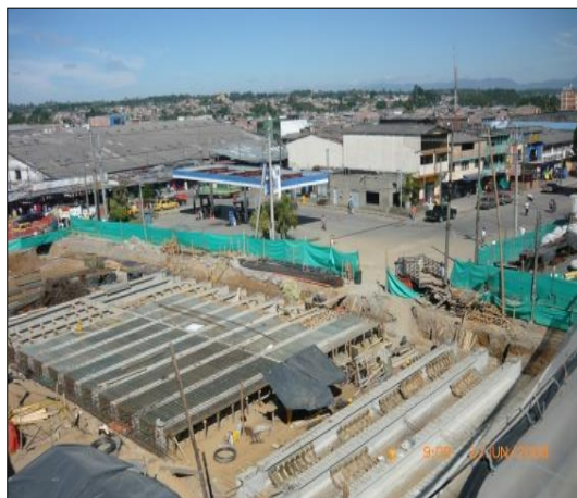
Distribución de las vigas postensadas
