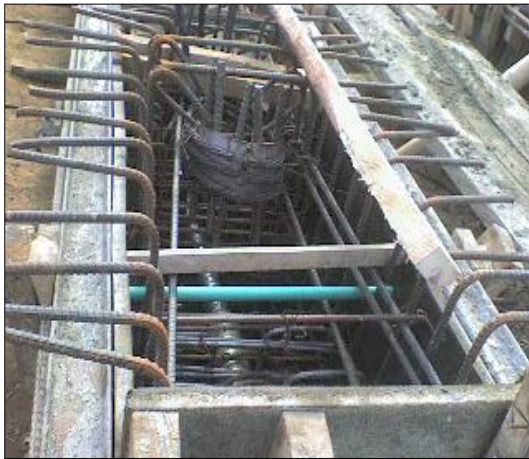
Cabezal de una de las vigas con sus aceros
