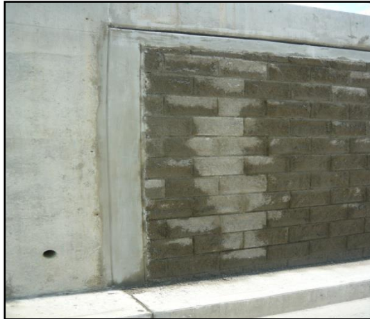
Empalme entre muros del acceso al deprimido y muros falsos
