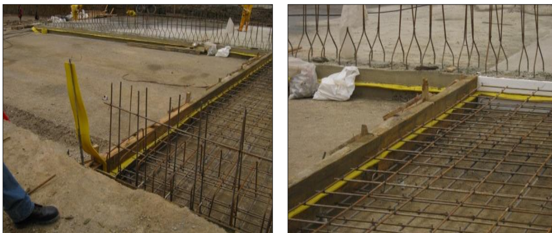
Colocación de los aceros, formaleta y del adherente de polietileno para la fundición de las losas
