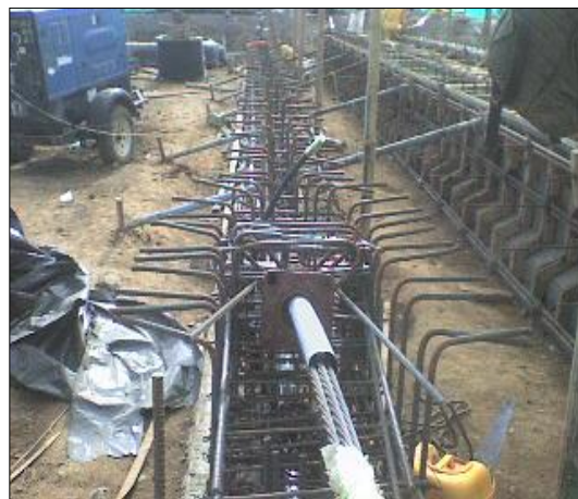
Trenza de aceros para el postensado de las vigas
