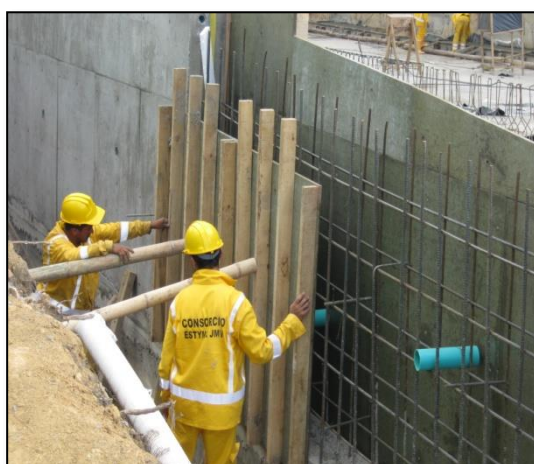
Construcción de muros en los accesos al deprimido
