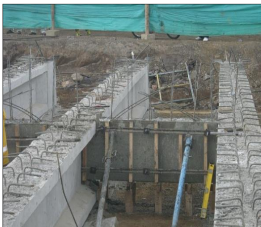
Colocación de aceros y formaleta de las riostras
