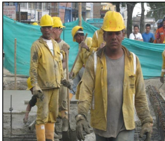
Obreros con implementos de seguridad industrial
