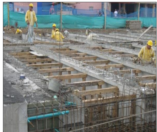
Adecuación de la formaleta para las losas
