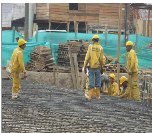
Colocación de los aceros para las losas
