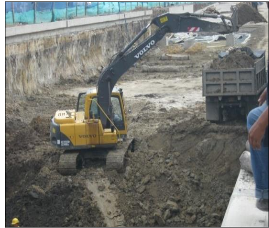
Excavación en costado sur
