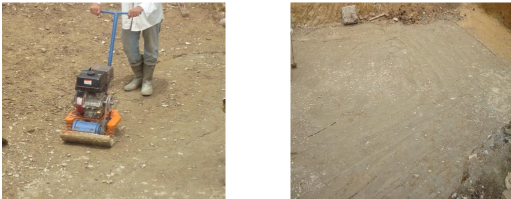
Figura 17. Compactación de Roca Muerta
