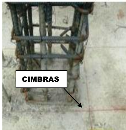
Figura 57. Marcación de dimensiones de columnas
