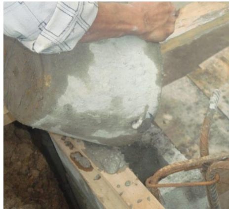
Figura 36. Fundición de celdas
