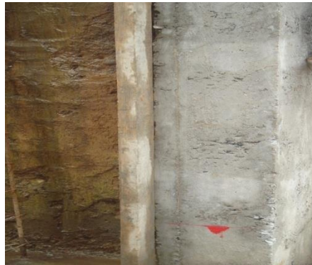
Figura 39. Colocación de los codales
