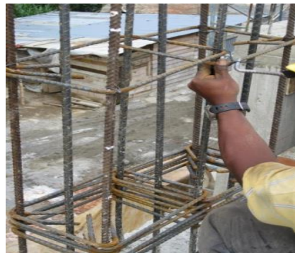
Figura 56. Colocación de estribos
