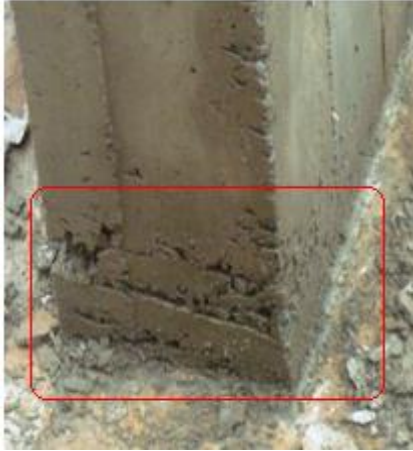
Figura 63. Pantalla P1 ubicada sobre ejes B/5
