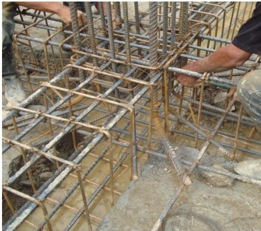
Figura 22. Columna C1 ubicada sobre ejes D/5
