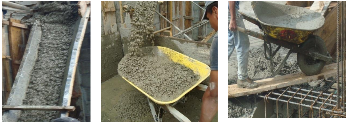
Figura 28. Transporte del concreto
