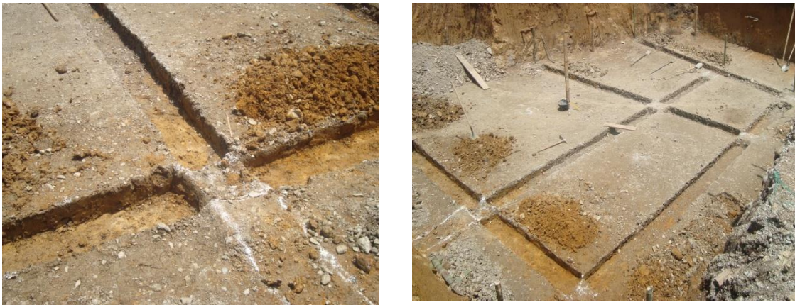
Figura 18. Zanjas para las Vigas de Cimentación
