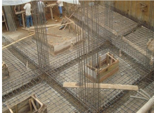
Figura 26. Parrilla de Refuerzo terminada
