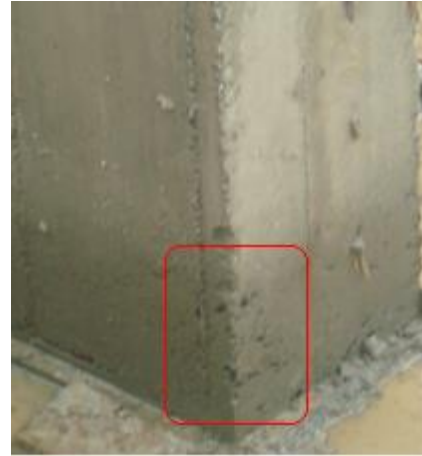
Figura 64. Pantalla P1 ubicada sobre ejes B/3
