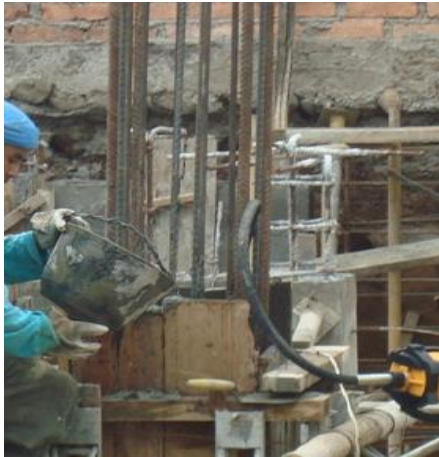
Figura 60. Vaciado del concreto
