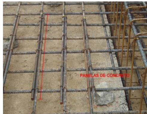
Figura 25. Chequeo de longitud de traslapeos y recubrimiento
