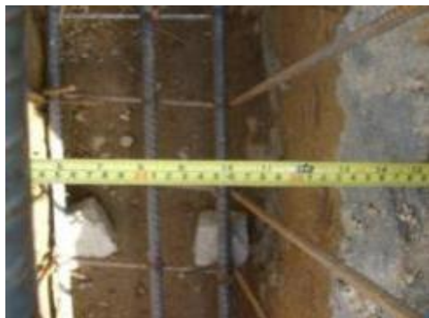
Figura 20. Verificación ancho de zanjas
