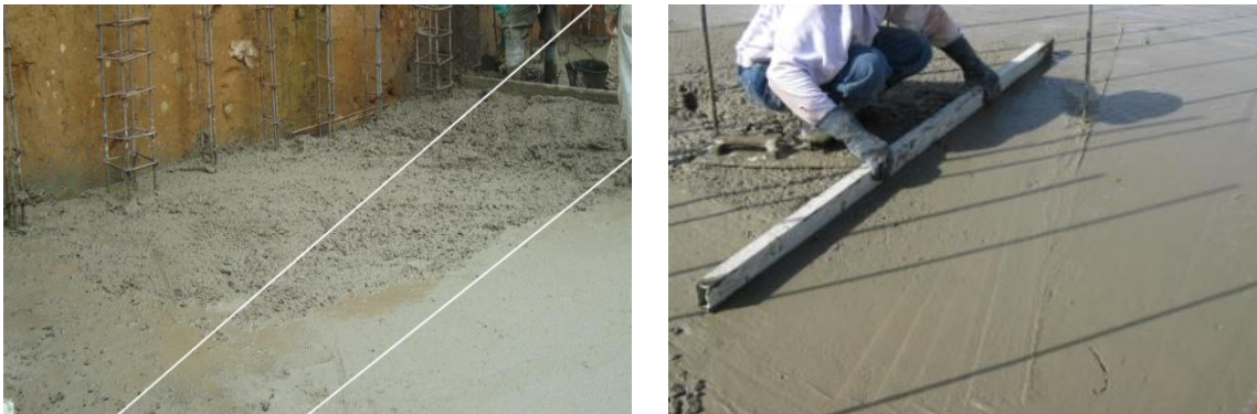
Figura 31. Nivelación y Enrasado con Codales
