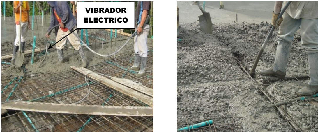
Figura 75. Compactación por vibración interna
