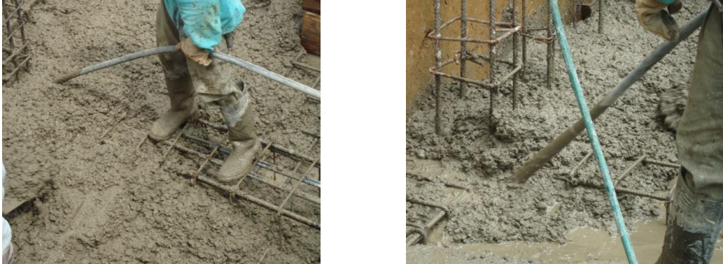
Figura 30. Compactación por Vibración Interna
