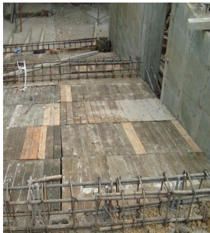
Figura 78. Formaleta rampa de acceso
