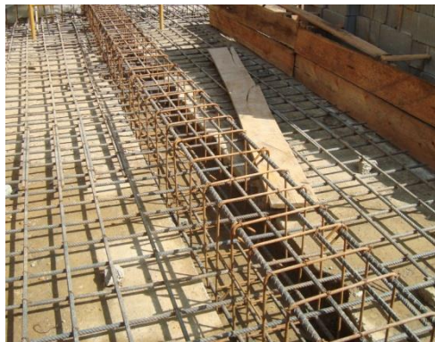
Figura 24. Parrilla de losa atravesada en Viga de Cimentación
