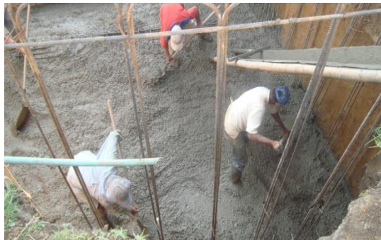
Figura 29. Colocación de mezcla
