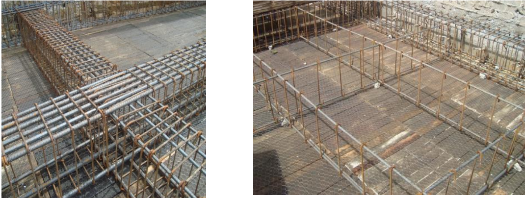
Figura 67. Colocación de refuerzo para losa de entrespiso
