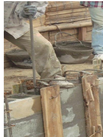
Figura 47. Compactación del concreto
