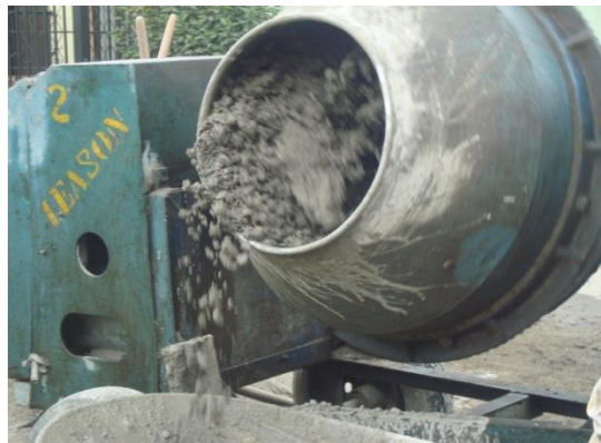
Figura 74. Mezclado del concreto
