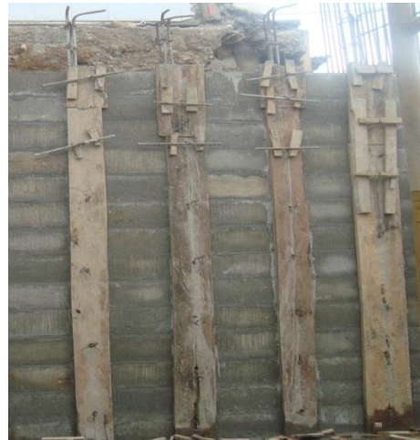
Figura 45. Formaleta para columnetas de muro
