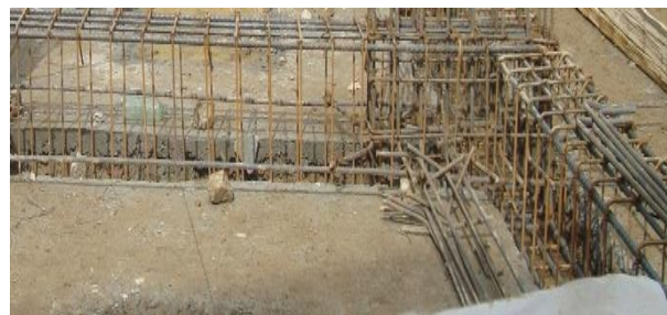
Figura 21. Viga de Cimentación ejes B/5
