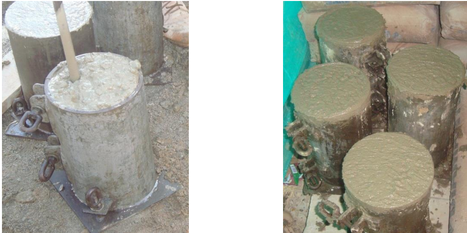
Figura 14. Elaboración de cilindros en obra
