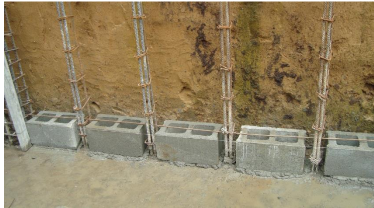
Figura 43. Primera hilada de muro
