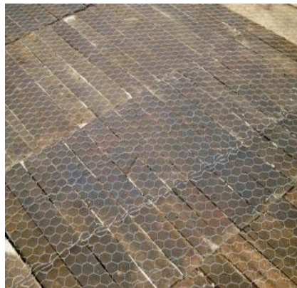
Figura 66. Colocación de la malla de alambre
