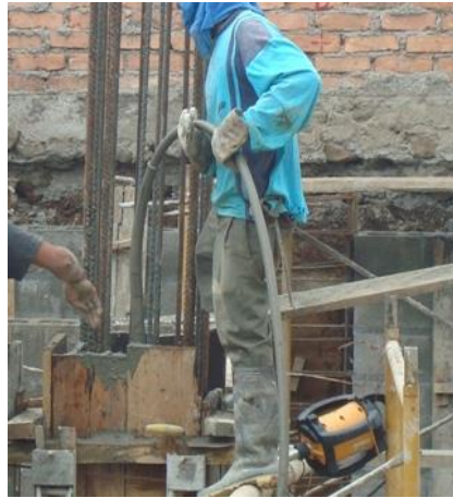
Figura 61. Vibrado del concreto
