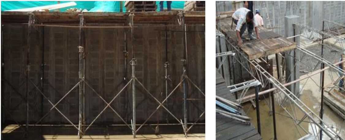
Figura 65. Colocación del encofrado
