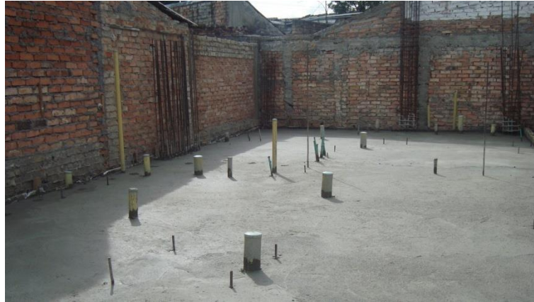
Figura 76. Losa terminada
