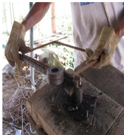
Figura 49. Figurado de los estribos
