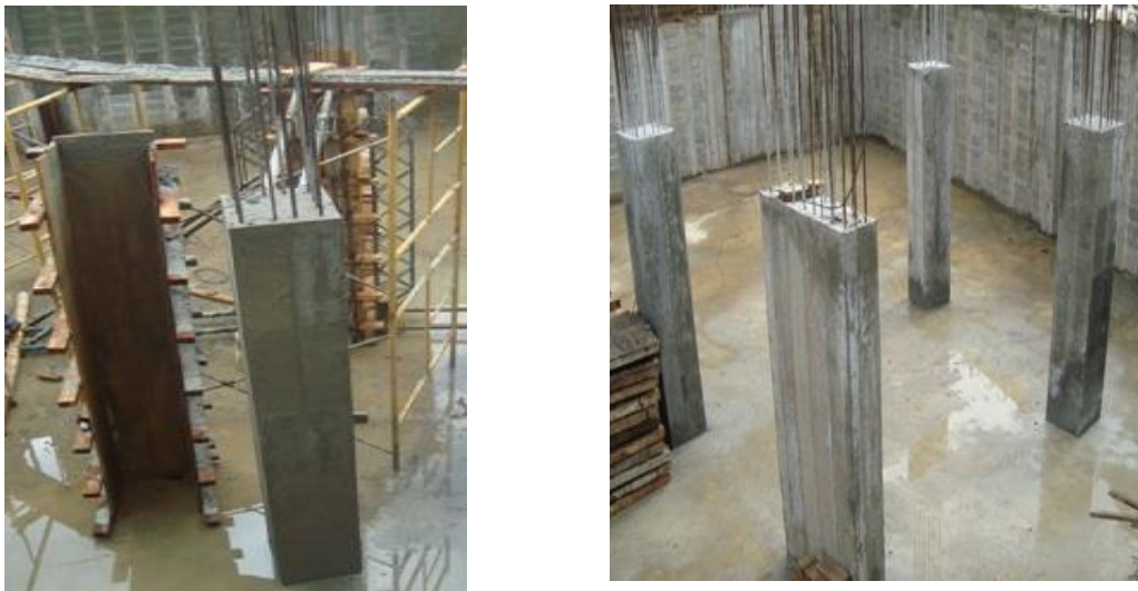
Figura 62. Desencofrado de columnas y pantallas
