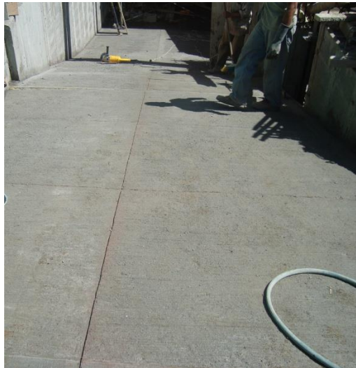
Figura 83. Cortes de juntas
