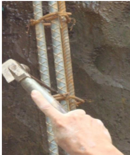
Figura 41. Colocación de pines para acero de columnetas
