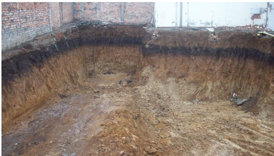
Figura 4. Estado inicial de obra
