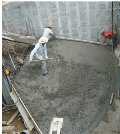
Figura 80. Colocación del concreto
