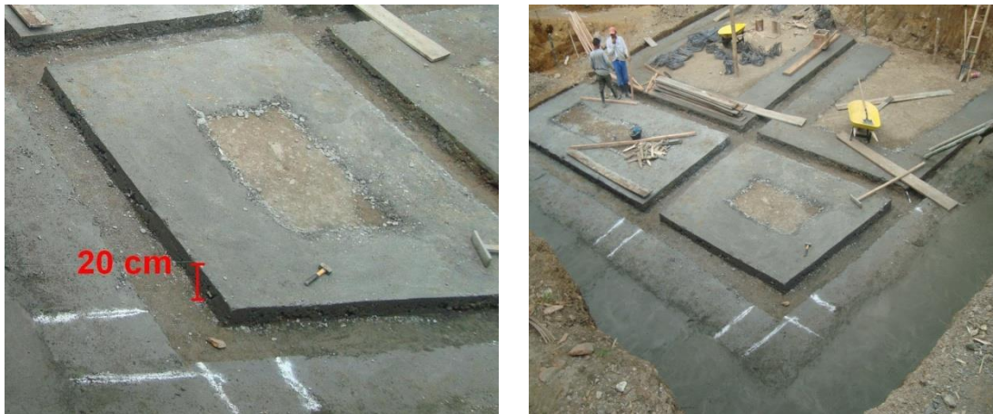
Figura 19. Solado de Vigas y Losa de Cimentación
