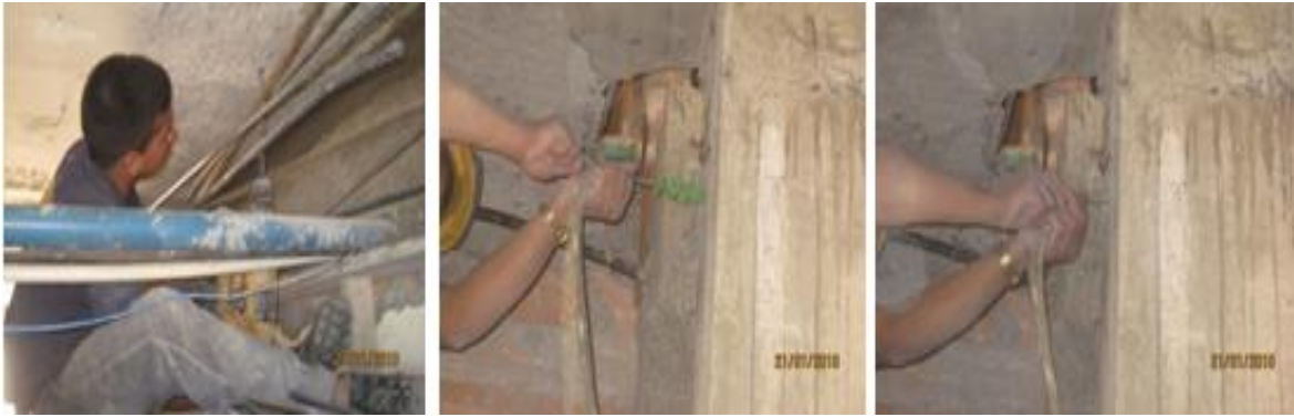
Fig. 71 Limpieza de la perforación
