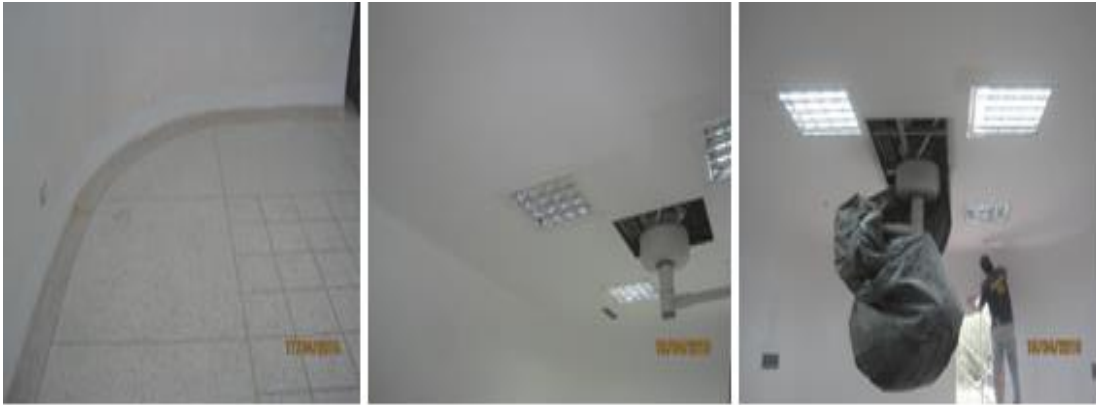
Fig. 30 Muros zona de quirófanos
