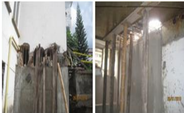
Fig.19 Apuntalamiento de las losas.
