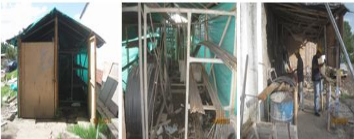
Fig.69 Almacén y zona de configuración de acero
