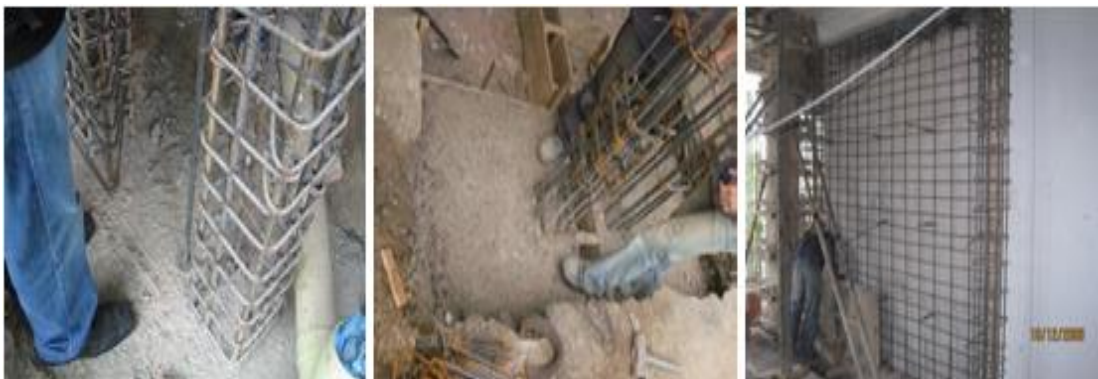
Fig.42 Cimentación y anclaje de las columnas
