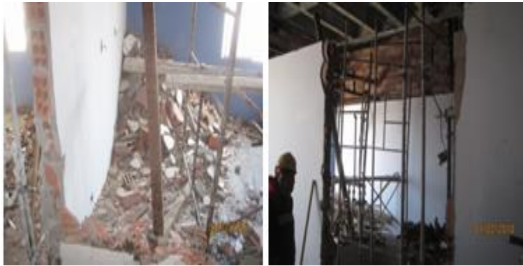
Fig.27 Demolición de muro
