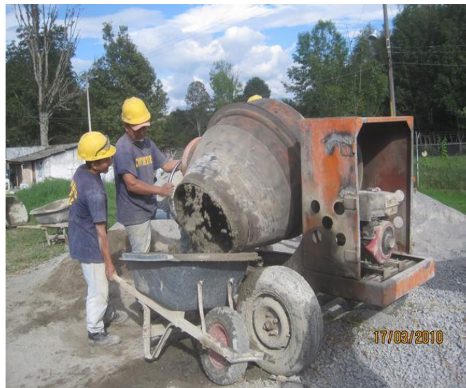
Fig. 66 Método de transporte del concreto
