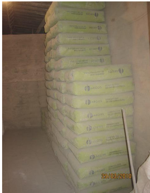
Fig. 57 Almacenamiento del cemento
