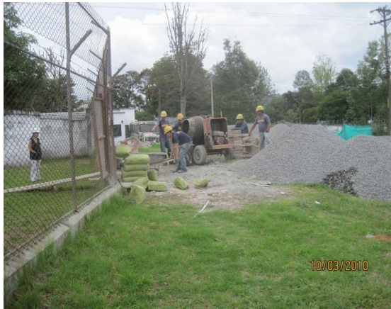
Fig.60 Sitio junto a las calderas
