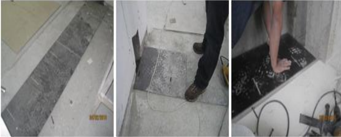
Fig.47 Lámina metálica pasillo
