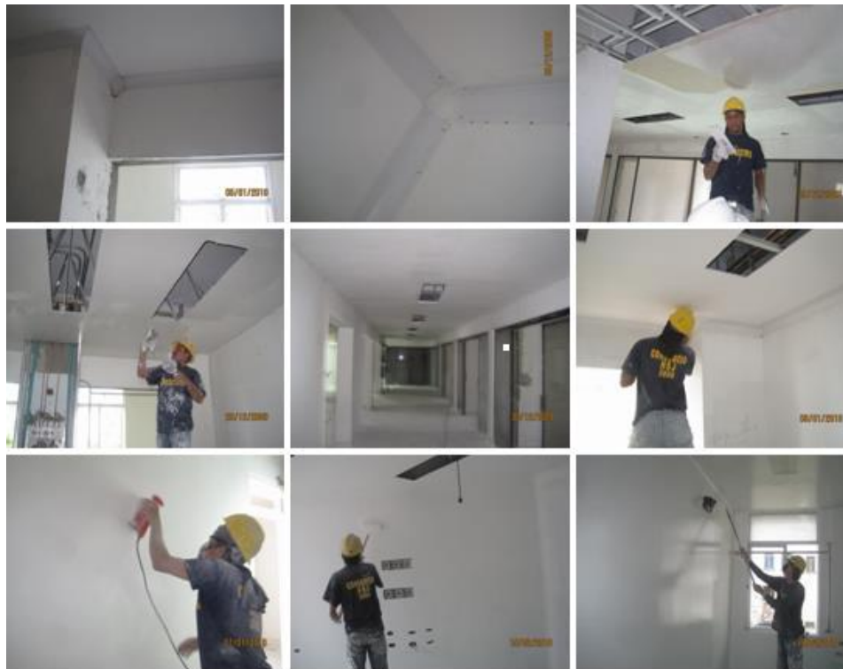
Fig.14 Montura plástica y acabado final de muros y cielos
