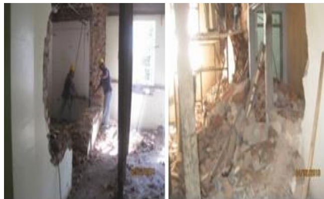
Fig.23 Demolicion de muro
