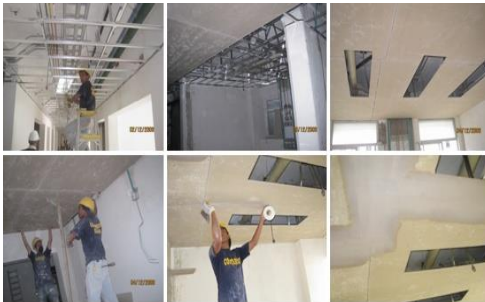
Fig. 13 Acabados en cielo para UCI
