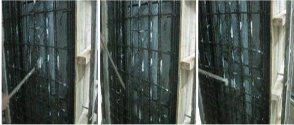
Fig. 34 Puente de adherencia concreto viejo a concreto nuevo
