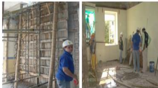
Fig.20 Formaleta y fundición de las pantallas
