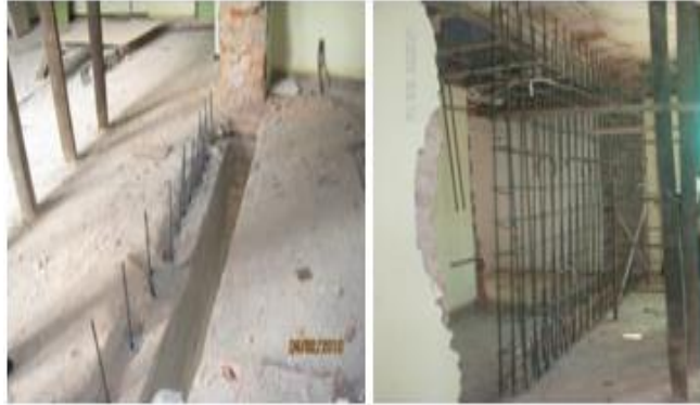
Fig.24 Anclajes pantalla
