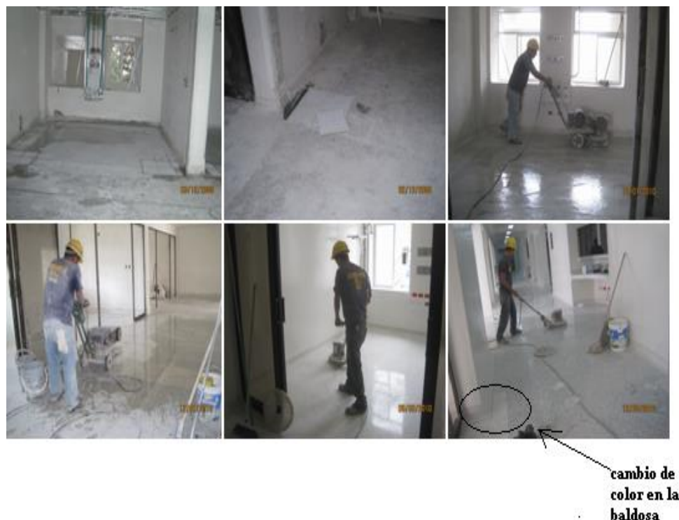
Fig.12 Reposición de piso UCI.
