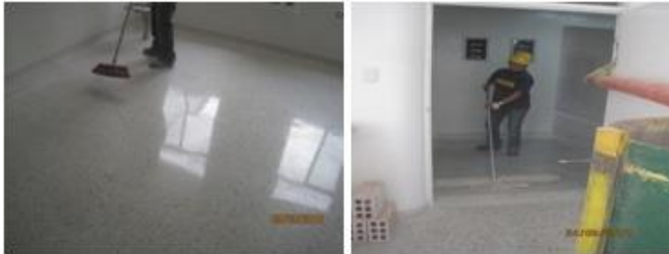
Fig. 84 Aseo de obra
