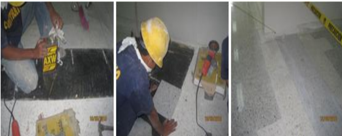
Fig.48 Vinisol sobre lámina
