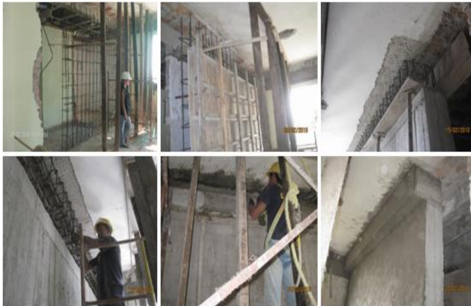
Fig.25 Construcción de pantalla eje K
