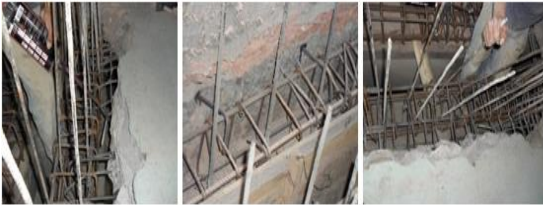
Fig.54 Vigas de coronación
