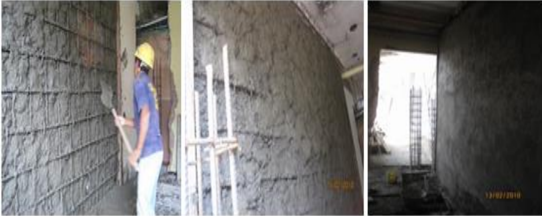
Fig.52 Mortero estructural pantalla
