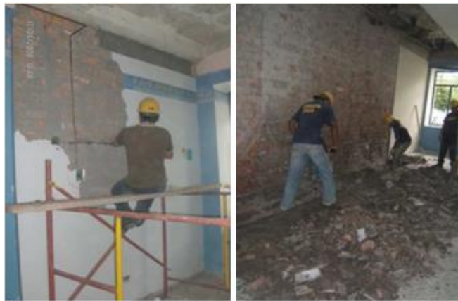
Fig. 7 Demoliciones de piso y repello de muros
