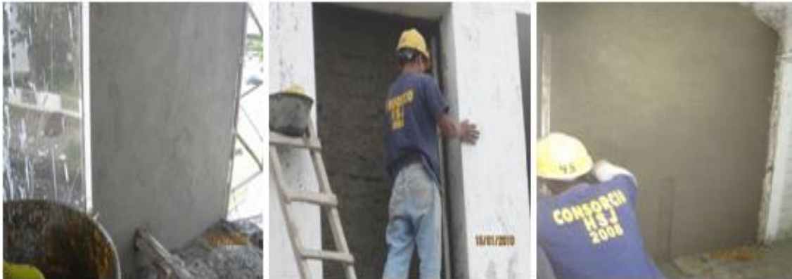
Fig.74 Repello de muros
