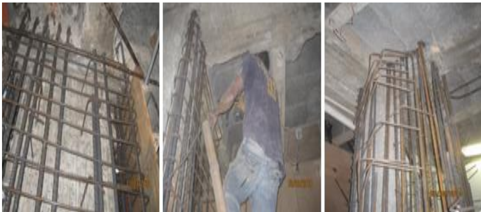
Fig. 35 Acero encamisados
