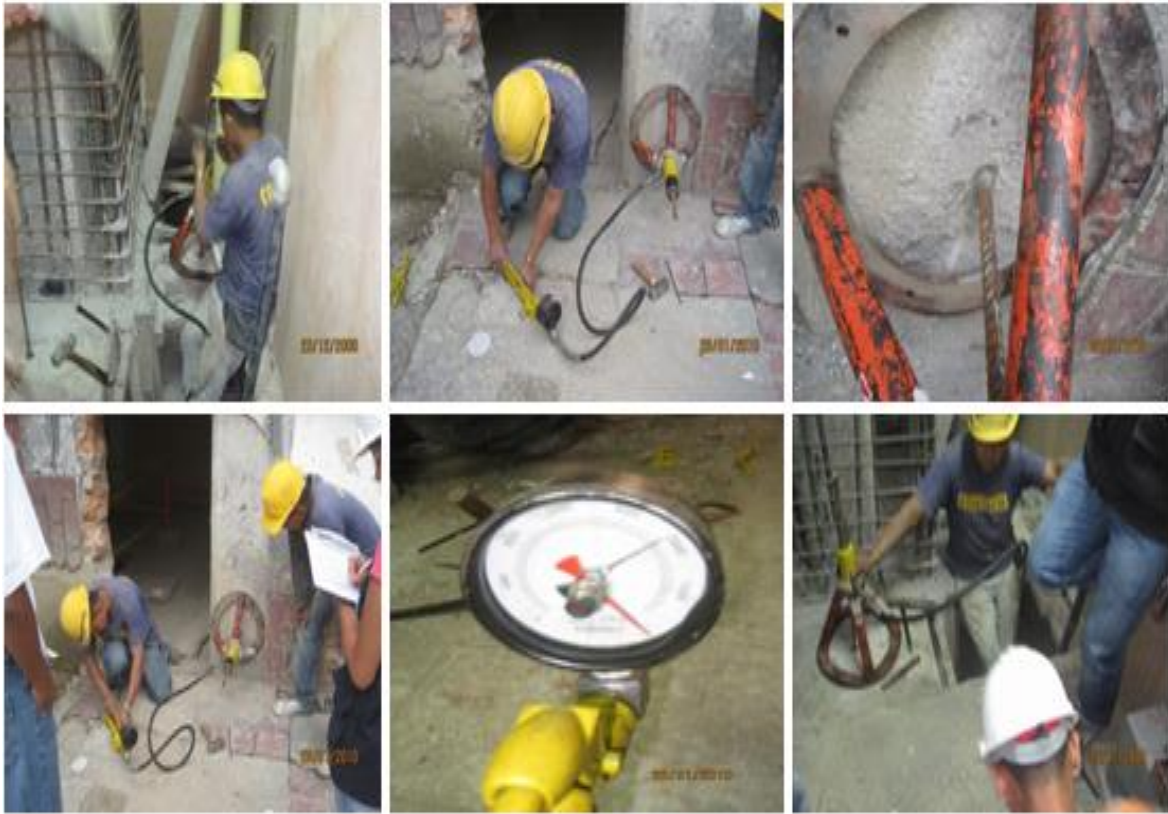
Fig.73 Prueba de anclajes
