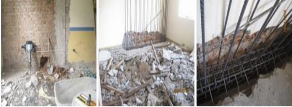
Fig.18 Construcción pantalla eje i
