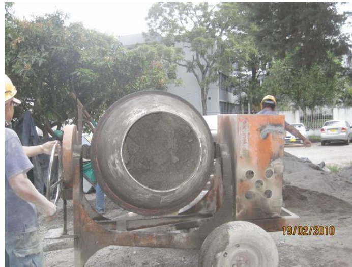
Fig. 64 Mezclado del concreto
