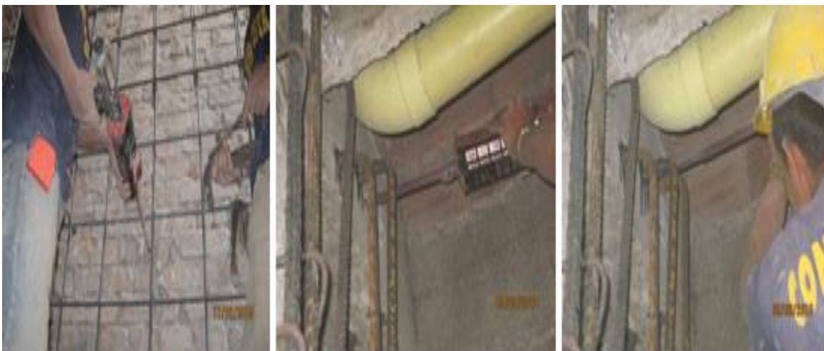
fig.72 Colocación barra y epóxico
