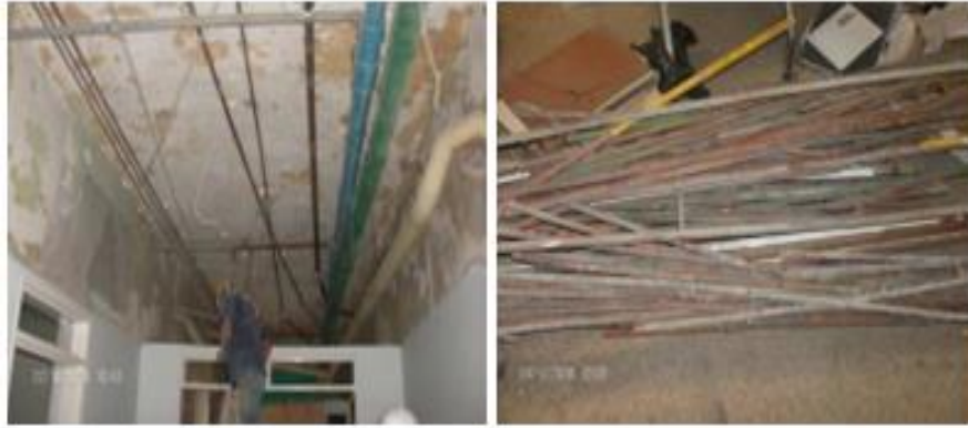
Fig. 10 Tubería de red de gases medicinales existente.
