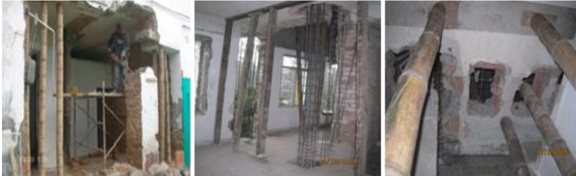
Fig.41 Apuntalamientos y cortes
