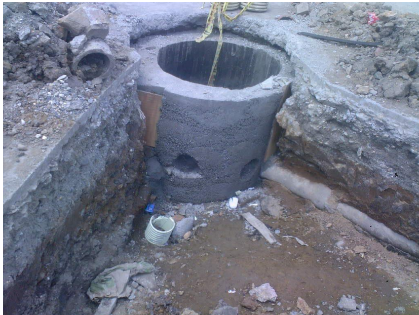
Figura 37. Construcción cámara de inspección
