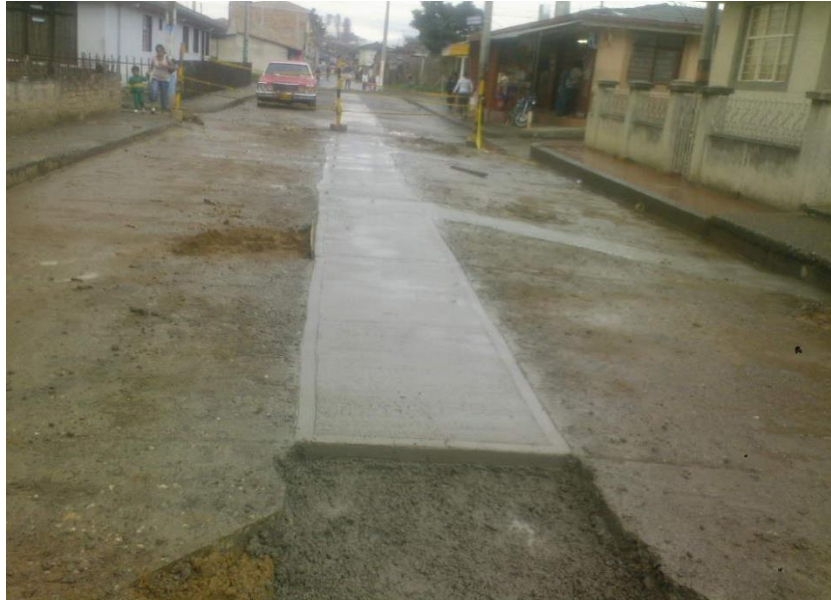
Figura 35. Construcción de losa en concreto f^c=4000\text{Psi} en el tramo de la red del colector principal
