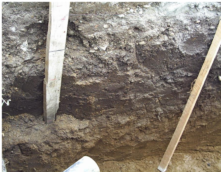
Figura 9. Toma de niveles para chequeo de pendiente
