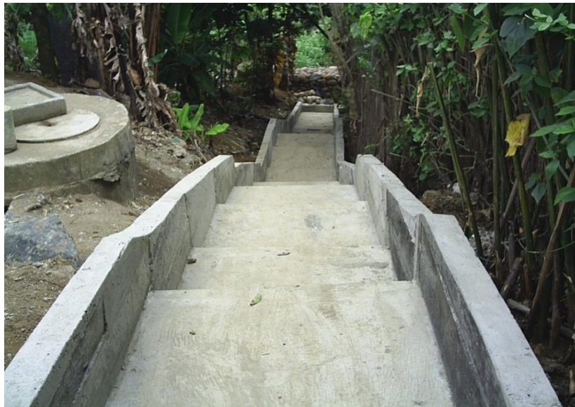
Figura 17. Construcción final disipador de energía
