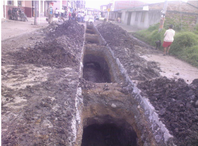
Figura 40. Excavación para reposición del colector sanitario
