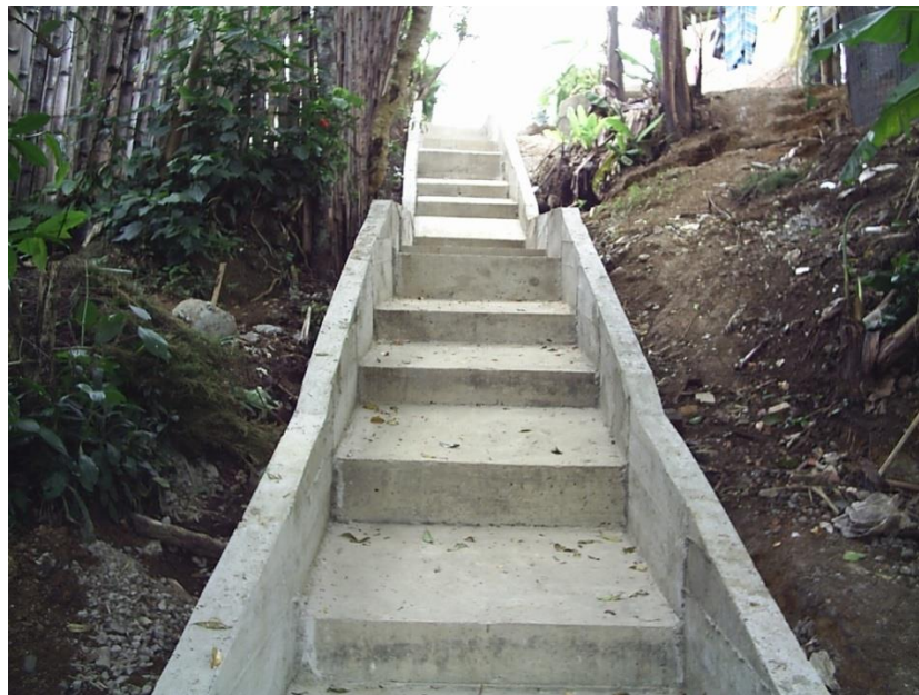
Figura 16. Dissipador de energía
