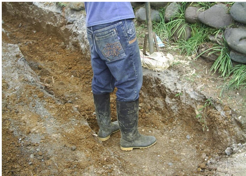
Figura 5. Compactación con pisón en capas de 20 cm con el fin de no dañar el tubo
