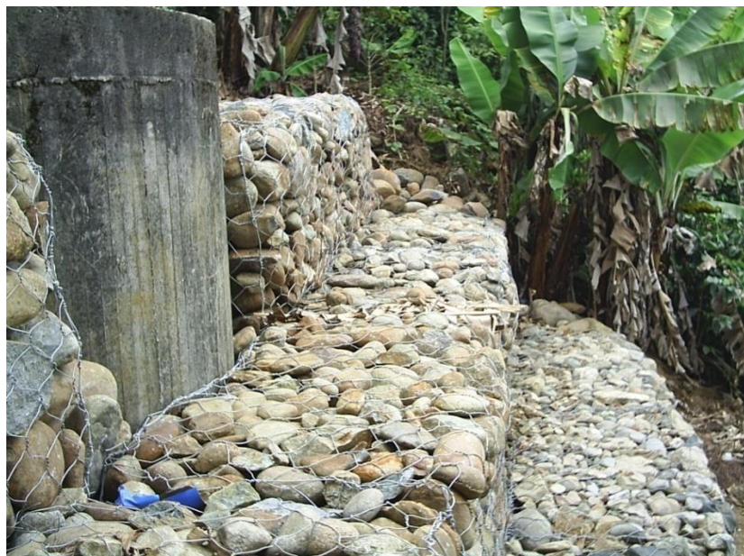
Figura 13. Gaviones en malla y piedra de 2 m 3
