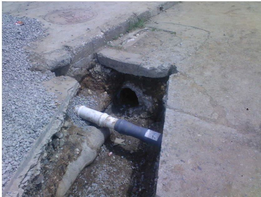
Figura 46. Reposición de sumidero
