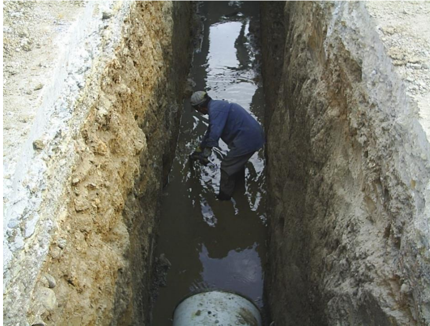
Figura 29. Instalación de tubería de 24" PVC
