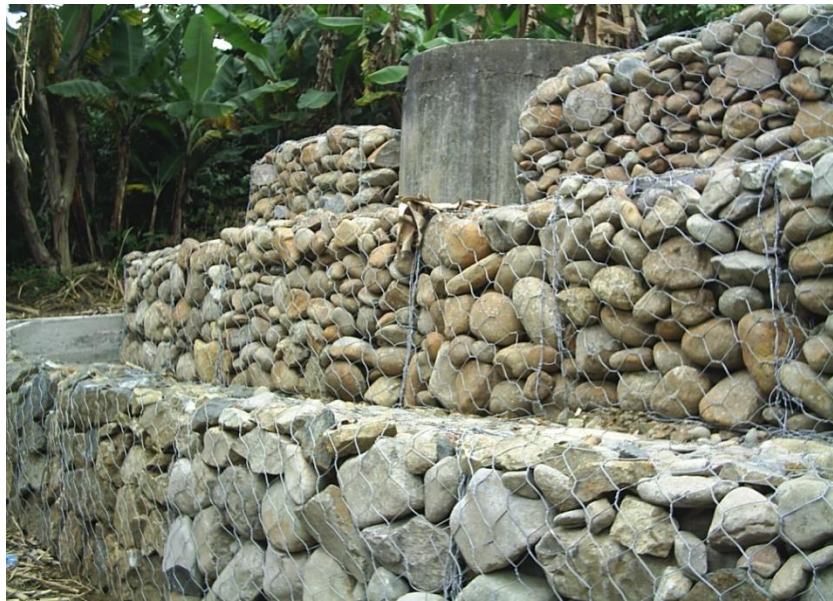
Figura 12. Protección cámara de inspección por medio de muro en gaviones
