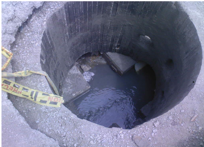
Figura 38. Se verificó el buen funcionamiento del sistema de conducción de aguas residuales
