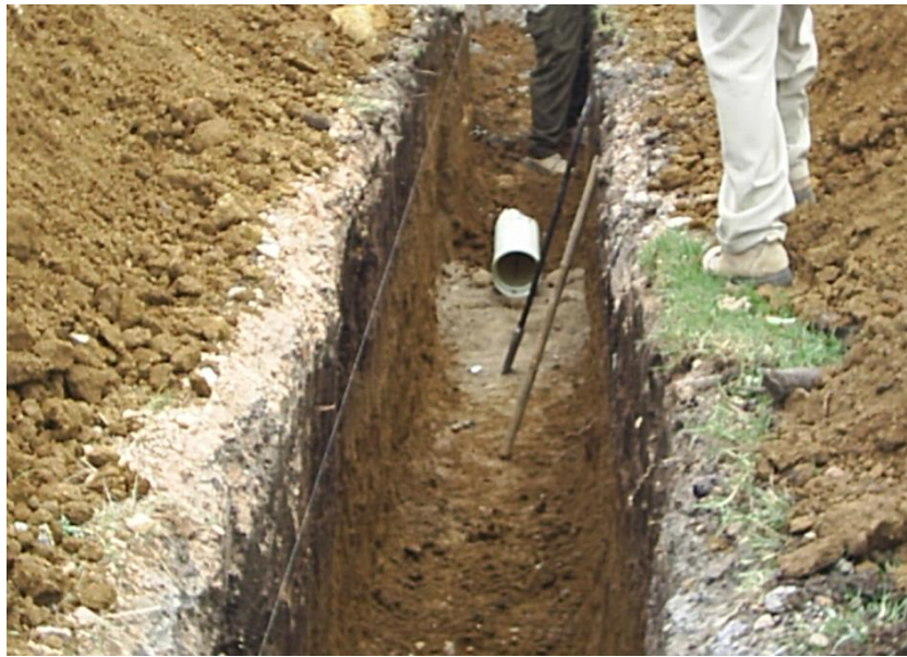
Figura 10. Instalación de tubería sobre material de cimentación
