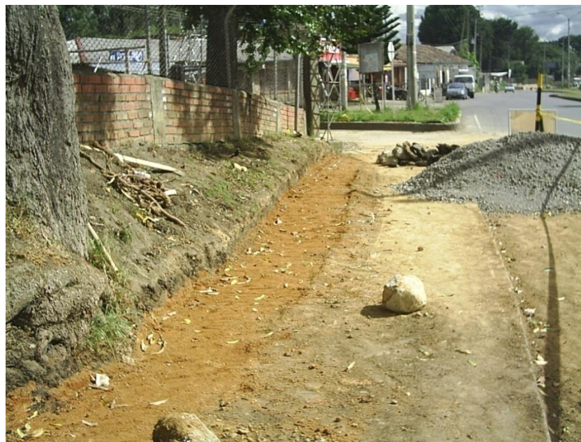
Figura 11. Finalización de la obra
