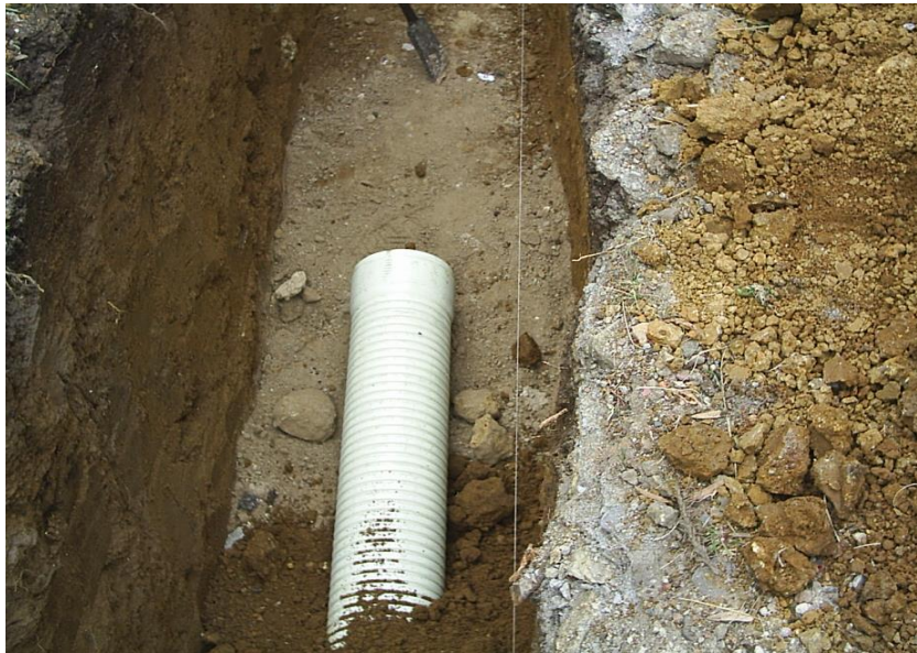
Figura 3. Se pudo verificar que se colocara capa de asiento y la buena compactación de los materiales
