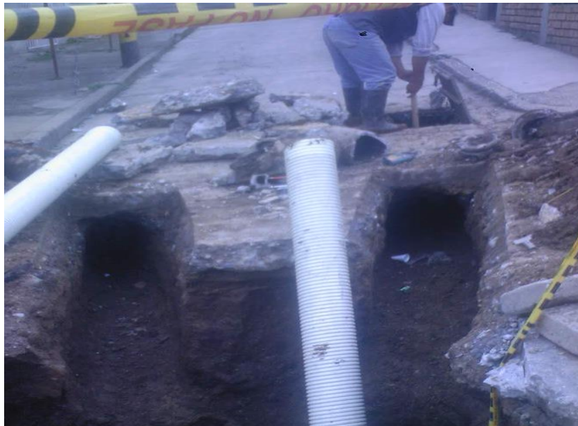
Figura 31. Excavación sumideros a la caja de inspección
