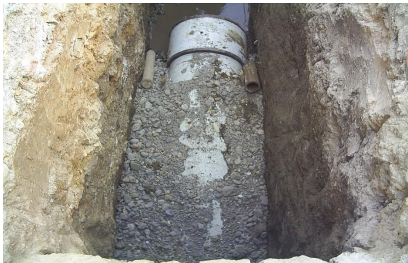
Figura 26. Colocación de material de filtro
