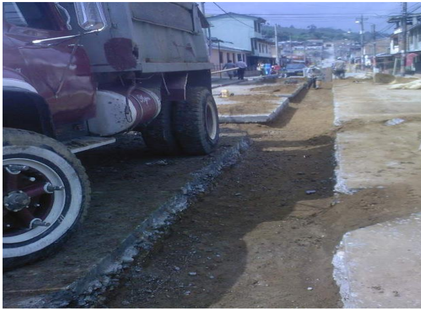
Figura 33. Colocación de material de relleno tipo II
