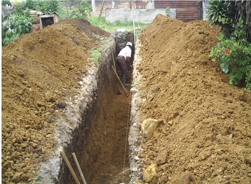
Figura 2. Por medio de mediciones realizadas se pudo constatar el volumen total de excavación.
