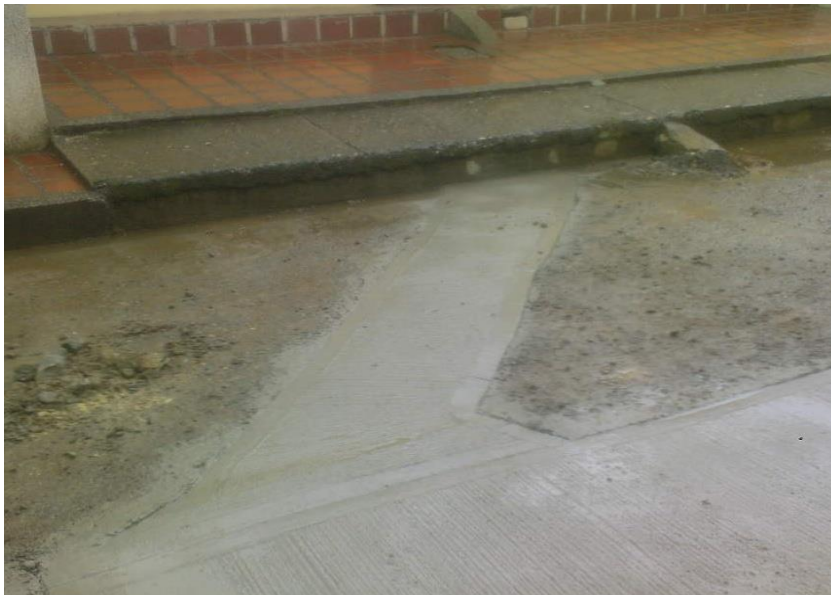
Figura 36. Construcción de losa en concreto f^c=4000\text{Psi} para las acometidas domiciliarias
