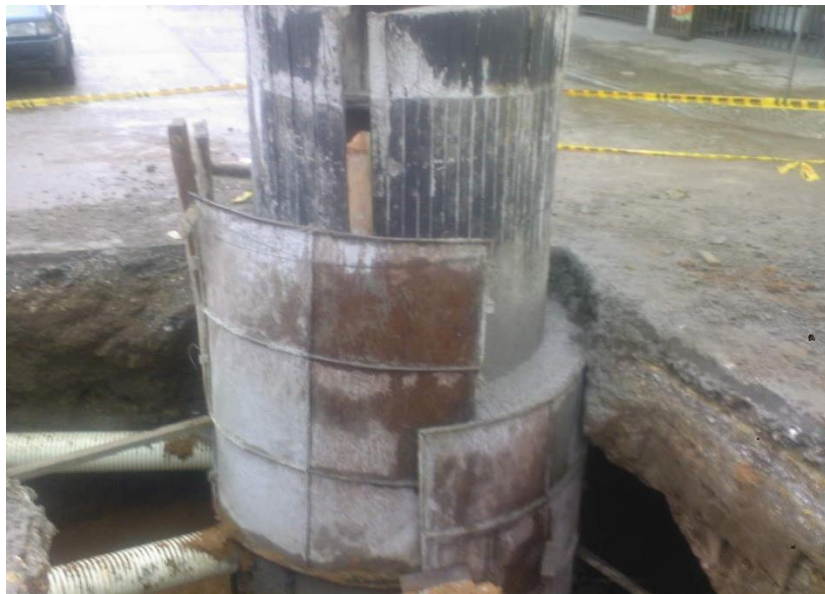
Figura 32. Construcción cámara de Inspección
