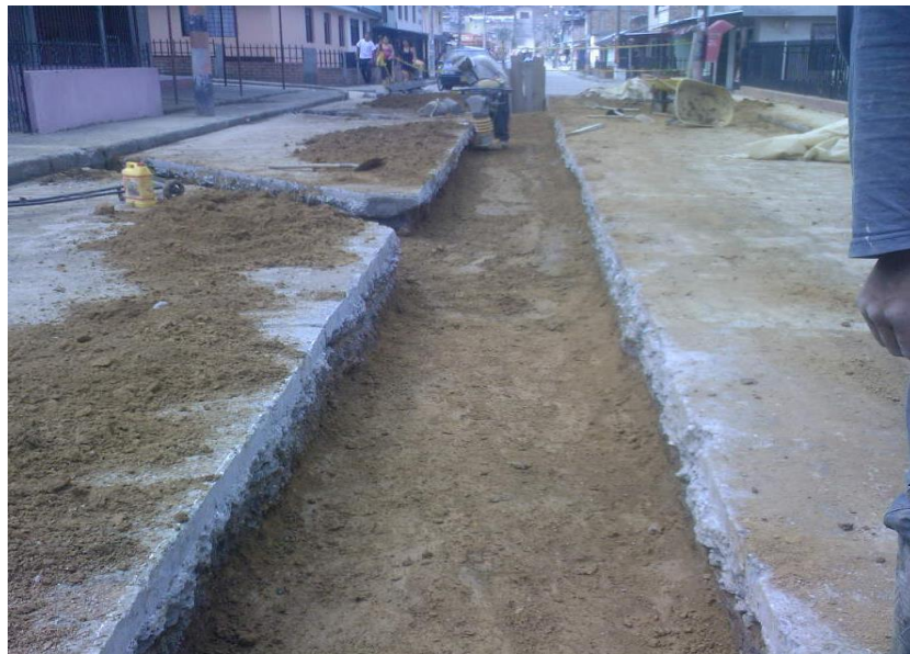
Figura 34. Compactación con material de relleno tipo II
