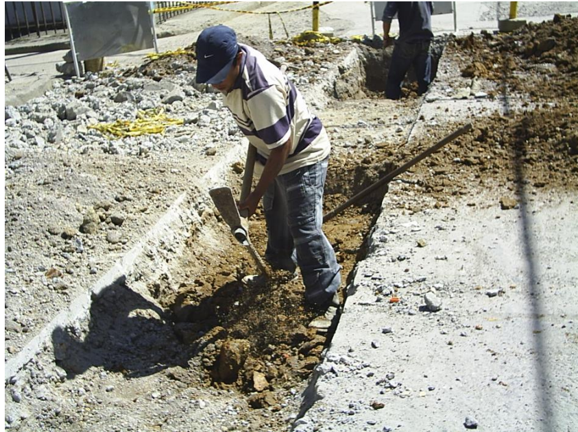
Figura 27. Excavación manual en material conglomerado
