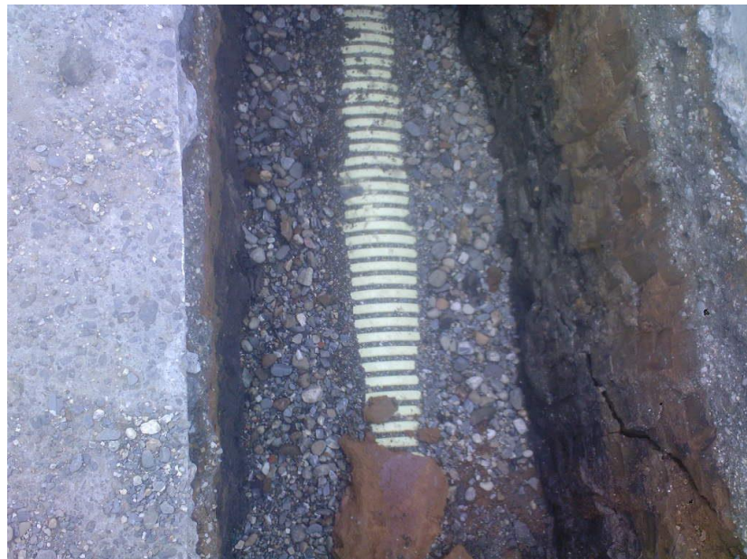
Figura 41. Tubería rodeada de grava que sirve como material de filtro
