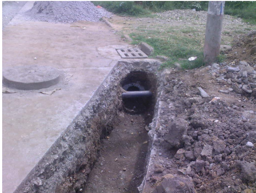
Figura 45. Zanja para sumidero
