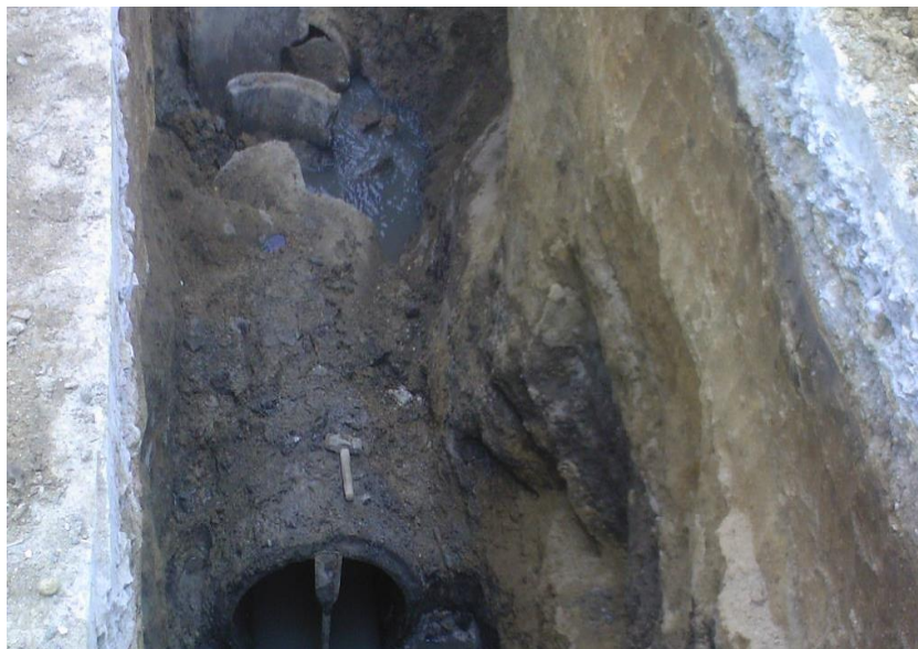
Figura 23. Tubería guía para la nueva instalación
