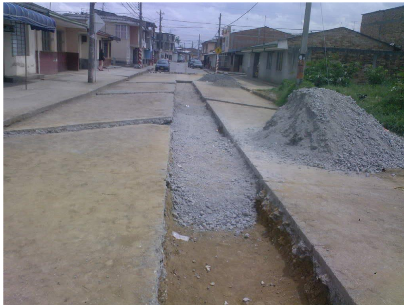
Figura 47. Colocación y compactación material para base
