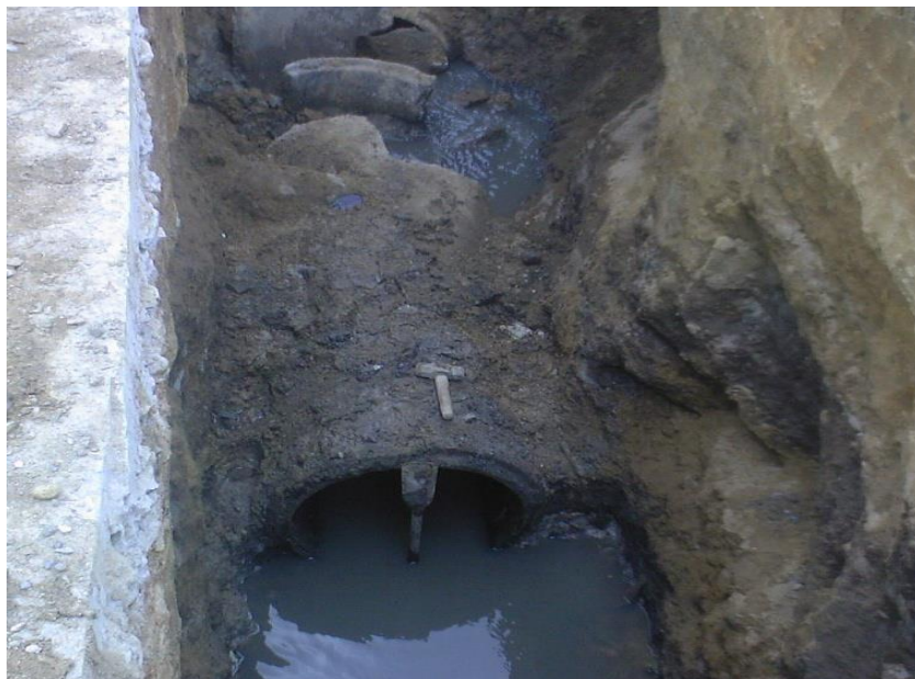
Figura 28. Tubería de asbesto-cemento que sirvió de guía para la instalación de la nueva tubería
