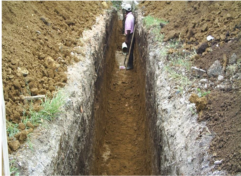
Figura 8. Excavación manual zanja de 0.80 m
