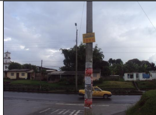
Foto No. 14 Postes de Alumbrado y de soporte de redes. Laterales al eje del puente.
