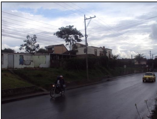
Foto No. 7 – Calzada oriental Ancho de 9.16m
