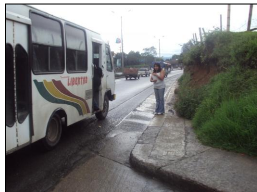
Foto No. 10 – Anden Occidental Ancho de 1.25m
