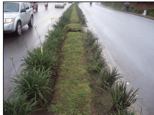
Foto No. 8 – Separador Central Ancho de 1.95m
